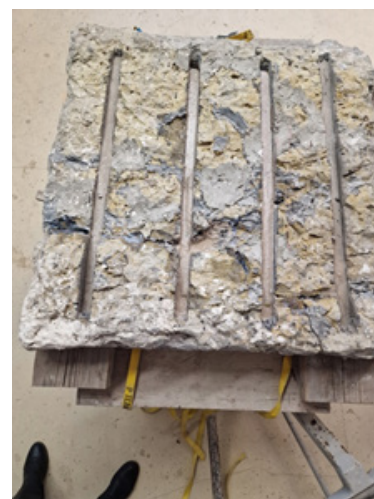
Slika 3: Vstavljanje nerjavečih vezi v hrbtišče reliefa (Foto: arhiv ZVKDS, Restavratorski center, Oddelek za kamen in štukaturu, 2025)
