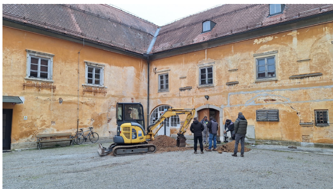
Slika 1: Napeljava električnega voda do nove razdelilne omarice v grajski kleti (Foto: Dušan Štepec, 2025)
