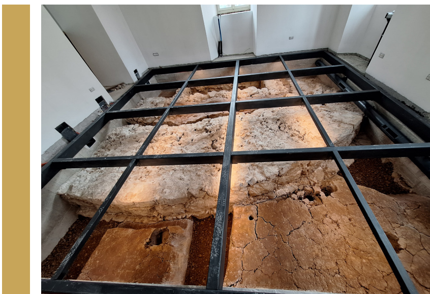
Slika 3: Postavitev kovinske konstrukcije nad arheološkimi ostalinami (Foto: Tina Britovšek, 2025)
