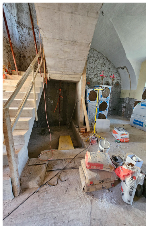
Slika 2: Pogled na novo zgrajeno stopnišče (Foto: Vita Weiss Babič, 2025)
