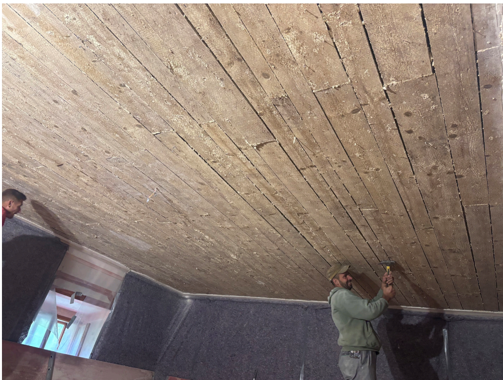
Slika 3: Priprava lesene stropne konstrukcije za nanos novega apnenega ometa v grajskem salonu (Foto: Anja Urbanc, 2025)
