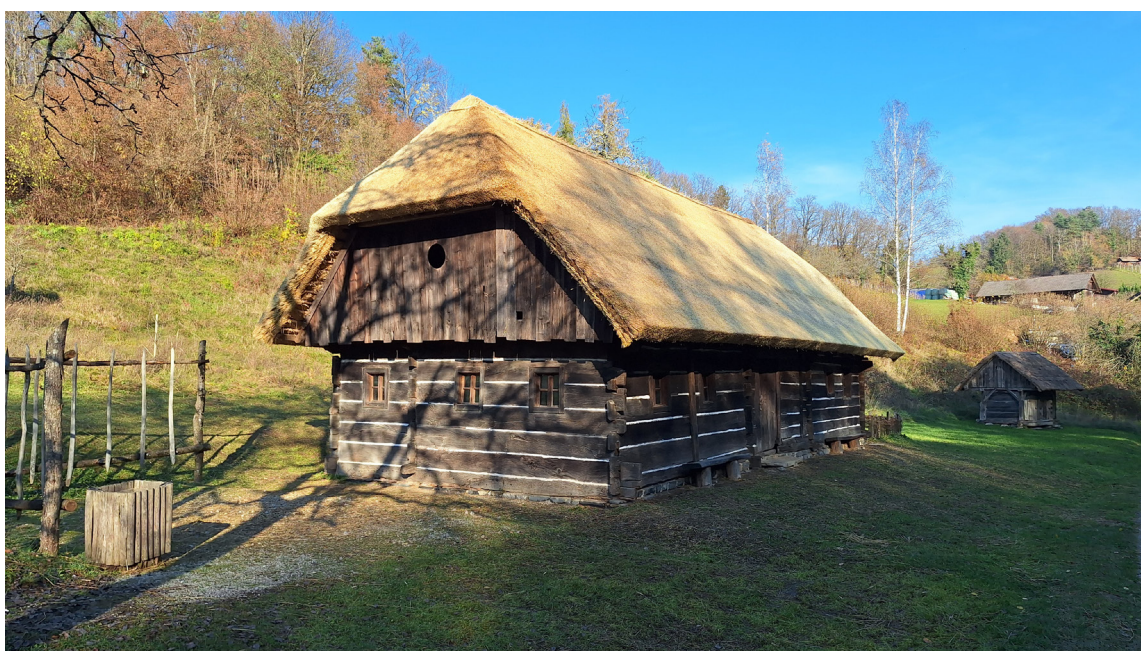
Slika 4: Rangusova hiša z novo slamnato streho (Foto: Dušan Štepec, 2025)
