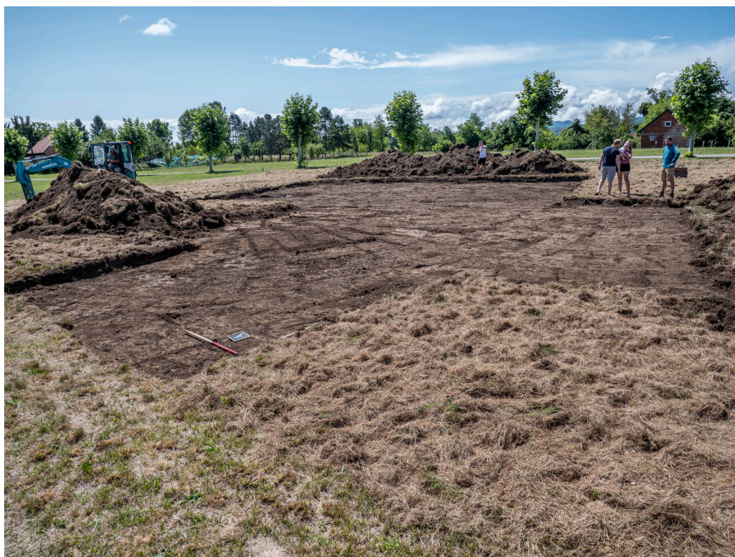
Slika 2: Odstranjevanje humusne plasti v velikosti bodočega posega na parc. št. 4/10 (4/12 – del) k. o. Rigonce (Foto: PJP, d. o. o., 2025)
