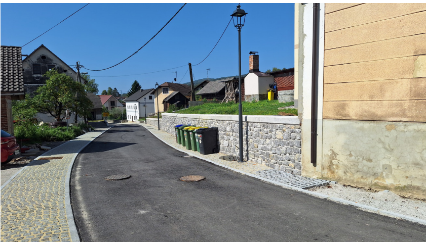
Slika 2: Med obnovo vaškega jedra so bili izdelani novi pločniki, oporni zidovi in postavljena nova javna razsvetljava. (Foto: Dušan Štepec, 2025)
