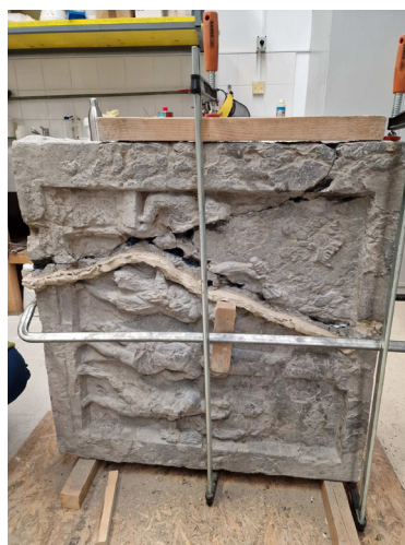
Slika 2: Lepljenje reliefa (Foto: arhiv ZVKDS, Restavratorski center, Oddelek za kamen in štukaturu, 2025)
