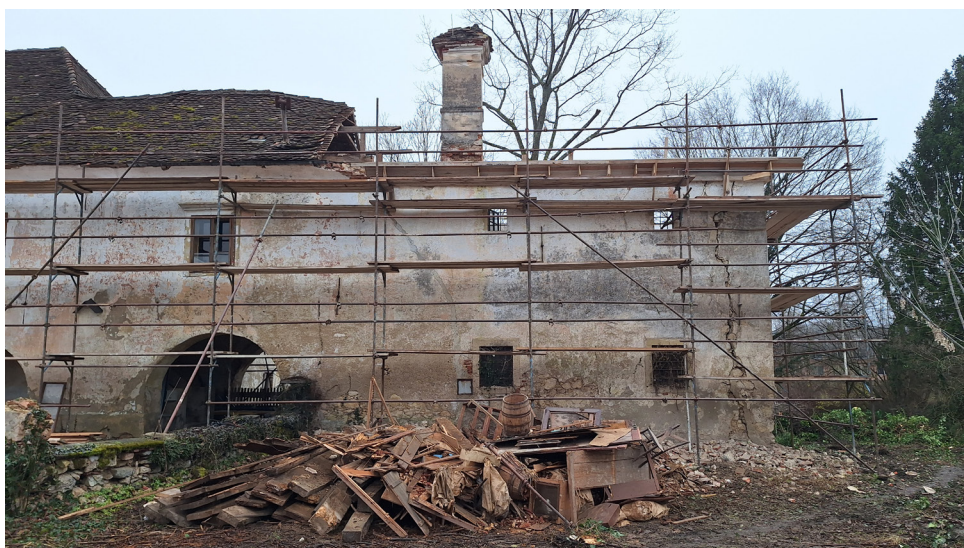
Slika 3: Župnijski dvorec po odstranitvi strešne konstrukcije na delu SZ trakta (Foto: Dušan Štepec, 2025)
