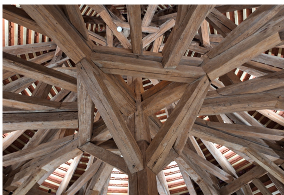
Slika 2: Osvetljena baročna strešna konstrukcija v jugozahodnem grajskem stolpu (Foto: Tomaž Golob, 2026)
