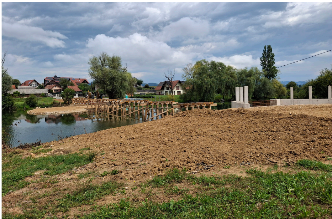
Slika 3: Lesena konstrukcija nosilnih stebrov novega mostu (Foto: Judita Podgornik Zaletelj, 2025)
