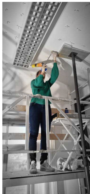
Slika 5: Injektiranje poliuretanske pene in stabilizacija apnenega ometa (Foto: Tanja Mesojedec, 2025)
