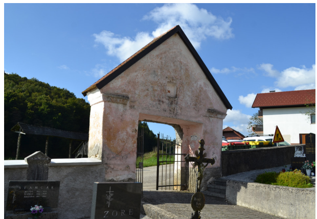
Slika 2: Vhodni portal s hrbtne strani pred posegi (Foto: Ana Krevelj, 2025)
