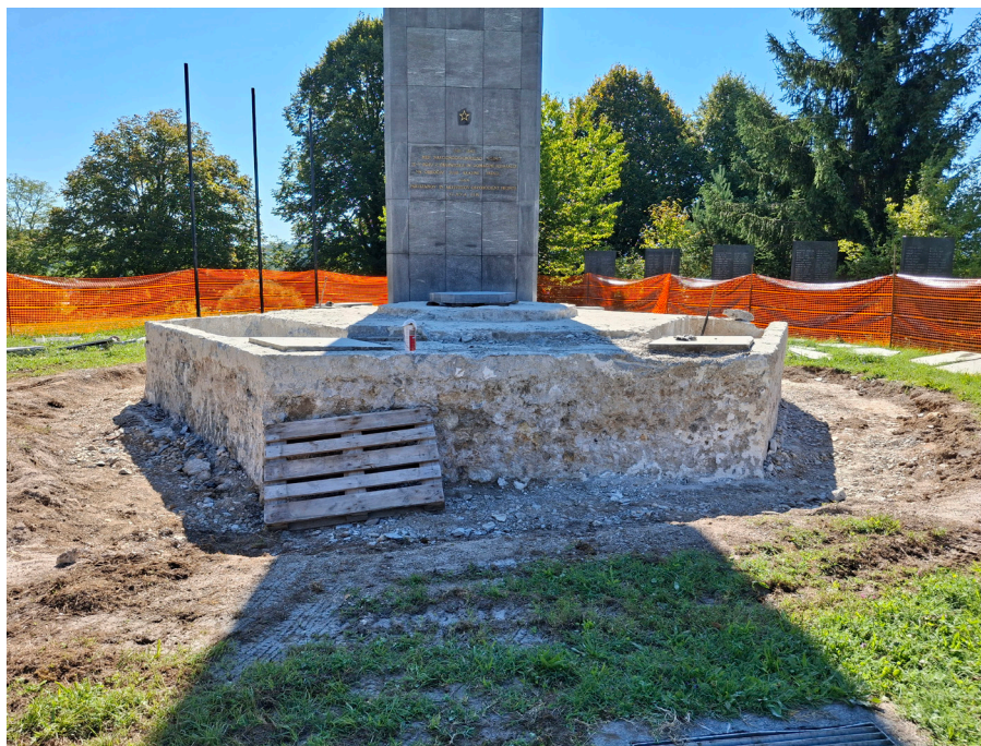
Slika 3: Obod grobnice med izvajanjem dela (Foto: Judita Podgornik Zaletelj, 2025)
