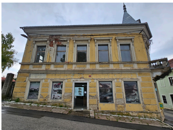
Slika 1: Stanje objekta pred obnovo (Foto: Vita Weiss Babič, 2025)
