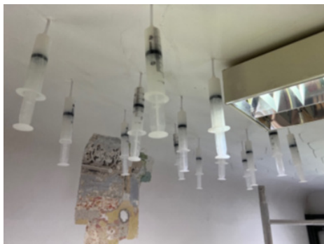
Slika 4: Injektiranje apnenega utrjevalca in utrjevanje apnenega ometa (Foto: Saša Snoj 2025)
