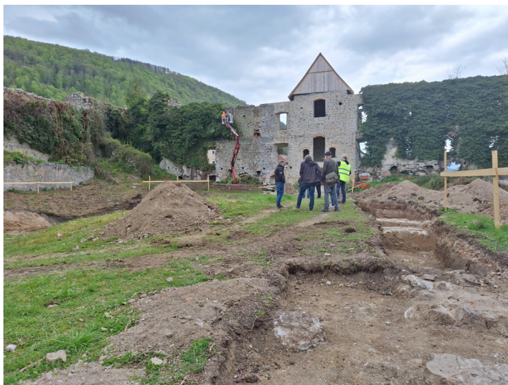
Slika 1: Arheološke raziskave na dvorišču z odkritimi temelji in tlaki južnega trakta ter odstranjevanje bršljana z vzhodnega obodnega zidu (Foto: Tomaž Golob, 2025)
