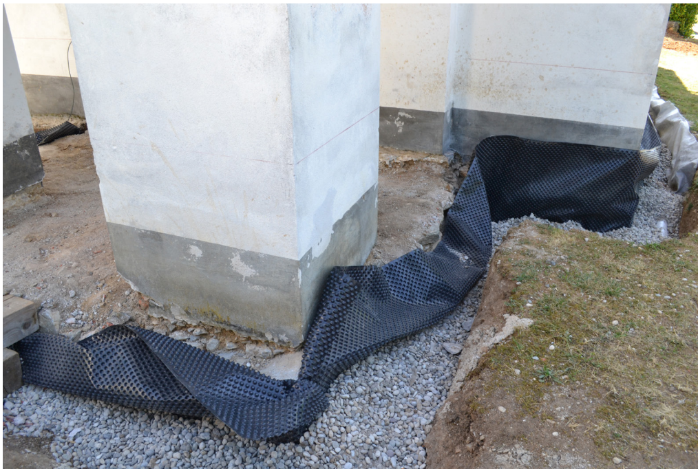
Slika 2: Izvedba drenaže okoli zvonika (Foto: Ana Krevelj, 2025)
