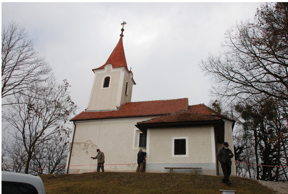
Slika 1: Cerkev sv. Jakoba po potresu v Petrinji leta 2020 (Foto: Bojan Zaletelj, 2021)
