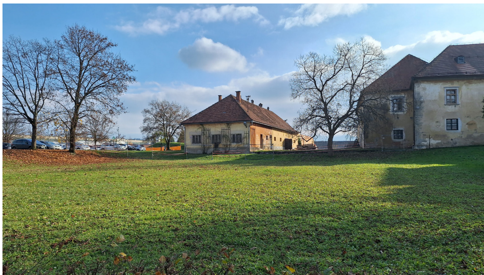
Slika 1: Grajski hlev pri gradu Grm pred začetkom rušitve (Foto: Dušan Štepec, 2025)
