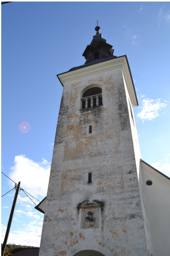
Slika 3: Detajl z zvonikom pred posegi (Foto: Ana Krevelj, 2024)
