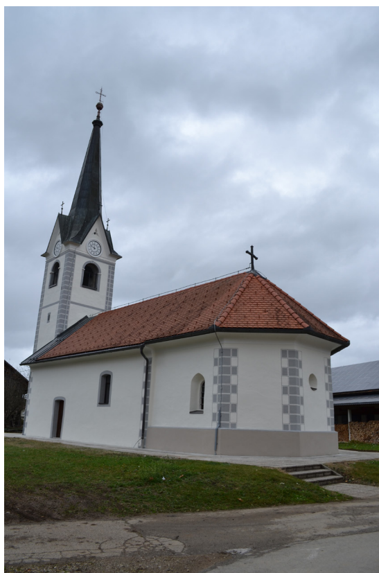
Slika 2: Cerkev sv. Štefana po obnovi (Foto: Ana Krevelj, 2025)
