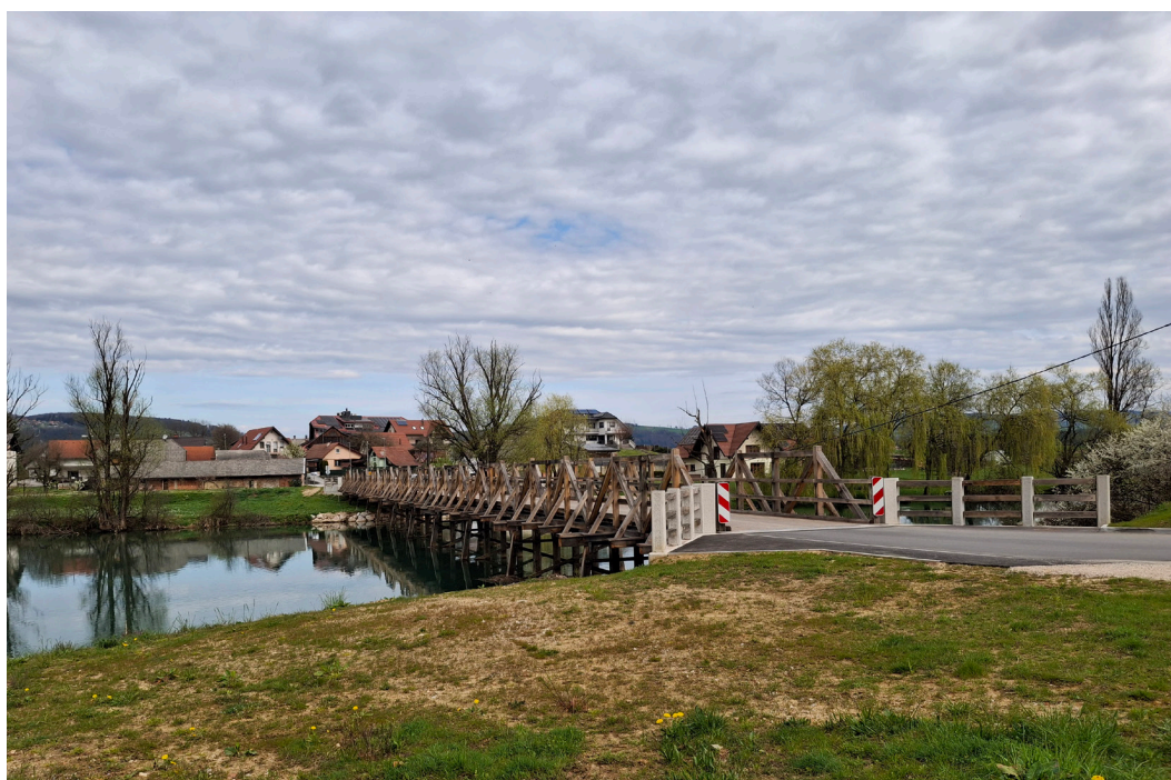
Slika 4: Pogled na most po zaključenem delu (Foto: Judita Podgornik Zaletelj, 2026)
