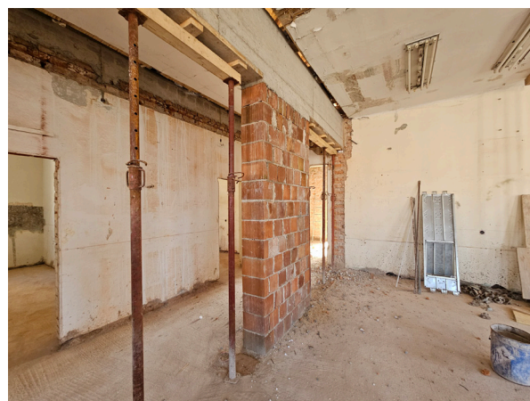
Slika 2: Statična sanacija v notranjosti objekta (Foto: Vita Weiss Babič, 2026)
