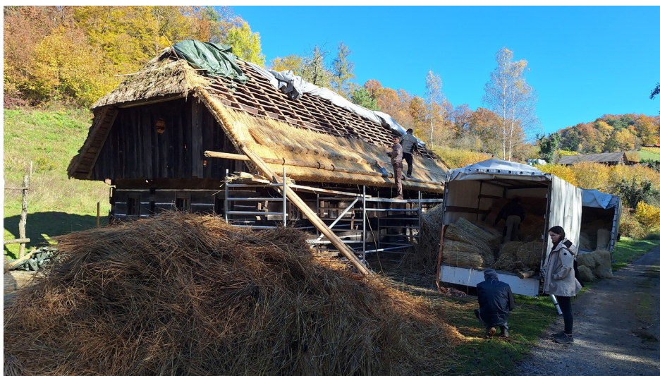
Slika 2: Slamokrovec pri prekrivanju strehe s slamo (Foto: Dušan Štepec, 2025)
