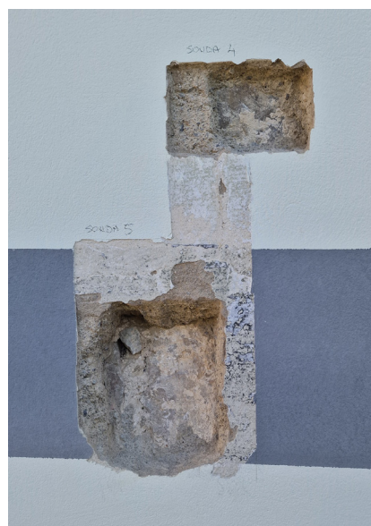
Slika 2: Sondažne raziskave na južni fasadi severovzhodnega stolpa (Foto: Tanja Mesojedec, 2025)
