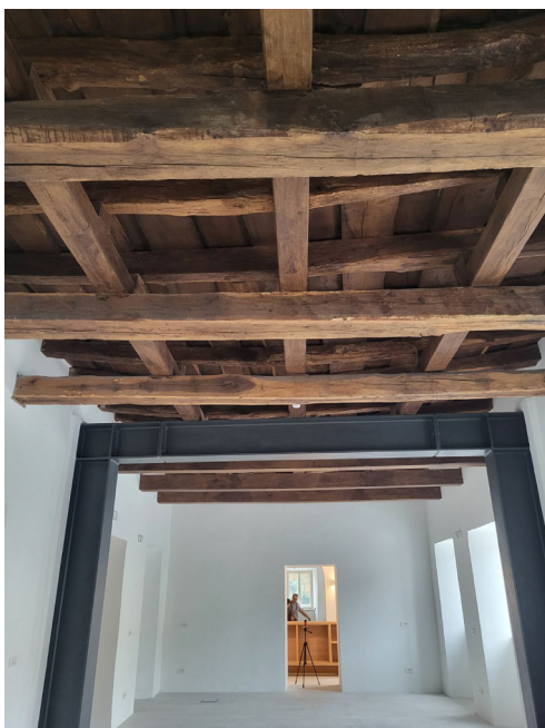
Slika 1: Rekonstrukcija lesenega stropa v dvorani (Foto: Mojca Verček Rems, 2025)
