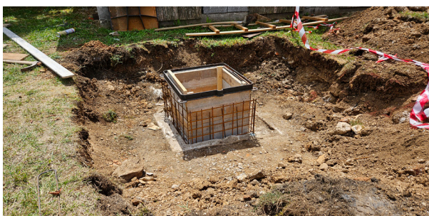
Slika 6: Izdelava opaža za nov jašek (Foto: Martin Pungerčar, 2025)
