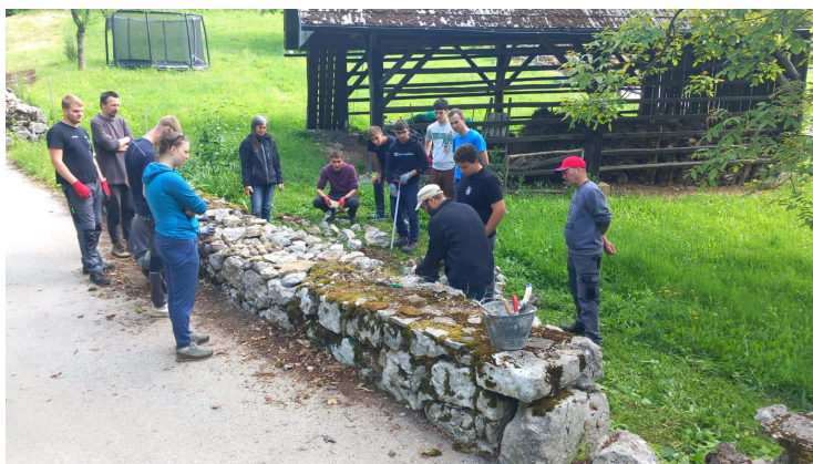
Slika 1: Dijaki pri obnovi kamnitega zidu na Trški gori (Foto: Mateja Kavčič, 2025)
