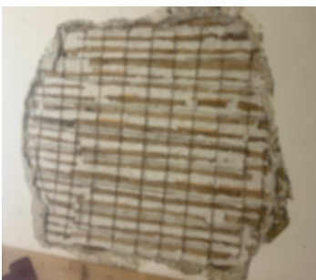
Slika 2: Sanacija poškodbe (Foto: Saša Snoj, 2025)
