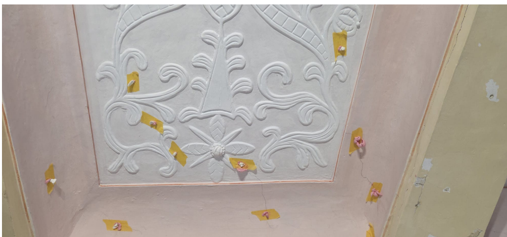
Slika 4: Injektiranje stropnih ometov v slavnostni dvorani (Foto: Anja Urbanc, 2025)
