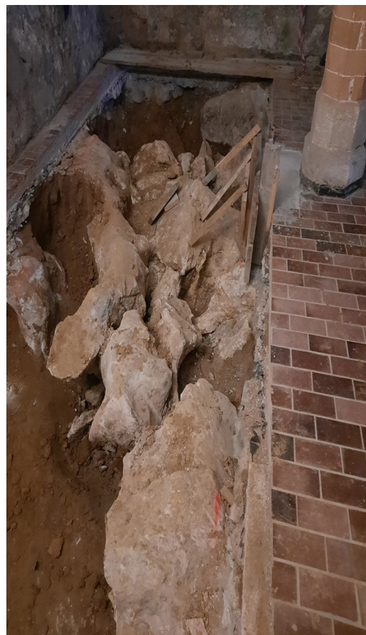
Slika 2: Izvedba geomehanske sonde v tleh kripte novomeške stolnice (Foto: Ana Krevelj, 2025)
