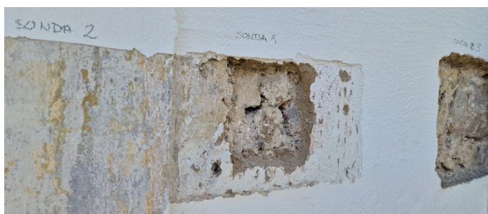
Slika 1: Sondažne raziskave na vzhodni fasadi (Foto: Tanja Mesojedec, 2025)
