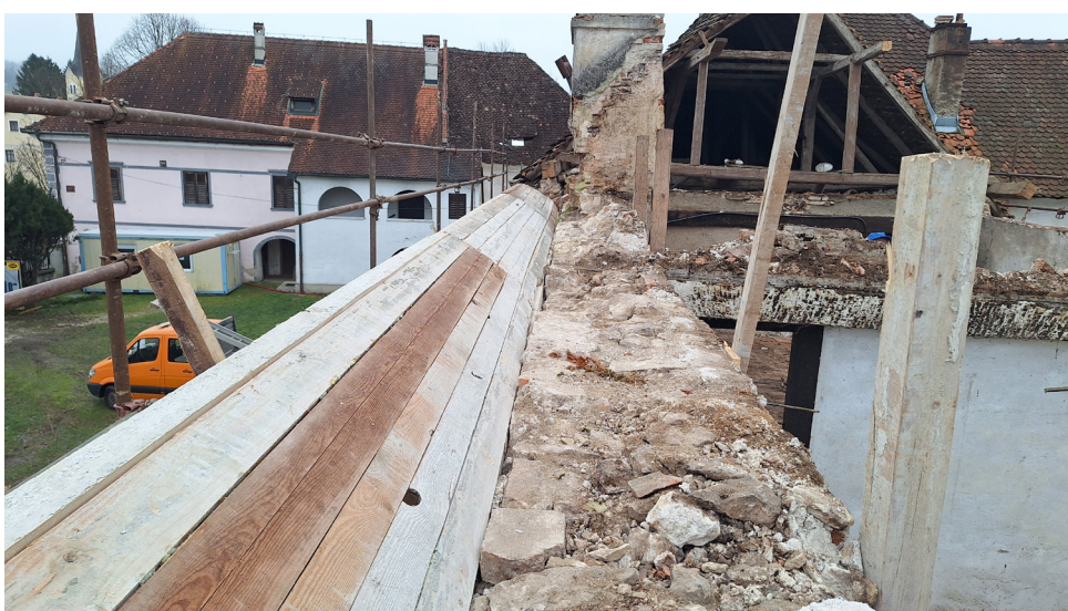
Slika 4: Lesen opaz, pripravljen za izvedbo polkrožnega strešnega venca (Foto: Dušan Štepec, 2026)
