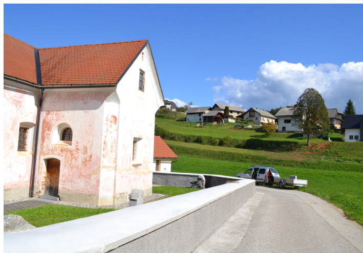
Slika 6: Obnovljen del pokopališkega zidu (Foto: Ana Krevelj, 2025)
