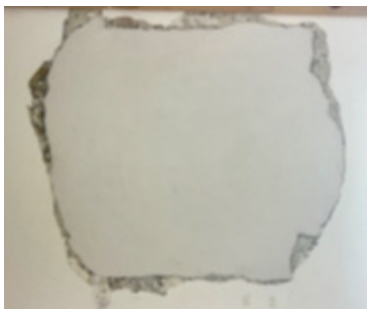
Slika 3: Pogled na strop po posegu (Foto: Saša Snoj, 2025)
