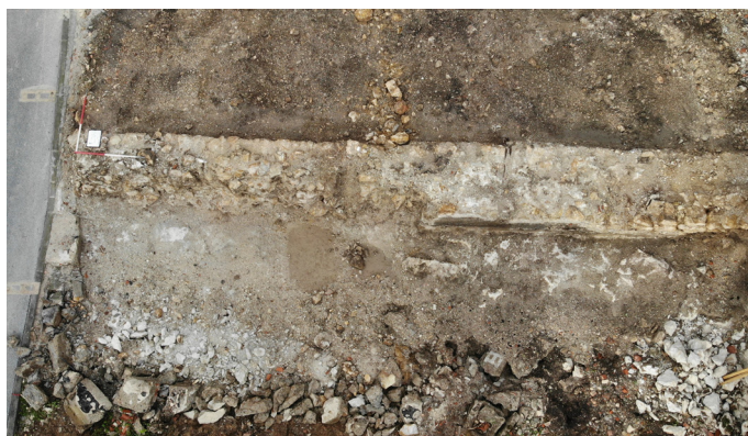
Slika 2: Temelji objekta, ki so ga odstranili, so bili postavljeni na skalnato osnovo, na rob mestnega pomola. (Foto: Žiga Mavrič, 2025)
