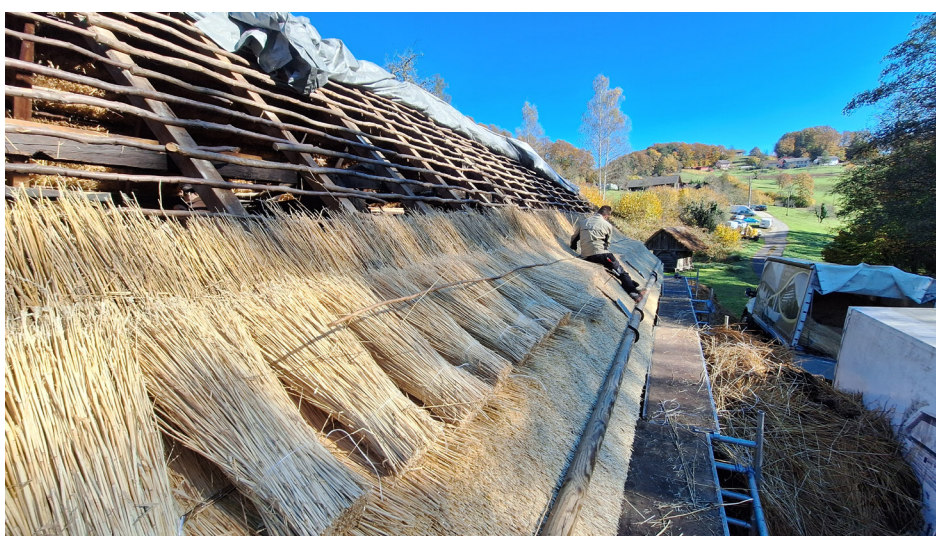
Slika 3: Za pokrivanje je slamokrovec uporabil rženo slamo. (Foto: Dušan Štepec, 2025)
