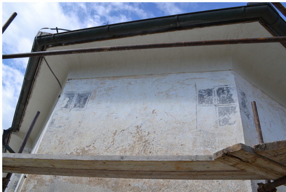
Slika 4: Sondiranje ometa in beleža na fasadi prezbiterja (Foto: Ana Krevelj, 2025)
