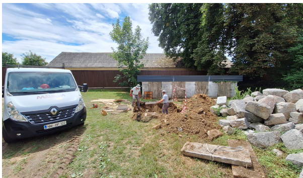
Slika 5: Popravilo jaška nad greznico pri gradu Grm (Foto: Dušan Štepec, 2025)
