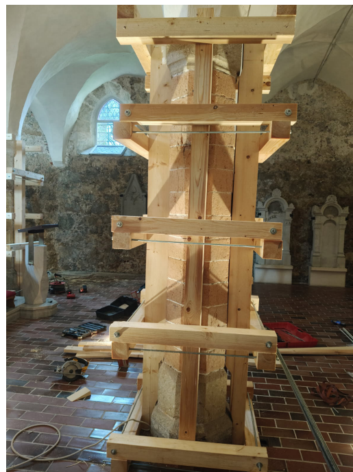
Slika 4: Začasna stabilizacija slopov (Foto: Klavdio Peterca, 2025)
