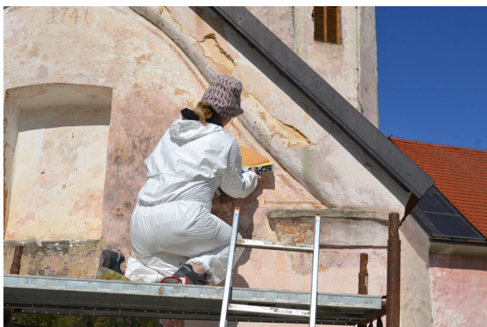
Slika 4: Sondiranje ometa in beleža na vhodnem loku (Foto: Ana Krevelj, 2025)
