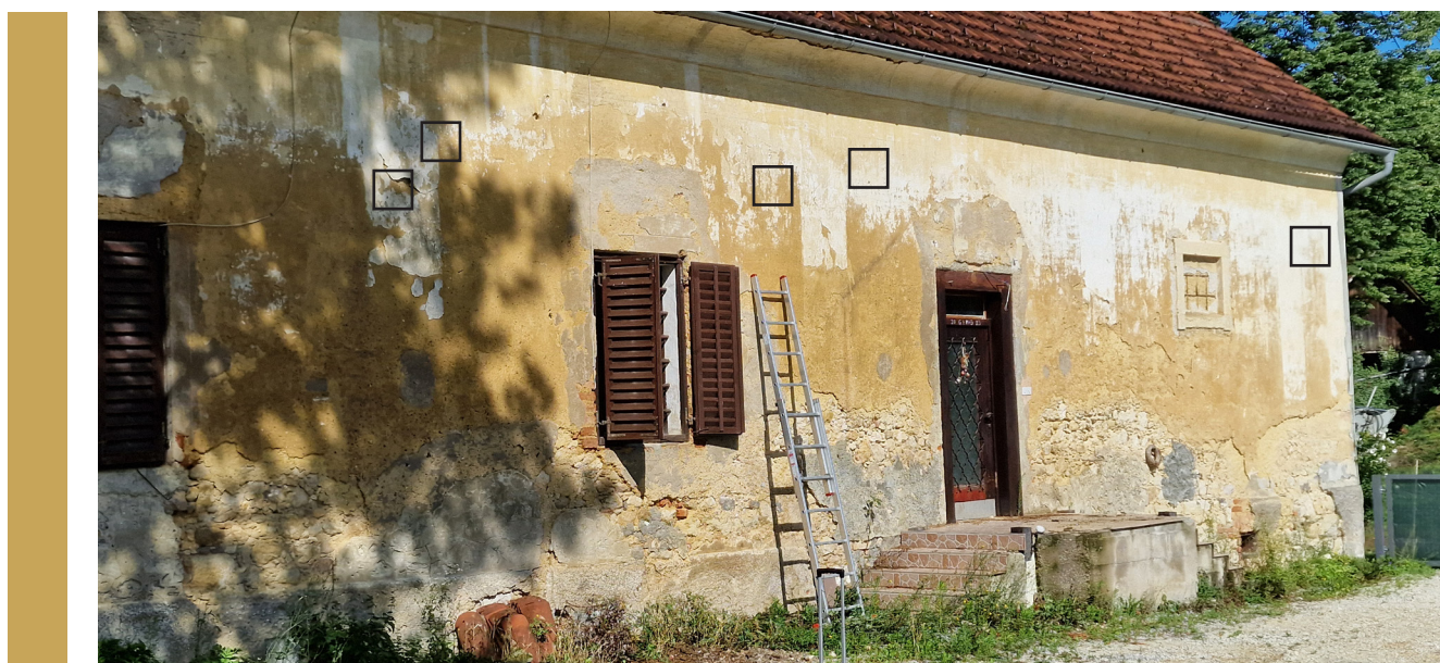
Slika 1: Sondažne raziskave na vzhodni fasadi (Foto: Tanja Mesojedec, 2025)
