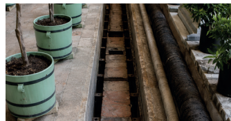
Primerjalni primer ogrevalnega kanala v oranžeriji doma Samanoci v Potsdamu (vir: Orangeriekultur im Sachsen-Anhalt und Nachbarländern, Lukas Verlag, str. 152, foto: T. Seeger 2022)
