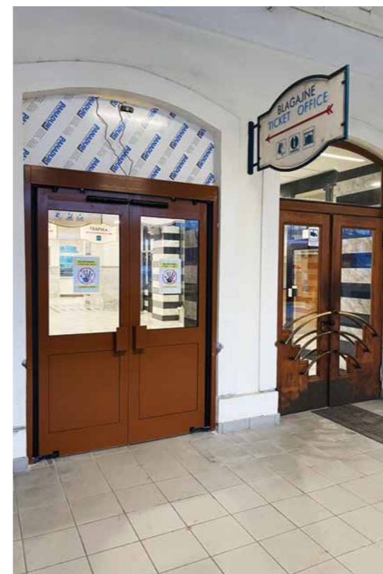
16 Celje - železniška postaja, zamenjava prvotnih nihajnih vrat z avtomatiziranimi. Foto: T. Hohnec, 2025
