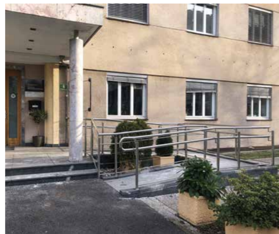
10 Zavita klančina ob vhodu javne stavbe. Foto: T. Hohnec, 2023
