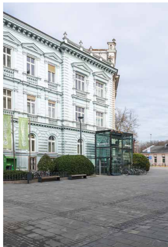
19 Dvigalo v varovanem območju mestnega jedra Celje. Foto: J. Kunšek, 2024
