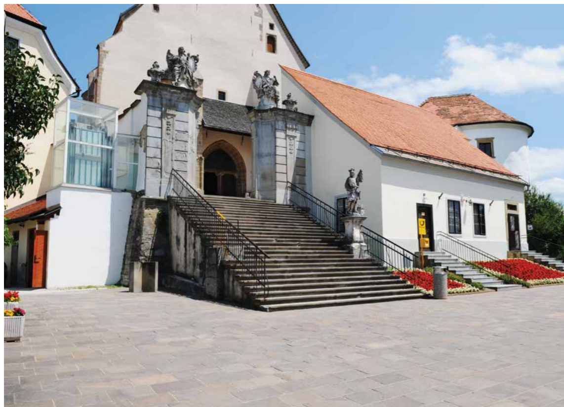
22 Neustrezna lokacija dvigala ob levi strani stopnišča, ki vodi do vhoda v cerkev na Ptujski Gori. Foto: R. Peskar, 2011
