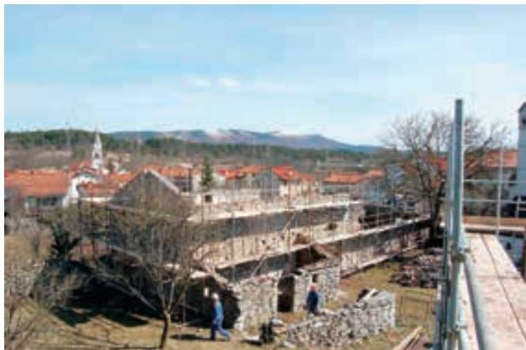
Štala s senikom med obnovo v letu 2009 (foto: Eda Belingar, arhiv ZVKDS, Območna enota Nova Gorica)
