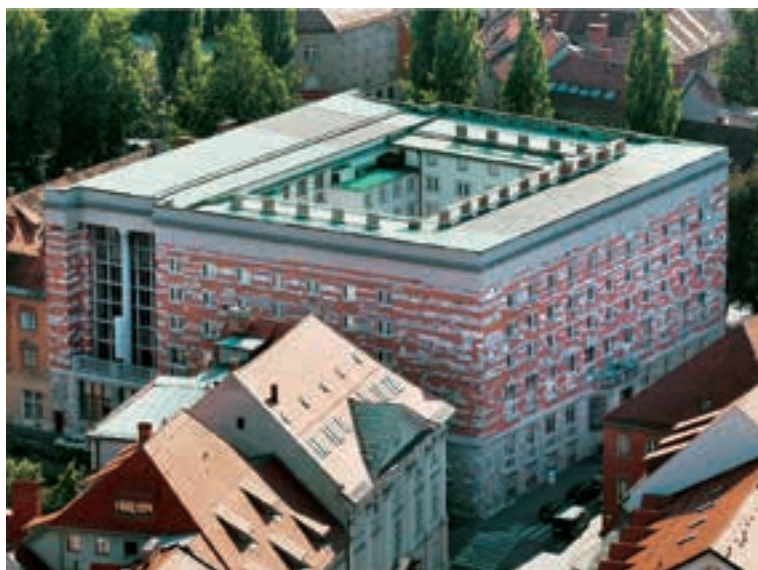
Ljubljana, Narodna in univerzitetna knjižnica, arhitekt Jože Plečnik; prenova leta 1945: arhitekt Marko Mušič, konservatorica Staša Blažič, 1989 (foto: arhiv INDOK centra, Ministrstvo za kulturo)
