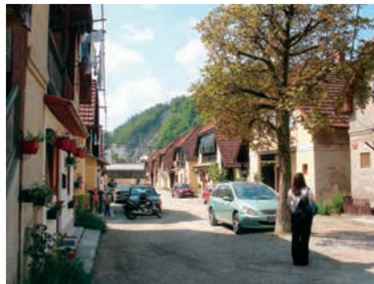
Trbovlje, Občinska kolonija, arhitekt F. Razinger, 1927–1939, pred prenovo (foto: Tanja Hohneč, arhiv ZVKDS, Območna enota Celje)
