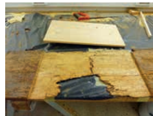
Visoko pod Kureščkom, cerkev sv. Nikolaja, del lesenega poslikanega stropa med konservatorsko-restavratorskimi posegi, detajl reševanja uničenega nosilca (foto: Vito Dolničar, arhiv ZVKDS, Restavratorski center)
