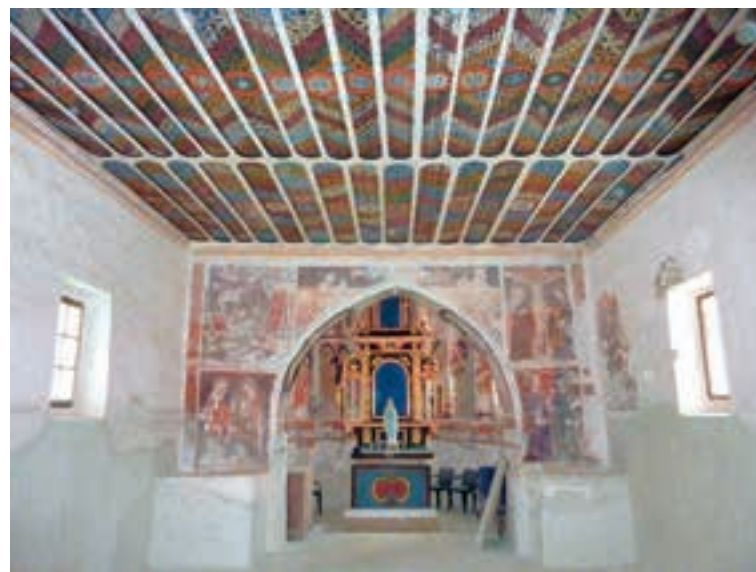
Visoko pod Kureščkom, cerkev sv. Nikolaja, lesen poslikan strop po konservatorsko-restavratorskem posegu, 2011 (foto: Vito Dolničar, arhiv ZVKDS, Restavratorski center)
