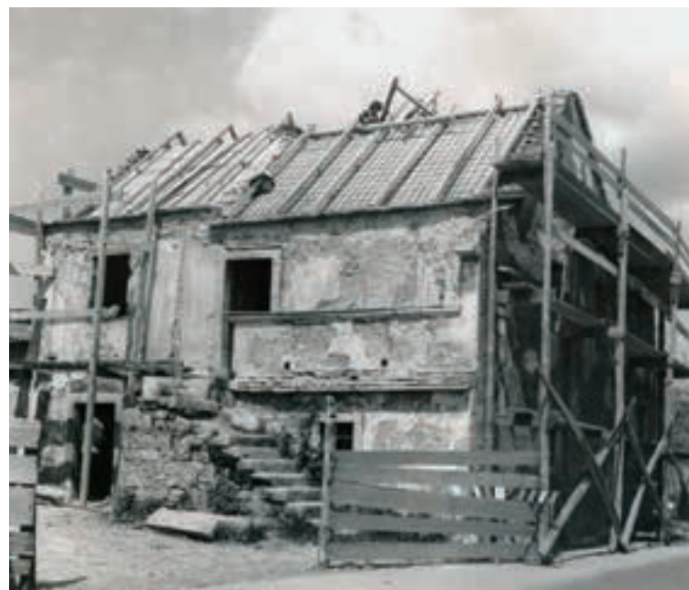
Škrateljnova hiša med obnovo v sedemdesetih letih 20. stoletja (foto: arhiv ZVKDS, Območna enota Nova Gorica)
