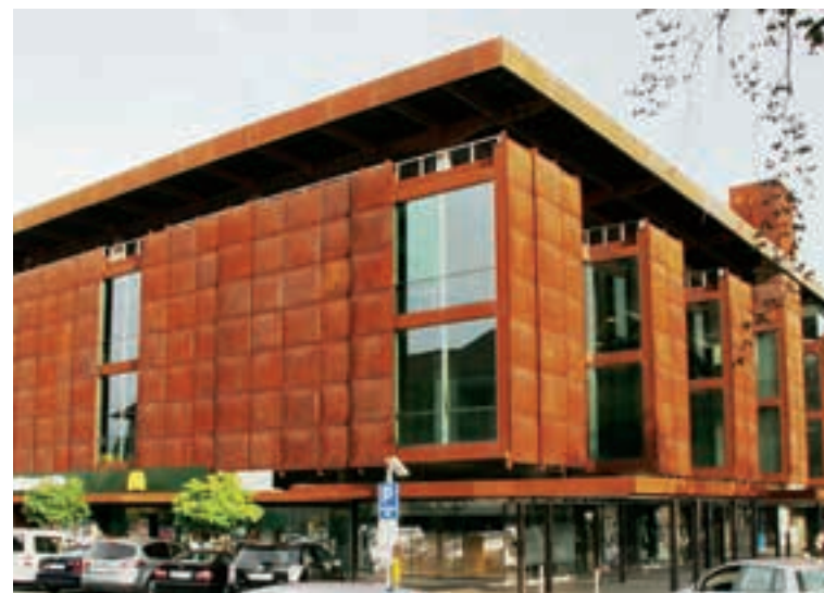
Kranj, Blagovnica Globus, arhitekt Edvard Ravnikar, 1969–1972; danes Mestna knjižnica Kranj, prenova leta 2008: arhitekta Uroš Birs in Majda Kregar (Ambient), konservatorica Nika Leben (foto: Gojko Zupan)
