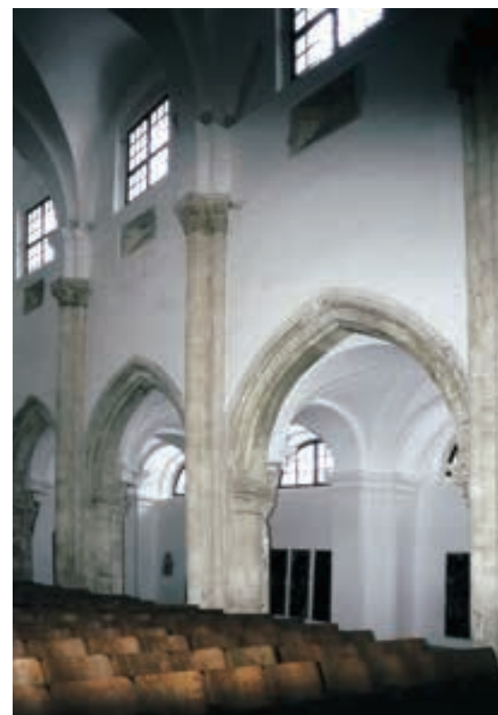
Samostan Kostanjevica na Krki, notranjost cerkve po rekonstrukciji (foto: Valentin Benedik, arhiv ZVKDS, Restavratski center)
