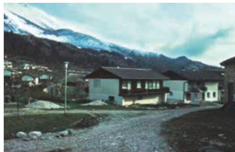
Porušen ter zgrajen »novi Breginj« (foto: Peter Fister)
