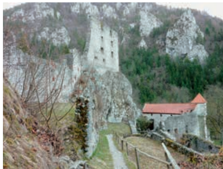
Grad Kamen pri Begunjah, konservirani zidovi grajskega kompleksa (foto: Mateja Kavčič, arhiv ZVKDS, Restavratski center)
