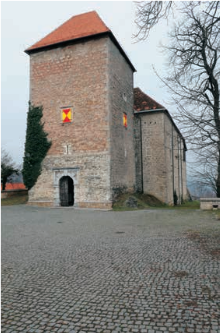
Vhodni stolp z vzhodne strani (foto: Robert Peskar, arhiv ZVKDS, Območna enota Novo mesto)
