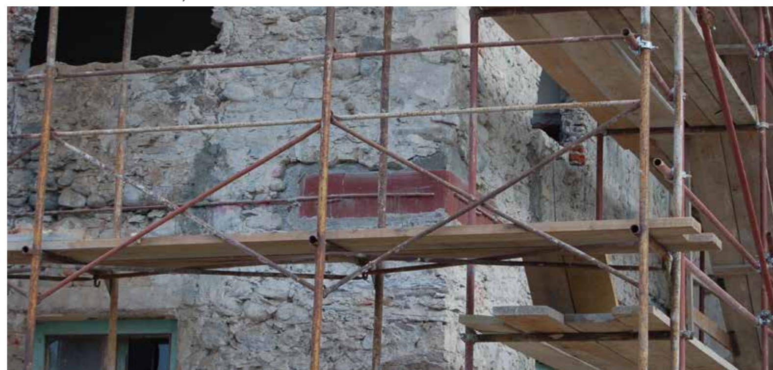
→ Vgrajene jeklene horizontalne vezi za izboljšanje statične stabilnosti objekta
