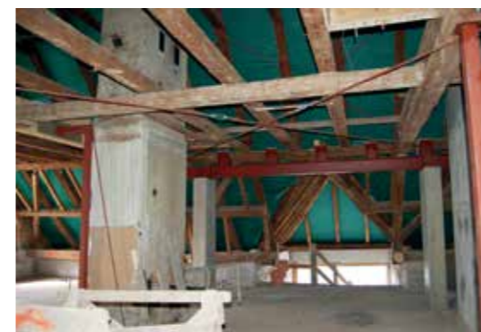
→ Vgrajene jeklene horizontalne vezi za izboljšanje statične stabilnosti objekta
