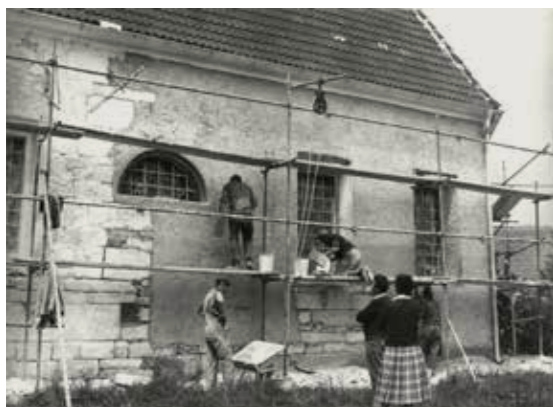
→ Črešnjevec – cerkev sv. Mihaela med obnovo
