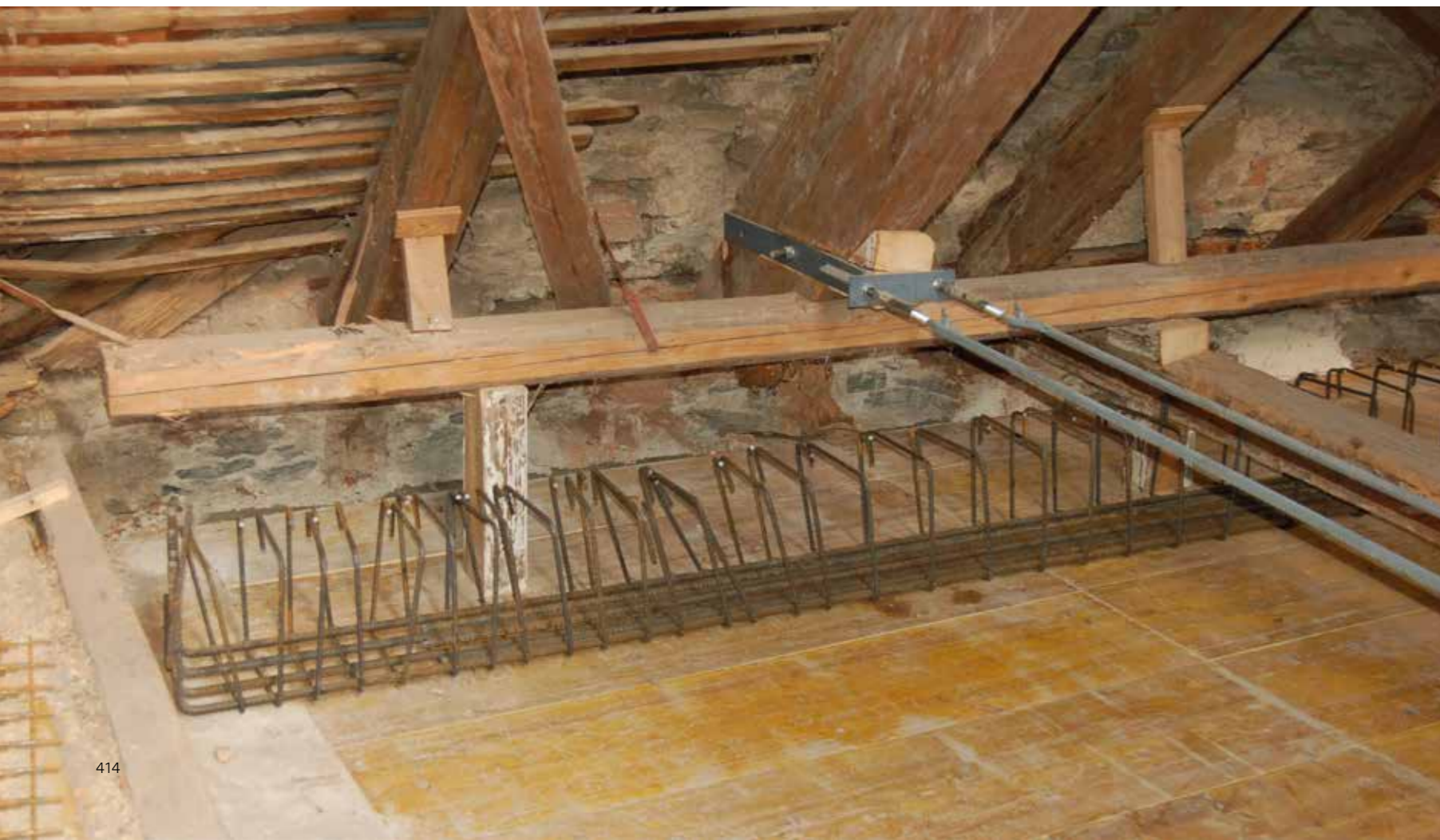
→ Sovprežna konstrukcija z novim tankim armiranobetonskim estrihom
