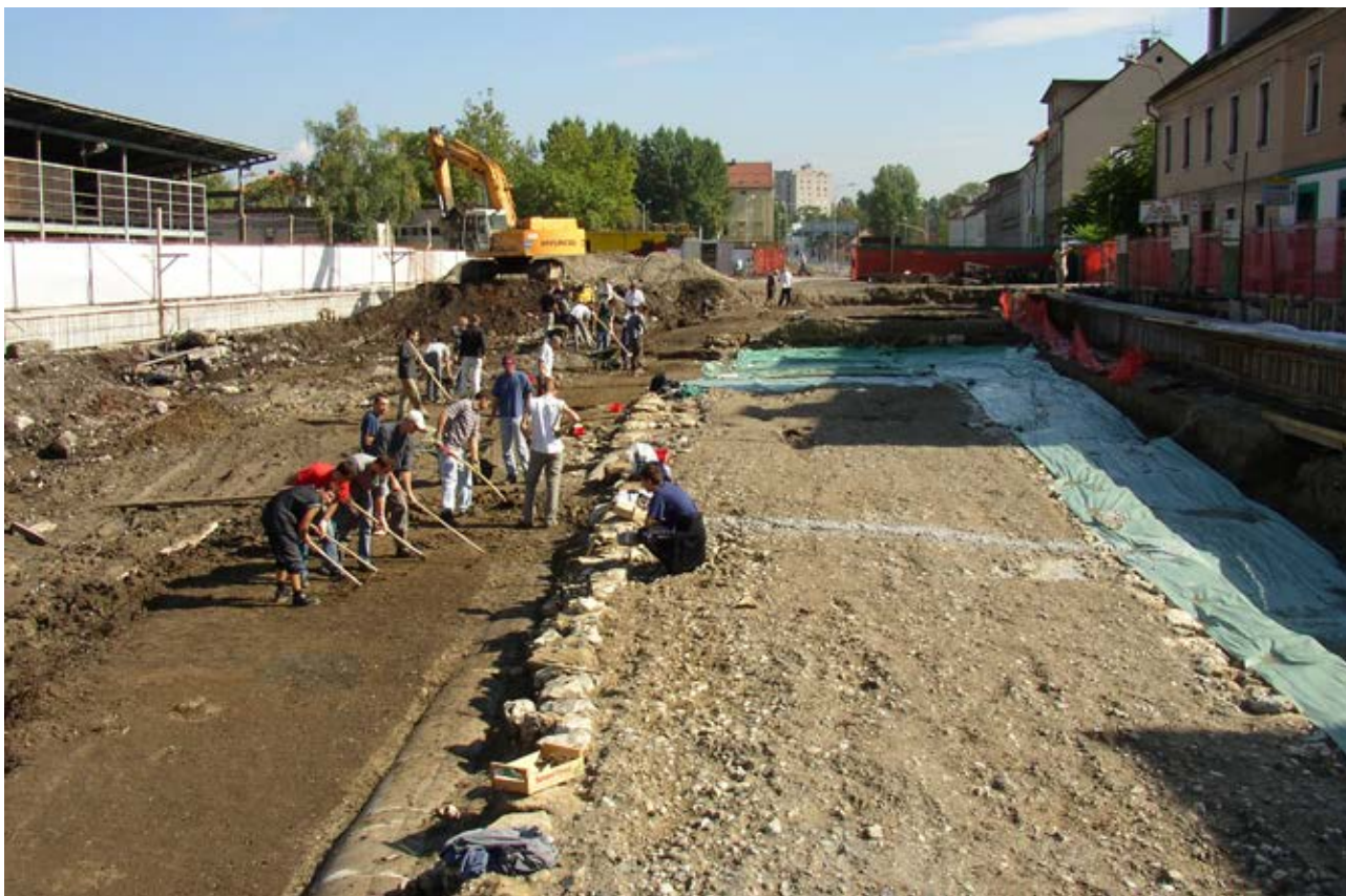
310 Faza 6b. Avstrijska cesta v severnem sektorju. Pogled proti severovzhodu.
