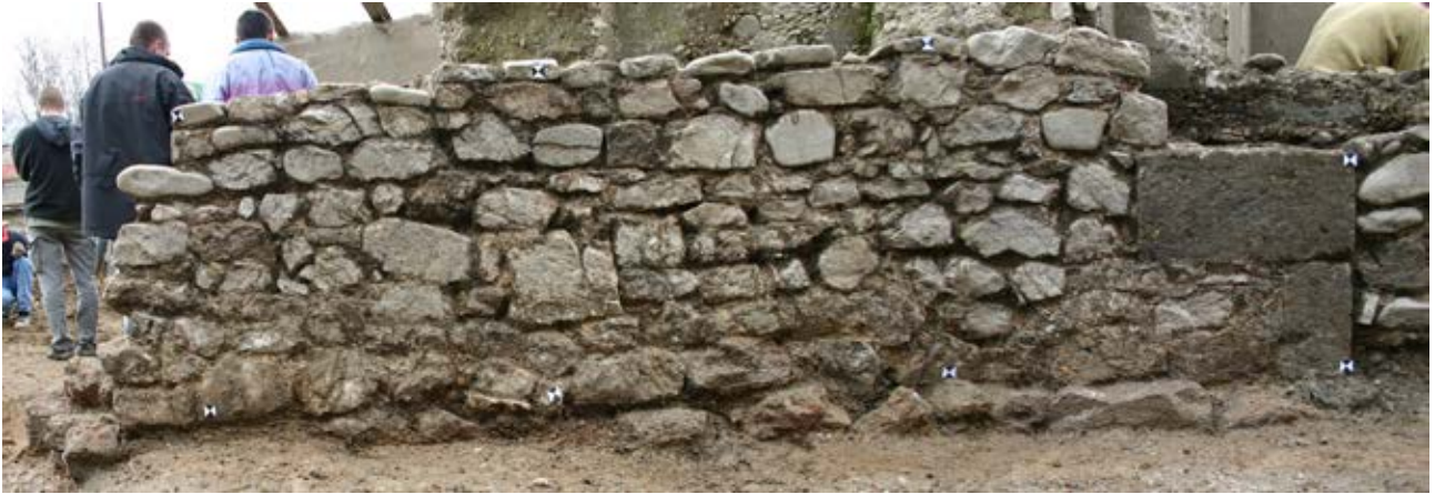
363 Faza 2a, grobna parcela J2. Zid SE 3542 grobne parcele z obdelanimi vogalniki. Pogled proti vzhodu.
