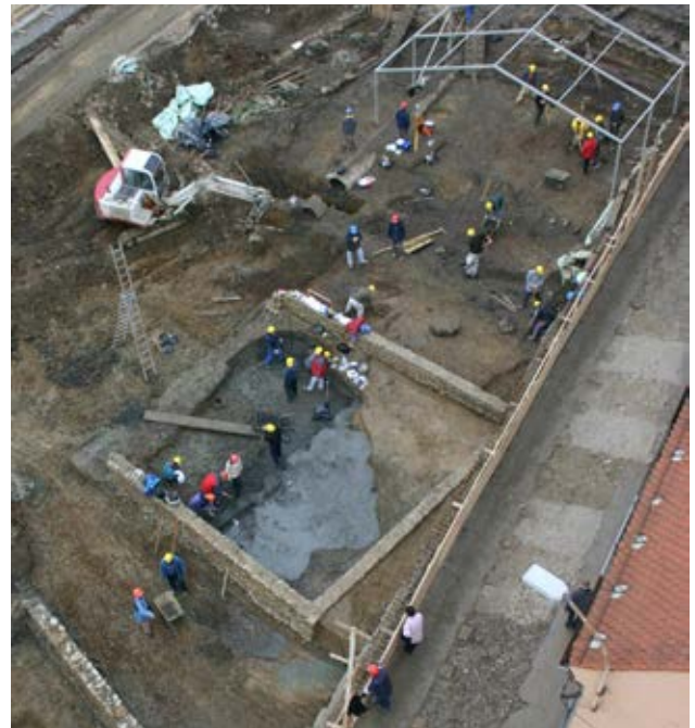
80 Pogled na izkop zadnje faze kala in objekta severovzhodno od njega (vidni še obodni zidovi cele svetišča I iz faze 2a). Pogled proti severovzhodu.
