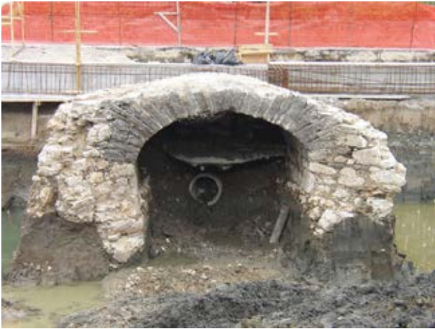
722 Kamniti zidani prepust vzhodno od velenjske proge je nadomestil lesene mostove na komercialni cesti. Na vzhodni opornik je poševno prislonjen betonski zid za usmerjanje vode v prepust, ki ni bil nikoli povsem zasut.
