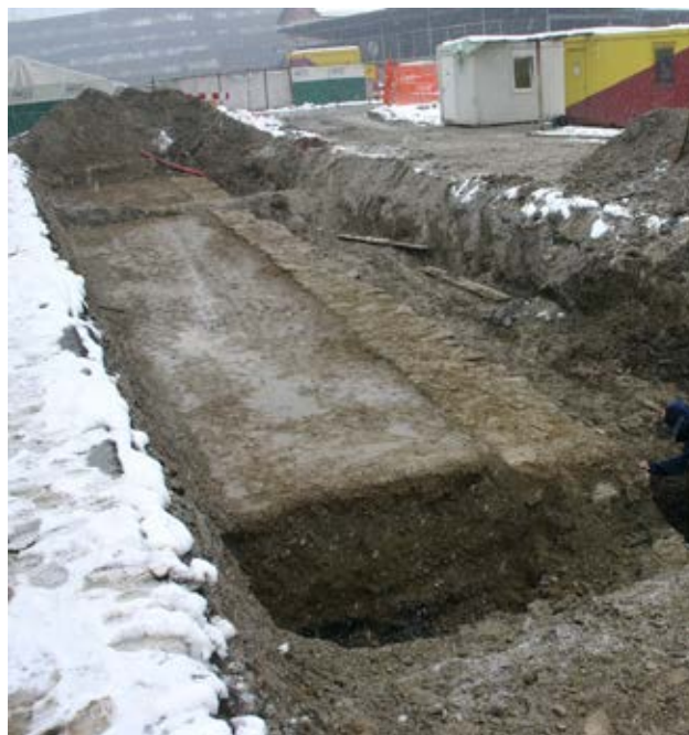
311 Faza 6b. Zid SE 3125 in cestišče SE 3126.
