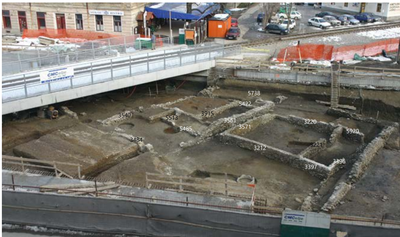
400 Faza 2c. Parceli J5 in J6. Pogled proti jugovzhodu.
