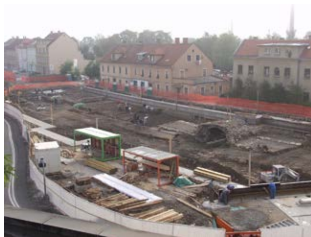
720 Odnos med cestiščem komercialne ceste in prepustom, postavljenim ob gradnji velenjske železnice leta 1891.
