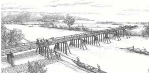
761 Le Rondet. Rekonstrukcija lesenega mostu s stebri iz ene vrste pilotov s stranskima opornikoma, iz časa po 7 pred našim štetjem (po Schwab 2003).
