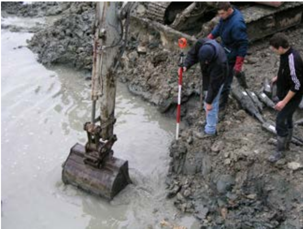
723 Izkop polnil mrtvice in dokumentiranje pilotov iz temelja novoveškega prepusta.
