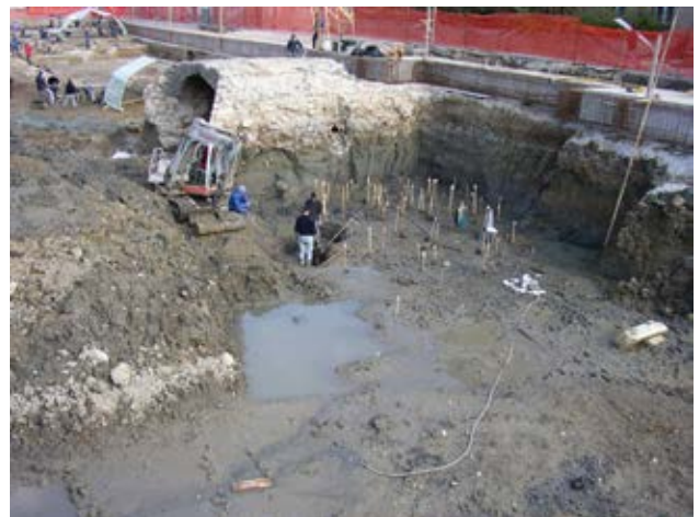
704 Označeni vrhovi pilotov na dnu struge. Desno v ospredju marmorna baza in pod njo kamnit arhitekturni element.
