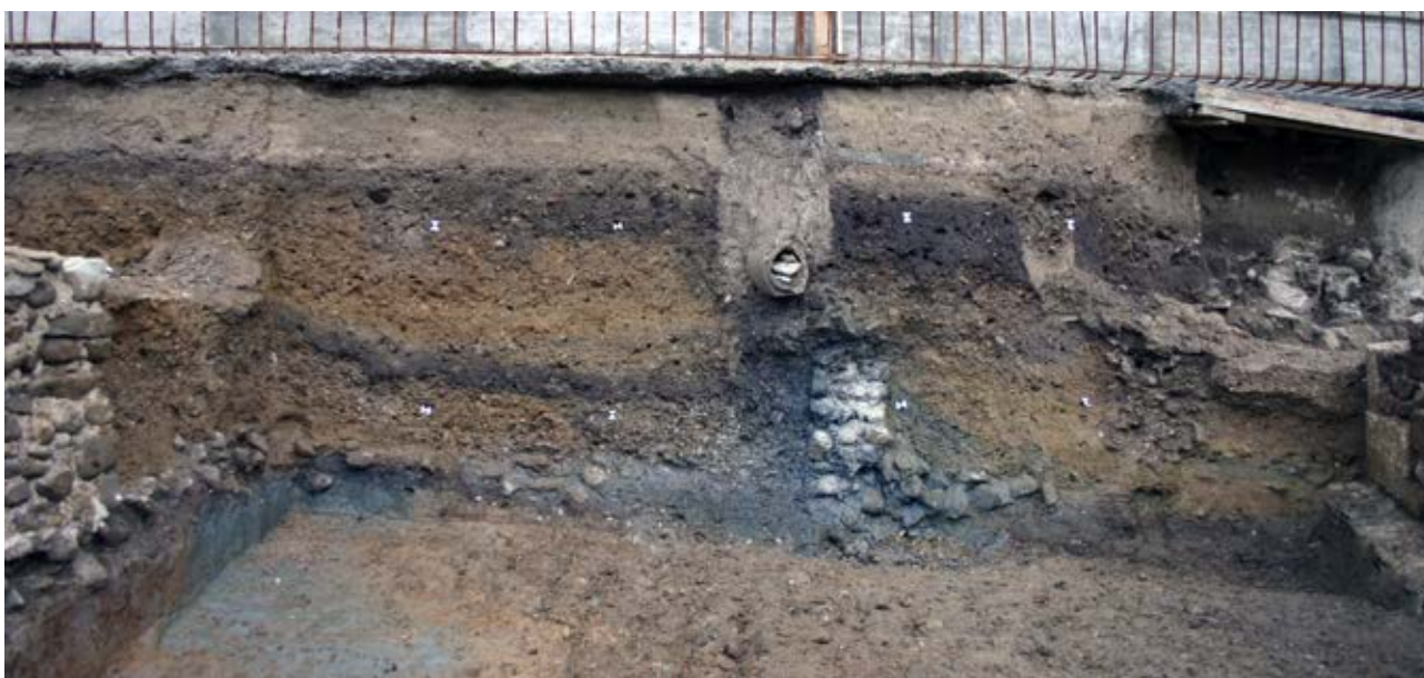
650 Presek zahodnega hodnika z obodnim zidom in vidnimi oblicami kot ostankom gradnje.
