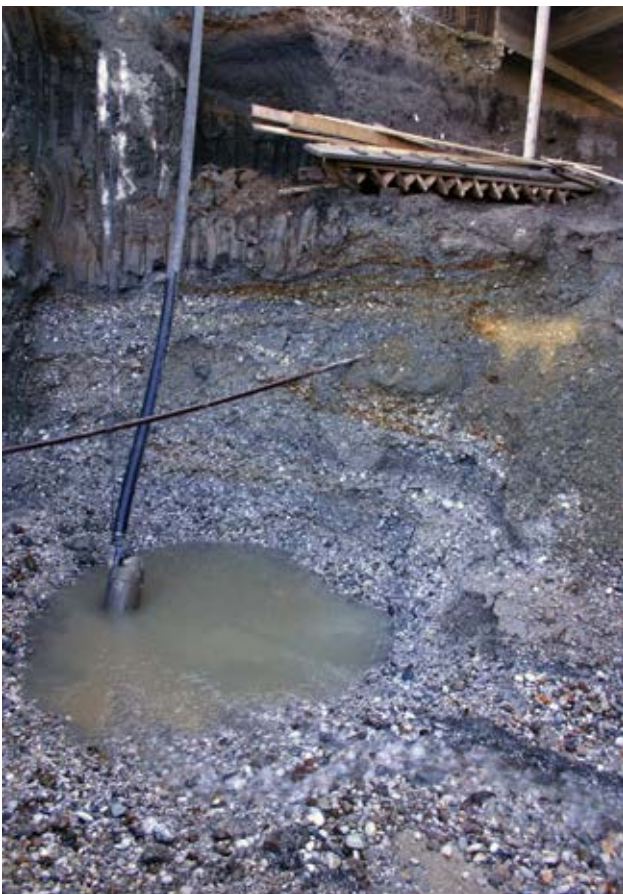
703 Prodatni zasip struge ob poglobitvi izkopa za gradnjo podložne plošče podvoza.
