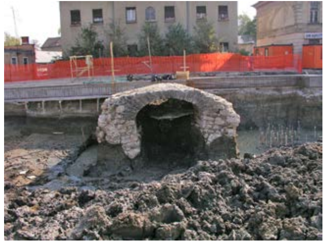
725 Višinsko razmerje med kamnitimi prepustom in ohranjenimi vrhovi pilotov četrtega stebra rimskega mostu.
