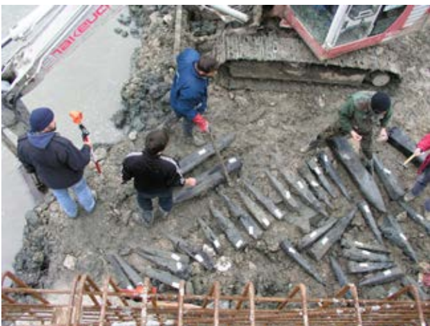
724 Izkop polnil mrtvice in dokumentiranje pilotov iz temelja novoveškega prepusta.
