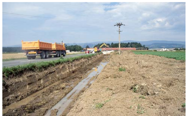
11 Pogled proti severozahodu na območje širitve priključne ceste iz/v Pragersko, sek. 2.
