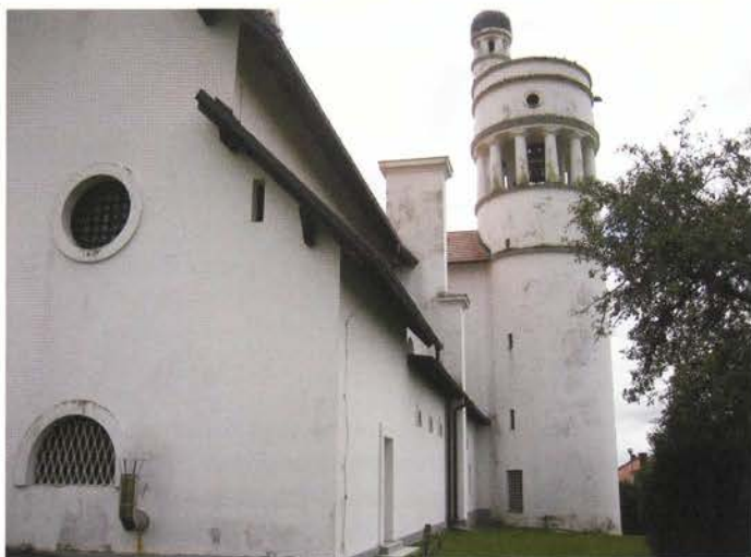
Del severne in zahodna fasada pred obnovo.
