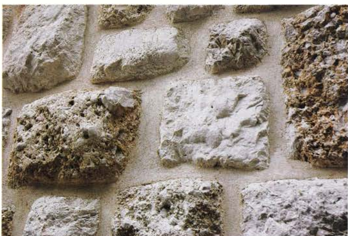
Detajl kamnite fasade.
