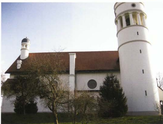
..... Južna fasada po obnovi jeseni 2006.
