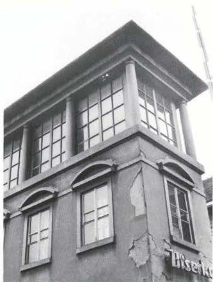
Stanje pred obnovo fasade leta 1990.
