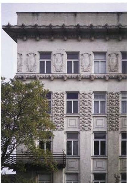
Balkoni hiše Langer na Dunaju tečejo čez oba vogala hiše in povezujejo fasado v enoten stavbni plašč. .....
