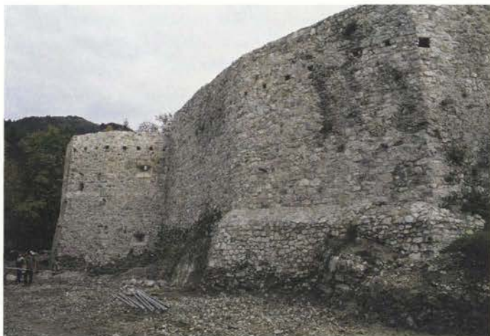
Jugozahodni predel obzidja grajskega jedra in renesančni severozahodni stolp po sanaciji in obnovi.
