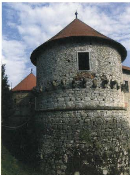
Severovzhodni stolp gradu pred obnovo. .....
