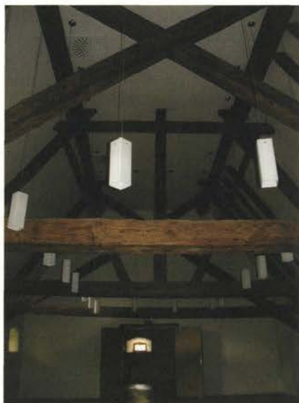
Strešna konstrukcija južnega trakta.
