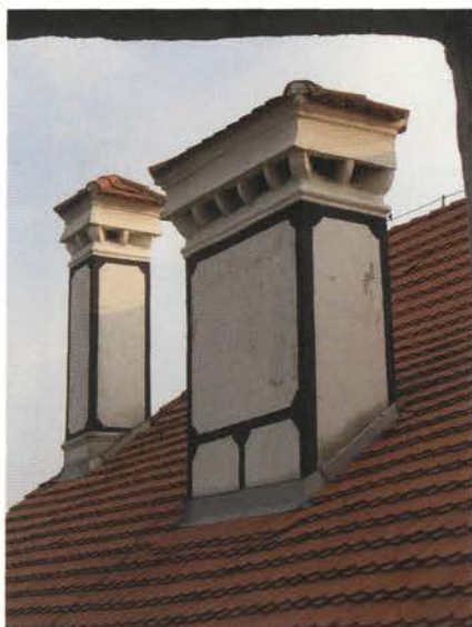
Obnovljeno ostrešje z dimnikoma. .....
