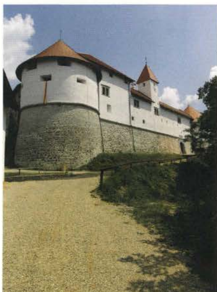
Obnovljeni zahodni trakt s stolpoma.
