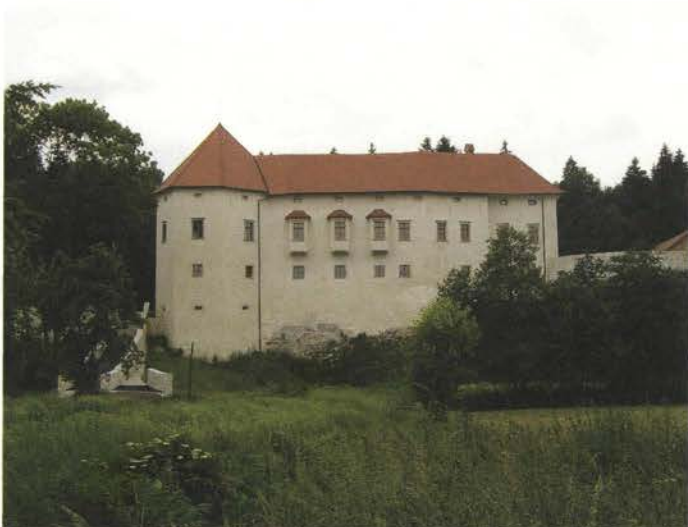
Pogled na vzhodno fasado po obnovi.
