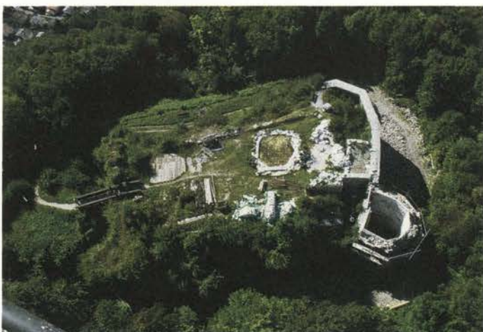
Aeroposnetek grajskega jedra med obnovo s severne strani.
