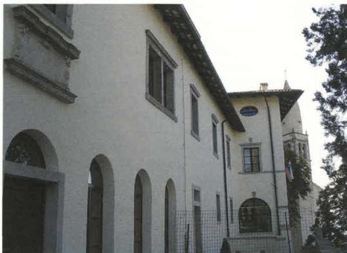
Prenovljeni del gornjega palacija s stolpom.
