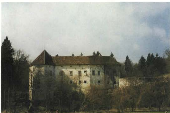
Pogled na vzhodno fasado pred obnovo.
