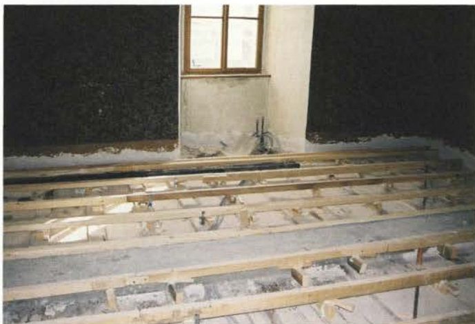
Statična ojačitev stropov v prvem nadstropju.
