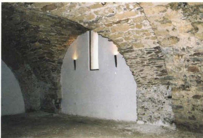
Obokani pritlični del zahodnega trakta s strelno lino.
