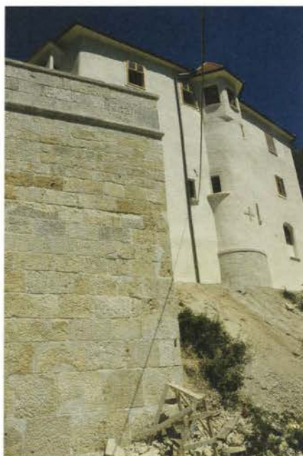
Južna fasada gradu in podporni zid po obnovi.
