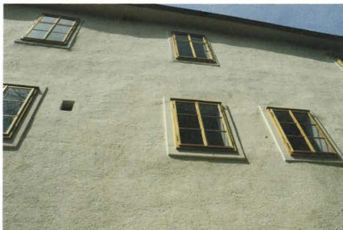
Vzhodna fasada gradu po obnovi.
