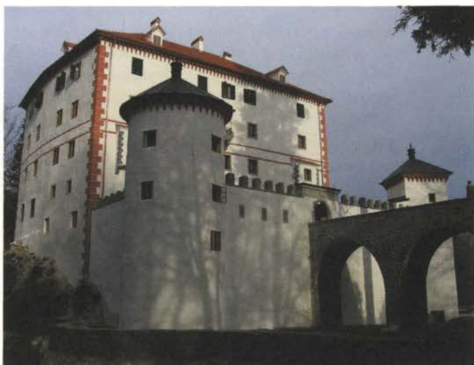
Pogled na jugovzhodno fasado po obnovi.
