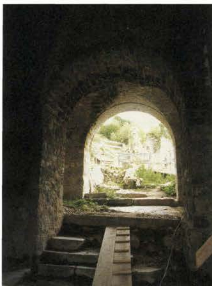
Vezni trakt, prehod na grajsko dvorišče.
