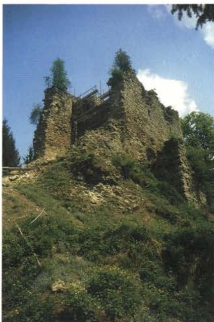
Friderikova hiša pred obnovo.
