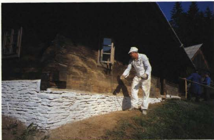
Skomarska hiša, pleskarji so upoštevali konsevatorska navodila: najprej s pigmenti, nato pa še s prahom izpod napušča hiše so odlično »postarali« videz novo vgrajenih tesanih brun, 1996.
