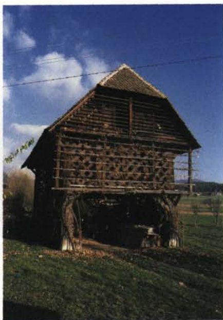
Toplarji imajo nosilne stebre in spodnje prečne tramove hrastove, drugi deli so večinoma smrekovi, Polže pri Soržu, 1999.
