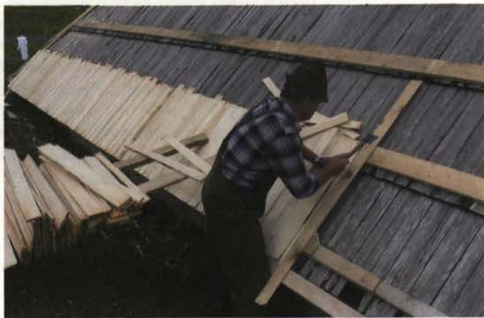
Poznavanje vrste in lastnosti lesa, izkušnje z njegovo obdelavo in vgrajevanjem so pogoj za kakovostno prekritje strehe s skodlami. Krovce prekriva pastirski stan na Veliki planini, 2004.
