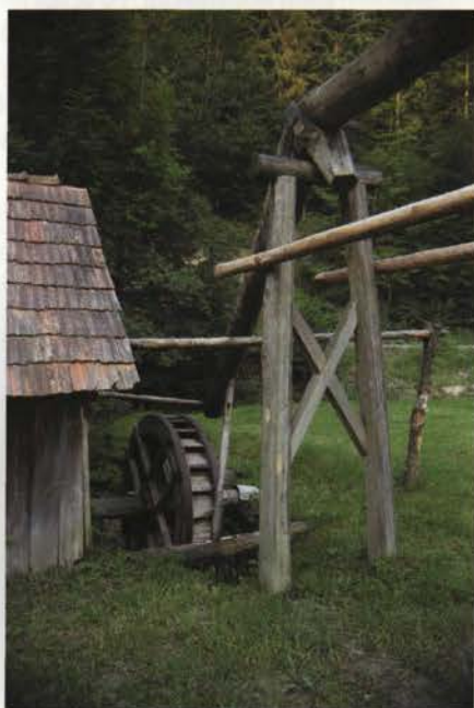
Šentjanž nad Dravčami, kmečki mlin s pogonom na zgornjo vodo, 1994.
