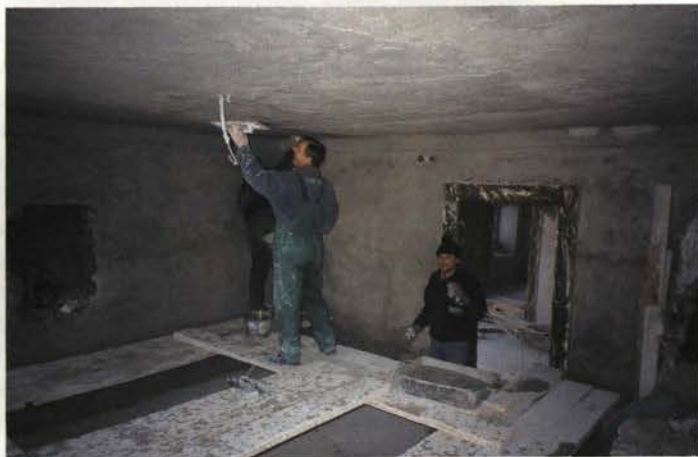
Obnova Škrabčeve domačije. Zidarji podjetja Grafit so uspeli rekonstruirati staro, rahlo valovito strukturo ometov, 1998.
