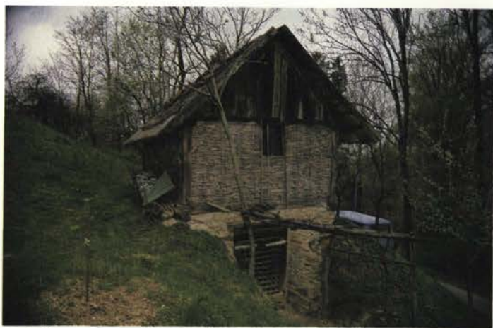
Vinska klet je v kletnem delu sicer zidana, v nadstropju pa spletena večinoma iz gabrovih vej in ometana z ilovico, Sovjak, 1993.
