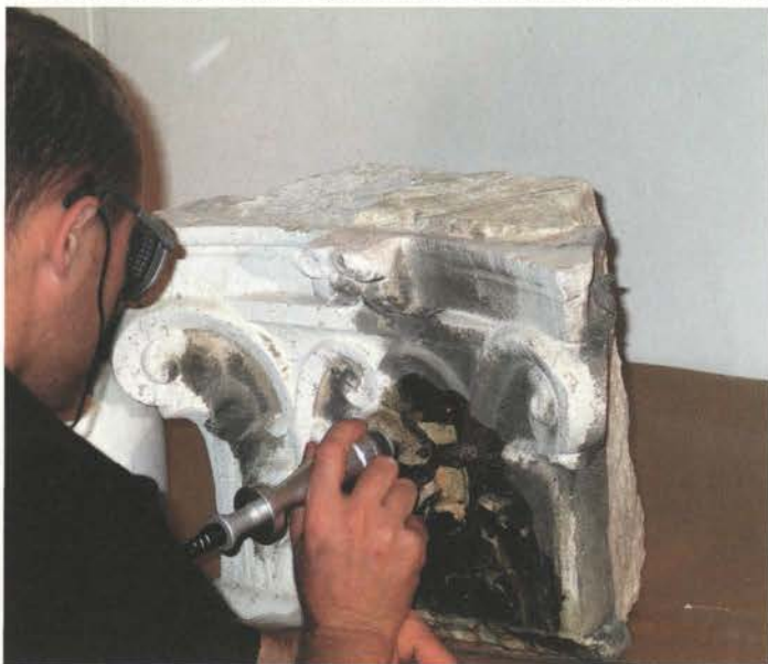
Čiščenje črnih oblog z laserjem.
