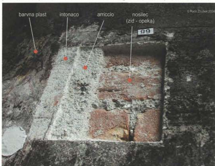
Zgradba fresko ometa.
