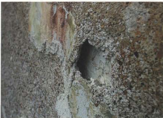
Značilno odpadanje ometa v spodnjem delu.
