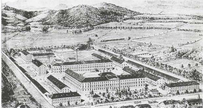
Ř. k. Haupt-Tabakfabrik in Taibadi.
