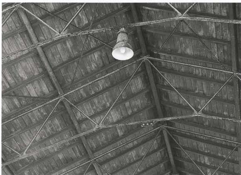
Mestna klavnica v Ljubljani ... »Jeklene palične konstrukcije streh imajo tudi mlajši objekti. Tak primer je hala mestne klavnice zgrajena leta 1926.« ...
