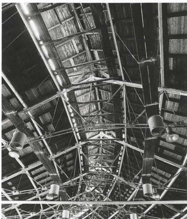
Železniške delavnice v Ljubljani ... »V osemdesetih letih 19. stoletja so se nekatere ljubljanske industrijske zgradbe ponašale tudi že z jeklenimi paličnimi strešnimi konstrukcijami.« ...
