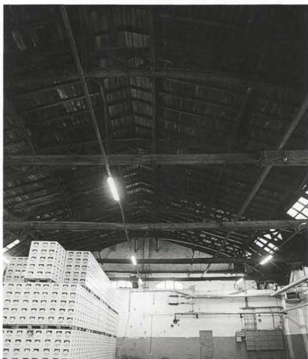
Pivovarna Union v Ljubljani ...»Stropne in strešne konstrukcije prvotnih industrijskih stavb so bile lesene.« ...
