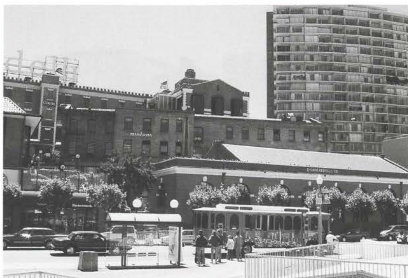
Tovarna čokolade Girardelli v San Franciscu (ZDA) ... »Revitalizirano območje je postalo pomemben vir dohodka ... Volumne starih industrijskih objektov so izrabili za nove funkcije.« ...
