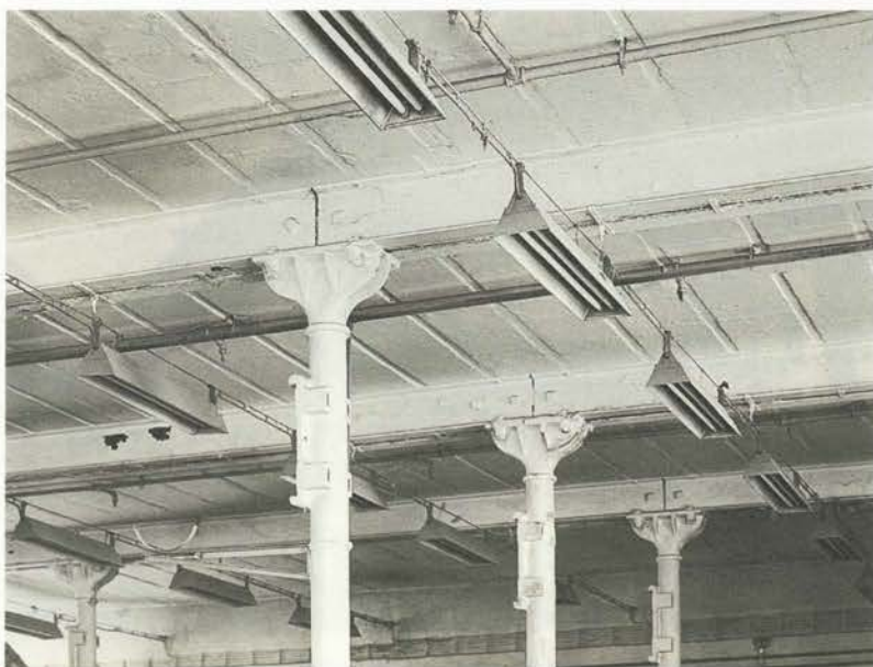
...»Notranja nosilna konstrukcija je sestavljena iz litoželeznih stebrov in nosilcev.« ...
