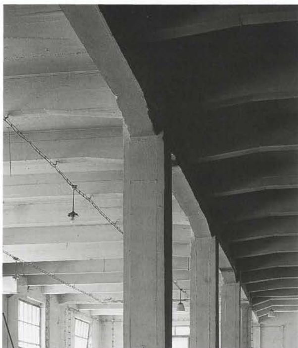
Tovarna Droga v Izoli ... »Po prvi svetovni vojni so železobeton že uporabljala vsa večja gradbena podjetja.« ...
