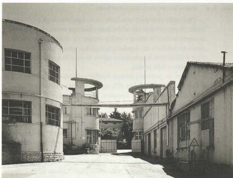
...»Vhod v tovarno je arhitekturna celota dveh polkrožno zaključenih zračalnih traktov.« ...
