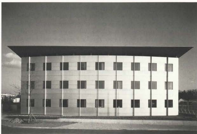
Fasada upravnega poslopja ... »Lešnik pri stavbi Farmadent uporabi montažne, metalne fasadne plošče, ki so obenem grelna telesa.« ...
