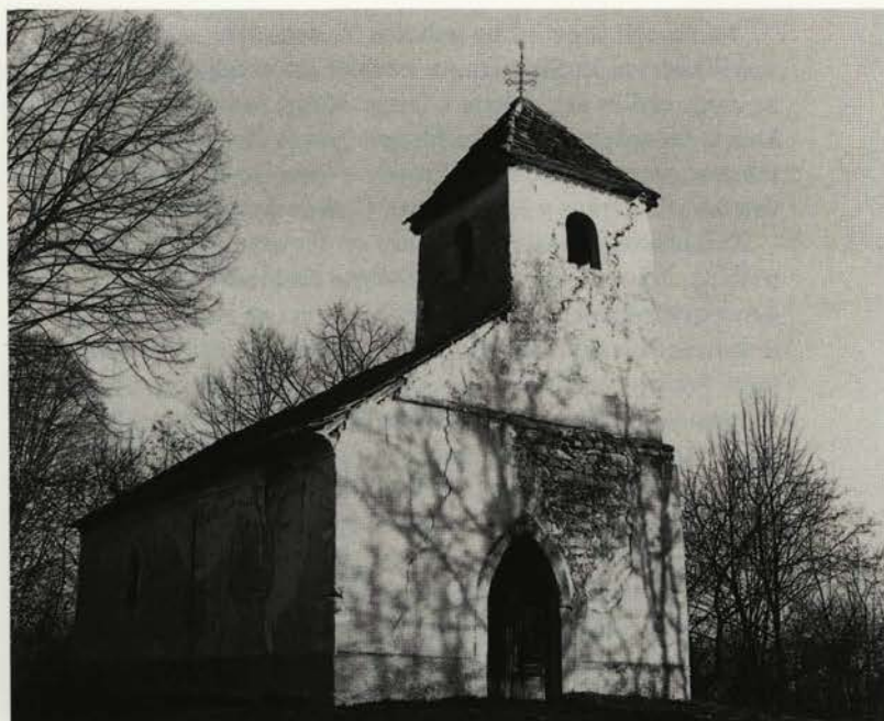
Cerkev sv. Helene pred obnovo ... »Zaradi vse večjih razpok na zvoniku, oboku in stenah ladje ter nevarnosti rušenja, je leta 1986 končno prišla pobuda za obsežno obnovo« ...
