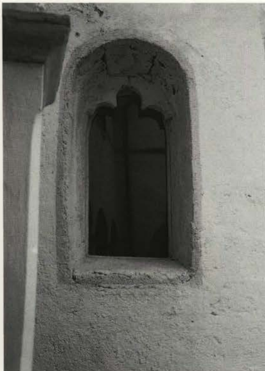
Obnovljeno gotsko okno ... »Odstranitev stopnišča pa je omogočila tudi odkritje gotskega okenca s trilistnim zaključkom na zahodni dvoriščni fasadi stolpa« ...
