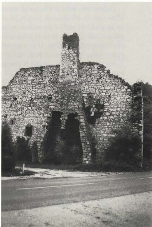
Ostanki severne stene in dimnika pred obnovo. ...»Tako danes o železarstvu na Dvoru pričajo le skromni ostanki nekdanje železarne...«
