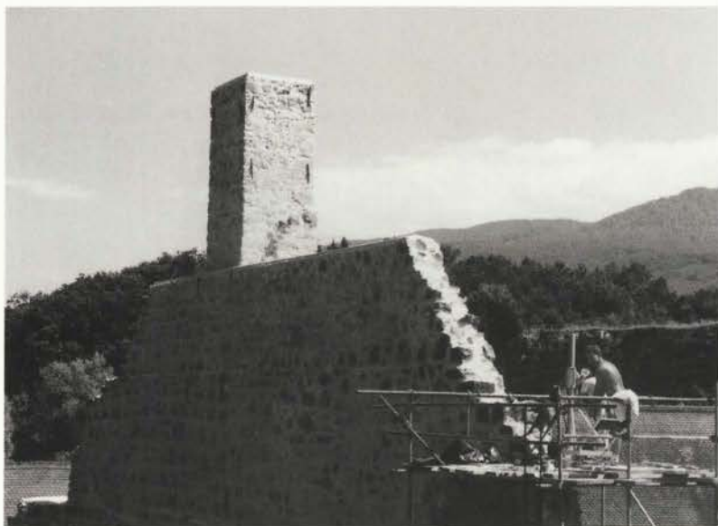
Sanacija severne stene. ...»V letu 1994 je potekala druga faza obnove ruševin...«
