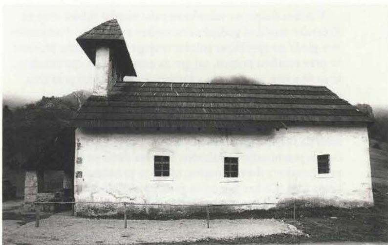
Cerkev sv. Egidija pred obnovo. ...»dotrajana lesena strešna kritina je bila vzrok za izredno slabo stanje podružnice in je resno ogrožala arhitekturo in cerkveno opremo...«
