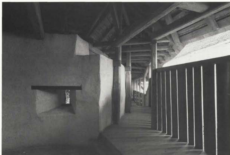
Pogled vzdolž lesenega obrambnega hodnika. ...»Izhodišče za sanacijo in rekonstrukcijo celotnega obzidja so bile dobro ohranjene strelne line v različnih nivojih...«
