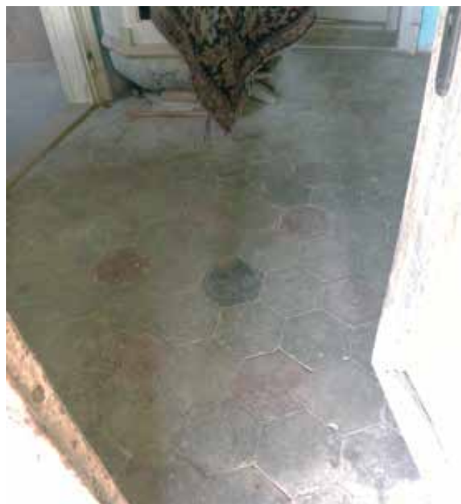
Kančevci, stara šola, v veži ohranjen prvotni betonski tlak v obliki satovja, marec 2016 (foto: S. Vešligaj)
