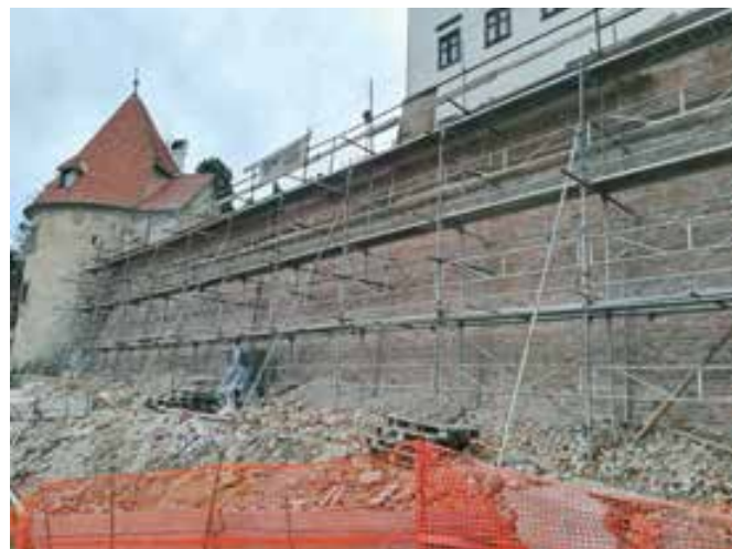
Ptuj, grajsko obzidje med pozidavo opečne fronte z že vzidanim kordonskim vencem (foto: S. Menoni Muršič)
