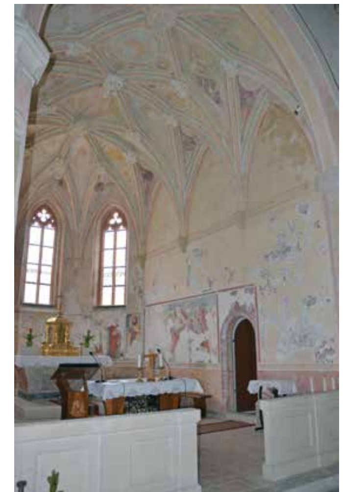
Tolmin, cerkev sv. Urha, pogled v notranjščino prezbitarija po zamenjavi zasteklitve (foto: M. Osojnik)
