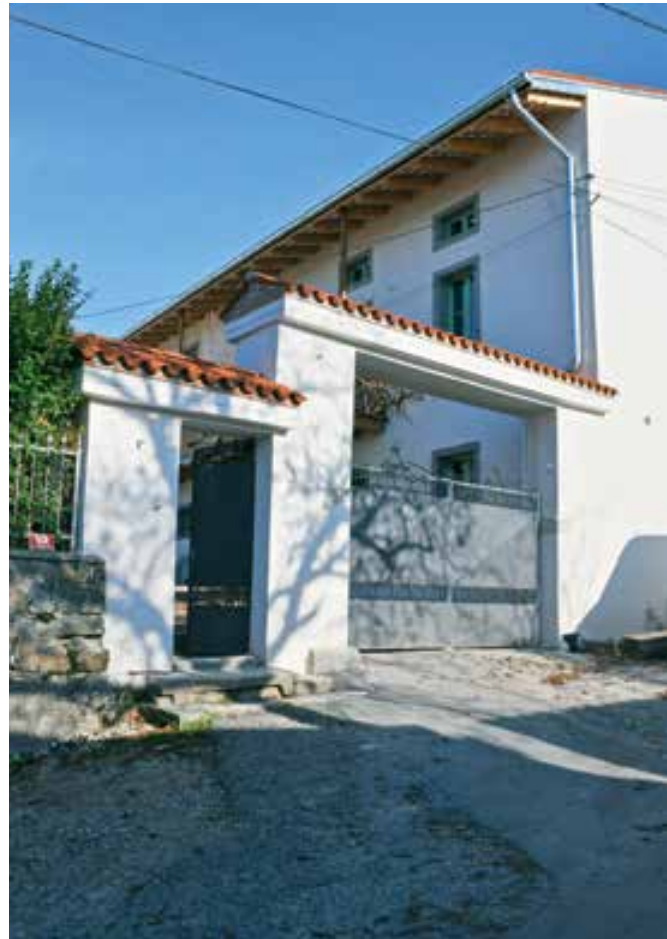
Vipolže, domačija Vipolže 53, porton, stanje po obnovi (foto: A. Ščukovt, 2019)
