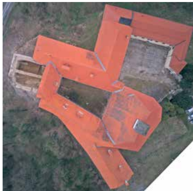
Dolane, grad Borl, zračni posnetek gradu in izkopnega polja (foto: G. Rutar)
