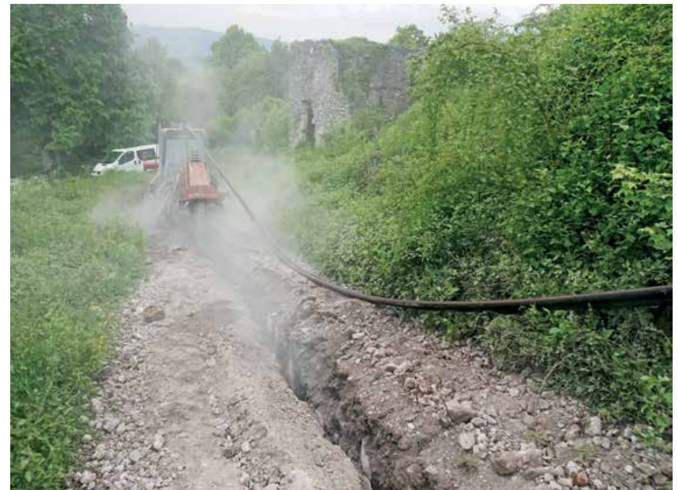
Križna gora, izkop jarka s kopalnim kolesom (frezo) na poti pri nekdanjem župnišču (foto: T. Fabec)
