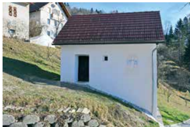
Jesenica, kašča pri Brecu po obnovi (foto: A. Ščukovt, 2019)
