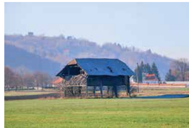
Zgornje Poljčane, kozolec Čreti, stanje pred obnovo (foto: M. Zupan, 2016)
