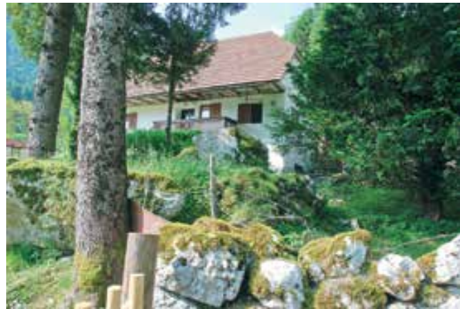
Hiša Soča 104 pred obnovo (foto: A. Ščukovt, 2017)
