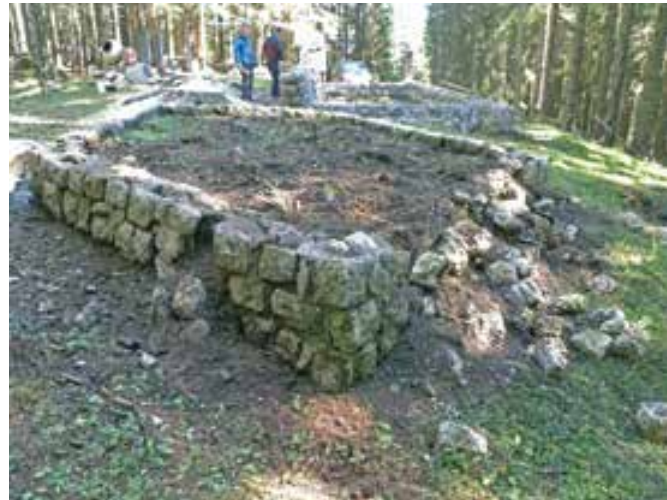
Goreljek, pogled na porušeni del grobišča borcev III. bataljona Prešernove brigade po odstranitvi vegetacije (foto: R. Pamić)
