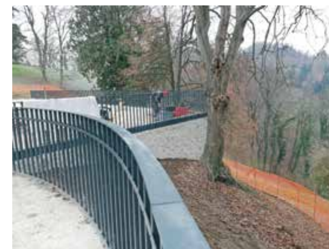
Velenje, grad, umestitev zaščitne kovane ograje na podpornem zidu, december 2019 (foto: ZVKDS, OE Celje)
