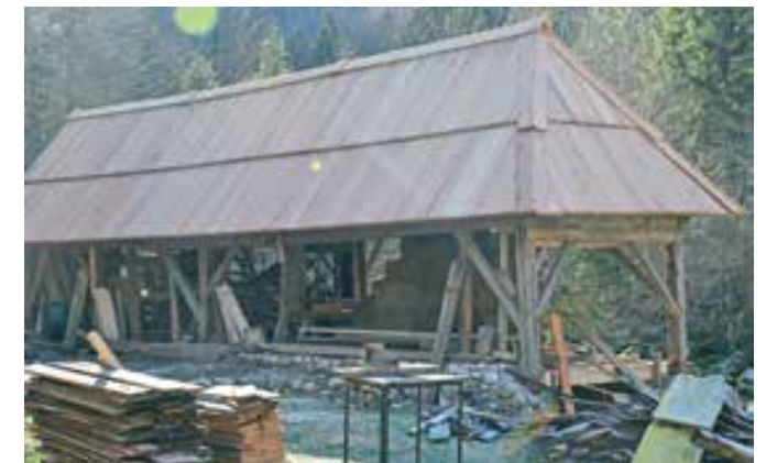
Domačija Soča 51, žaga med obnovo lesenih elementov (foto: A. Ščukovt, 2019)
