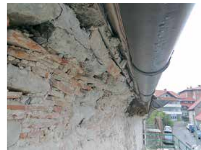
Postojna, zidani napušč novejšje in leseni starejše enote po odbitju ometov (foto: Tomaž Biščak, 2019)
