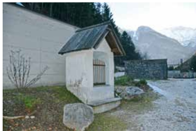
Trenta, pogled na znamenje pri pokopališču pred obnovo (foto: A. Ščukovt, 2019)
