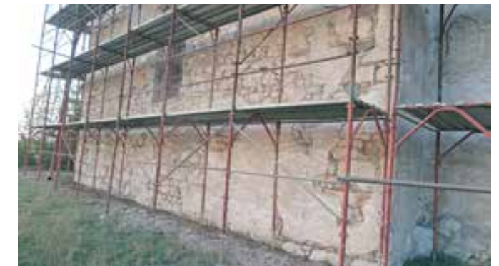
Vitovlje, cerkev sv. Petra, južna fasada ladje po odstranitvi dotrajanih ometov (foto: Klavdij Zalar)
