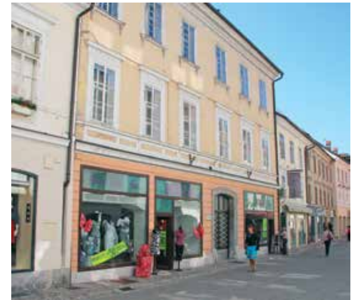
Kranj, fasada hiše Prešernova ulica 11 pred obnovo (foto: Bernarda Jesenko Filipič)
