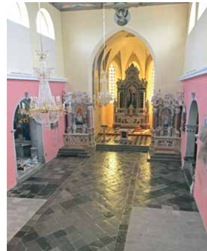
Ilirska Bistrica, cerkev sv. Petra, pogled s kora po končani obnovi tlaka (foto: M. Osojnik)
