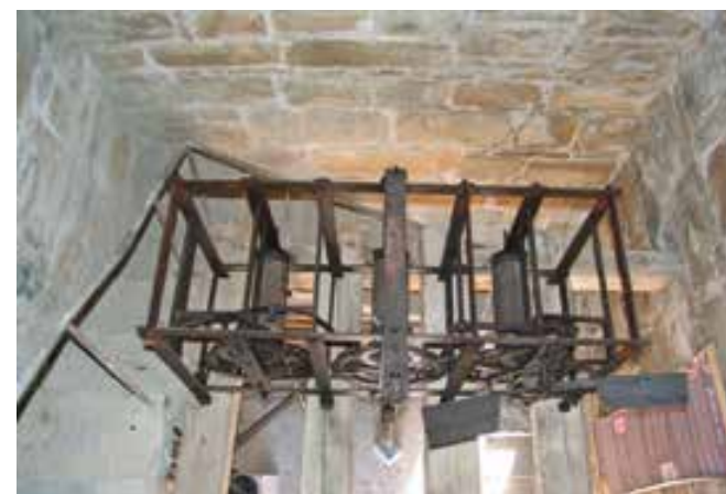
Marezige, cerkev sv. Križa, obnovljena in prezentirana stolpna ura (foto: N. Škrjanec, 2020)
