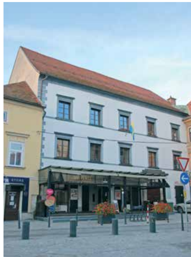
Celje, hiša Glavni trg 12, zunanjščina s prezentirano renesančno fazo pročelja (foto: U. Todosovska - Šmajdek, 2020)
