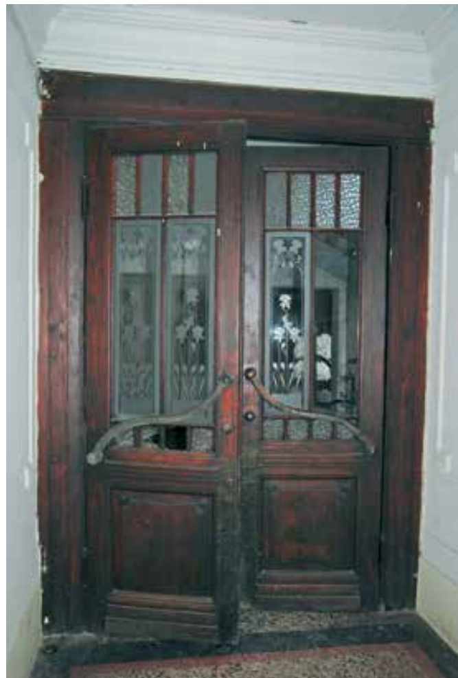
Ljubljana, hiša Cigaletova ulica 5, nihajna vrata, ki ločijo stopnišče od veže, pred obnovo (foto: M. Režek Kambič, 2017)
