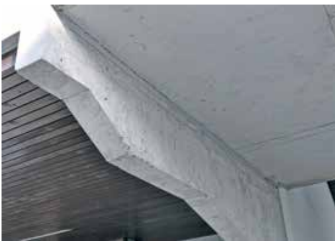
Ljubljana, vrtec Ajda, očiščena, sanirana in s karbonskimi lamelami ojačana konzola v vidnem betonu (foto: Tatjana Adamič)
