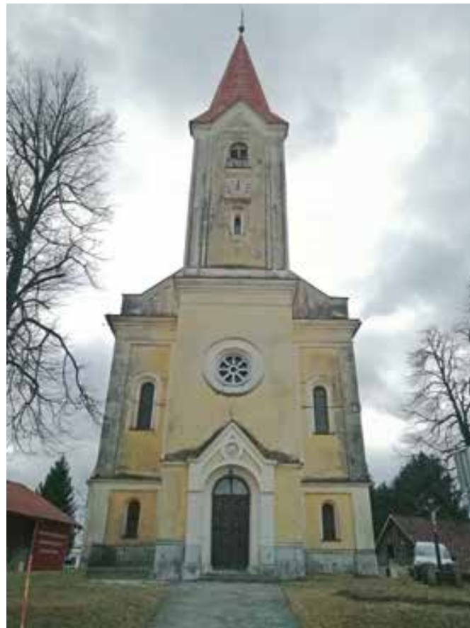
Stara Cerkev, cerkev Marijinega vnebovzetja pred obnovo (foto: S. Ravnikar)
