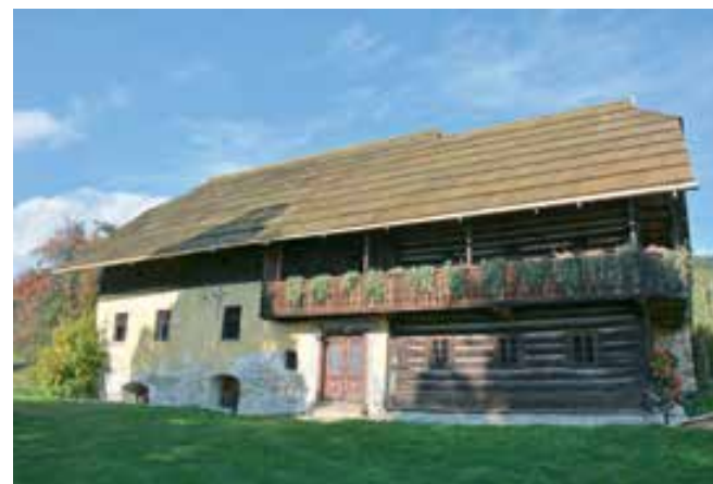
Hiša Zavodnje 69 po končani obnovi strehe (foto: B. Hostnik, 2019)
