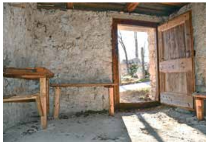
Bovec, mlekarna v Ravnem Lazu, restavrirana vhodna vrata, spuščalnica in klopi (foto: A. Ščukovt, 2019)
