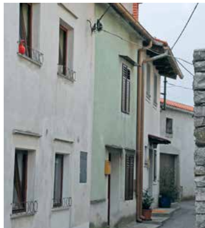
Vipavski Križ, hiša št. 34, stanje pred prenovo (foto: A. Ščukovt, 2016)
