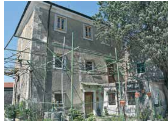
Nova škatlasta okna v drugem nadstropju hiše Škocjan 6 (foto: E. Belingar, 2020)
