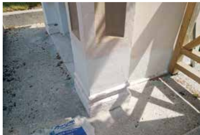
Planina, kapelica v Dolnji Planini, obnovljeni deli po nanosu ometov (foto: Primož Fučka, 2019)
