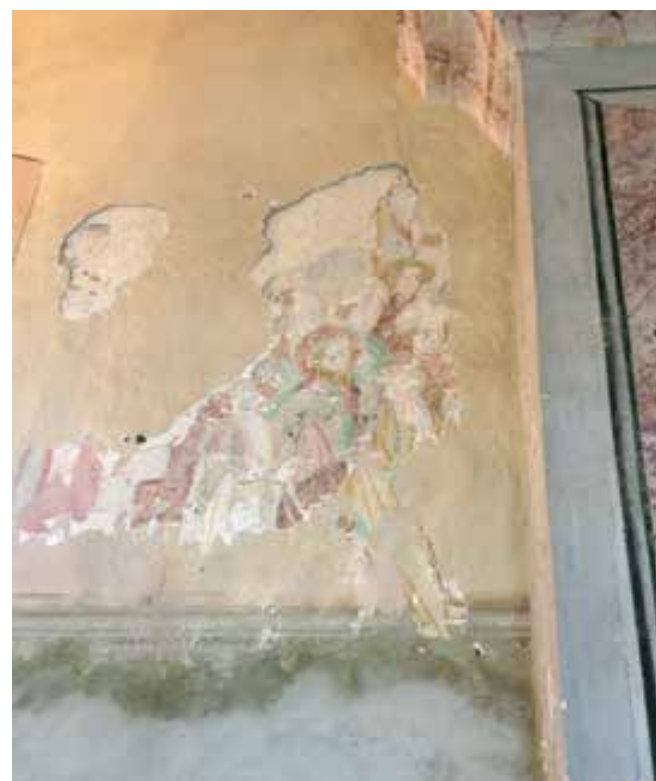
Topolšica, cerkev sv. Jakoba, odkriti fragment freske na severni strani notranjščine ladje med sondiranjem (foto: M. Plevnik)
