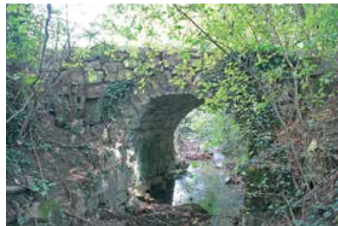
Slap pri Vipavi, most čez potok Dragonc (foto: A. Ščukovt, 2017)
