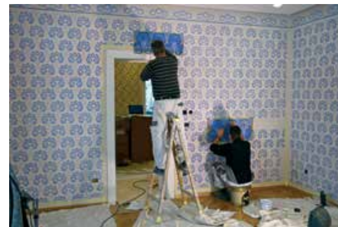
Bled, vila Savska cesta 2, izdelava šablonskih poslikav (foto: M. Remškar)
