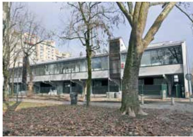
Ljubljana, vrtec Ajda, pročelje po obnovi, z zastekljenim hodnikom v nadstropju (foto: Tatjana Adamič)
