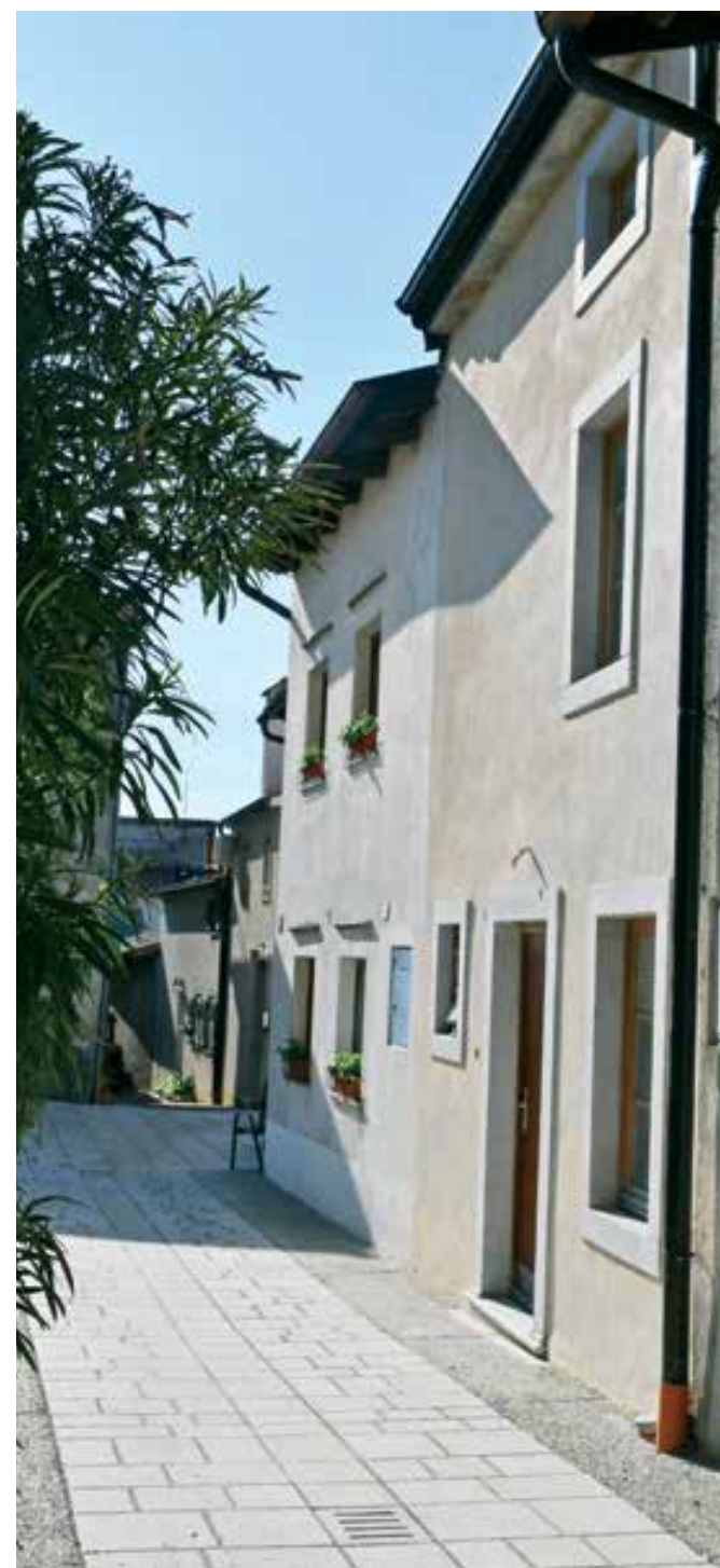
Vipavski Križ, hiša št. 34, stanje po prenovi (foto: A. Ščukovt, 2021)
