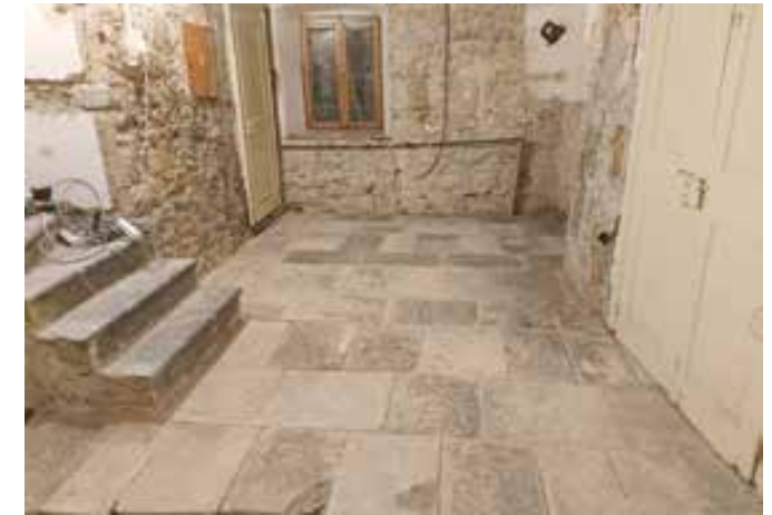
Domačija Velike Žablje 71, kamniti tlak in stopnišče v pritličju hiše, stanje med restavratorskimi posegi (foto: A. Ščukovt, 2020)
