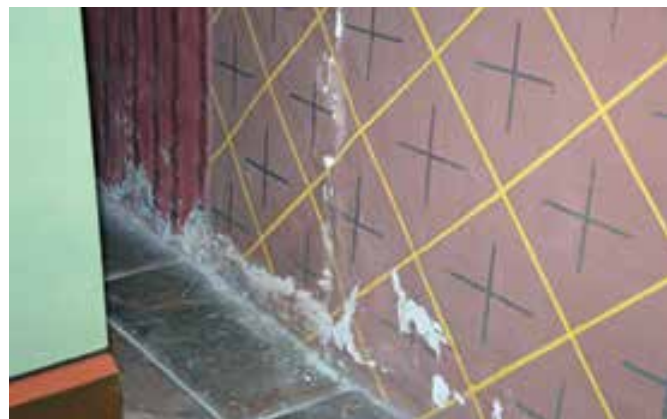
Trenta, cerkev Marije Device Lavretanske, poškodbe ometov v notranjščini, vzhodna stena (foto: Minka Osojnik)
