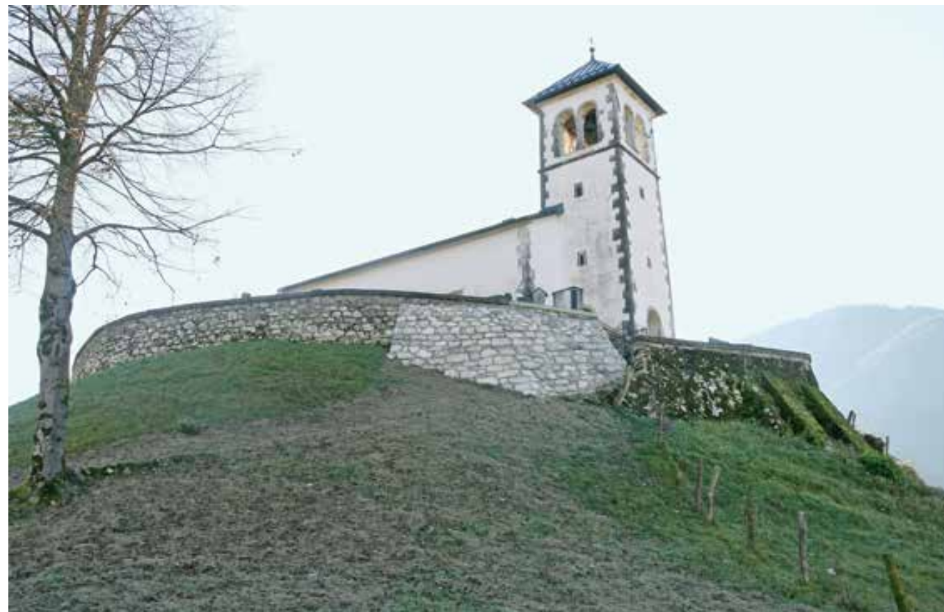
Libušnje, cerkev sv. Lovrenca, oporni zid po obnovi (foto: M. Osojnik)
