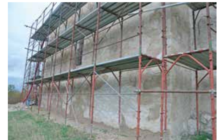
Vitovlje, cerkev sv. Petra, južna fasada ladje po izvedbi rekonstrukcije ometov (foto: M. Osojnik)
