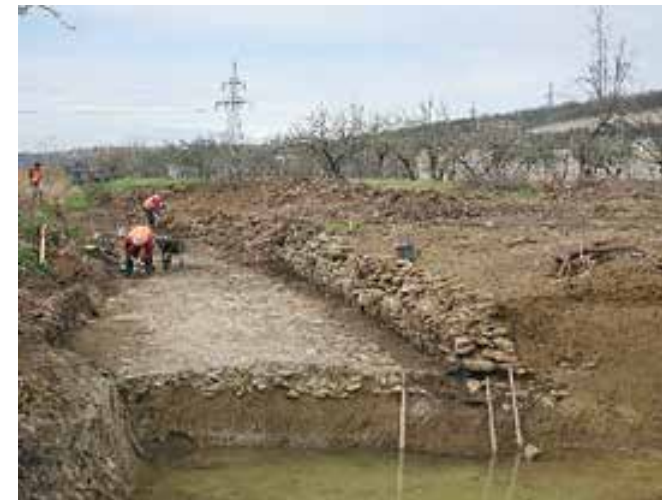
Dekani, IP 1, novoveško makadamsko cestišče, obdano s škarpama (foto: T. Fabec)
