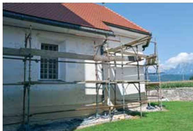
Srednja vas pri Šenčurju, cerkev sv. Katarine med krpanjem ometov (foto: M. Remškar)
