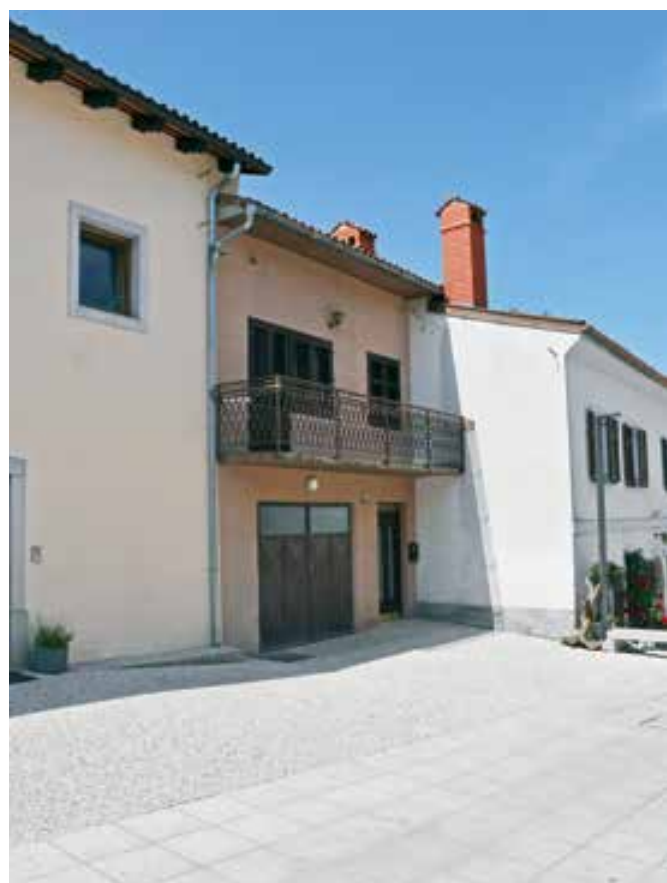
Vipavski Križ, hiša št. 15a, stanje pred prenovo (foto: A. Ščukovt, 2018)
