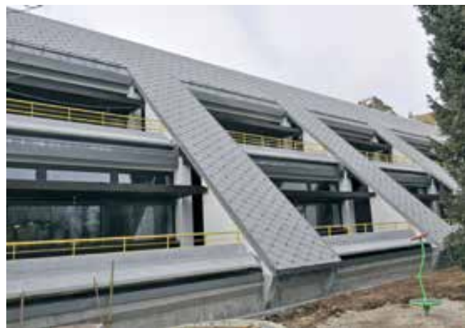
Ljubljana, vrtec Ajda, podoba začelja po namestitvi rekonstruiranih betonskih korit s kovinsko ograjo (foto: Tatjana Adamič)
