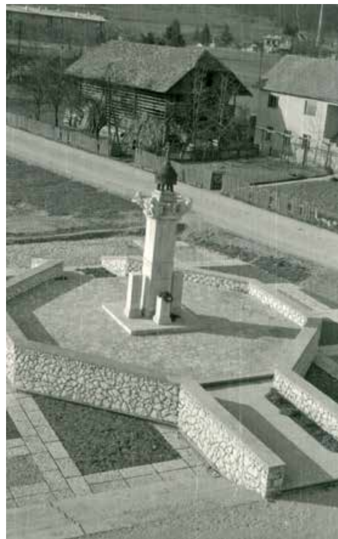
Sevnica, stanje spomenika borcev NOB z okolico pred obnovo (foto: N. Podkrižnik, 2016)
