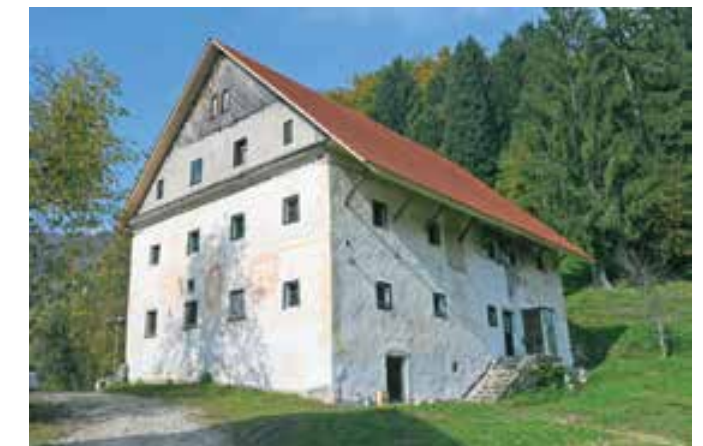
Gorenja Kanomlja, pogled na domačijo Šturmajce po opravljenih sanacijskih delih (foto: A. Ščukovt, 2019)
