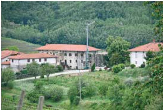
Drnovk 8 in 9, pogled na obnovljeno enovito streho kmečkega dvorca (foto: A. Ščukovt, 2020)
