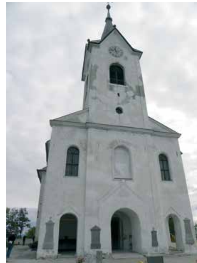
Prežganje, cerkev sv. Marjete pred obnovo (foto: Mojca Arh Kos)
