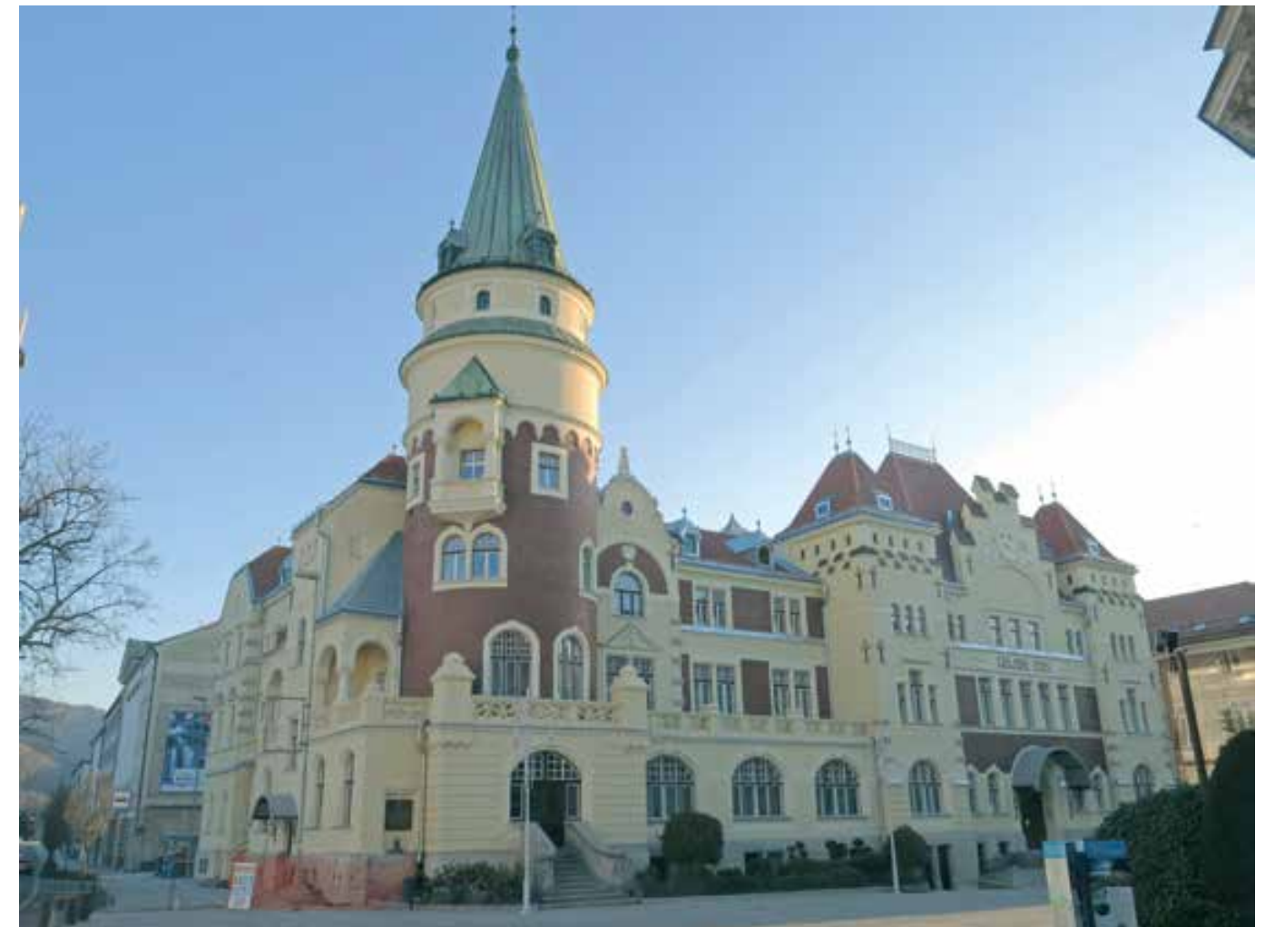
Celje, Celjski dom, pogled na glavno fasado s severovzhodne strani, stanje po obnovi zunanjsčine (foto: M. Plevnik)
