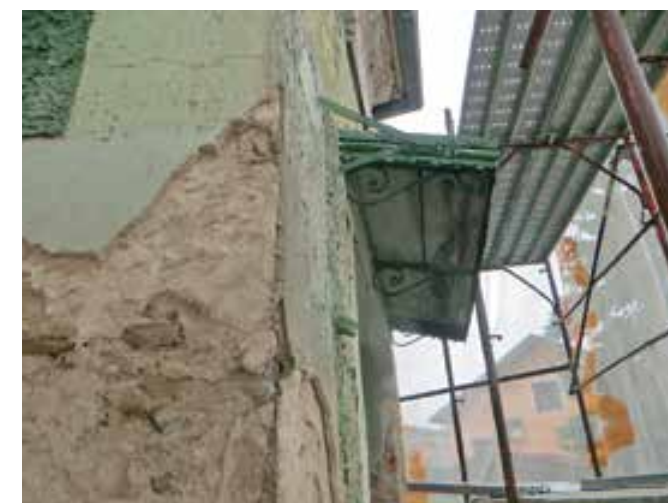
Postojna, severozahodni vogal hiše z opaznim prvotnim gladkim in kasnejšim ometom (foto: Tomaž Biščak, 2019)
