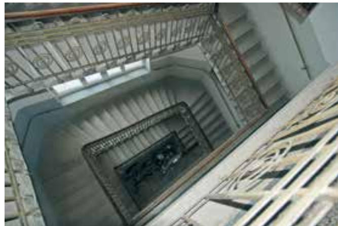
Ljubljana, stopnišče hiše Cigaletova ulica 5, pogled iz drugega nadstropja pred obnovo (foto: M. Režek Kambič, 2017)
