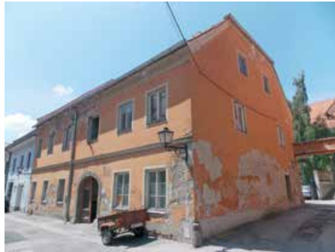
Ptuj, fasada hiše Jadranska ulica 12 pred obnovo (foto: S. Menoni Muršič)
