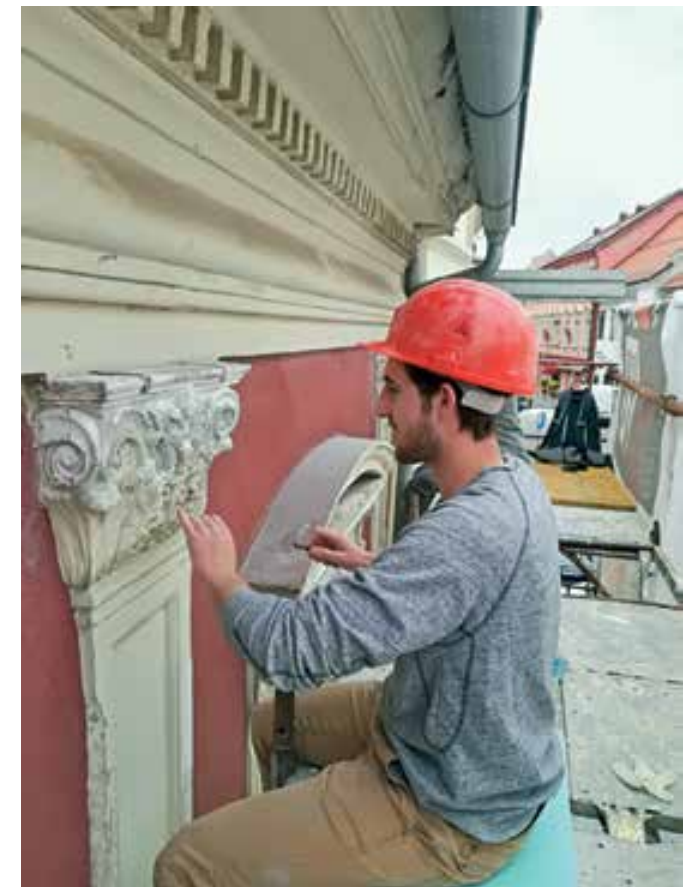
Ptuj, hiša Slovenski trg 1, restavratorsko čiščenje z akrilnim beležem zalite fasadne profilacije (foto: S. Menoni Muršič)
