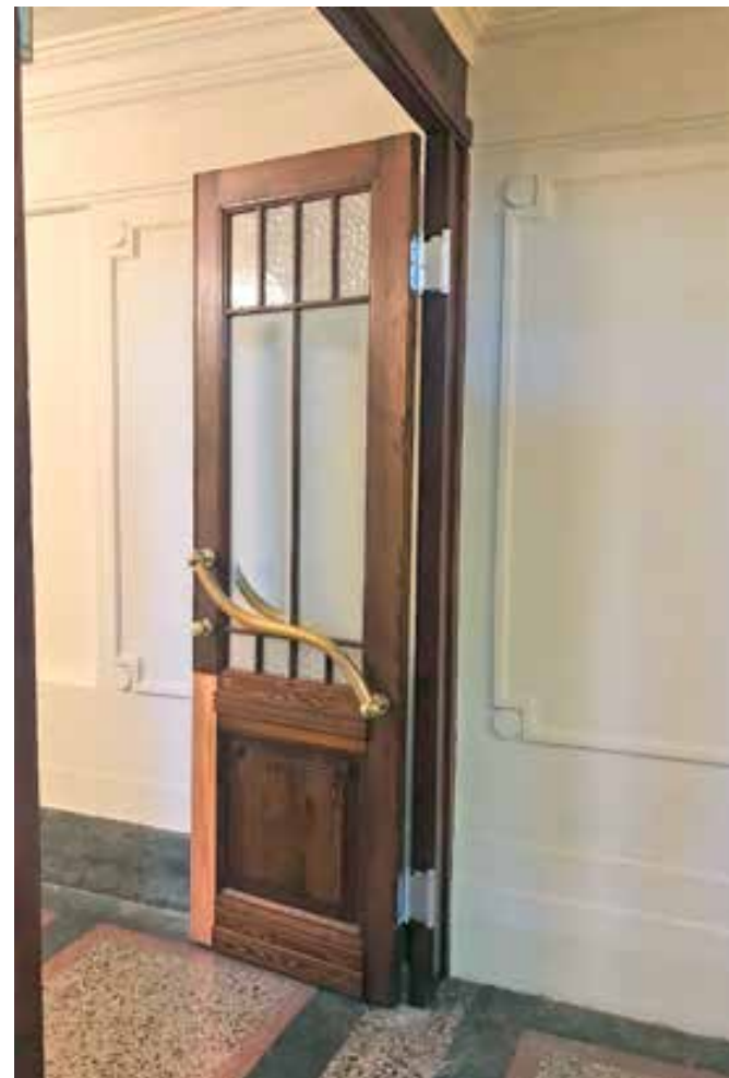
Ljubljana, hiša Cigaletova ulica 5, nihajna vrata, ki ločijo stopnišče od veže, po obnovi (foto: M. Režek Kambič, 2020)
