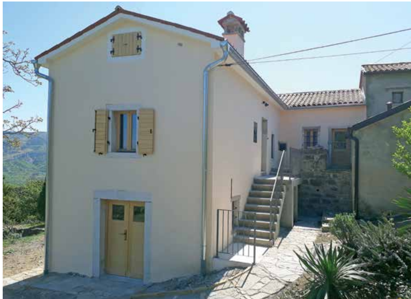
Kubed, obnovljena hiša Kubed 62a, jugozahodna stran (foto: E. Benčič Mohar)
