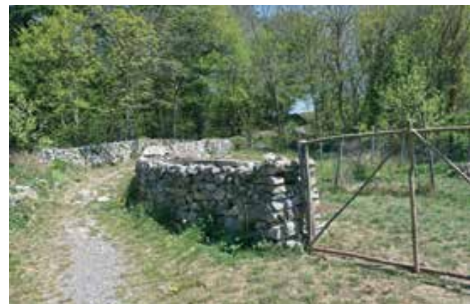
Na novo pozidan zid ob vrtu hiše Matavun 3c (foto: E. Belingar, 2020)
