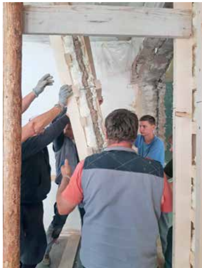
Trbovlje, strojna tovarna, snemanje sgraffita po kosih (foto: M. Lesar Kikelj, 2019)
