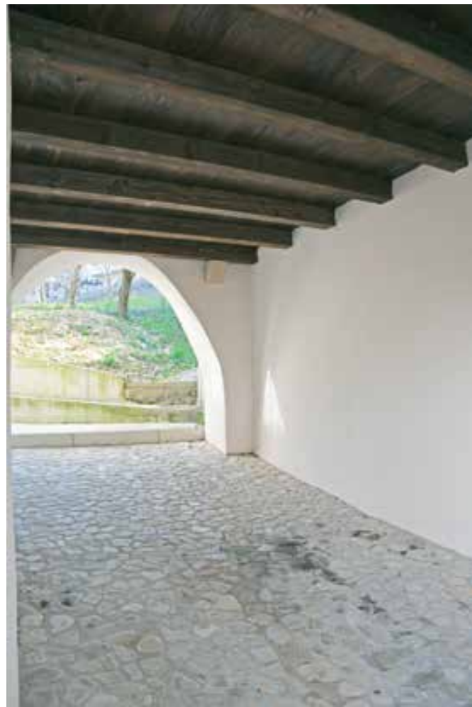
Črniče 92, obnovljen podhod (foto: A. Ščukovt, 2020)
