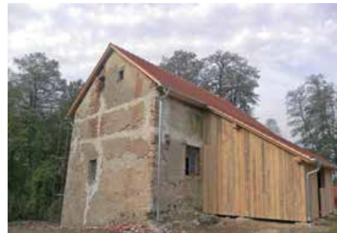
Formin, Kotni mlin na Sokovi domačiji po uspešno zaključeni statični sanaciji, oktober 2018 (foto: S. Vešligaj)
