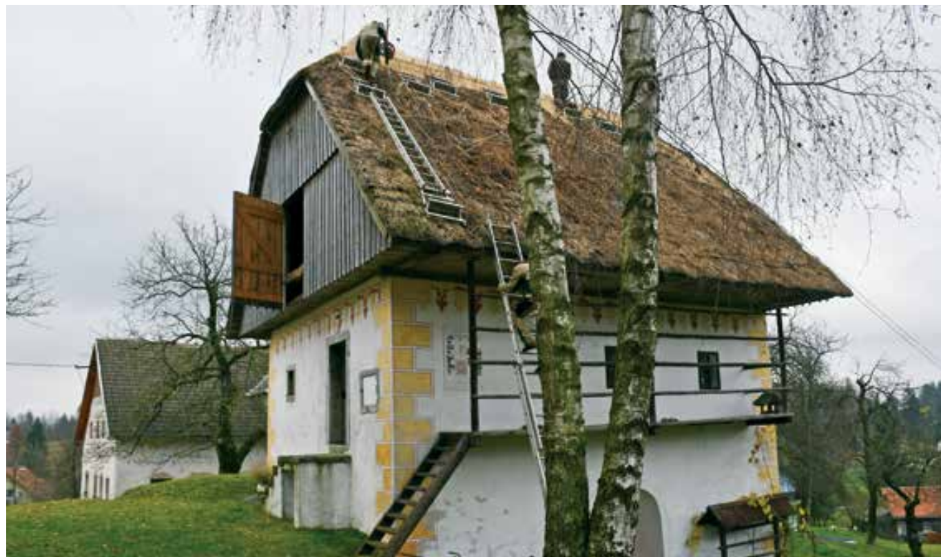
Zavrtec, slamokrovca pri sanaciji slamnate kritine Možinotove kašče (foto: A. Ščukovt, 2019)
