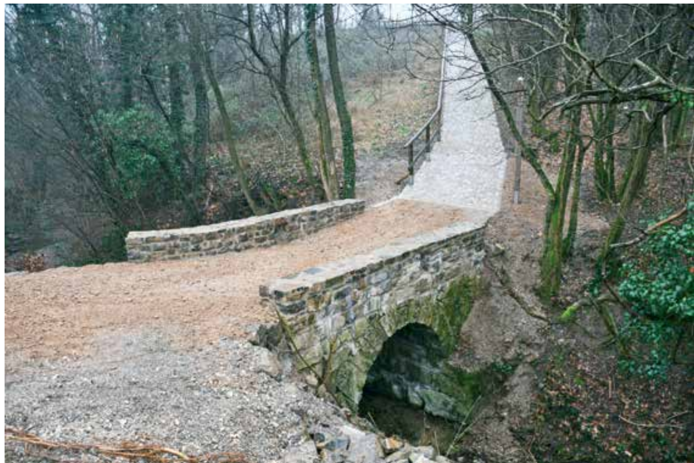
Slap pri Vipavi, obnovljeni most čez potok Dragonc (foto: A. Ščukovt, 2021)
