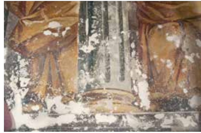
Zreče, cerkev Matere Božje na Brinjevi gori, detajl levega spodnjega dela figuralne poslikave med kitanjem (foto: J. Radšel, 2020)
