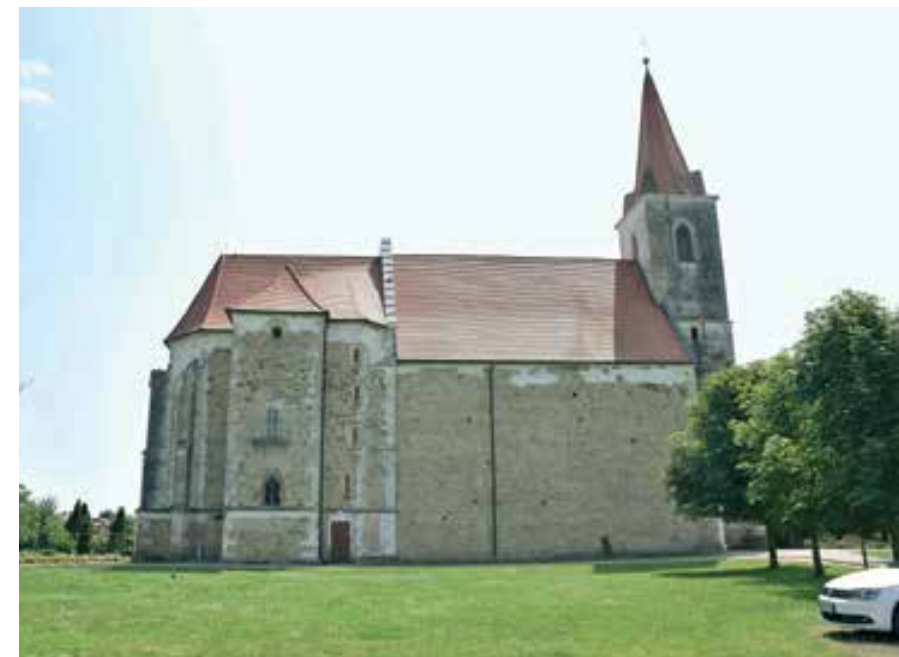
Tišina, cerkev Marijinega rojstva, severna fasada pred obnovo (foto: S. Simerl, 2018)
