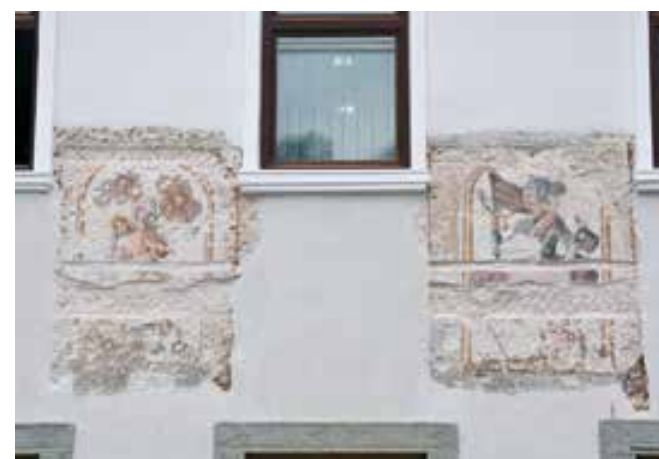
Radovljica, hiša Gorenjska cesta 1, očiščene in delno zakitane freske (foto: E. Tršar Andlovic)
