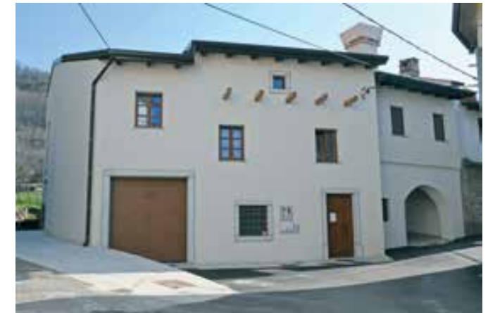
Črniče 92, stanje domačije po obnovi (foto: A. Ščukovt, 2020)
