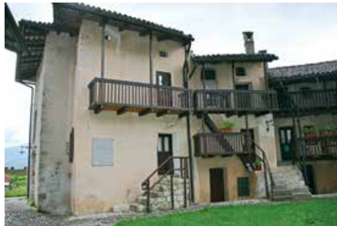
Obnovljeni ganki in dimnik stavbe Breginj 128 (foto: A. Ščukovt, 2020)
