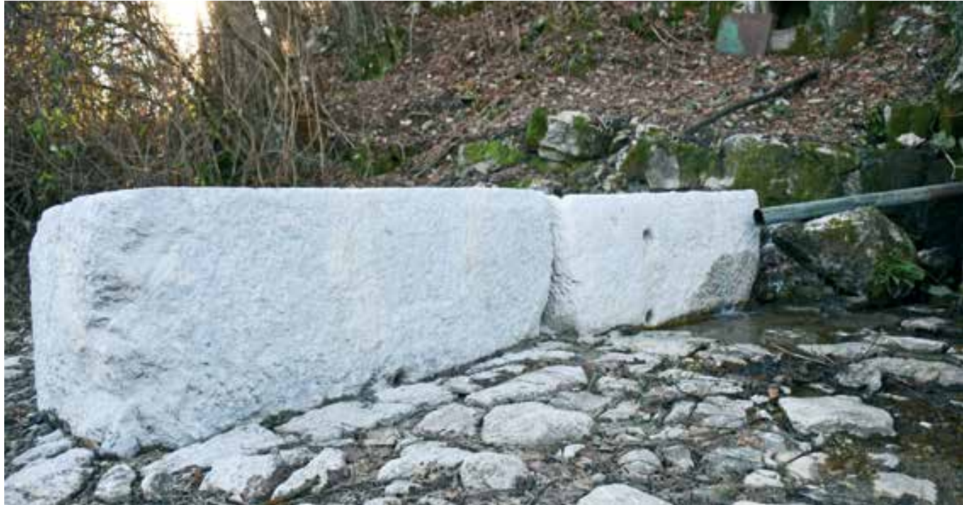
Avsa, studenec Podčelami, stanje po opravljenih vzdrževalnih delih in restavratorskih posegih na obeh kamnitih koritih (foto: A. Ščukovt, 2019)
