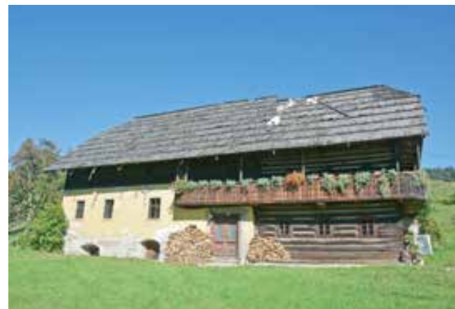
Hiša Zavodnje 69, streha s skodlami pred obnovo (foto: B. Hostnik, 2018)
