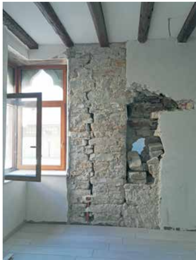
Koper, Ribiški trg 10, 11, med sondiranjem odkrita okenska odprtina z gotsko poslikavo (foto: N. Škrjanec, 2019)
