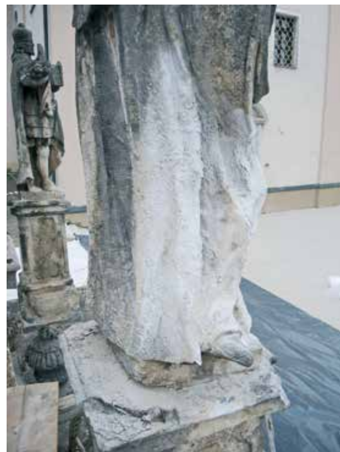
Radlje ob Dravi, Marijino znamenje, zaščita odstopajočih delov z začasnim utrjevalcem, november 2020 (foto: Š. Govže)
