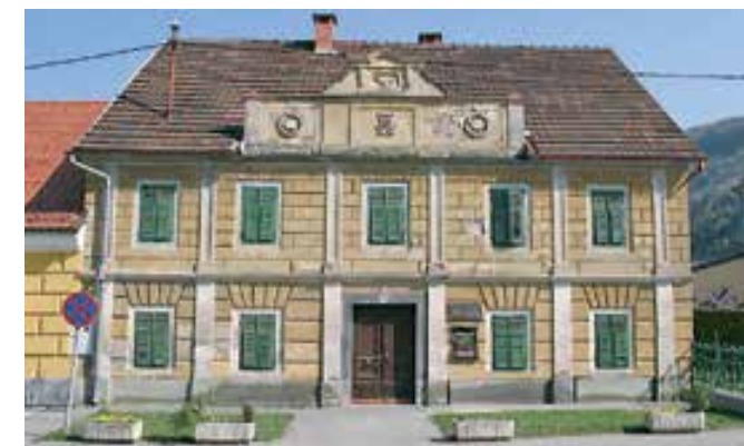
Vransko, hiša Vransko 25 pred posegi (foto: N. Podkrižnik, 2017)
