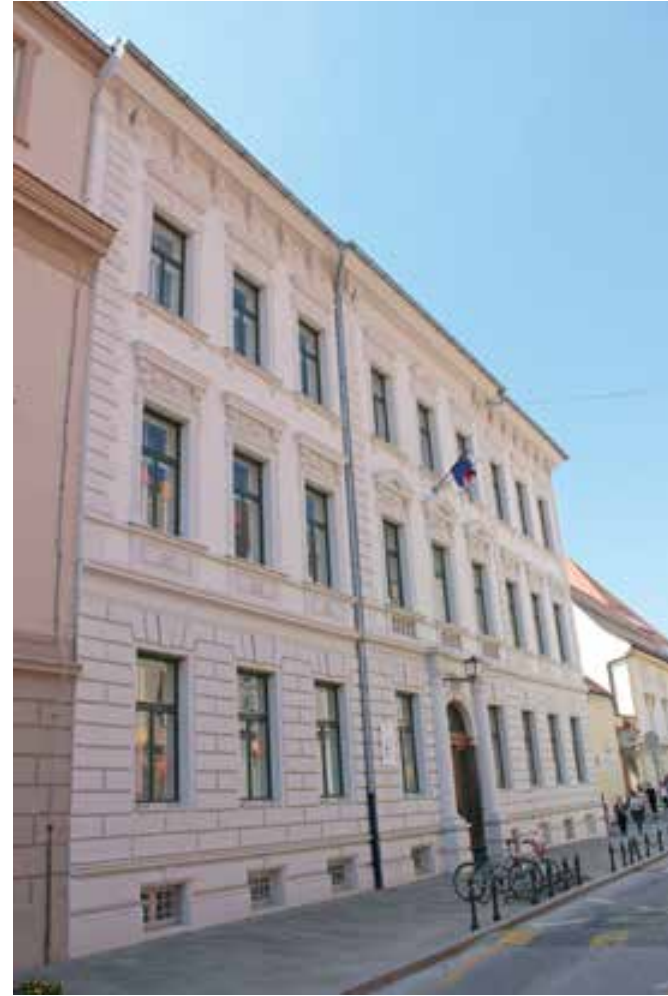
Ptuj, Osnovna šola Olge Meglič, čelna fasada objekta po obnovi (foto: Vlasta Čobal Sedmak)
