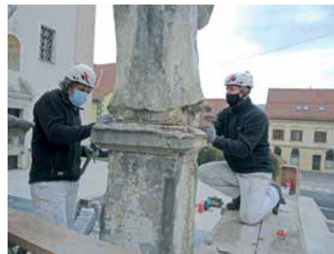
Radlje ob Dravi, Marijino znamenje, odpiranje stikov med kipom in podstavkom, november 2020 (foto: Š. Govže)
