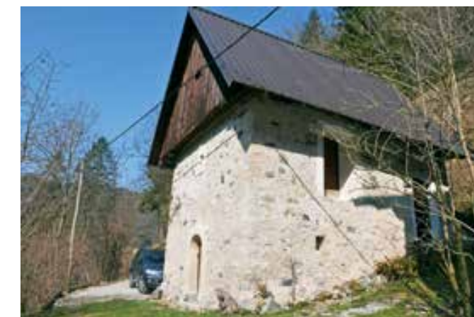
Ravne pri Cerknem, kašča, stanje po restavratorskih posegih (foto: A. Ščukovt, 2021)
