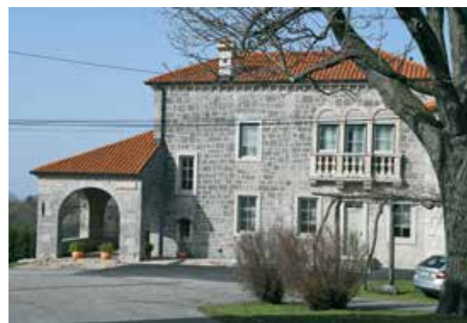
Temnica, županstvo, stanje po obnovi stavbe (foto: A. Ščukovt, 2021)
