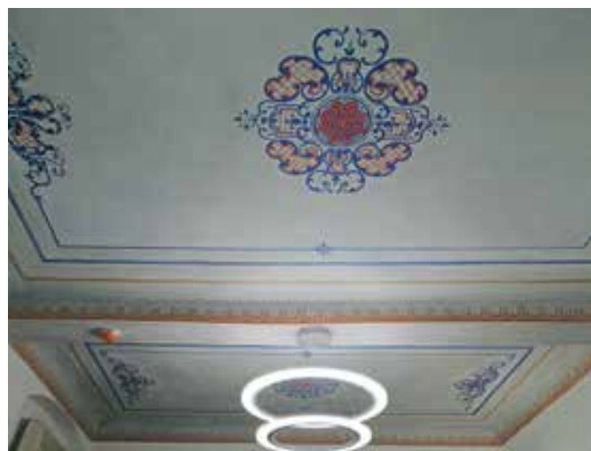
Celje, hiša Glavni trg 12, stropna poslikava v prvem nadstropju po opravljenih konservatorsko-restavratorskih delih (foto: U. Todosovska – Šmajdek, 2020)
