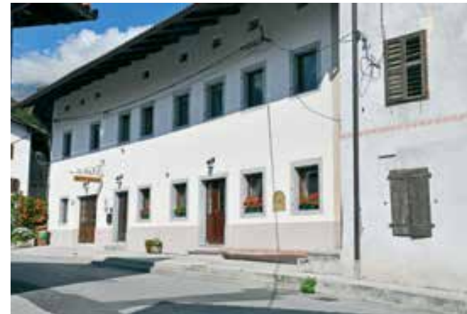
Kobarid, Gregorčičeva 23, stanje po obnovi (foto: A. Ščukovt, 2019)
