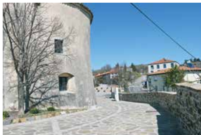
Šmartno v Brdih, pogled na obnovljen podporni zid na Podratah (foto: A. Ščukovt, 2020)
