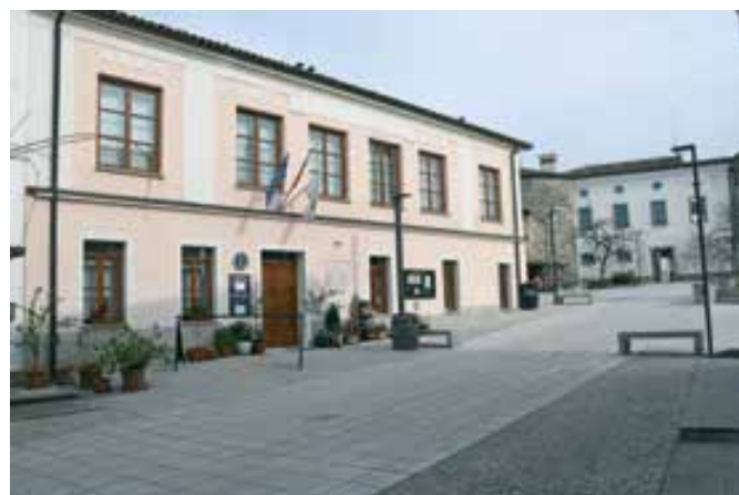
Vipavski Križ 8, pogled na objekt z vgrajenim novim stavbnim pohištvom (foto: Andrejka Ščukovt, 2020)
