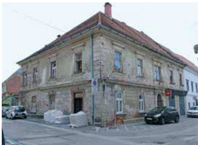
Ptuj, hiša Jadranska ulica 15 pred obnovo fasade (foto: S. Menoni Muršič)
