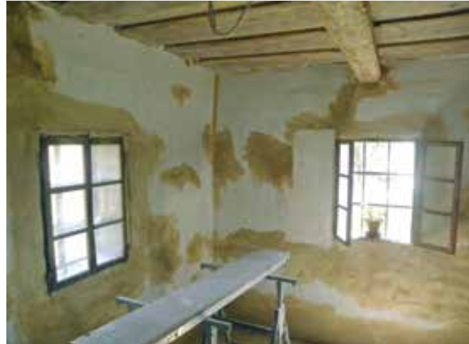
Dražen Vrh, domačija Kapl, kamra med obnovo, julij 2018 (foto: S. Vešligaj)
