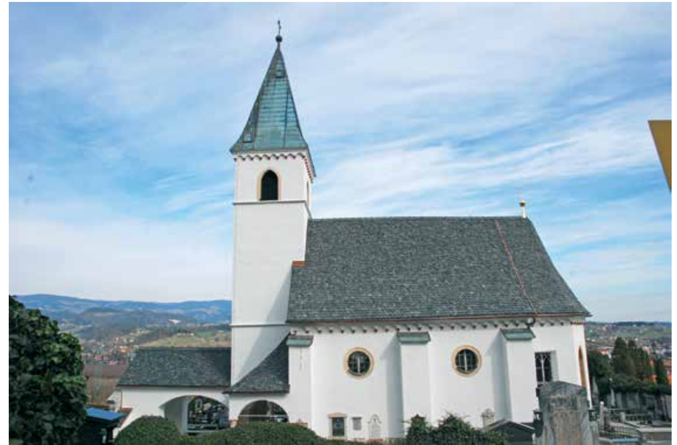
Slovenske Konjice, cerkev sv. Ane, pogled na južno fasado po obnovi (foto: U. Todosovska – Šmajdek, 2019)
