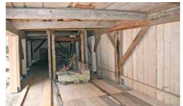
Domačija Soča 51, notranjost žage po obnovi (foto: A. Ščukovt, 2019)
