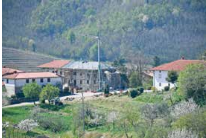
Drnovk 9, obnova strehe (foto: A. Ščukovt, 2020)
