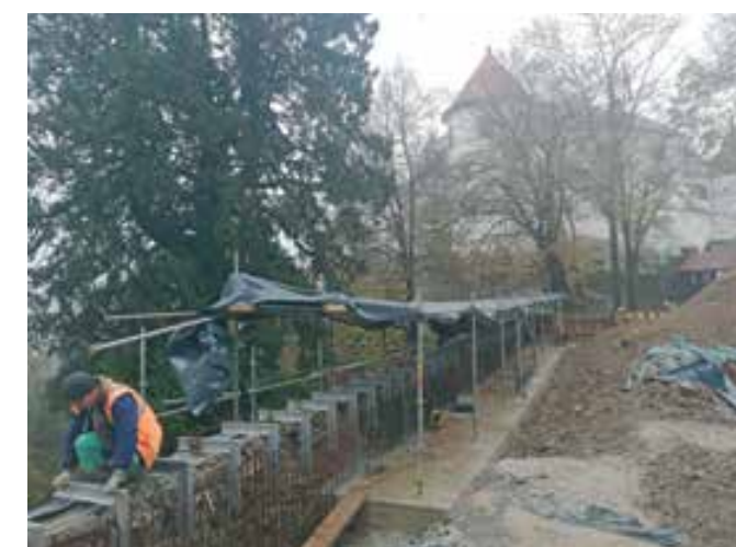
Velenje, grad, gradnja novega podpornega zidu na zahodni in severni strani parterja, november 2019 (foto: ZVKDS, OE Celje)
