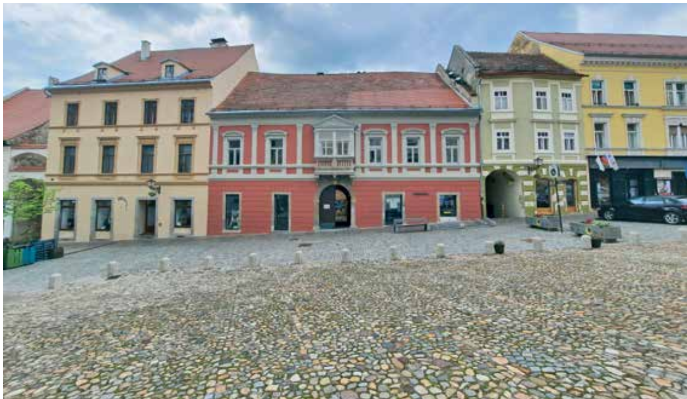
Ptuj, hiša Slovenski trg 1 po obnovi fasade (foto: S. Menoni Muršič)
