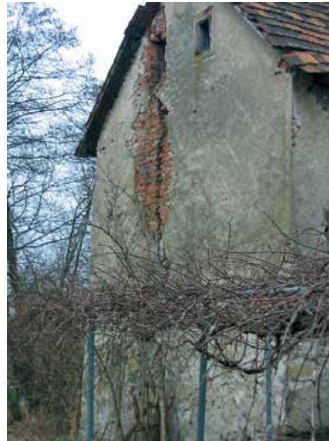
Formin, Kotni mlin na Sokovi domačiji s 15-centimetrsko razpoko v jugovzhodni fasadi, januar 2011 (foto: S. Vešligaj)
