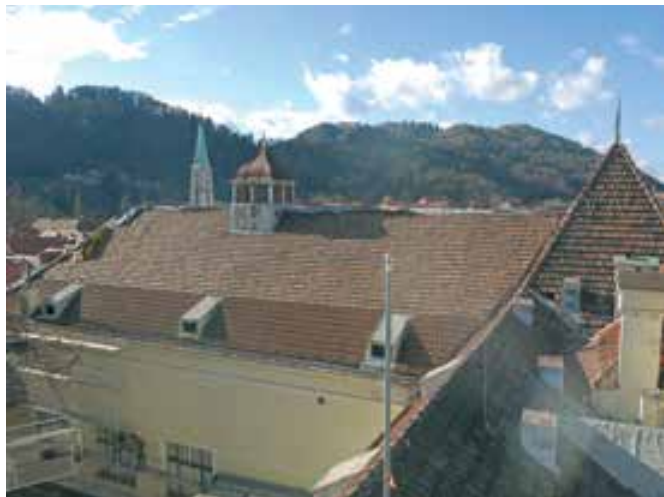
Celje, Celjski dom, pogled na strehe proti zahodnemu stranskemu krilu, pred posegi (foto: M. Plevnik)
