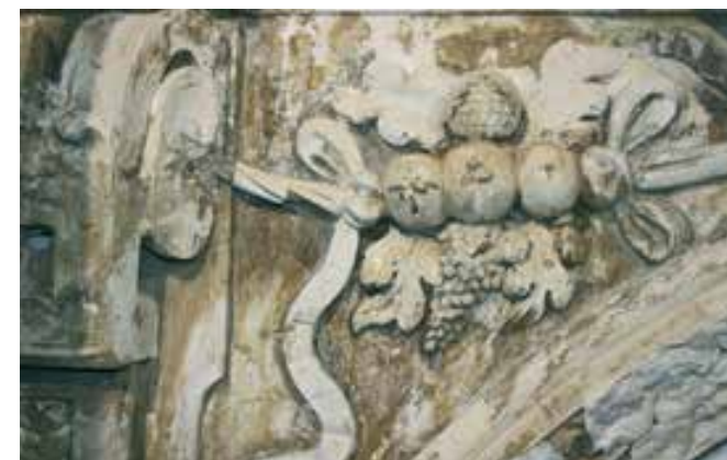
Nova Gorica, cerkev Gospodovega oznanjenja Mariji na Kostanjevici, girlanda iz sadja med čiščenjem z geli (foto: M. Bensa, september 2019)
