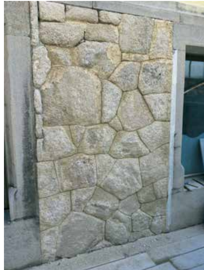
Celje, Celjski dom, sanacija kamnitega talnega zidca (foto: M. Plevnik)
