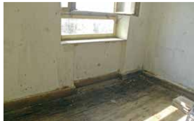
Kančevci, stara šola, dotrajane lesene podnice v bodočem razstavnem prostoru, marec 2016 (foto: S. Vešligaj)
