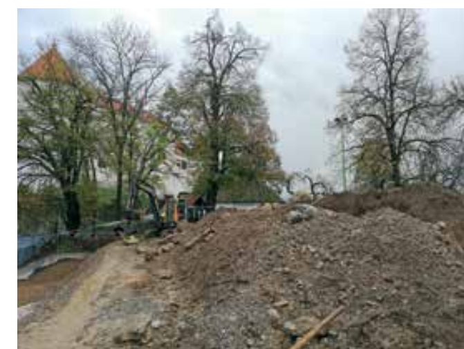
Velenje, grad, začetek zemeljskih del, november 2019 (foto: ZVKDS, OE Celje)
