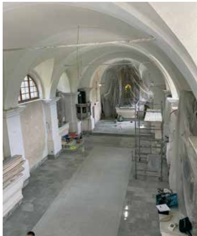
Jereka, cerkev sv. Marjete, notranjost cerkve med obnovo (foto M. Remškar)
