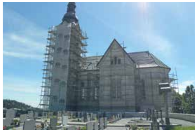
Črni Vrh, cerkev sv. Lenarta pred obnovo (foto: S. Ravnikar)
