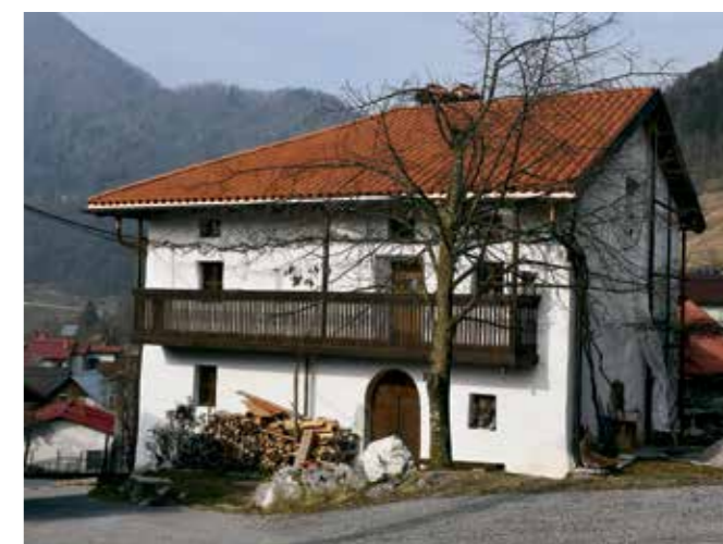
Žabče, domačija Žabče 13, stanje po zamenjavi strešnikov (foto: A. Ščukovt, 2019)
