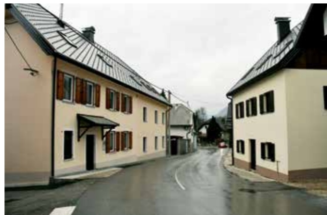
Bovec, Kot 60 in Kot 64, stanje po popotresni obnovi (foto: A. Ščukovt, 2019)
