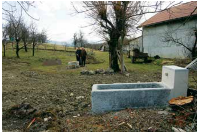
Orehok pri Postojni, pozidan oklep štirne Pri Luži ter na svoje mesto nameščeno kamnito korito ob na novo pozidanem slopu s pipo (foto: Eda Belingar, 2019)
