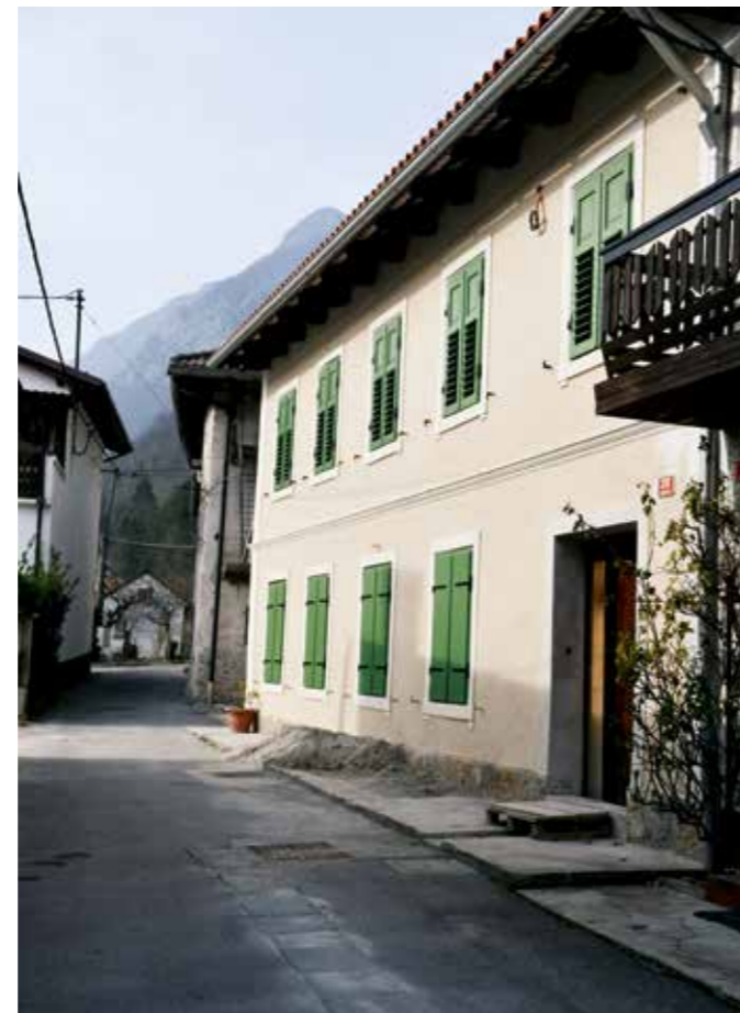
Kobarid, Krilanova ulica 20, stanje po popotresni sanaciji (foto: A. Ščukovt, 2019)
