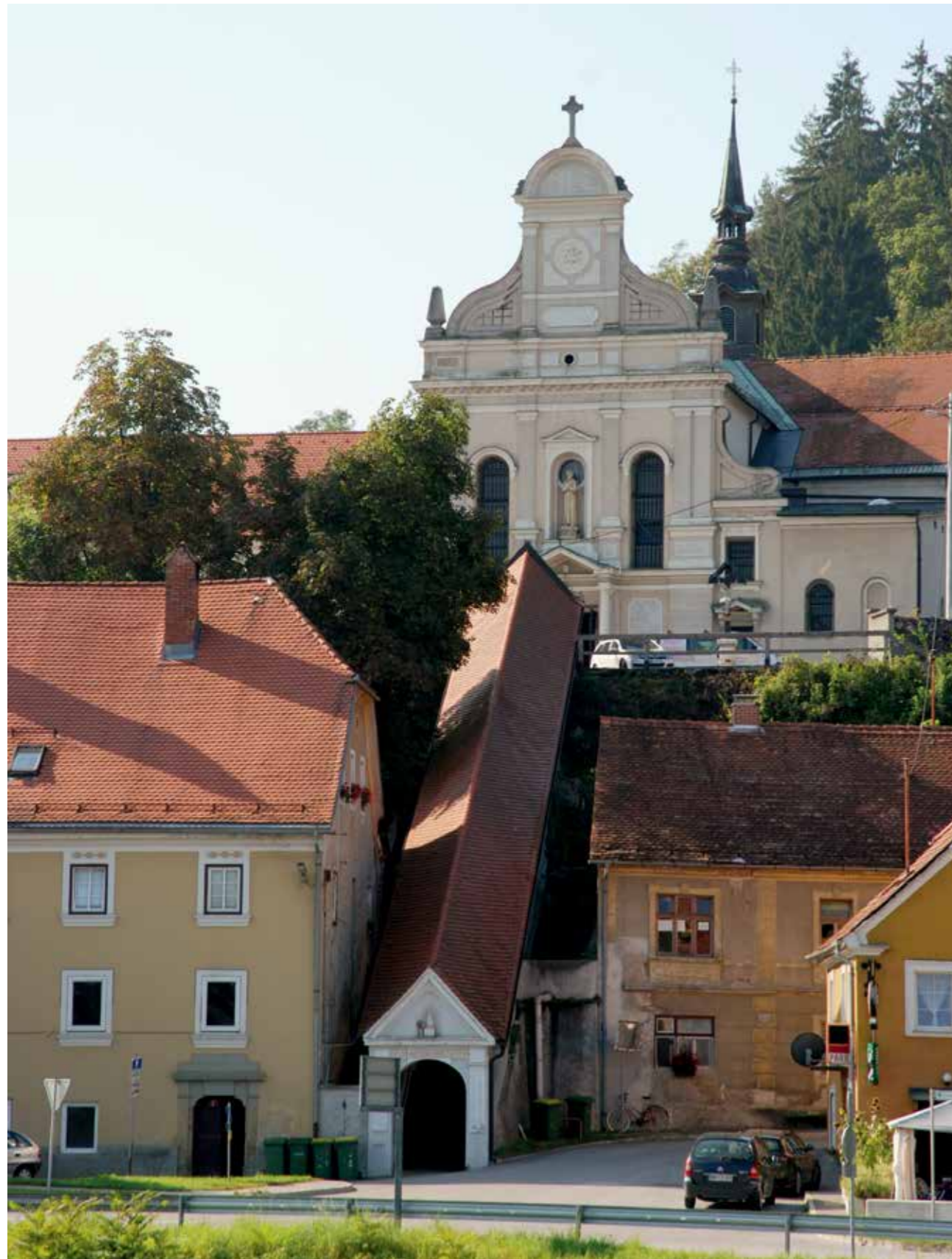
Celje, pogled na stopnice in pročelje cerkve kapucinskega samostana (foto: U. Todosovska – Šmajdek, 2016, arhiv ZVKDS, OE Celje)
