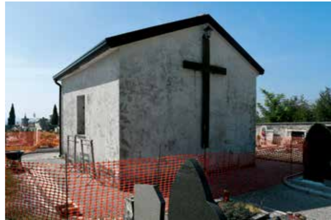
Šmartno, mrliška vežica na pokopališču pred obnovo (foto: A. Ščukovt, 2018)
