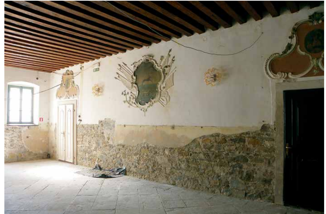
Izola, palača Besenghi degli Ughi, reprezentančna vhodna avla po odstranitvi lesenih elementov (foto: N. Škrjanec, 2018)
