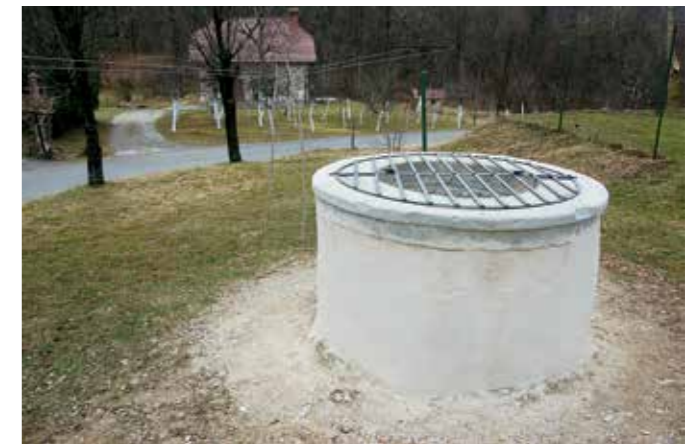
Orehek pri Postojni, na novo pozidana šapa iste štirne, zaščitena s kovano mrežo (foto: Eda Belingar, 2019)
