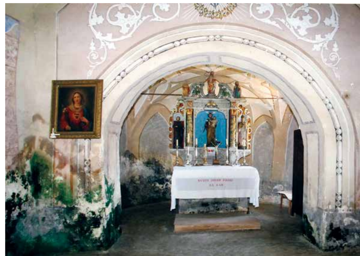
Podklanec, cerkev sv. Jožefa, pogled na prezbitterij pred posegom, 2011 (foto: M. Ocepek)
