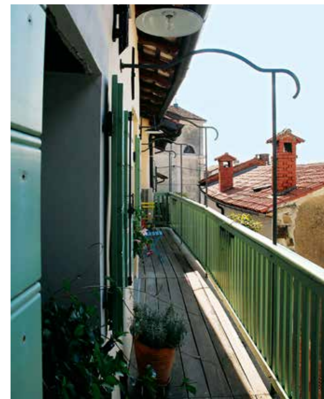
Šmartno 33, strešni napušč, stanje pred izvedbo t. i. linde (foto: A. Ščukovt, 2017)
