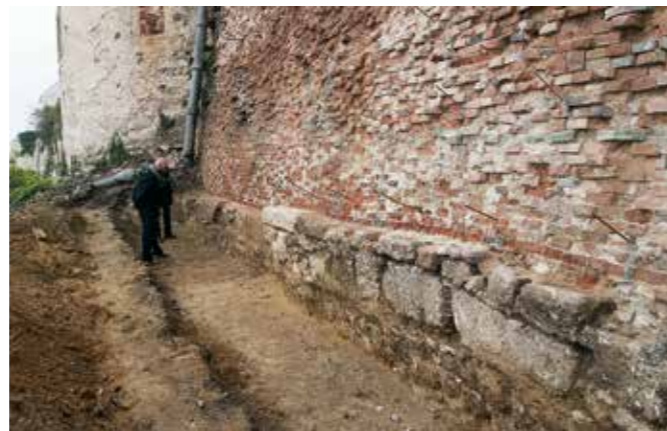
Ptuj, grad, zid J-1 med sanacijo. V temelj zidu so vzdane tudi antične marmorne spolje (foto: R. Lebar)
