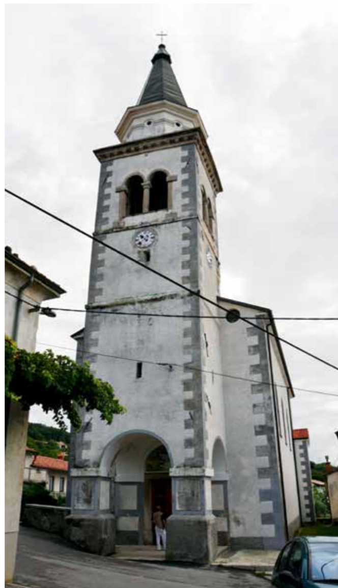
Kamnje, cerkev sv. Mihaela, pogled na zvonik pred obnovo (foto: M. Osojnik)
