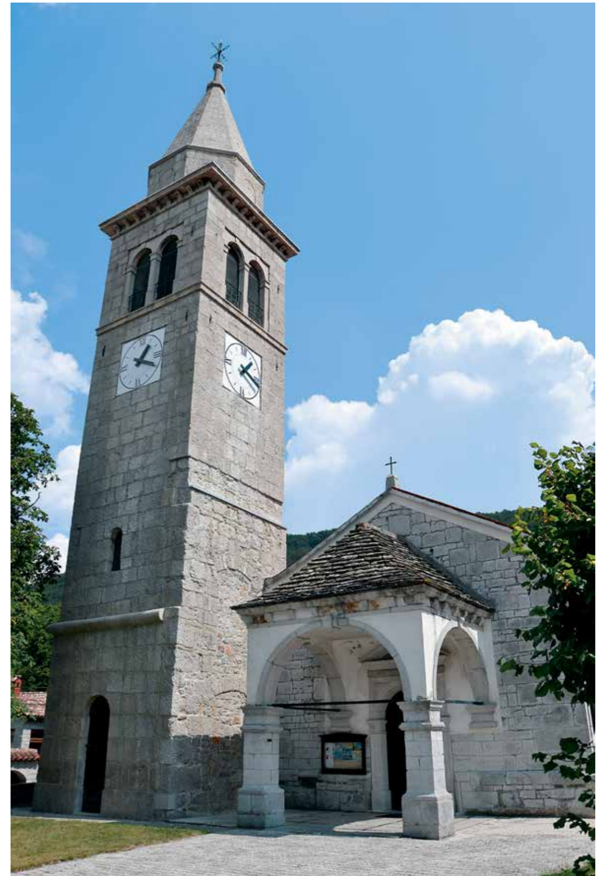
Rodik, cerkev Sv. trojice, pogled na zahodno pročelje cerkve po obnovi zvonika (foto: M. Osojnik)
