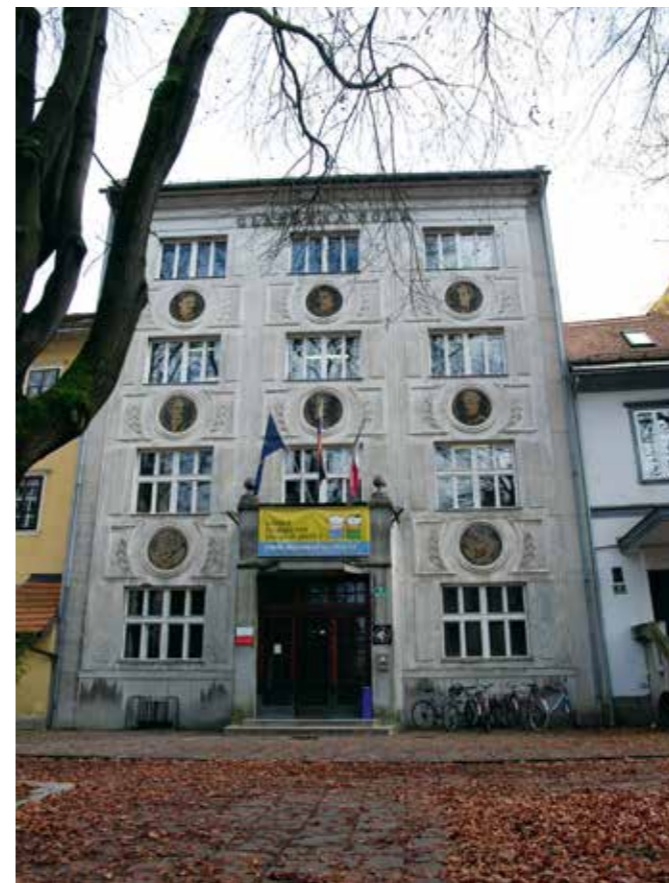
Ljubljana, Vegova ulica 5, ulična fasada pred prenovo (foto: M. Režek Kambič, 2016)
