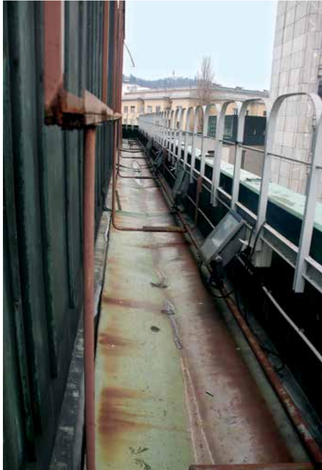
Ljubljana, Cankarjev dom, dotrajana žlota iz bakrene pločevine na vzhodnem delu strehe (foto: T. Adamič)
