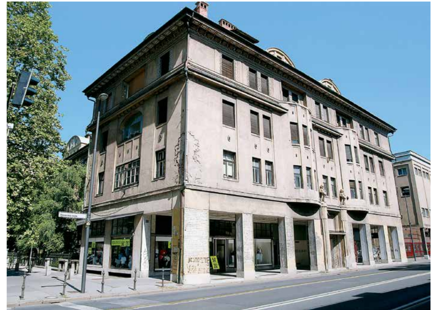
Ljubljana, pogled na Nemško hišo s Slovenske ceste pred obnovo (foto: M. Režek Kambič, 2013)
