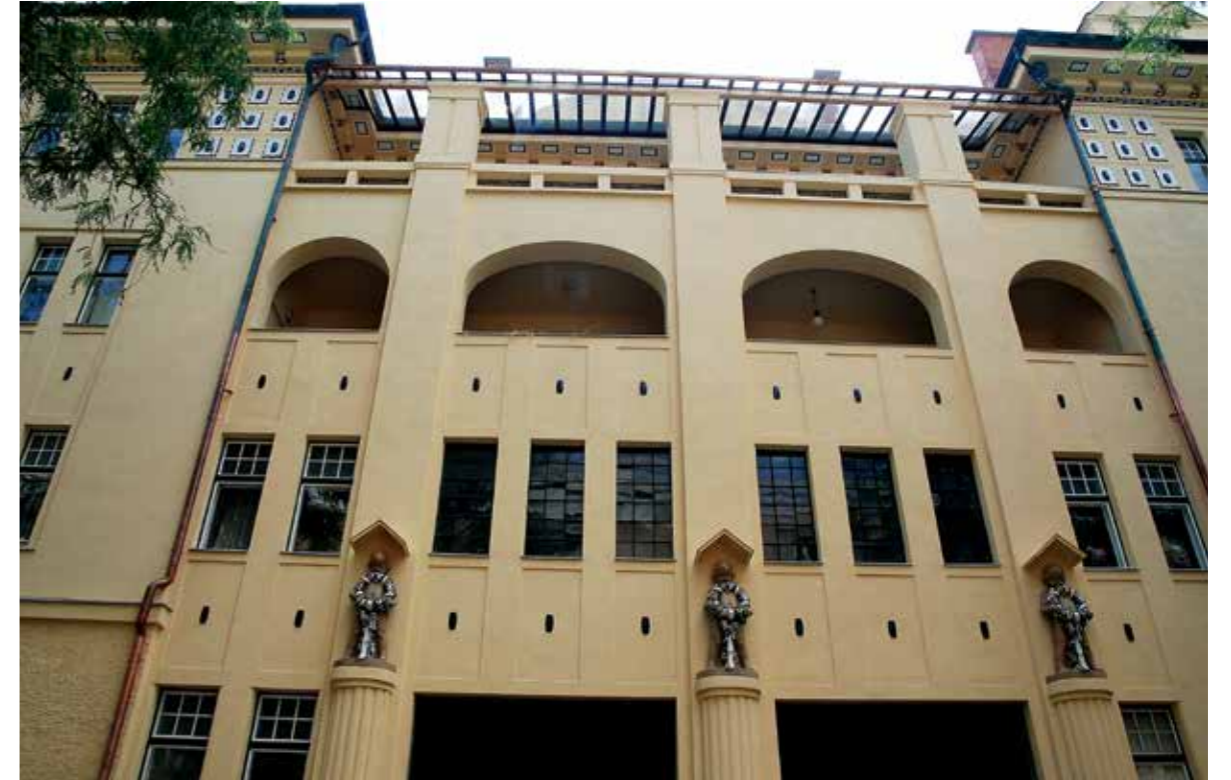
Ljubljana, Nemška hiša, severna fasada s posodobljeno stekleno streho in zaščitnimi strešicami nad kiparskim okrasom po obnovi (foto: M. Režek Kambič, 2018)
