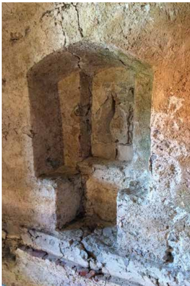
Planina, zvonik cerkve sv. Marjete, zidane obokenske klopi v tretjem nadstropju (foto: M. Osojnik)
