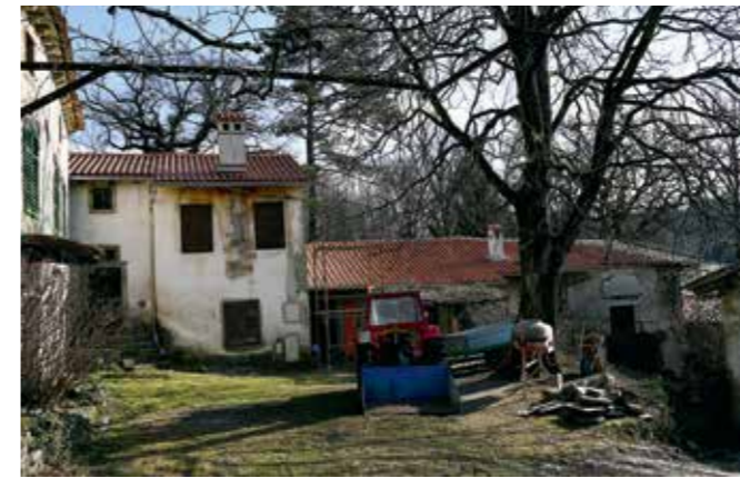
Črniče, Huhov mlin, obnovljene strehe (foto: A. Ščukovt, 2018)
