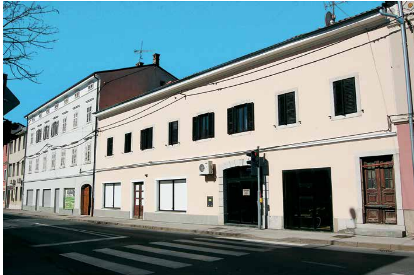
Sežana, obnovljeni fasadi stavb Partizanska cesta 20 in 22 (foto: Eda Belingar, 2018)
