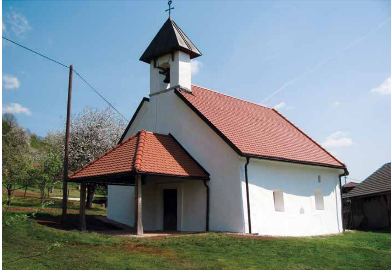
Podklanec, cerkev sv. Jožefa po celostni obnovi, 2018 (foto: M. Ocepek)
