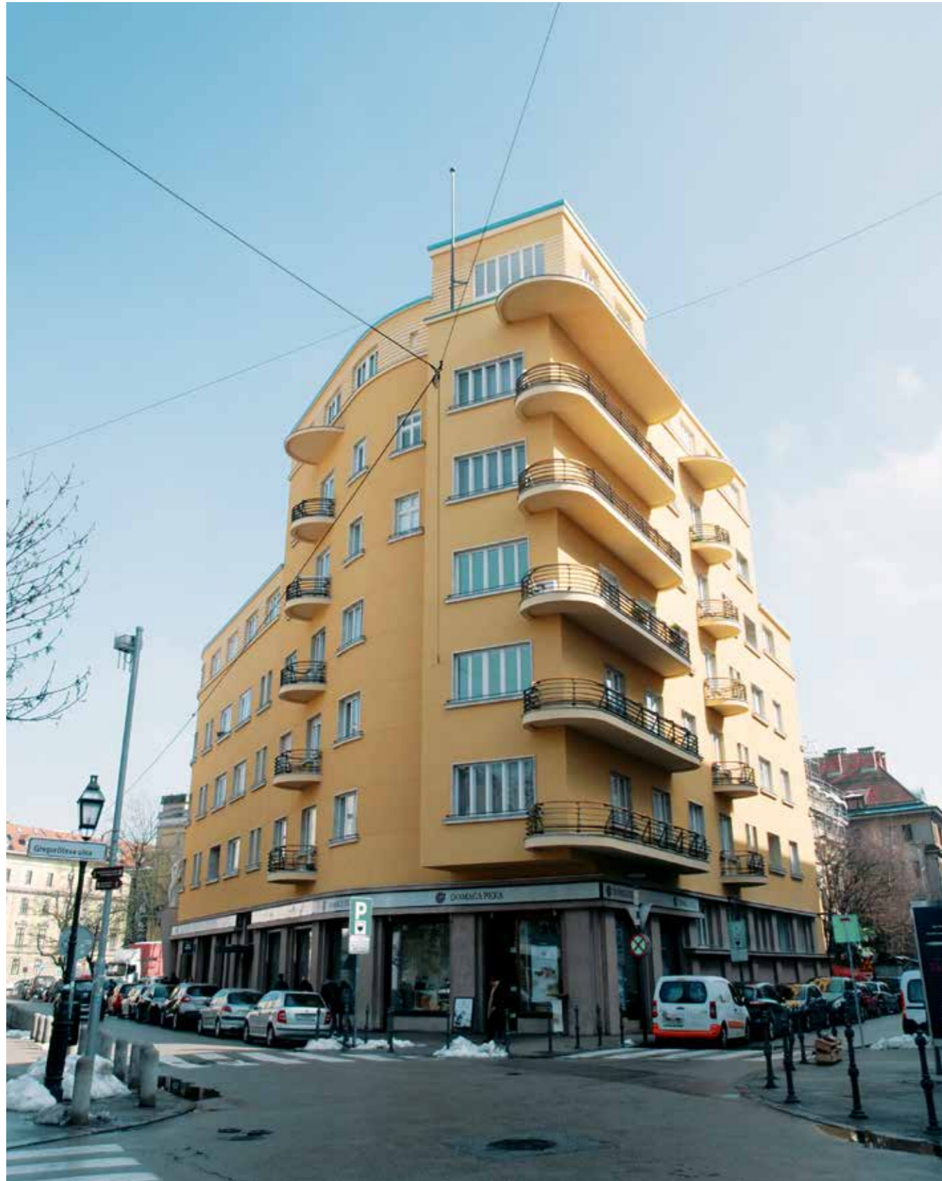
Ljubljana, Mali nebotičnik, dvoriščna fasada po obnovi (foto: M. Režek Kambič, 2009)
