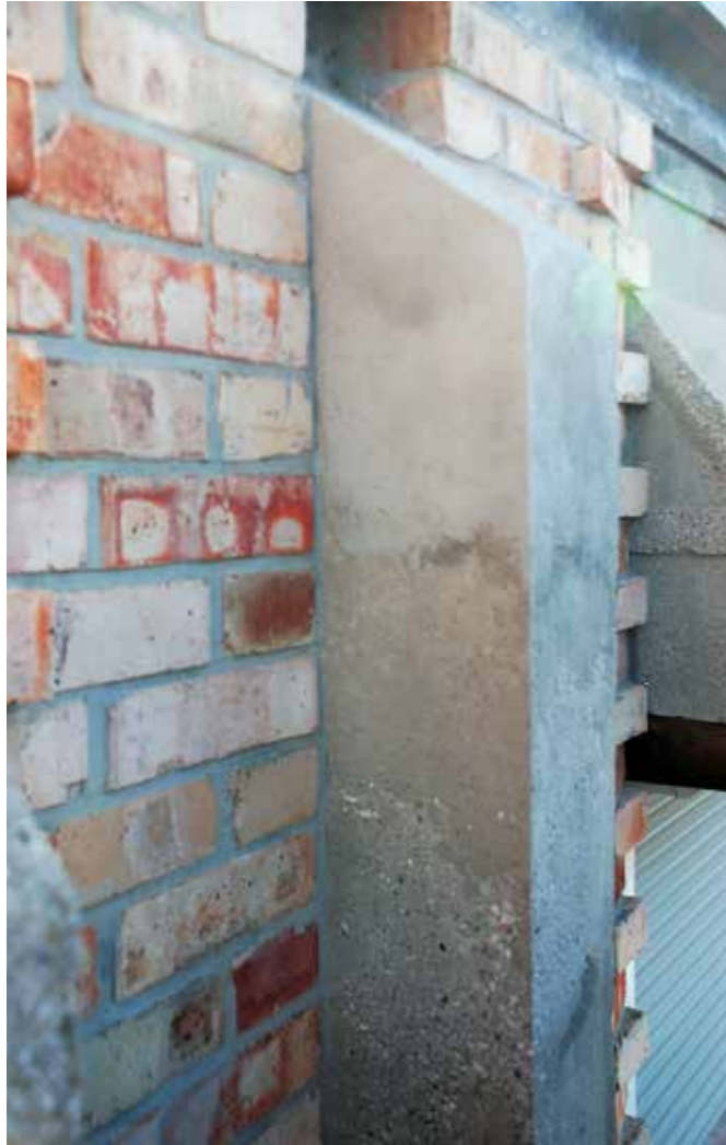
Ljubljana, soška Ferantov vrt, obnovljena fasadna prvina iz vidnega betona (foto: T. Adamič)
