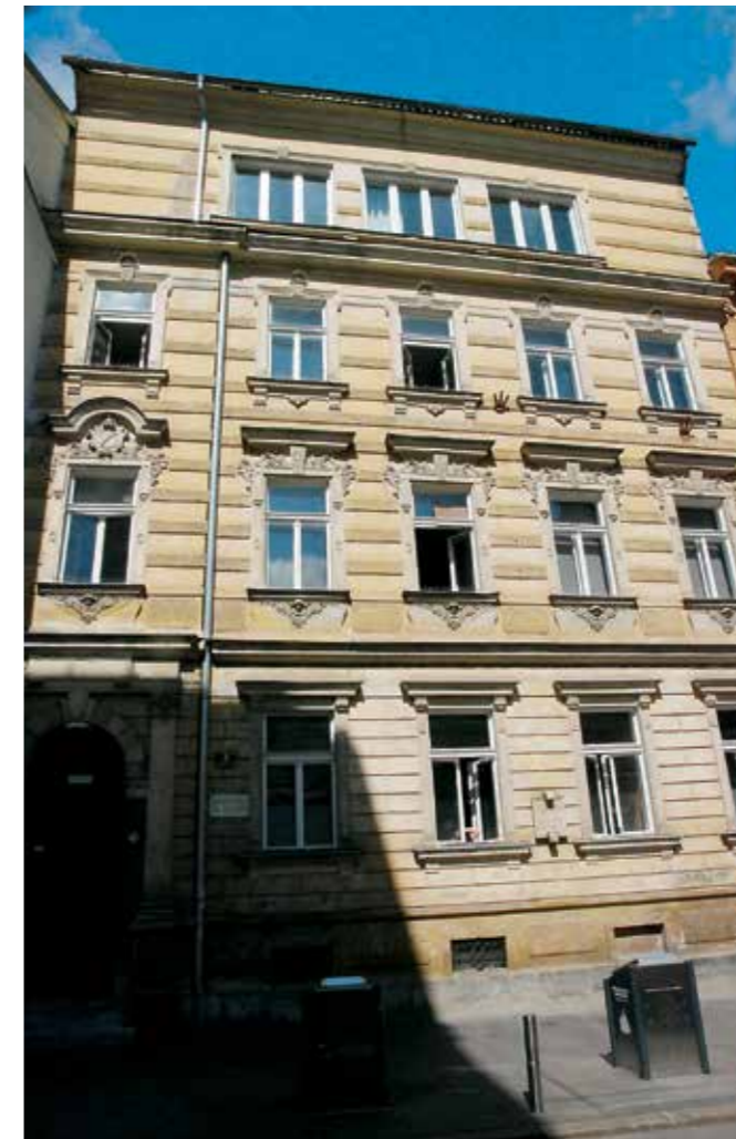
Ljubljana, Gosposka ulica 8, ulična fasada pred obnovo (foto: M. Režek Kambič)
