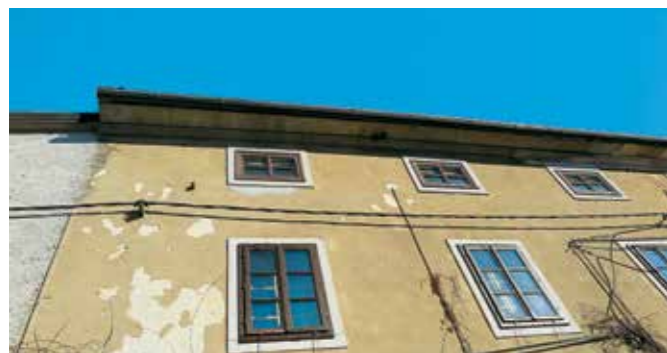
Ilirska Bistrica, Trg maršala Tita 6, stanje fasadnih ometov na vhodni fasadi stanovanjskega poslopja (foto: Klavdij Zalar, 2018)
