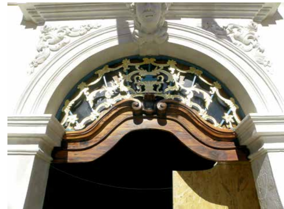
Izola, palača Besenghi degli Ughi, obnovljeno kovinsko okrasje vhodnega portala (foto: N. Škrjanec, 2018)
