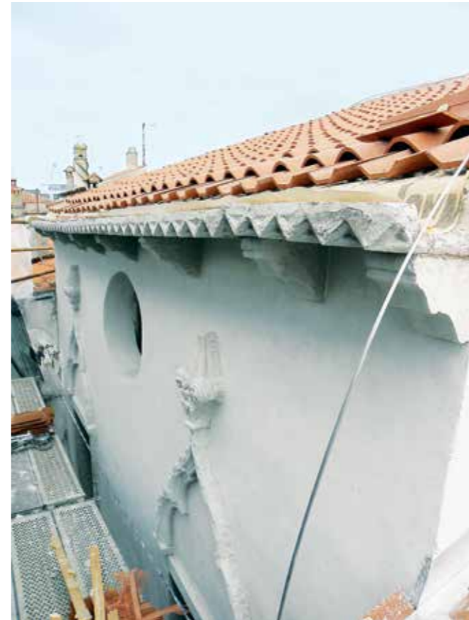
Koper, Vergerjev trg 3, kamniti žleb po odstranjeni zapolnitvi (foto: N. Škrjanec)
