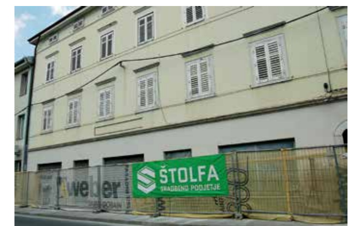
Sežana, obcestna fasada stavbe Partizanska cesta 22 ob začetku del (foto: Eda Belingar, 2018)
