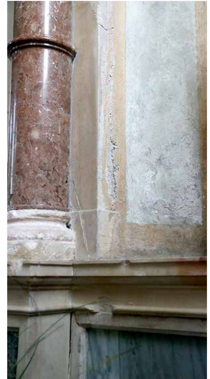
Col, cerkev sv. Lenarta, stranski oltar, detalj poškodb na ometu in bazi stebra (foto: M. Marolt)
