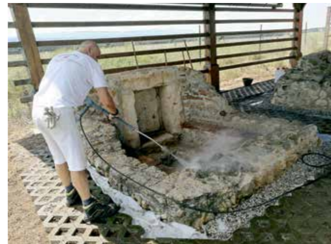
Drnovo, Neviodunum, odstranjevanje oblog s kamnitih delov grobnice (foto: arhiv ZVKDS, RC)
