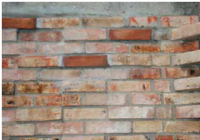
Ljubljana, soška Ferantov vrt, zamenjava poškodovanih fasadnih opek (foto: T. Adamič)
