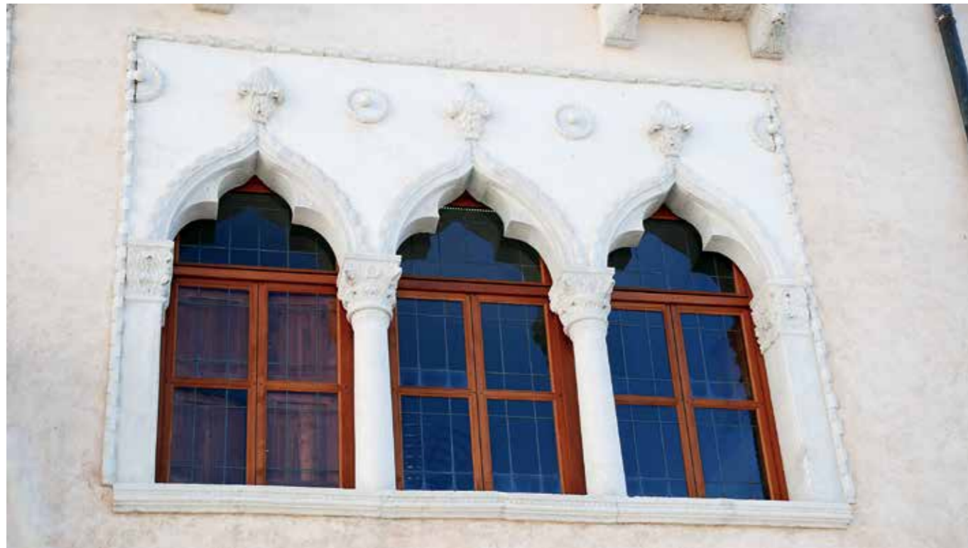
Piran, hiša Benečanka, obnovljeno stavbno pohištvo trifore (foto: M. Kovač, 2019)
