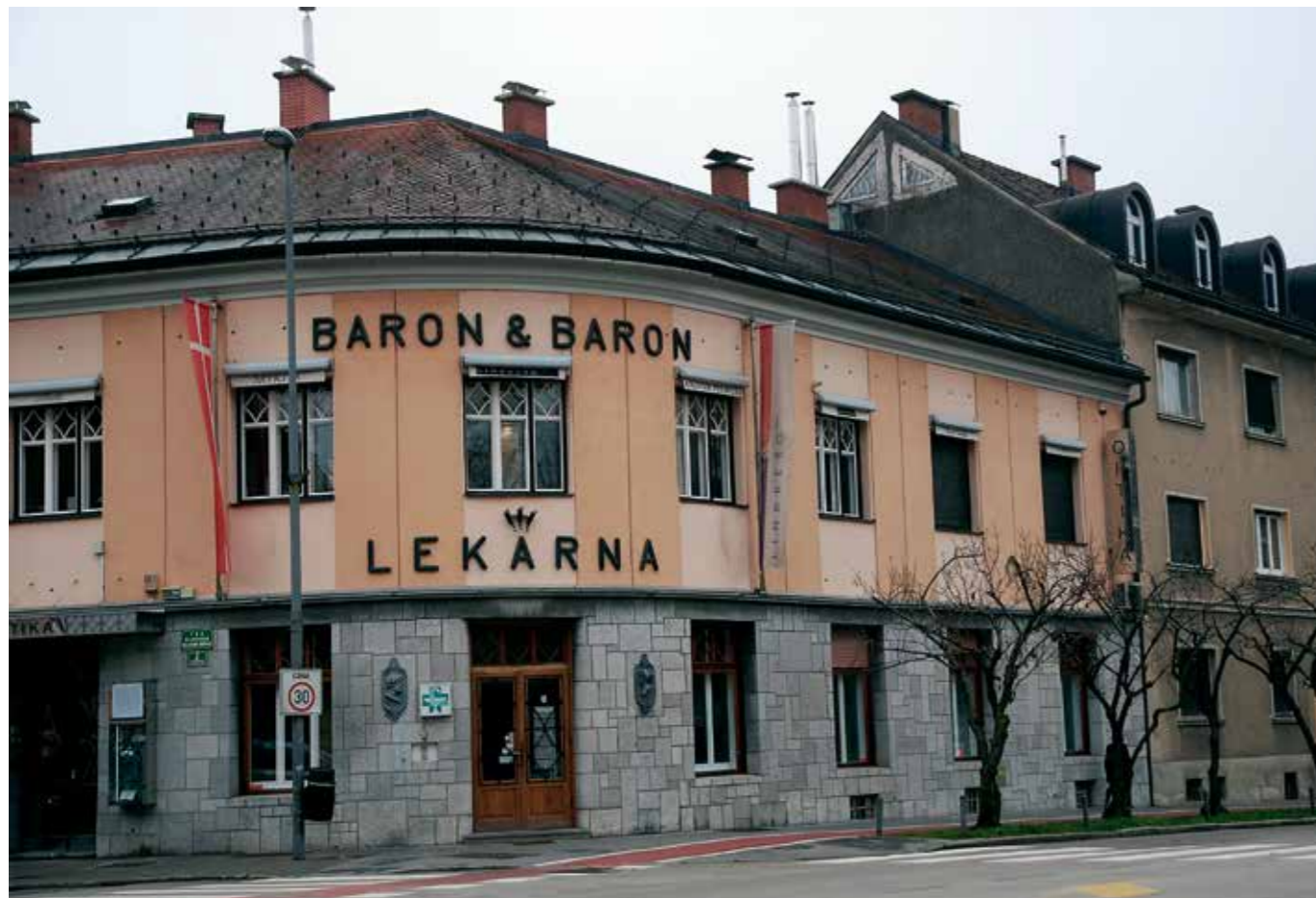
Ljubljana, lekarna Trg mladinskih delovnih brigad 2, ulična fasada s stavbnim pohištvo po obnovi (foto: M. Režek Kambič, 2018)
