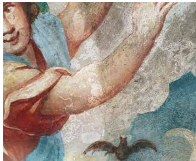
Ljubljana, Breg 20. Da čiščenje z geli ne poškoduje lazur, je lepo vidno na predelu, kjer je bila ob preliminarnih sondiranjih narejena sonda s kationskimi smolami, ki so poškodovale lazuro (foto: Martina Lesar Kikelj).
