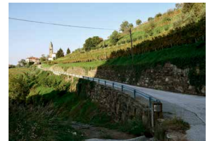
Gradno, pogled na kamnite podporne zide, stanje po obnovi (foto: A. Ščukovt, 2018)
