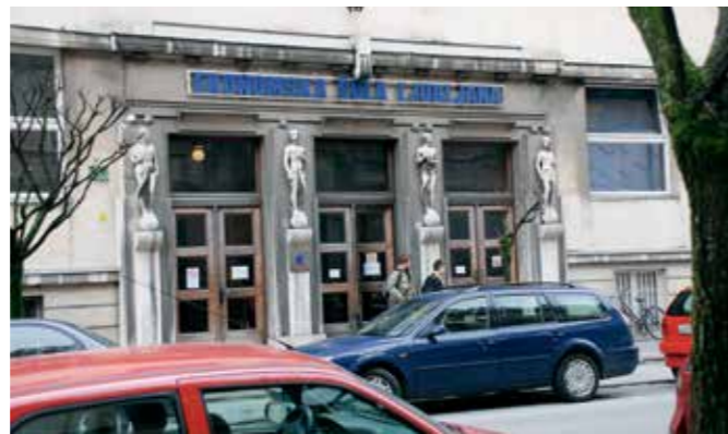
Ljubljana, palača ekonomske srednje šole, glavni portal pred obnovo (foto: M. Režek Kambič, 2006)
