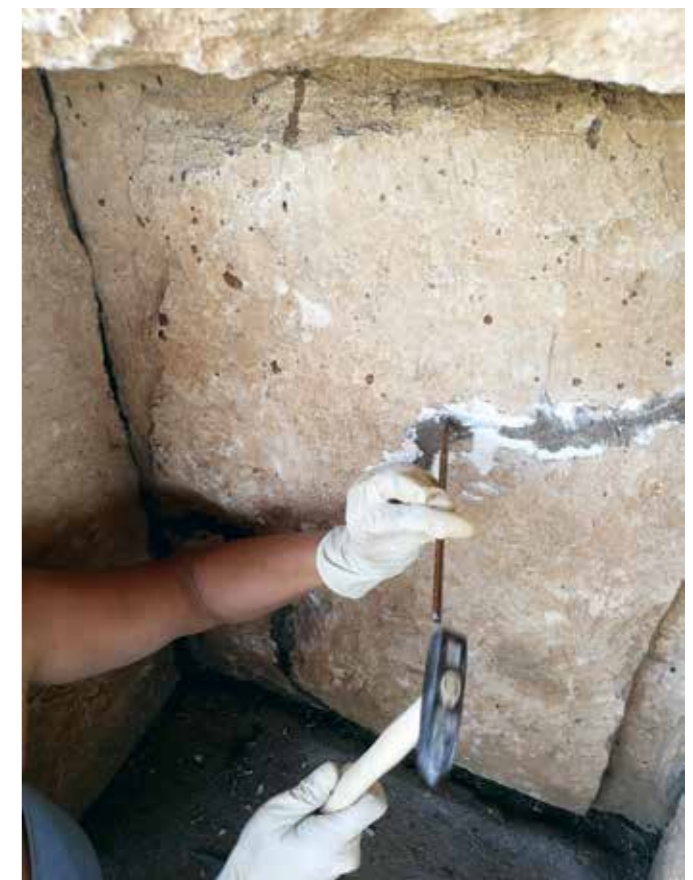
Drnovo, Neviodunum, odstranjevanje neustreznih domodelacij (foto: arhiv ZVKDS, RC)
