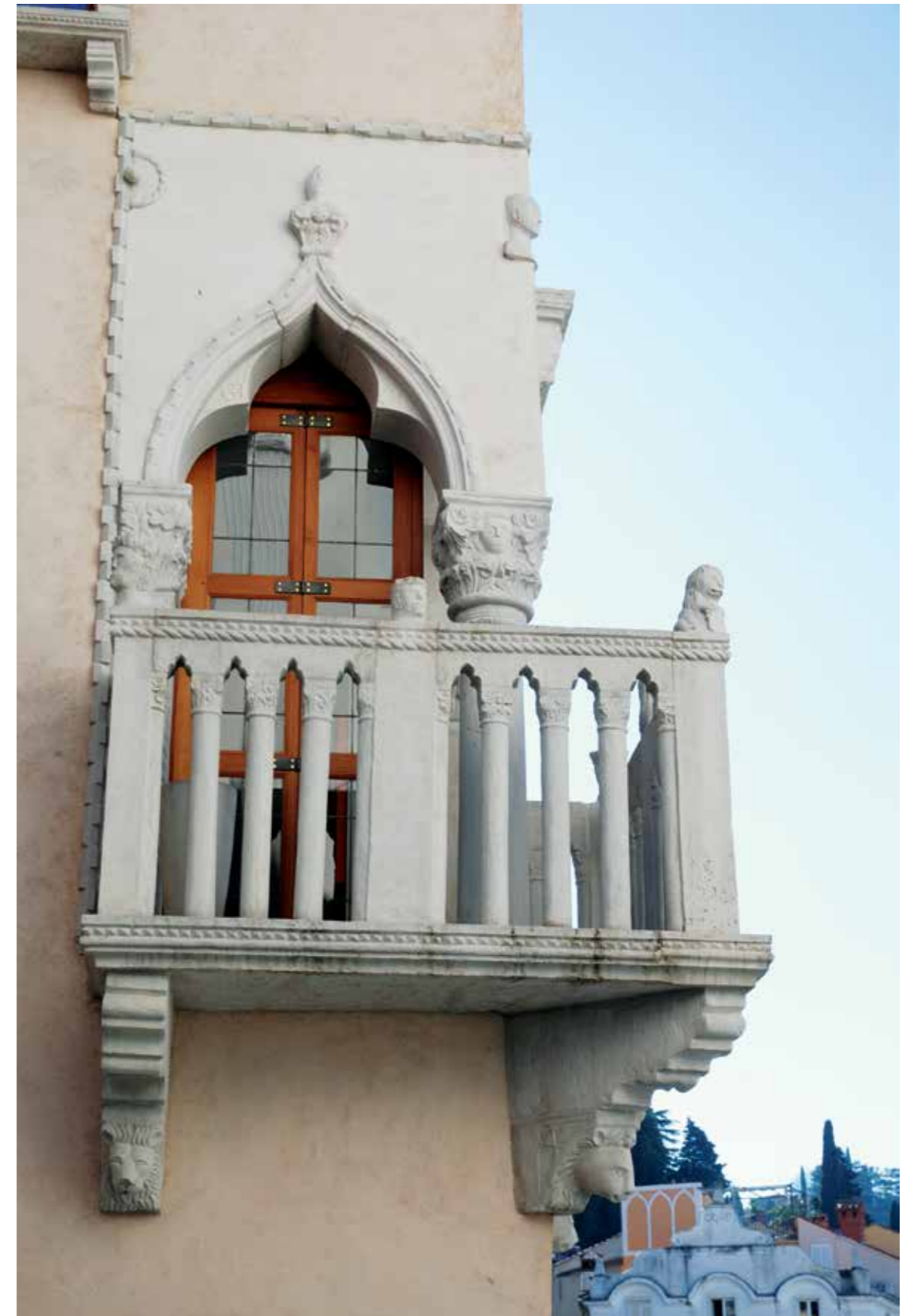
Piran, hiša Benečanka, obnovljeno stavbno pohištvo vogalnega balkona (foto: M. Kovač, 2019)
