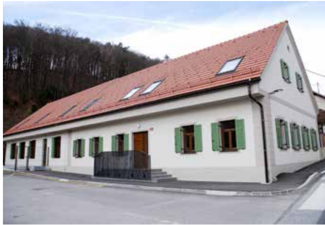
Fram, nekdanja Turnerjeva gostilna po prenovi (foto: L. Medved, marec 2019)
