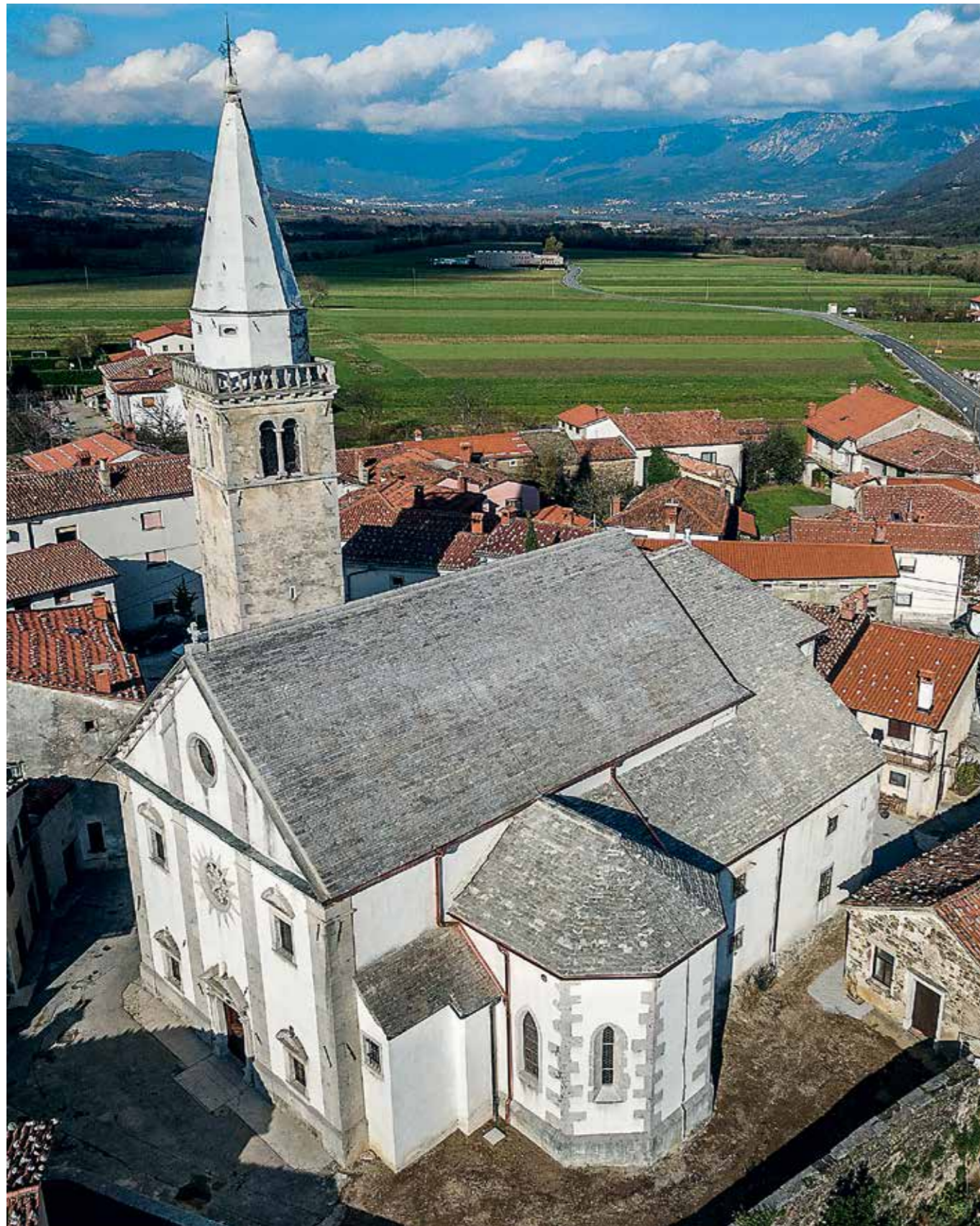
Podnanos, cerkev sv. Vida, pogled na obnovljeno streho (foto: A. Bratož)
