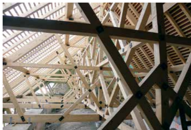
Stična, cerkev Žalostne Matere Božje, nova strešna konstrukcija (foto: S. Ravnikar)
