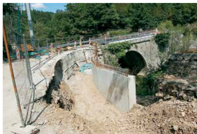
Škoflje, kamniti most čez Reko, predhodni utrditvi zaledja je sledila izdelava armiranobetonskega podpornega zidu (foto: Eda Belingar, 2018).
