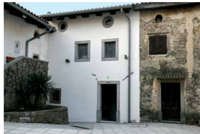
Vipavski Križ, objekt parc. št. 3875, 3874/1, obe k. o. Vipavski Križ – severna fasada po obnovi (foto: A. Ščukovt, 2019)
