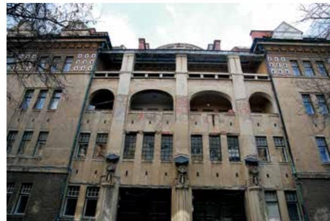
Ljubljana, Nemška hiša, severna fasada s posodobljeno stekleno streho in zaščitnimi strešicami nad kiparskim okrasom pred obnovo (foto: M. Režek Kambič, 2015)
