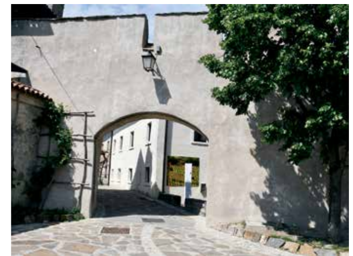
Šmartno, severovzhodna vrata po obnovi ometa (foto: A. Ščukovt, 2018)
