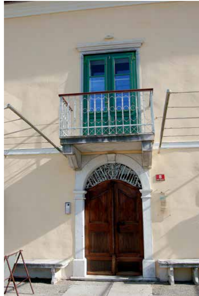
Domačija Matavun 8, restavrirana vrata in nameščena lesena letev na ograji balkona nad vrati (foto: Eda Belingar, 2019)
