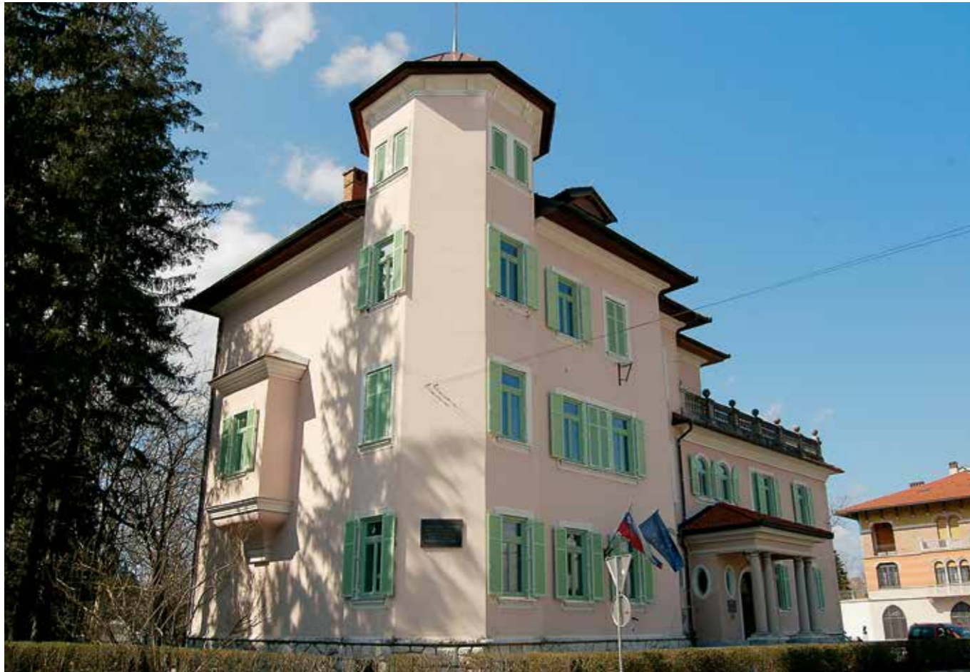
Ilirska Bistrica, Bazoviška cesta 22, z novim stavbnim pohištvom opremljena fasada sodišča (foto: Eda Belingar, 2019)
