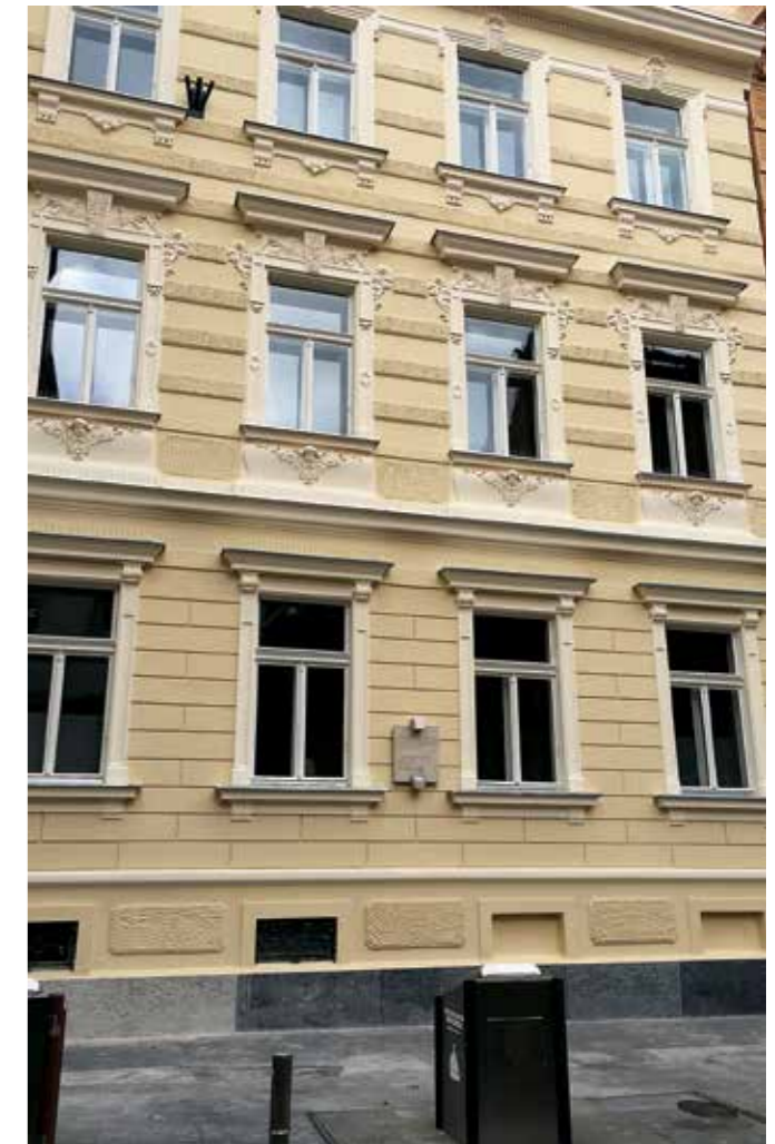
Ljubljana, Gosposka ulica 8, ulična fasada po obnovi (foto: M. Režek Kambič)
