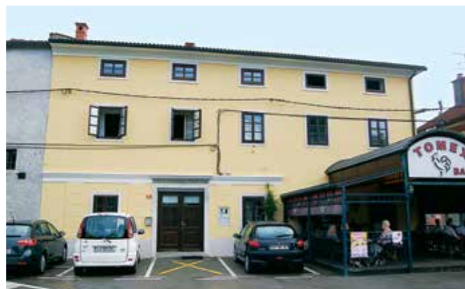
Ilirska Bistrica, Trg maršala Tita 6, vhodna, na trg obrnjena fasada stanovanjskega poslopja po izvedbi novih ometov (foto: Eda Belingar, 2018)
