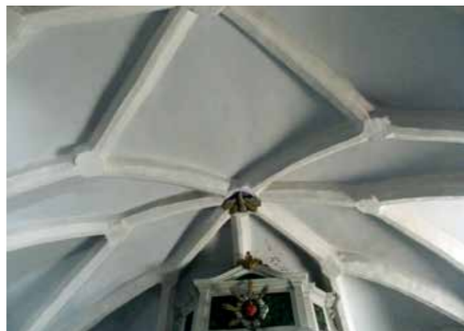
Strop prezbiterja cerkve sv. Martina v Zazidu pred začetkom restavratorskih del (foto: E. Benčič Mohar, 2017)
