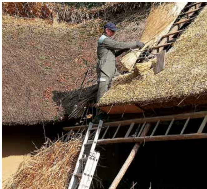
Gornji Slaveči, Bežanova domačija, obnavljanje slamnate strehe (foto: B. Ramšak, september 2018)
