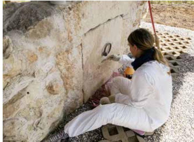
Drnovo, Neviodunum, dopolnjevanje poškodb z nadomestno malto iz apna NHL in ustreznega peska (foto: arhiv ZVKDS, RC)
