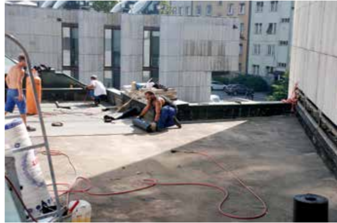
Ljubljana, Cankarjev dom, obnova ravne strehe z bitumensko hidroizolacijo (foto: T. Adamič)
