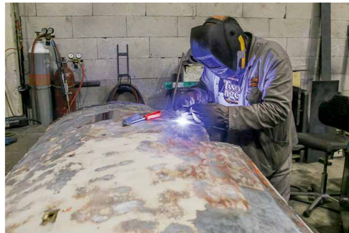
Triglav, Aljažev stolp, saniranje poškodb na plašču stolpa (foto: Mirko Kunšič, 2018)
