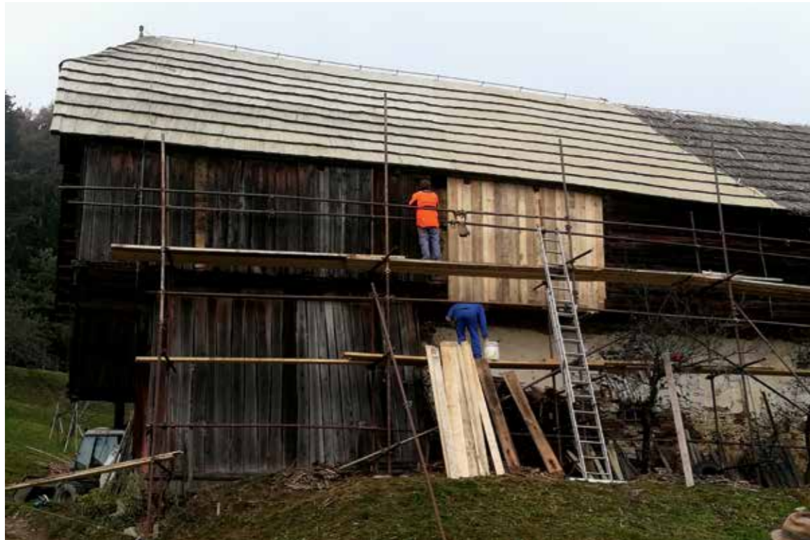
Delna obnova strehe in opaža na gospodarskem poslopju pri Janežu na Strojni (foto: L. Medved, november 2018)
