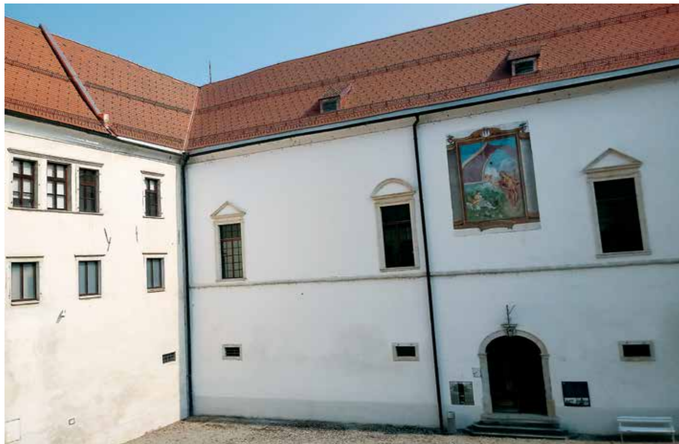
Brežice, nova kritina na strehah severnega in vzhodnega trakta gradu Brežice (foto: T. Golob, 2018)
