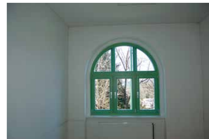
Ilirska Bistrica, Bazoviška cesta 22, novo nameščeno okno (foto: Eda Belingar, 2019)
