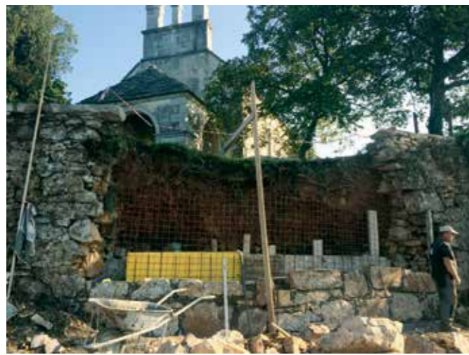
Tomaj, cerkev Device Marije v Britofu, podporni zid med obnovo (foto: M. Osojnik)
