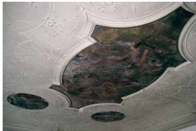
Ljubljana, Breg 20, preliminarna sondiranja: čiščenje z ionskimi izmenjevalci, kationskimi smolami (foto: Martina Lesar Kikelj)
