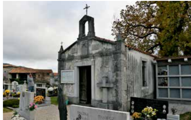
Temnica, mrliška vežica, stanje pred celovito obnovo (foto: A. Ščukovt, 2017)
