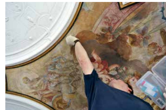
Na mednarodni delavnici Nove metode čiščenja stenskih poslikav z geli je prof. Richard Wolbers pripravil oljno-vodno emulzijo na osnovi ksantanskega gela, s katero se je približal idealnemu sistemu čiščenja Jelovškove poslikave (foto: Tine Benedik).
