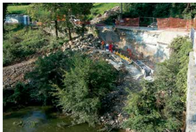
Škoflje, kamniti most čez Reko, obnovitvena dela so bila obsežna (foto: Eda Belingar, 2018).
