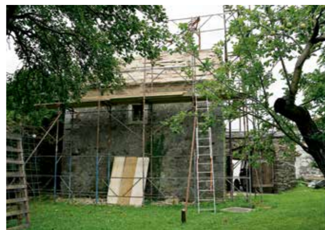
Rodmanov hram v Lozicah, streha po odstranitvi kamnite kritine (foto: A. Ščukovt, 2018)
