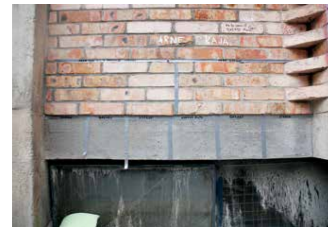
Ljubljana, soseska Ferantov vrt, vzorci čiščenja na opečnati in betonski površini (foto: T. Adamič)
