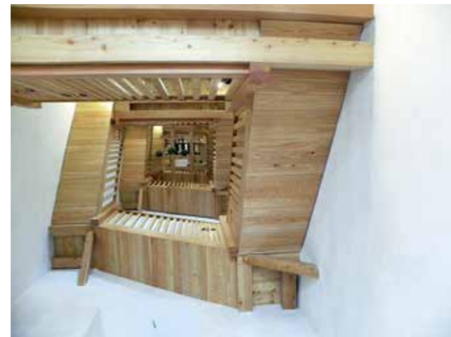
Piran, zvonik sv. Jurija, novo stopnišče (foto: N. Škrjanec, 2018)
