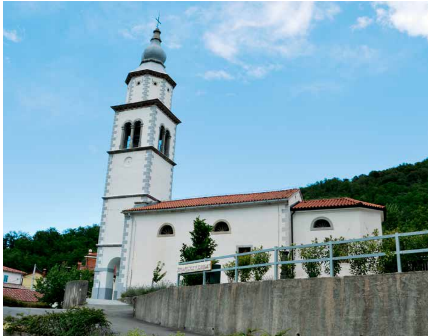
Kodreti, cerkev sv. Katarine, pogled na cerkev sv. Katarine po obnovi fasad zvonika (foto: M. Osojnik)
