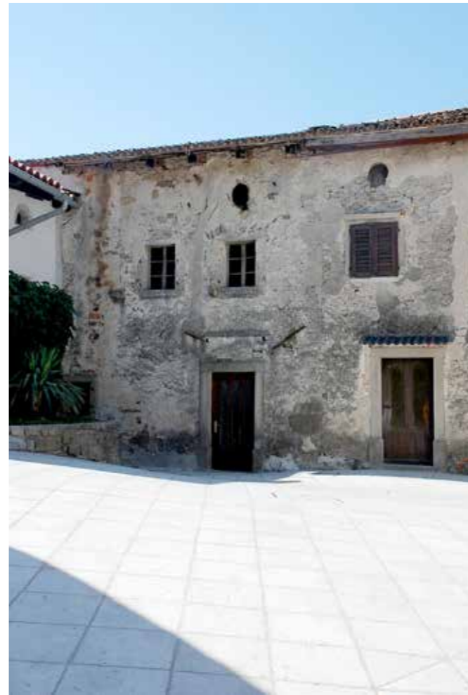
Vipavski Križ, objekt parc. št. 3875, 3874/1, obe k. o. Vipavski Križ – stanje pred obnovo (foto: A. Ščukovt, 2017)
