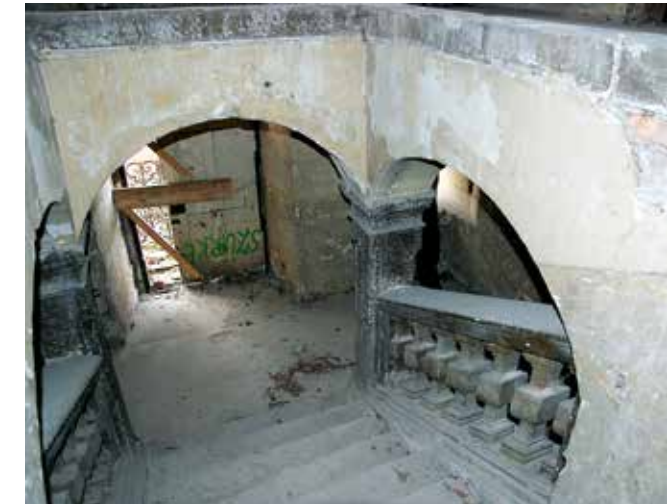
Celje, dvorec Zgornji Lanovž, osrednje stopnišče pred prenovo (foto: Nataša Podkrižnik, 2016)
