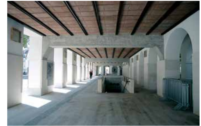
Del arkadnega hodnika v sklopu uršulinskega samostana po prenovi (foto: M. Režek Kambič, 2017)
