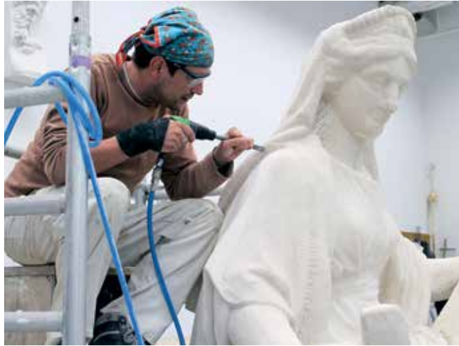
Ljubljana, Vladna palača, klesanje s pomočjo pnevmatskega orodja (foto: arhiv ZVKDS, Restavratorski center)
