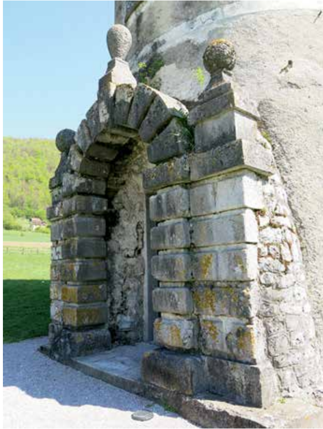
Soteska, Hudičev turn, kamnit portal pred posegom, preraščen z vegetacijo in mikroorganizmi (foto: K. Rus)
