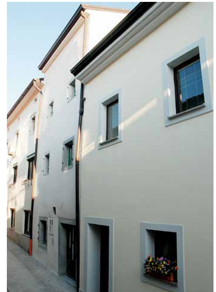
Vipavski Križ, hiša št. 27a po obnovi (foto: A. Ščukovt, 2017)
