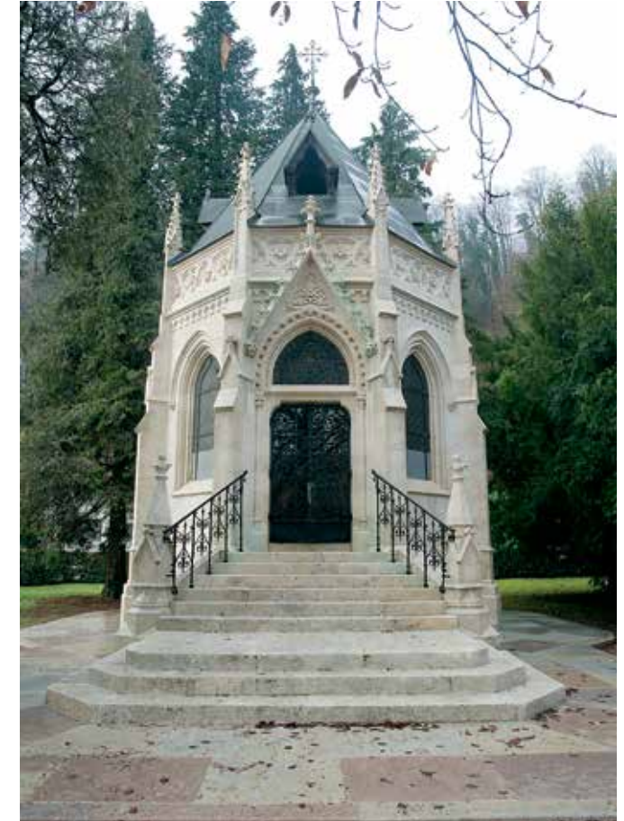
Krško, mavzolej po prenovi (foto: M. Režek Kambič, 2017)
