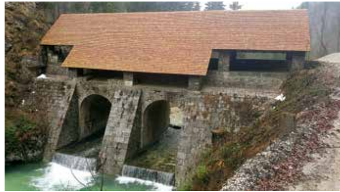
Vojsko, idrijske klavže, na novo prekrita streha (foto: arhiv CUD Hg Idrija)
