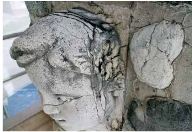
Črna na Koroškem, spomenik žrtvam prve in druge svetovne vojne, poškodbe kamnite glave dečka pred demontažo (foto: arhiv ZVKDS, RC)
