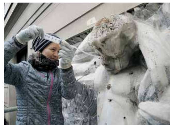
Ljubljana, Obrtna šola na Aškerčevi cesti, injektiranje (foto: arhiv ZVKDS, RC)
