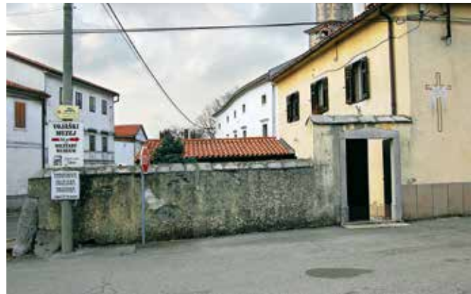
Lokev, visoki zid dvorišča župnišča z vrhom v špico (foto: E. Belingar, 2016)
