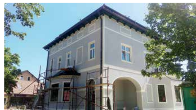
Ormož, hiša Ulica dr. Hrovata 10, dela na fasadi (foto: A. Zupan)
