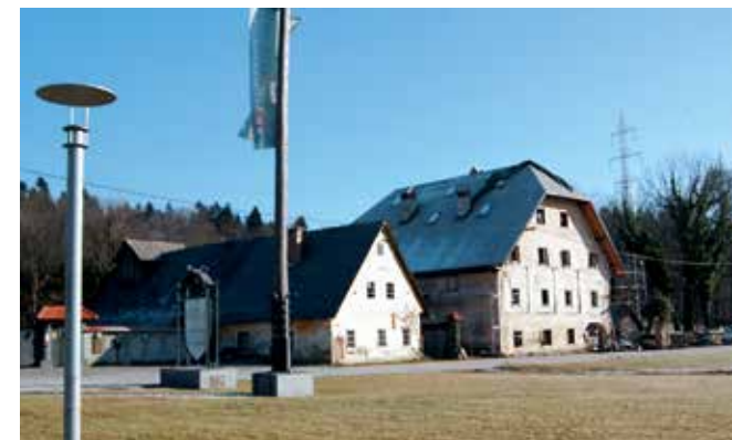
Zgornji Otok 6, zahodni del ostrešja po obnovi (foto: M. Tercelj Otorepec, 2017)
