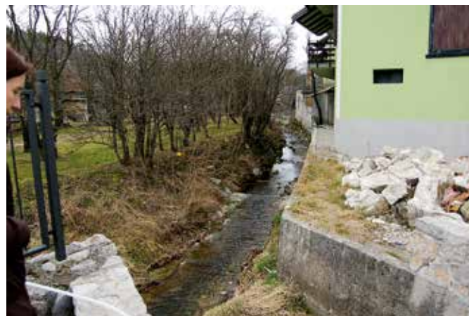
Narin, del potoka in na suho zložene brežine, ki ga je zaradi opustitve vzdrževanja preraslo rastlinje ter zasul zemeljski material (foto: E. Belingar, 2017)
