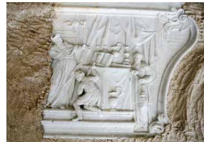
Piran, cerkev Marije Zdravja, razsoljevanje originala s celulozno-glineno oblogo in destilirano vodo (foto: arhiv ZVKDS, RC)
