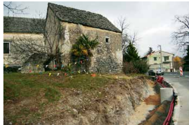
Šmarje pri Sežani, začetek izvajanja del pri cerkvi in komunski kašči (foto: E. Belingar, 2017)
