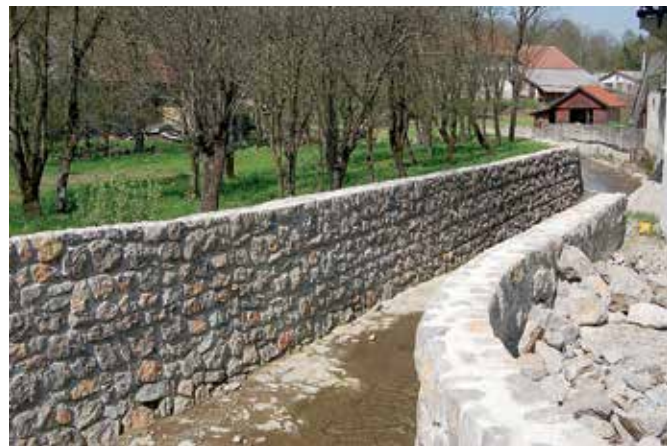
Narin, isti odsek po izvedenih vzdrževalnih delih (foto: E. Belingar, 2018)
