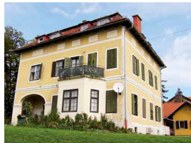
Ormož, hiša Ulica dr. Hrovata 10, južna fasada pred prenovno (foto: A. Zupan)
