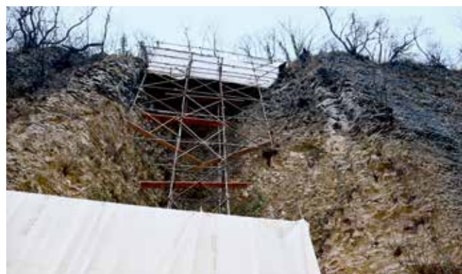
Sela pri Volčah, obnova enoločnega mosta (foto: A. Ščukovt, 2017)
