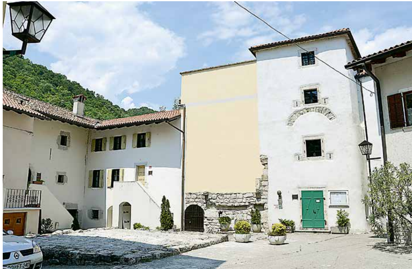
Kanal ob Soči, Kontrada pred prenovu (foto: J Svetina, 2012)
