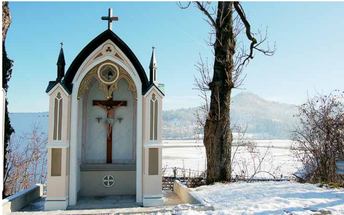
Planina, kapelica v Dolnji Planini po zaključku restavratorskih del z nameščenim razpelom v notranjosti in lesenim krogovičjem (foto: E. Belingar, 2017)
