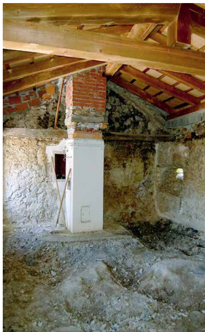
Škocjan pri Divači, domačija Škocjan 7, notranjost po odstranitvi stropa, z zidanim dimnikom in polkrožno zaključeno vdolbino, ki se nakazuje v desnem vogalu (foto: E. Belingar, 2017)
