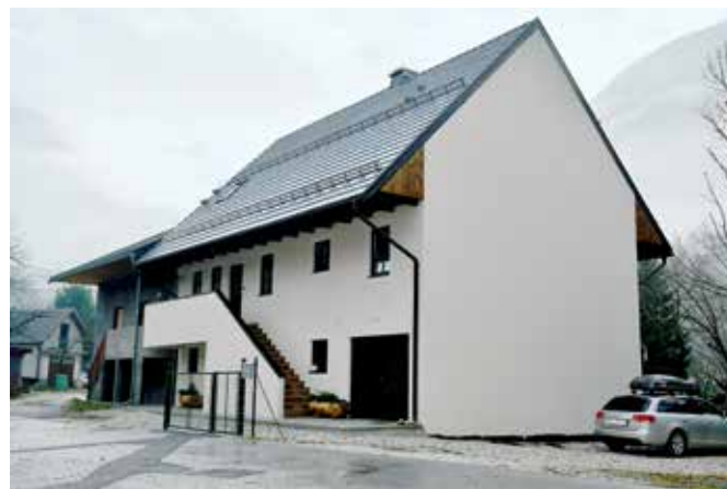
Čezsoča, nadomestni objekt hiša št. 56, zgrajen v okviru popotresne obnove Posočja (foto: A. Ščukovt, 2018)
