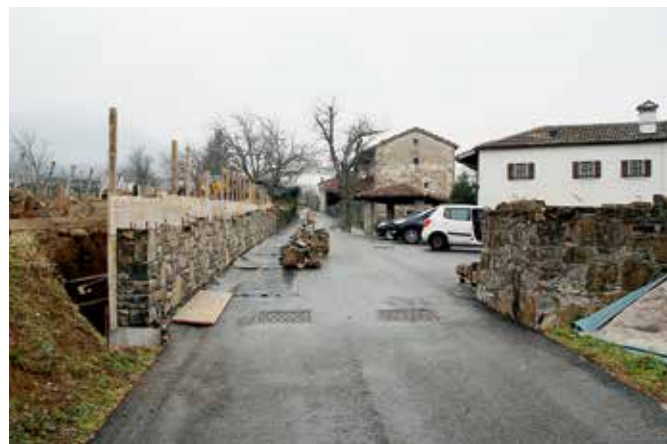
Slap, gradnja podpornega zida na območju Majerije (foto: A. Ščukovt, 2017)
