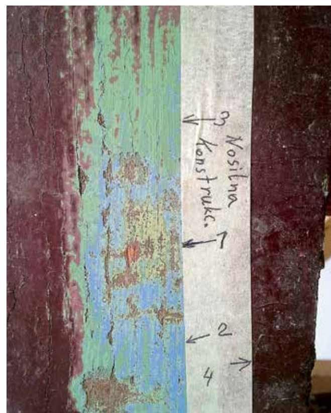
Bled, vremenska hišica s spominsko ploščo Arnoldu Rikliju, sondiranje barvnih plasti (foto: M. Hiršfelder, 2017)
