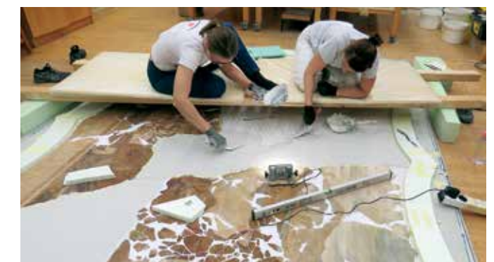
Križ pri Komendi, grad, nanos druge plasti malte za izdelavo rekonstrukcije manjkajočega dela poslikave s TattooWall tehnologijo (foto: Petra Benedik)
