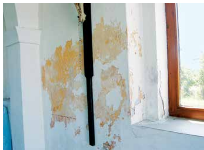
Drskovče, kapela Žalostne Matere Božje, poškodovani ometi in beleži v notranjosti (foto: E. Belingar, 2015)
