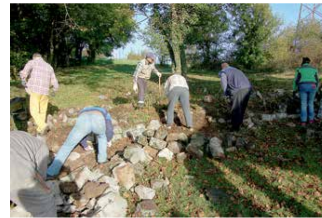
Gradišče pri Divači, cerkev sv. Helene, ponekod se je zid v celoti pozidal na novo (foto: E. Belingar, 2017)
