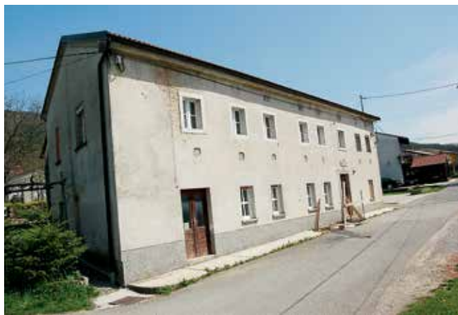
Vrbica, vaški dom, v okenske odprtine so vgradili plastična okna (foto: E. Belingar, 2018)
