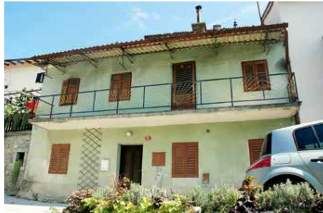
Vipavski Križ, hiša št. 46 pred obnovo (foto: A. Ščukovt, 2017)
