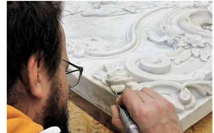
Piran, cerkev Marije Zdravja, odstranjevanje trdovratnih sekundarnih oblog z ultrazvočnim kladivcem (foto: arhiv ZVKDS, RC)
