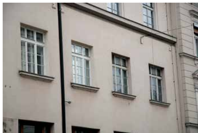
Ljubljana, palača Miklošičeva cesta 24, kopija okna levo in originalno okno desno (foto: M. Režek Kambič, 2017)
