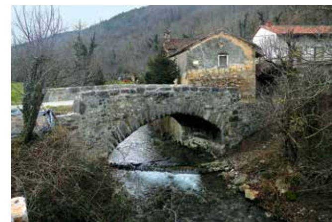
Lozice, kamniti most po obnovi ločnih sten (foto: B. Zbačnik)
