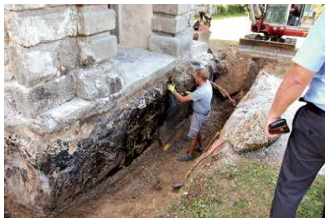
Soteska ob Krki, vrtni paviljon Hudičev turn, odstranitev obstoječega drenažnega zasutja (foto: T. Mesojedec)
