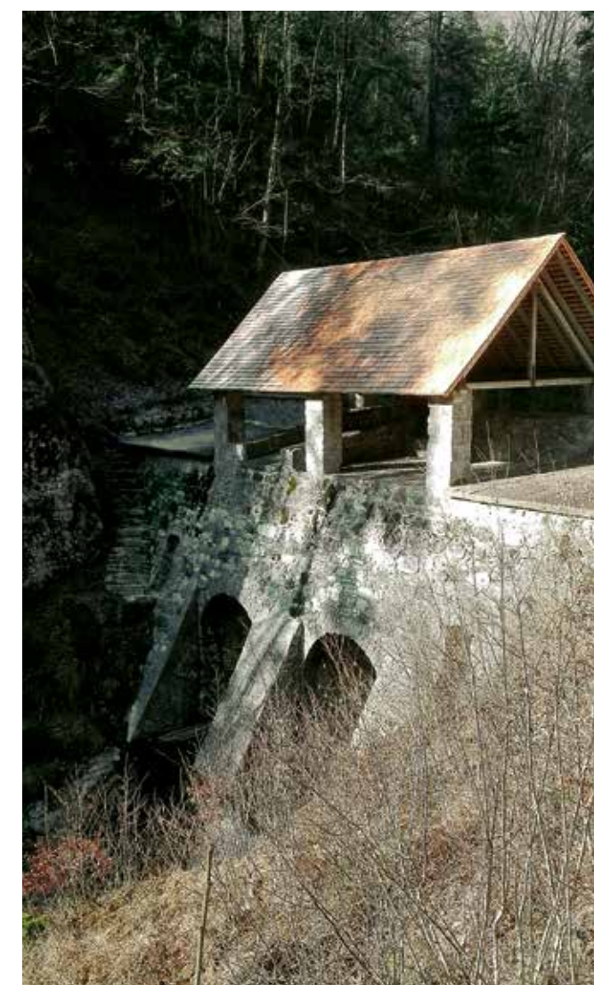
Idrijska Bela, Belčne klavže, na novo prekrita streha (foto: arhiv CUD Hg Idrija)
