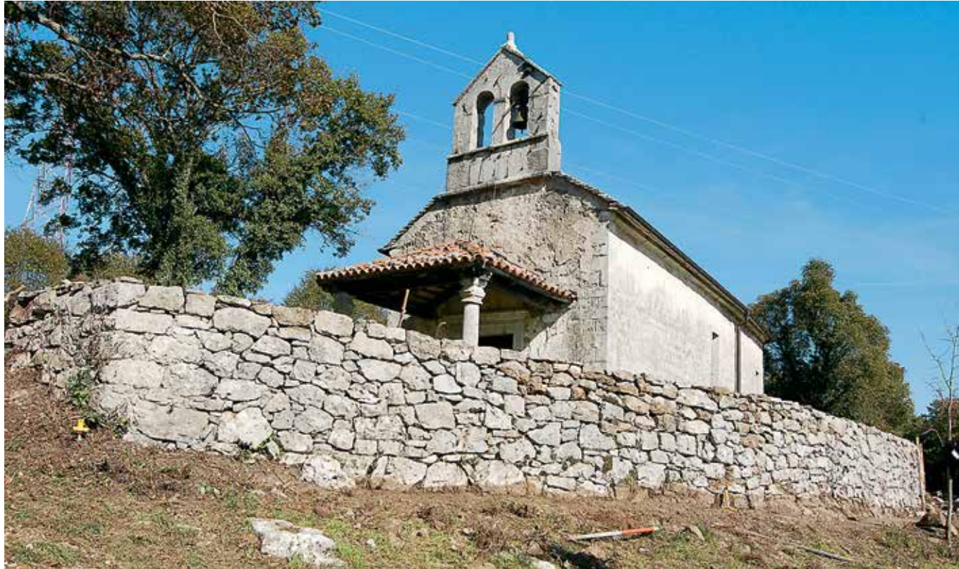
Gradišče pri Divači, cerkev sv. Helene, obnovljena cerkvena ograda (foto: E. Belingar, 2017)
