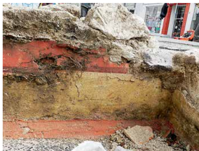
Celje, arheološko najdišče Celje, freske so bile poškodovane zaradi drevesnega debla in razrasta koreninic (foto: J. Radšelj, 2014).
