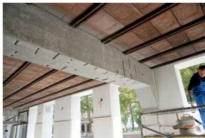
Ljubljana, arkade, sanacija betonskih nosilcev (foto: M. Režek Kambič, 2017)
