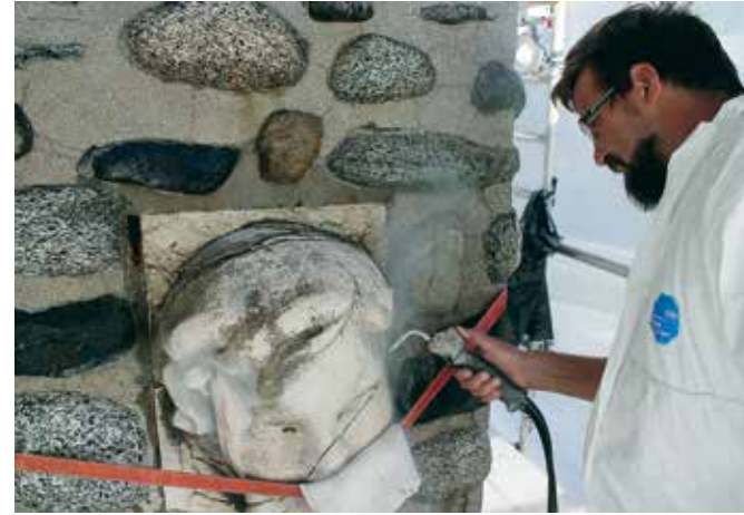
Črna na Koroškem, spomenik žrtvam prve in druge svetovne vojne, odstranjevanje oblog in bioloških dejavnikov propadanja z vodno paro (foto: arhiv ZVKDS, RC)
