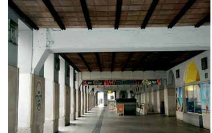
Ljubljana, del arkadnega hodnika v sklopu uršulinskega samostana pred prenovo (foto: M. Režek Kambič, 2011)
