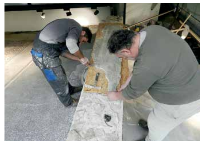
Celje, arheološko najdišče Celje, priprava fresk za ponovno montažo na mesto, s katerega so bile snete (foto: J. Radšelj, 2016)
