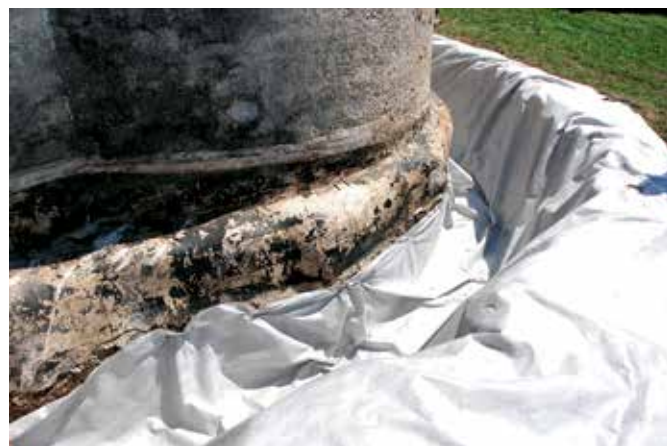
Soteska ob Krki, vrtni paviljon Hudičev turn, polaganje vodoprepustnega geotekstila Polyfelt TS 50 (foto: T. Mesojedec)
