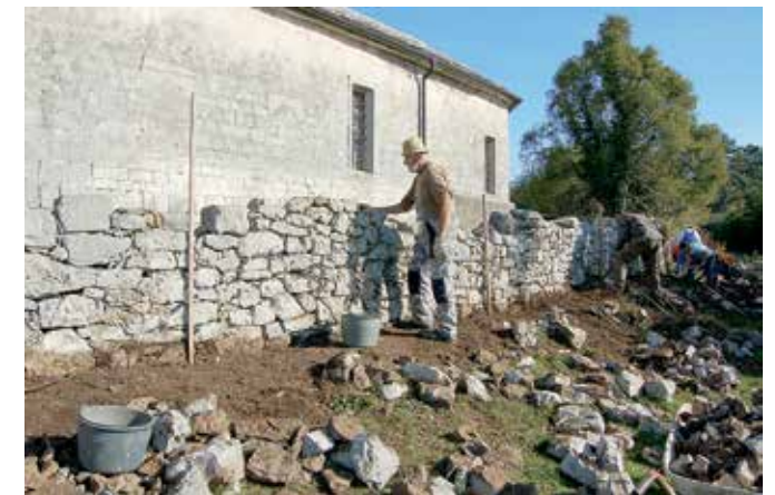
Gradišče pri Divači, cerkev sv. Helene, za enotno višino zidu je bila merilo vrvice, napeta med količki (foto: E. Belingar, 2017)
