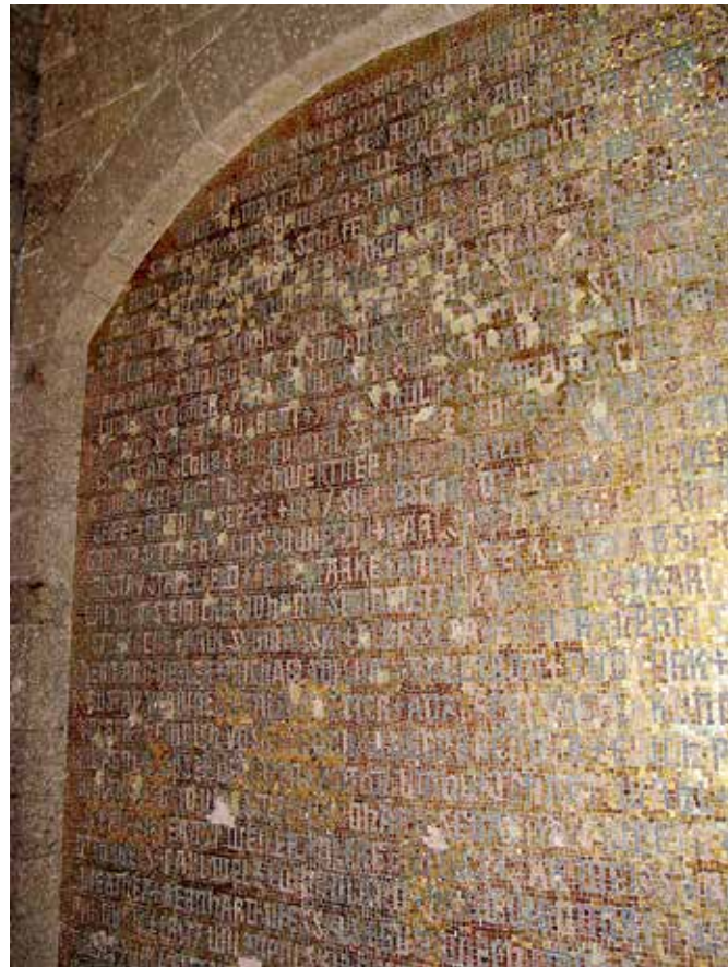
Tolmin, nemška kostnica, sredinski mozaik z označenimi mesti injektiranja in utrjevanja (foto: N. Škrjanec)
