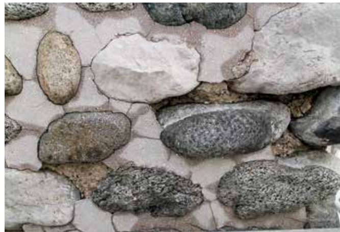
Črna na Koroškem, spomenik žrtvam prve in druge svetovne vojne, razpoke v polnilu med prodniki pred posegom (foto: arhiv ZVKDS, RC)
