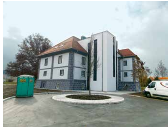
Celje, dvorec Zgornji Lanovž, sodobno interpretirano stopnišče ob severni fasadi dvorca (foto: Nataša Podkrižnik, 2018)
