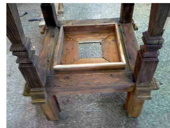
Bled, vremenska hišica s spominsko ploščo Arnoldu Rikliju, popravilo očiščenih lesenih delov hišice (foto: M. Hiršfelder, 2017)
