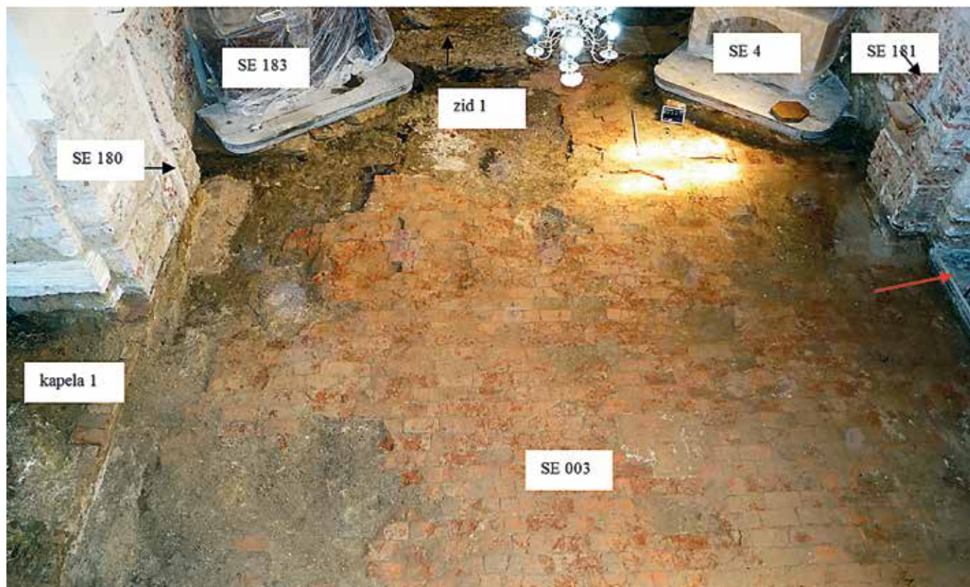
Juršinci, cerkev sv. Lovrenca, tlak iz opečnih tlakovcev iz poznogotske gradbene faze (foto: B. Tušek)
