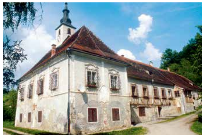
Polički Vrh, Jareninski dvor pred obnovo, pogled na južno in zahodno fasado (foto: J. Skalicky, 2003)
