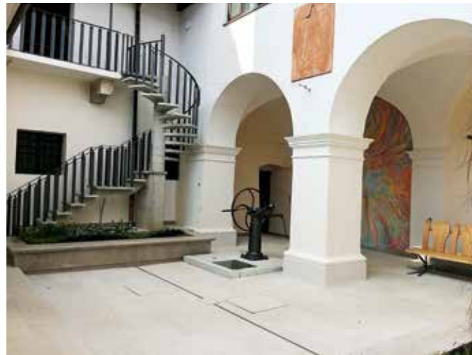
Nova Gorica, frančiškanski samostan Kostanjevica, pogled na obnovljen samostanski atrij (foto: Minka Osojnik)
