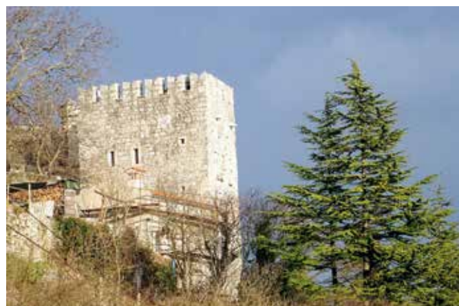
Štanjel, objekt G/1 ob Kobdiljskem stolpu (foto: M. Mozetič)
