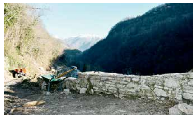
Sela pri Volčah, stara soška pot, sanacija zidov (foto: A. Ščukovt, 2017)
