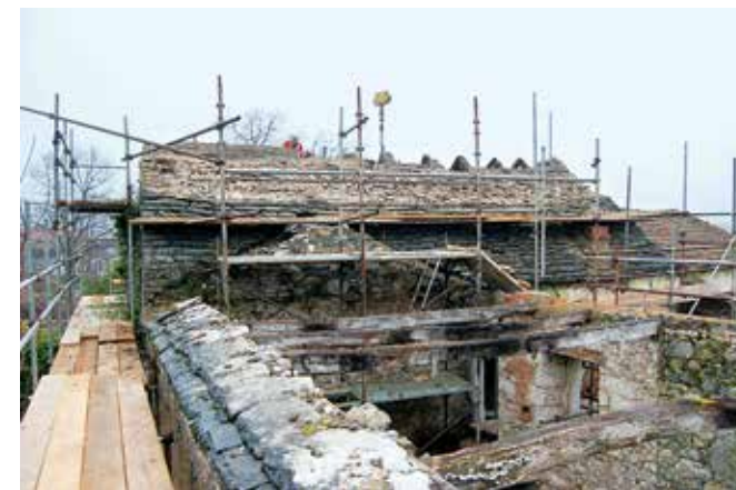
Domačija Šmarje 2 ob začetku obnove, ko se je najprej pričela razkrivati skrlata streha stanovanjske hiše. Streha štale (v ospredju) je bila tedaj že v celoti uničena (foto: E. Belingar, 2017).
