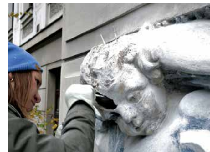
Ljubljana, Obrtna šola na Aškerčevi cesti, utrjevanje in zapolnjevanje votle glavicice deklice z grbom (foto: arhiv ZVKDS, RC)
