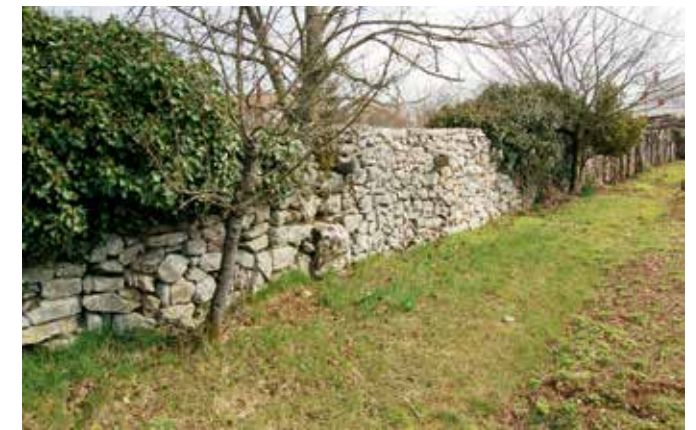
Divača, domačija Kraška 26, na novo zloženi del zidu z vgrajenimi konzolami (foto: E. Belingar, 2017)
