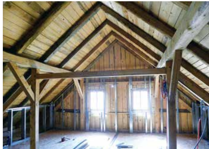
Zgornja Ščavnica, domačija Grafonž, podstrešje med obnovo (foto: S. Vešligaj, marec 2017)
