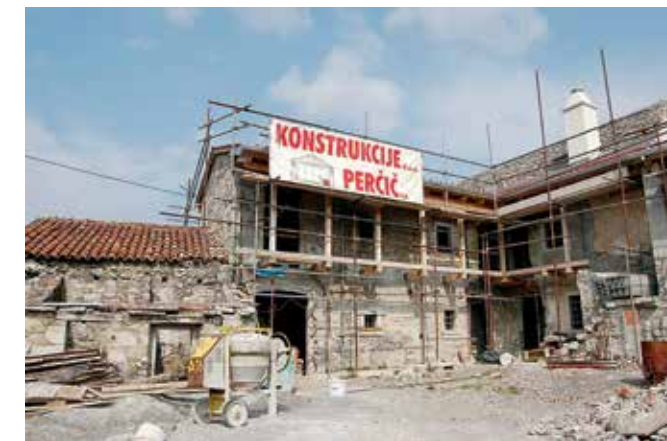
Domačija Šmarje 2 po zaključku v letu 2017 izvedenih del (foto: E. Belingar, 2018)
