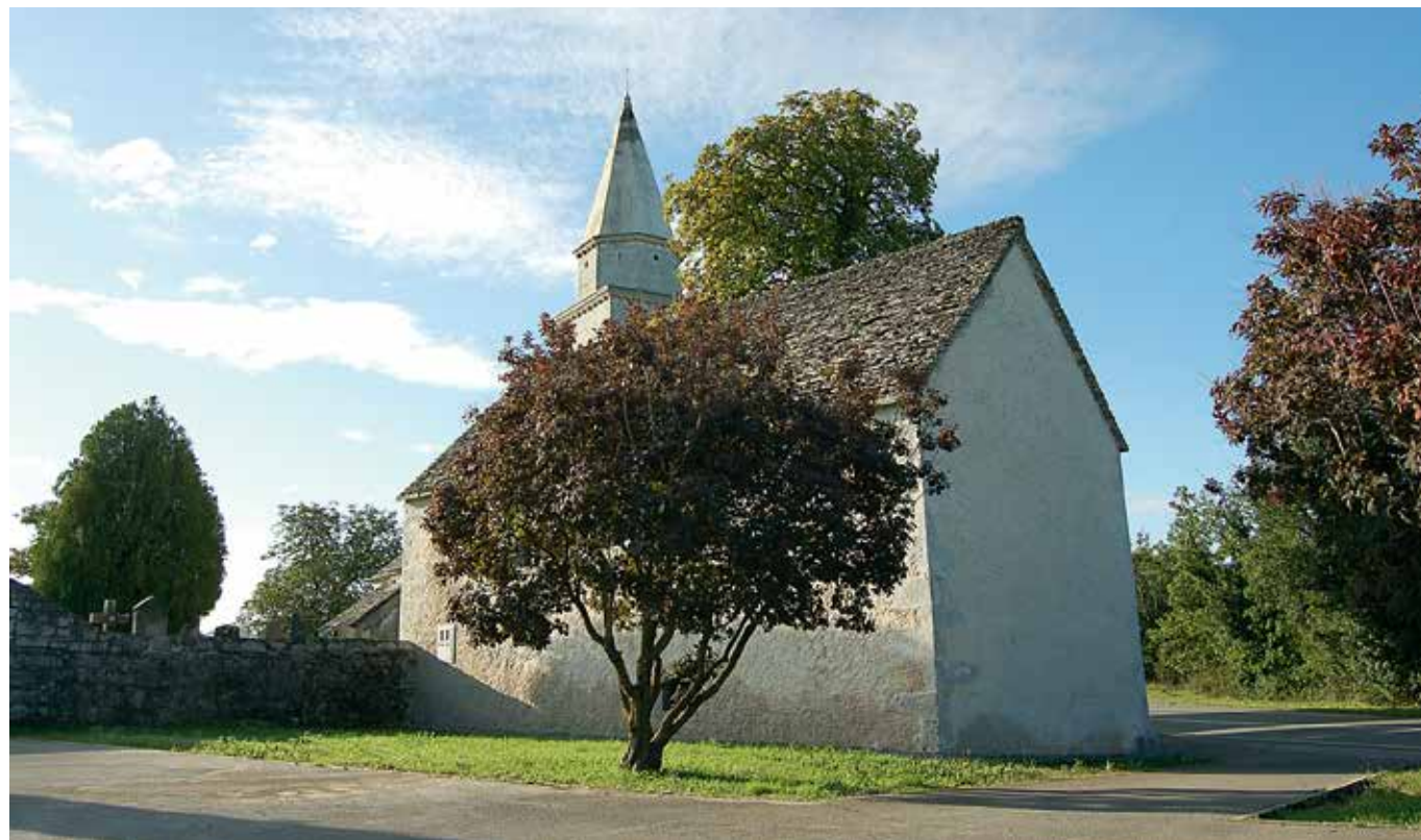
Križ pri Sežani, komunska kašča po obnovi fasadnih ometov (foto: Eda Belingar, 2017)
