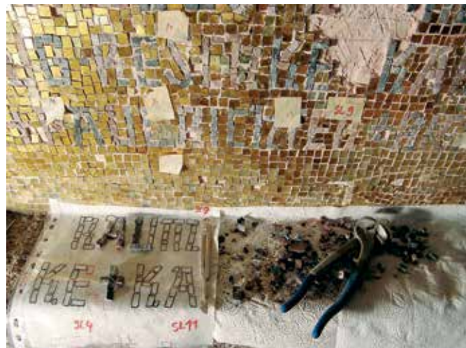
Tolmin, nemška kostnica, dopolnitev na sredinskem mozaiku z identičnimi kamnitimi in pozlačenimi kockicami (foto: N. Škrjanec)
