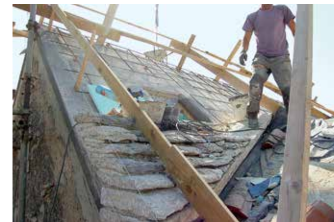
Domačija Šmarje 2, detajl izvedbe nove skrlate strehe stanovanjske hiše (foto: E. Belingar, 2017)
