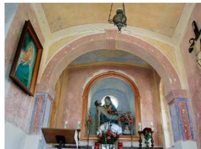
Drskovče, kapela Žalostne Matere Božje. Po odstranitvi odvečnih beležev se je razkrila prvotna poslikava sten (foto: E. Belingar, 2018)
