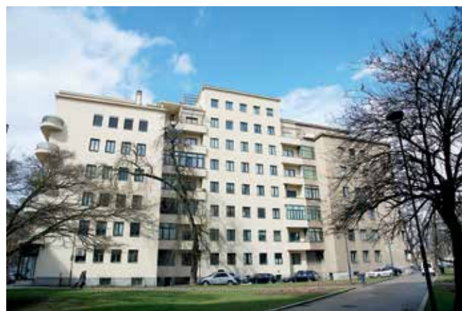
Ljubljana, Dukičevi bloki, detajl ulične fasade po obnovi (foto: M. Režek Kambič, 2017)
