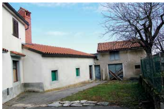
Škocjan pri Divači, domačija Škocjan 7 po namestitvi novega stavbnega pohištva, izdelani fasadi in odstranitvi dimnika (foto: E. Belingar, 2017)
