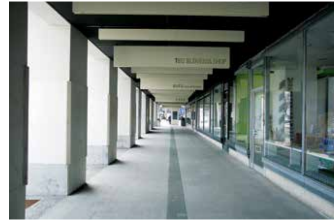
Ljubljana, del arkadnega hodnika Slovenska cesta 15 po prenovi z enotno zastavljenim sistemom oglaševanja dejavnosti, ki potekajo v arkadnih hodnikih (foto: M. Režek Kambič, 2017)
