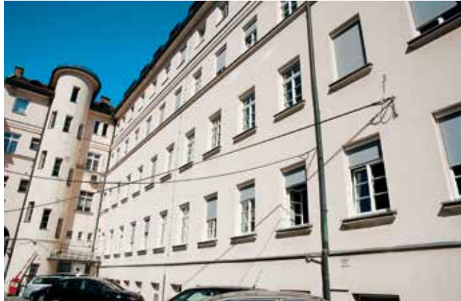
Ljubljana, palača Miklošičeva cesta 24, dvorišna fasada z novimi enojnimi okni (foto: M. Režek Kambič, 2017)
