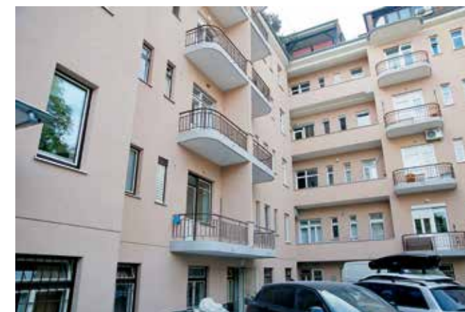
Ljubljana, stanovanjski blok Erjavčeva cesta 22, Prešernova cesta 17–19, dvoriščna fasada po obnovi (foto: M. Režek Kambič, 2017)
