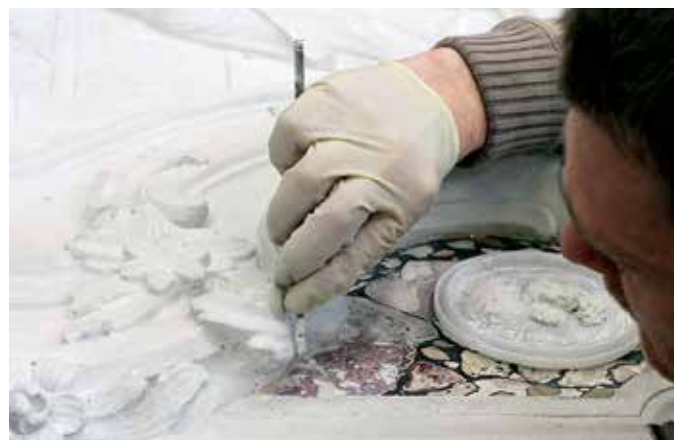
Piran, cerkev Marije Zdravja, dopolnjevanje manjših nepravilnosti na odlitku (foto: arhiv ZVKDS, RC)
