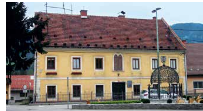
Muta, hiša Glavni trg 27 pred obnovo zunanjsčine (foto: L. Medved, april 2017)
