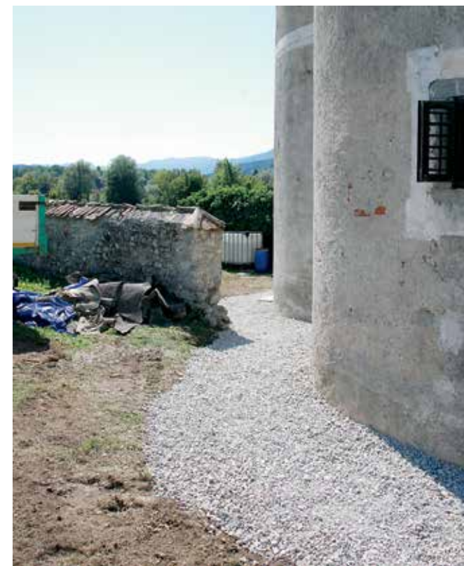
Soteska ob Krki, vrtni paviljon Hudičev turn, drenažno zasutje z dolomitnim drobljencem (foto: T. Mesojedec)
