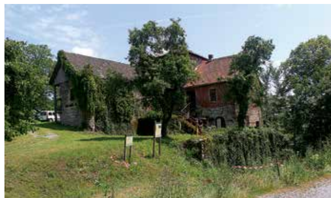
Vinica, pogled na zahodno fasado gradu Vinica pred obnovo (foto: Tomaž Golob, 2014)
