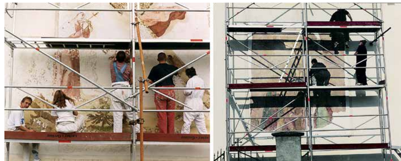
Kamna Gorica, cerkev Sv. trojice, restavriranje baročne poslikave in situ in montaža snete mlajše freske (foto: T. Benedik)
