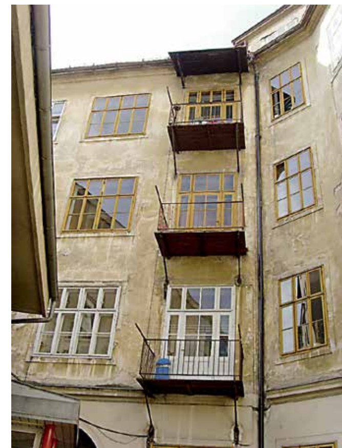
Ljubljana, hiša Gosposvetska cesta 4, dvoriščna fasada pred obnovo (M. Režek Kambič, 2013)
