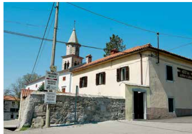
Lokev, zid po odstranitvi ometa in izvedbi ozkega fugiranja (foto: E. Belingar, 2018)
