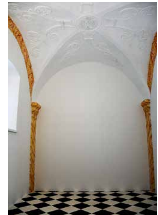
Celje, dvorec Zgornji Lanovž, restavrirana baročna kapela z rekonstruiranim tlakom (foto: Nataša Podkrižnik, 2018)
