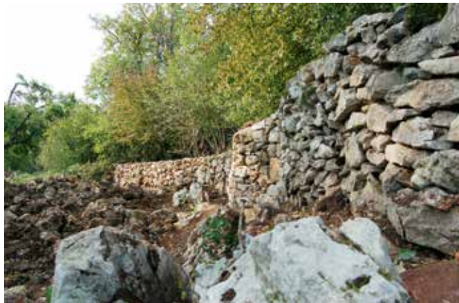
Dokončan mejni suhi zid ob hiši Matavun 3b (foto: E. Belingar, 2017)
