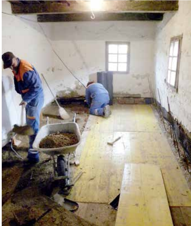
Dražen Vrh, prostor nekdanje shrambe v hiši Kaplove domačije med obnovo (foto: S. Vešligaj, februar 2017)
