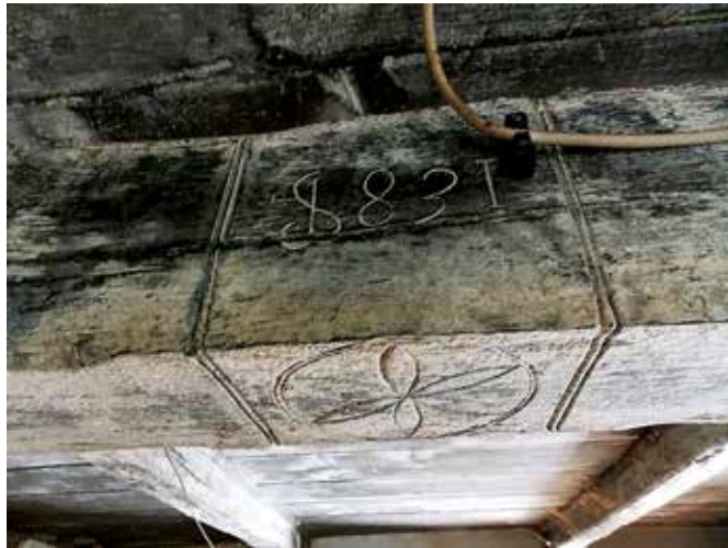
Nadole, domačija Pušnik, nosilni tram lesenega stropa z letnico 1831 in okrasno rozeto v hiši (foto: J. Skalicky, 2015)
