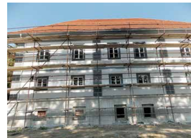
Celje, dvorec Zgornji Lanovž, potek prenove južne fasade (foto: Nataša Podkrižnik, 2017)
