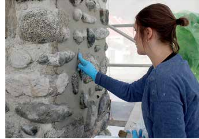
Črna na Koroškem, spomenik žrtvam prve in druge svetovne vojne, nadomeščanje poškodovane malte med prodniki (foto: arhiv ZVKDS, RC)
