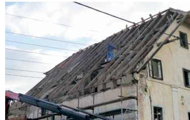
Zgornji Otok 6, zahodni del ostrešja med obnovo dotrajanih tramov (foto: M. Tercelj Otorepec, 2017)
