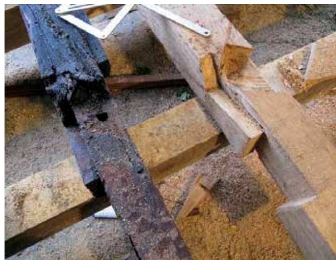
Breznica, Janšev čebelnjak, zamenjava dotrajanih delov (foto: J. Grmek, 2017)
