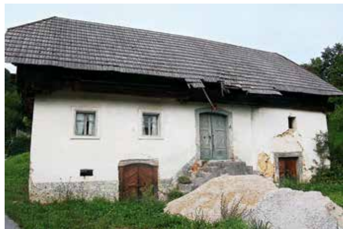
Peče, zahodna fasada Mejnikove hiše pred raziskavami (foto: M. Tercelj Otorepec, 2012)
