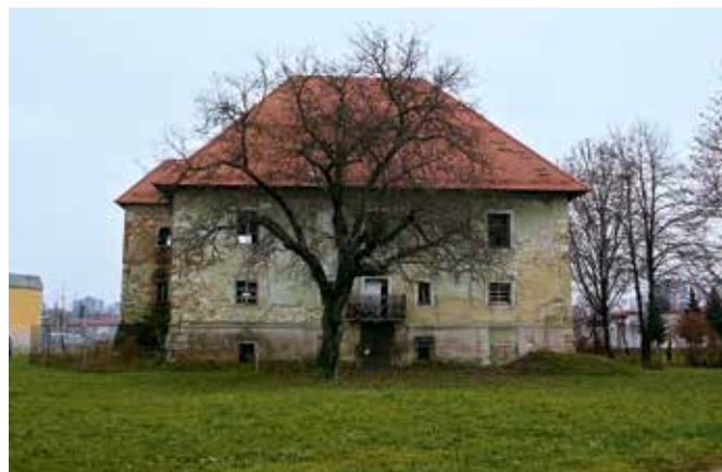
Celje, dvorec Zgornji Lanovž, stanje pred prenovo (foto: Nataša Podkrižnik, 2016)
