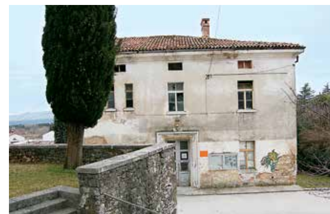
Komen, vhodna fasada, obrnjena k cerkvi (foto: E. Belingar, 2017)
