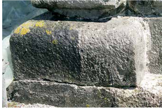
Soteska, Hudičev turn, površina kamna po visokotlačnem čiščenju z vodo (foto: K. Rus)
