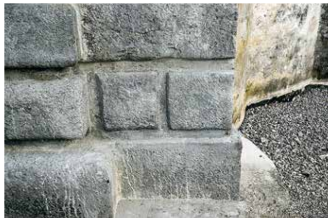
Soteska, Hudičev turn, površinsko obdelana in tonsko poenotena domodelacija kamna (foto: K. Rus)
