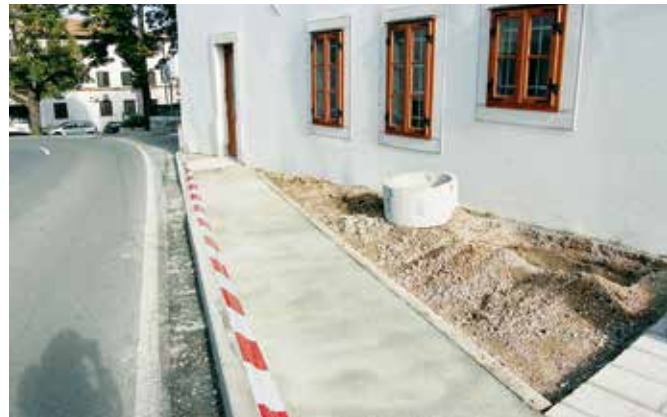
Lokev, urejanje okolice objekta (foto: E. Belingar, 2017)
