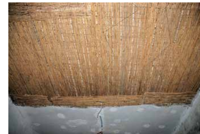
Ljubljana, nekdanji hotel Tivoli, t. i. Švicarija, vgradnja nove trstike na stropu nekdanje hotelske sobe (foto: T. Adamič)
