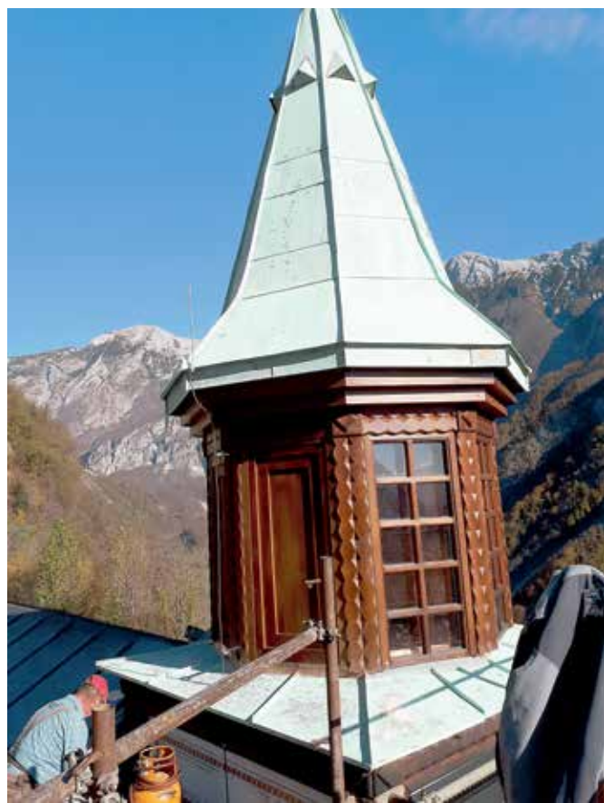
Javorca, spominska cerkev Svetega duha, obnovljen zvonik (foto: Metod Kavčič)
