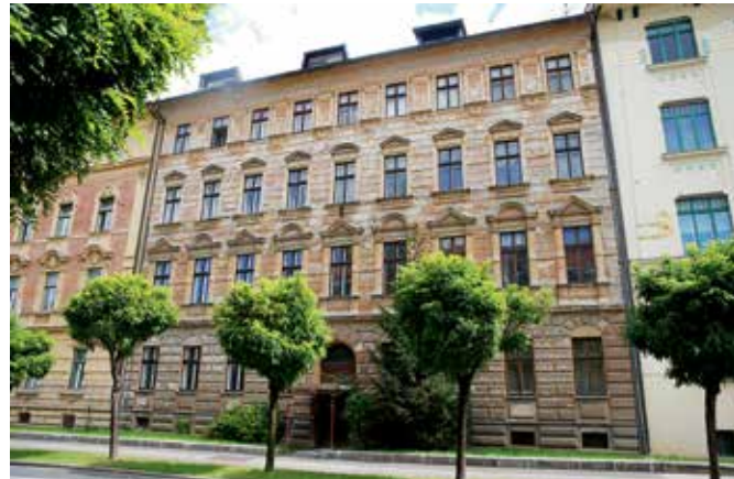
Ljubljana, hiša Prešernova cesta 16, ulična fasada pred obnovo (M. Režek Kambič, 2014)
