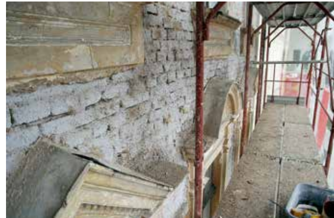
Ljubljana, hiša Prešernova cesta 16, fasada v fazi odbijanja nestabilnih ometov (foto: M. Režek Kambič, 2016)
