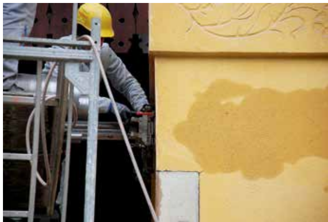
Ljubljana, nekdanji hotel Tivoli, t. i. Švicarija, izvedba vertikalnih in horizontalnih perfo sider (foto: T. Adamič)
