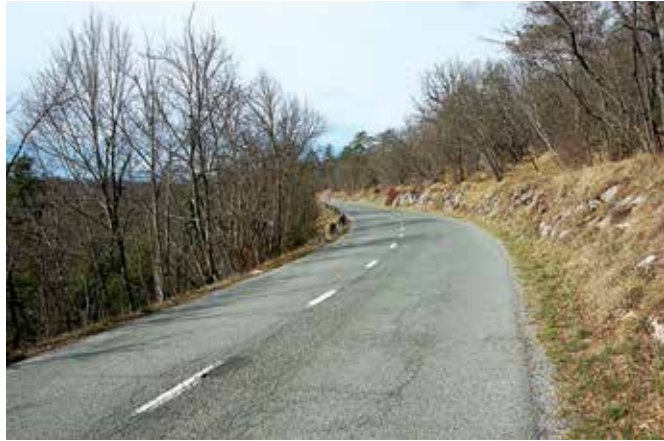
Matavun, cesta od matavunskega križišča do Matavuna. Mejni kamni so na tem odseku vgrajeni v vrh kamnitega podpornega zida (foto: E Belingar, 2017).
