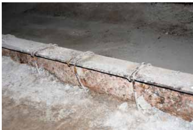
Ljubljana, nekdanji hotel Tivoli, t. i. Švicarija, vpenjanje armirano-betonske plošče na kovinske I-nosilce v severnem delu objekta (foto: T. Adamič)
