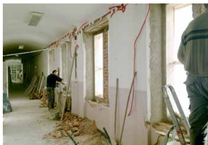
Ljubljana, palača Miklošičeva cesta 24, priprava okenskih odprtin za vgraditev okna po RAL smernicah (foto: M. Režek Kambič, 2016)
