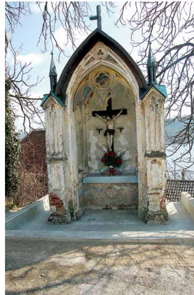
Planina, kapelica v Dolnji Planini, plato omogoča odvodnjavanje padavinske vode s ceste mimo kapelice (foto: E. Belingar, 2016).
