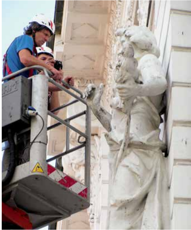
Ljubljana, Mestna hranilnica, preverjanje stanja figur, dokumentiranje in sondiranje z dvizne košare (foto: arhiv ZVKDS, RC)
