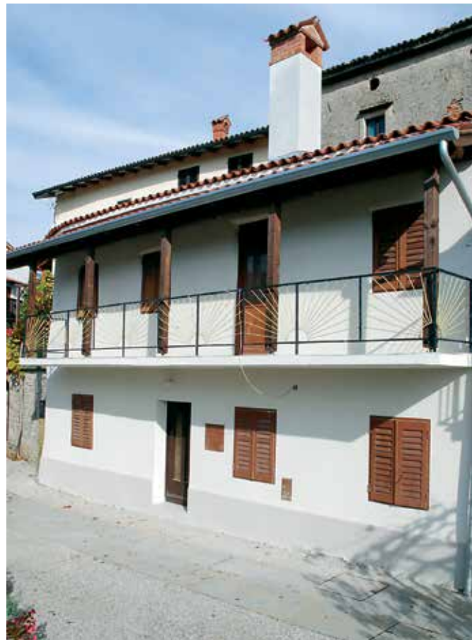
Vipavski Križ, hiša št. 46 po obnovi (foto: A. Ščukovt, 2017)
