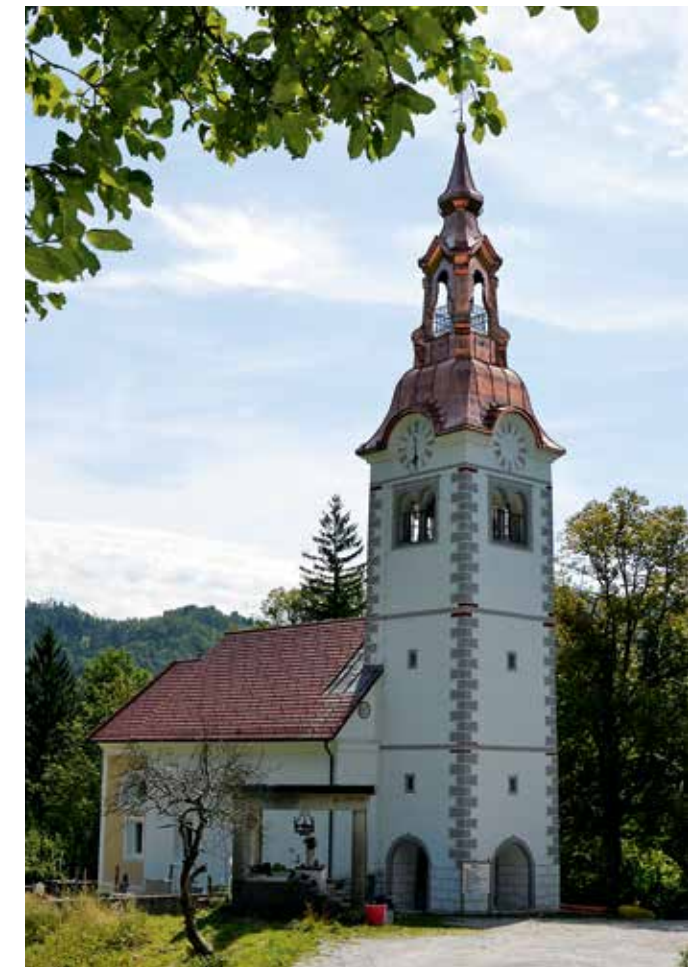
Orehok pri Cerknem, cerkev sv. Ubalda, zunanjščina po obnovi z rekonstruirano arhitekturno poslikavo zvonika (foto: Marta Bensa)
