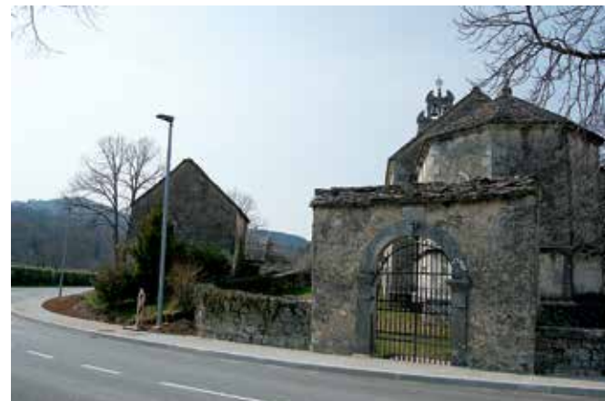
Šmarje pri Sežani, cesta po zaključku del (foto: E. Belingar, 2018)
