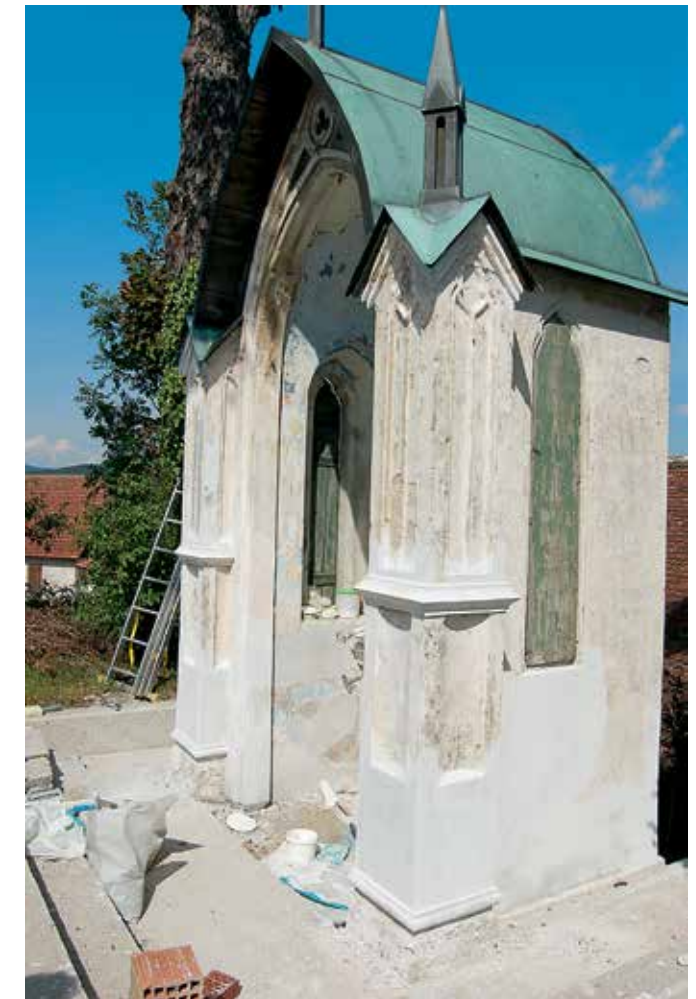
Planina, kapelica v Dolnji Planini, po domodelaciji ometov na zunanjsčini. Na spodnji del baz je bil nanesen sušilni omet (foto: E. Belingar, 2017).
