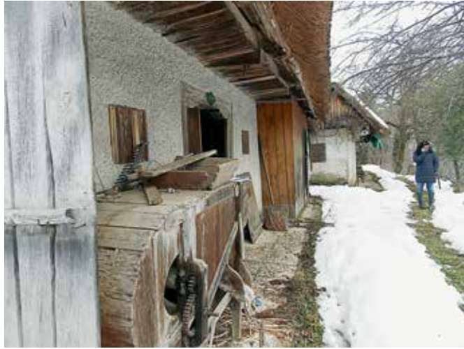
Nadole, domača Pušnik, vinska klet in del hiše pred obnovo (foto: J. Skalicky, 2015)
