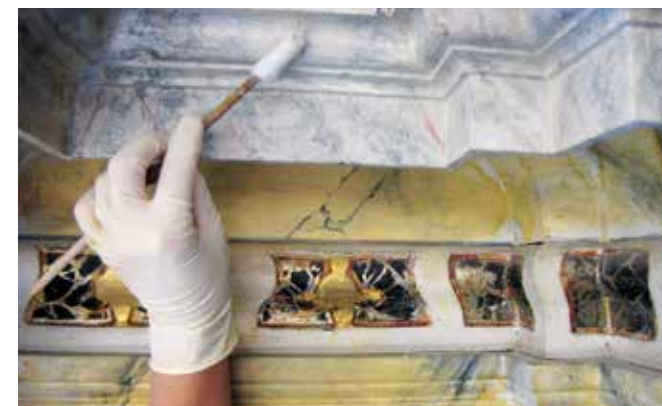
Vrzenec, podružnična cerkev sv. Kancijana, odstranjevanje porumenelega laka in preslikave s topli (foto: Frančiška Oražem, 2017)
