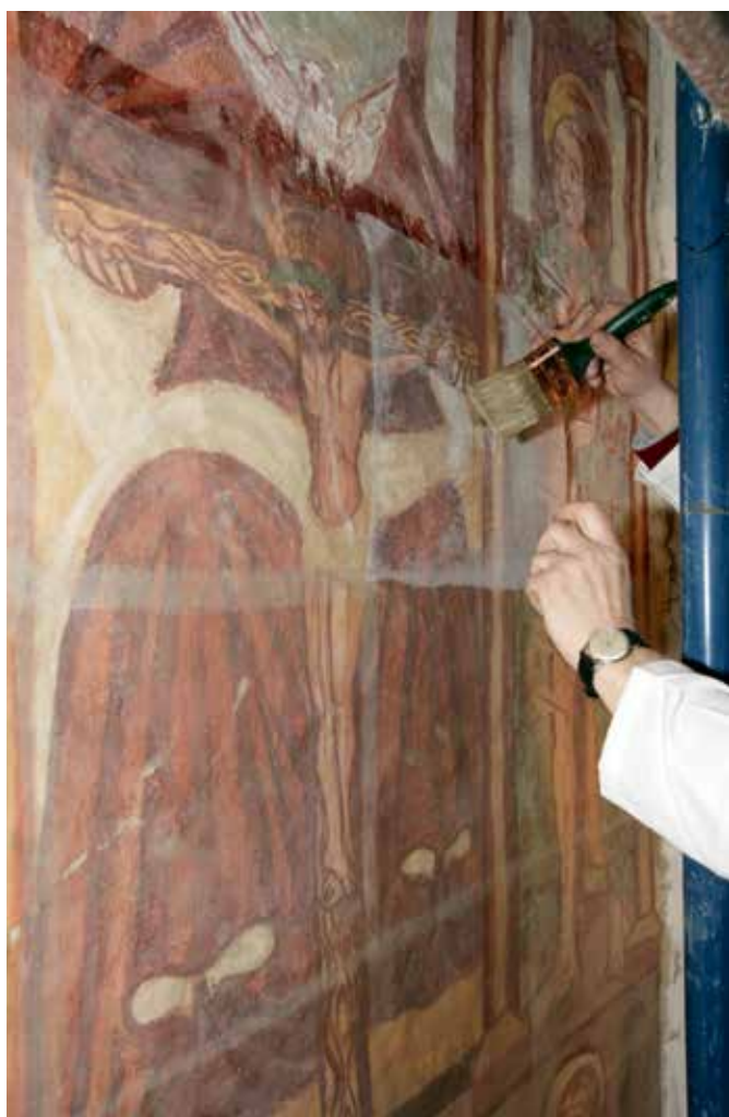
Bovec, cerkev Device Marije v Polju, nanašanje začasne (klejne) armature na originalno poslikavo (foto: V. Benedik)
