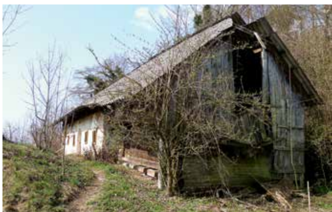
Kamnik, hiša Novi trg 5 pred obnovitvenimi posegi (foto: M. Tercej Otorepec)
