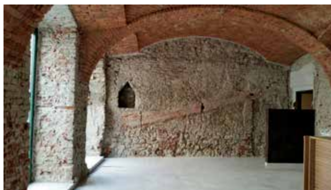
Ptuj, hiša Murkova ulica 5 med obnovo (foto: N. Nylaander)
