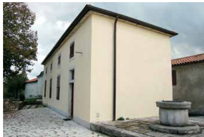
Škocjan pri Divači, hiša Škocjan 8, stavba po prekritju strehe ter barvanju pročelij (foto: E. Belingar, 2015)
