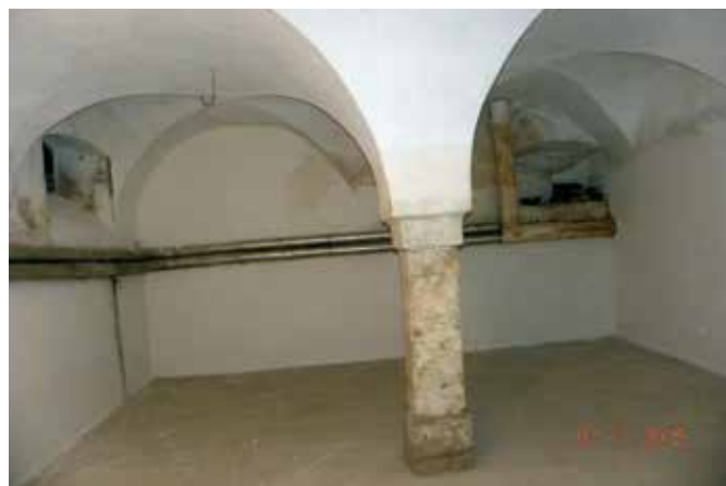
Poljane nad Škofjo Loko, Gostilna na Vidmu, obnovljen prostor z novimi stenski ometi (foto: D. Pediček, 2015)
