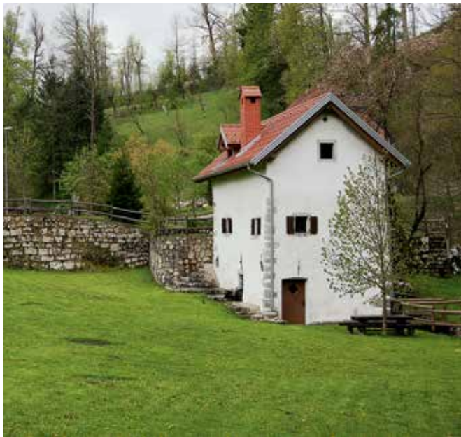
Predjama, grajski mlin, poslopje po prekritju strehe (foto: E. Belingar, 2017)
