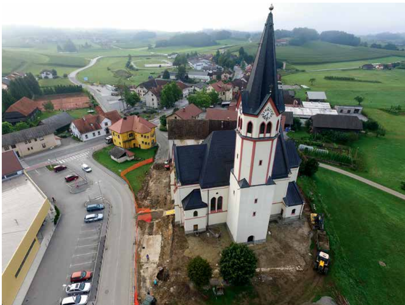
Mirna Peč, cerkev sv. Kancijana z okolico med arheološkim dokumentiranjem ob gradnji. Na fotografiji je vidno taborsko obzidje (foto: skupina Magelan, d. o. o.).
