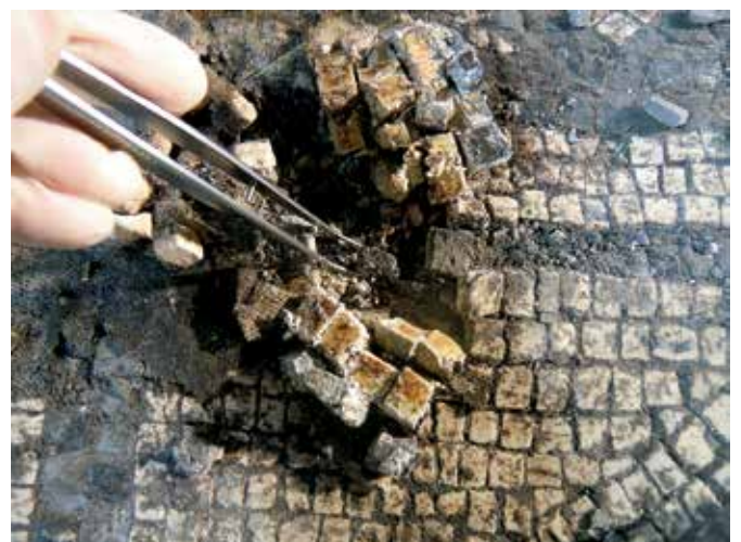
Celje, Glavni trg, ravnanje dvignjenih delov in umeščanje dislociranih teser, 2016 (foto: K. Žagar)
