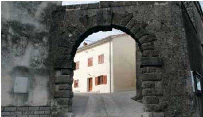
Vipavski Križ, severna mestna vrata pred obnovo (foto: A. Ščukovt, 2015)
