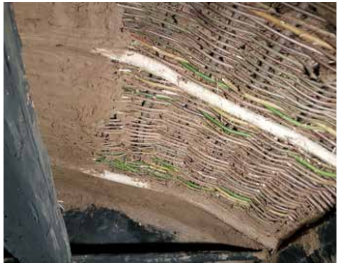
Rogatec, muzej na prostem, glinen sloj nad prepletom (foto: B. Hostnik, 2016)
