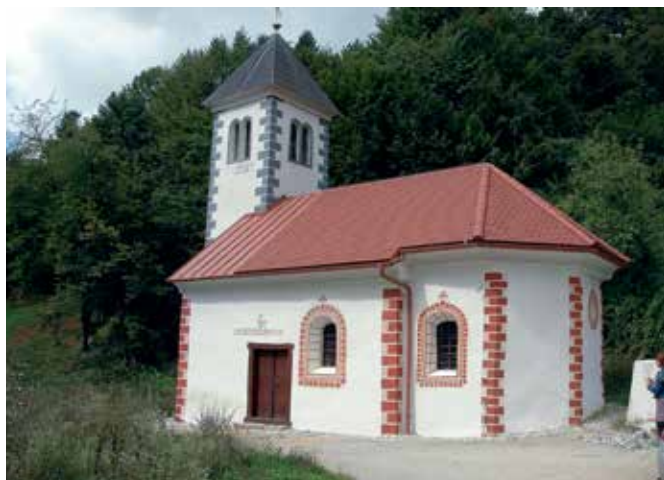
Šmaver pri Dobrniču, cerkev sv. Mavricija, po dokončanih restavratorskih delih na fasadi leta 2014 (foto: T. Mesojedec)
