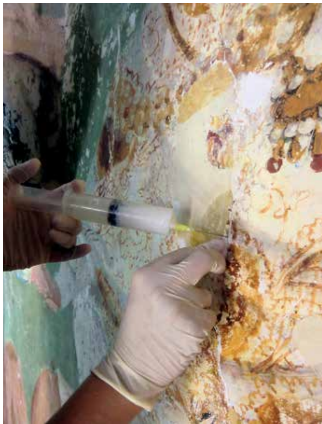
Črna pri Kamniku, cerkev sv. Primoža in Felicijana, injektiranje skozi obstoječe razpoke ob eni izmed starejših plomb (foto: A. Mladenovič)
