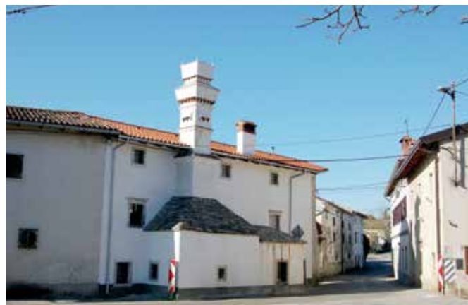
Kobdilj 9, obnovljene strehe in dimnik (foto: E. Belingar, 2017)
