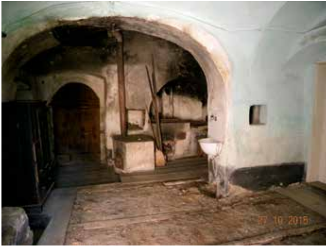
Dol pri Medvodah, Dolinčkova domačija, odstranjena montažna stena med vežo in kuhinjo ter podnice (foto: D. Pediček, 2015)
