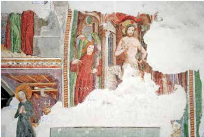
Bled, cerkev Marijinega vnebovzetja, detajl severne stene pred posegi (foto: T. Benedik)
