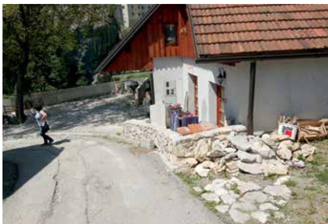
Predjama, domačija Predjama 3, urejanje dvorišča in podpornega zidu (foto: E. Belingar, 2015)
