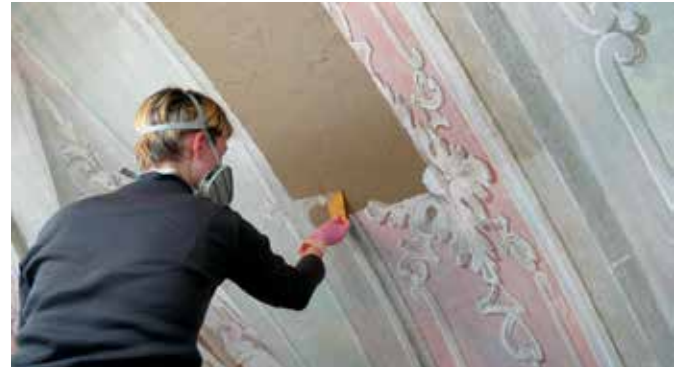
Škofja Loka, grad, kemijsko odstranjevanje nečistoč z nanašanjem oblog iz triamonijevega citrata in EDTA (foto: Anita Kavčič Klančar, arhiv ZVKDS, RC)
