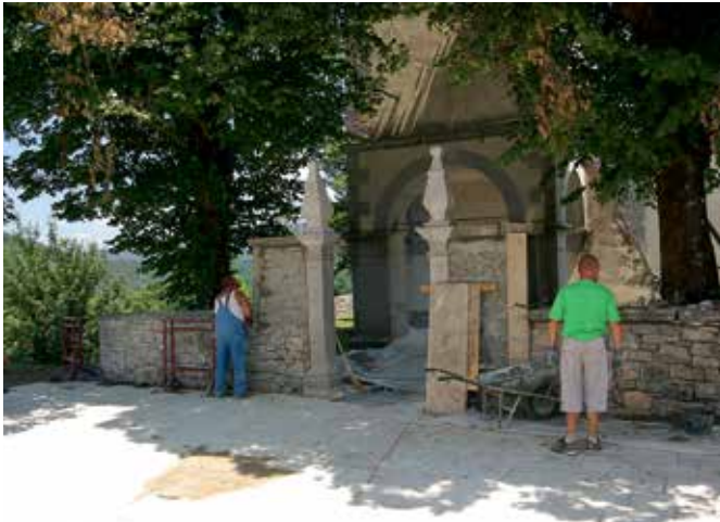
Škocjan pri Divači, ponovno pozidavanje dela kamnitega zidu pri cerkvi po namestitvi že restavriranih pilastrov (foto: E. Belingar, 2015)
