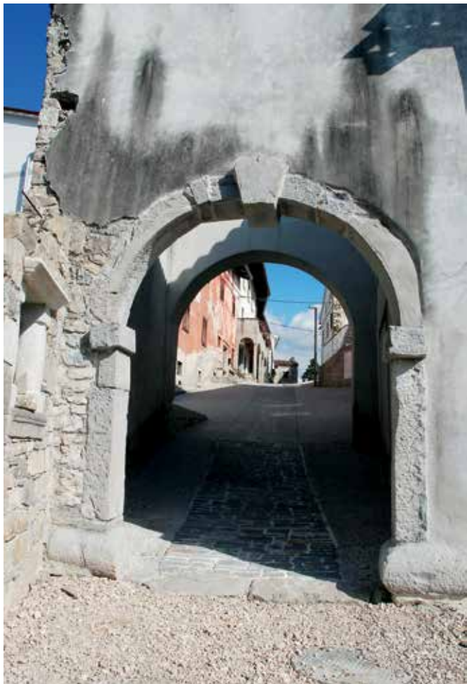
Vipavski Križ, južna vrata po obnovi (foto; A. Ščukovt, 2015)
