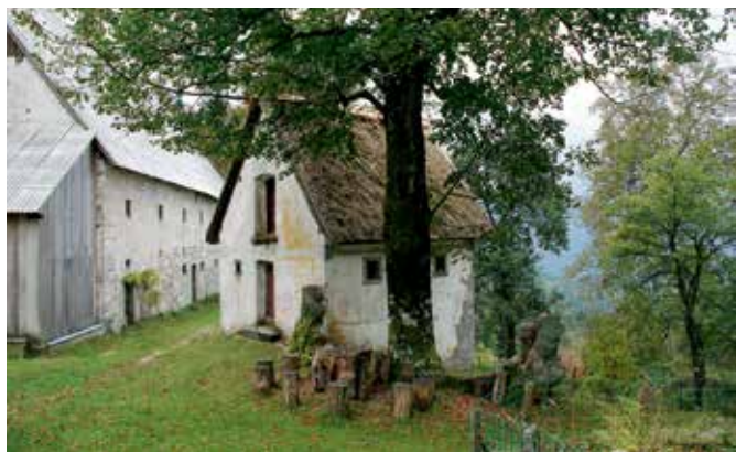
Gorenja Trebuša 89, kašča s kovačijo, pogled na dotrajano slamnato kritino (foto: A. Ščukovt, 2011)
