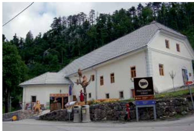
Predjama, domačija Predjama 13, domačija po dokončanih obnovitvenih delih gospodarskega dela in odprtju muzeja (foto: E. Belingar, 2016)
