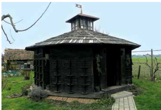
Veržej, Tigelijev čebelnjak pred prenovi skodlaste strehe (foto: S. Vešligaj, marec 2014)
