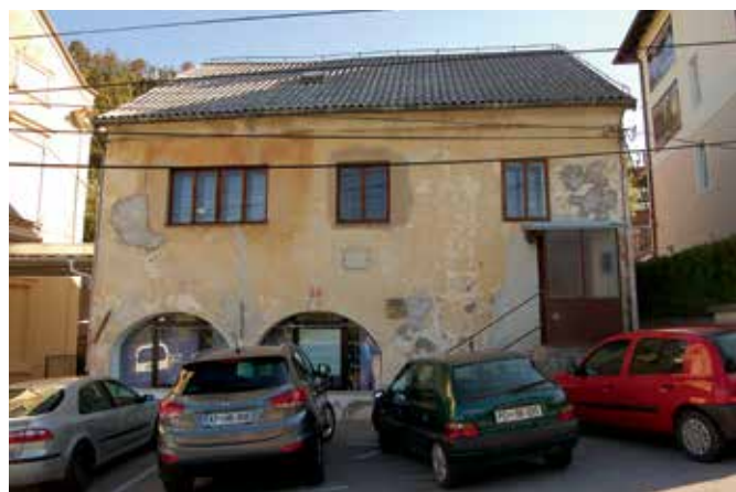
Postojna, stavba stare bolnišnice po prekritju strehe in namestitvi novega stavbnega pohištva v nadstropju (foto: E. Belingar, 2016)
