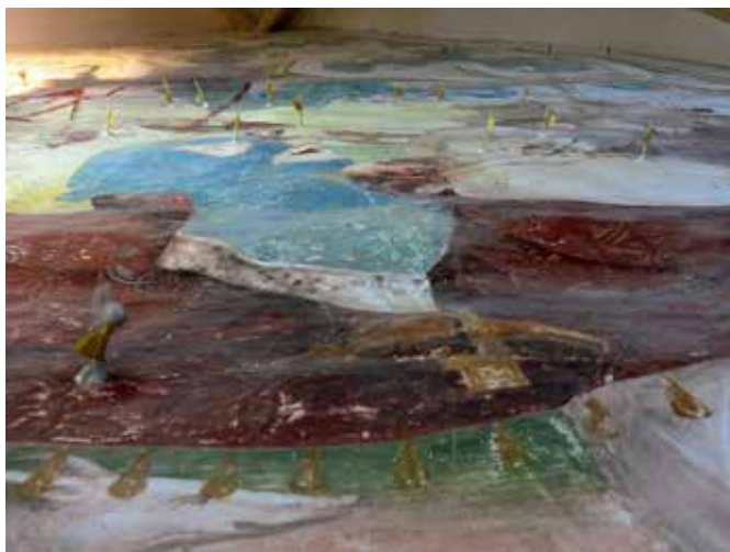
Črna pri Kamniku, cerkev sv. Primoža in Felicijana, severna stena ladje pred posegom – opazno prašna površina in injektirne cevke starejšega posega (foto: A. Mladenovič)
