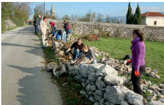
Škocjan pri Divači, rušenje dotrajanega zidu in priprava terena za ponovno pozidavo (foto: E Belingar, 2016)
