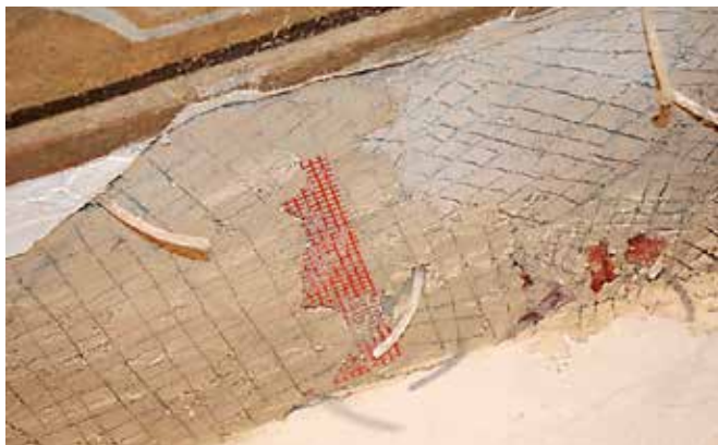
Novo mesto, cerkev sv. Lenarta, rekonstrukcija apnenih ometov (foto: T. Mesojedec)
