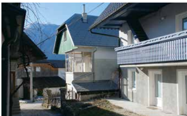
Bovec, hiša Klanc 20 po statični sanaciji (foto: A. Ščukovt, 2017)
