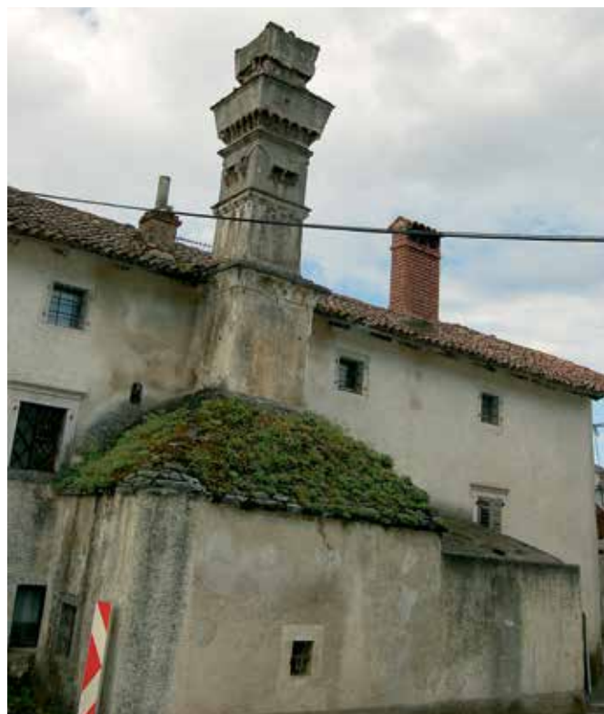
Kobdilj 9, domačija pred rekonstrukcijo streh in obnovo dimnika (foto: E. Belingar, 2013)
