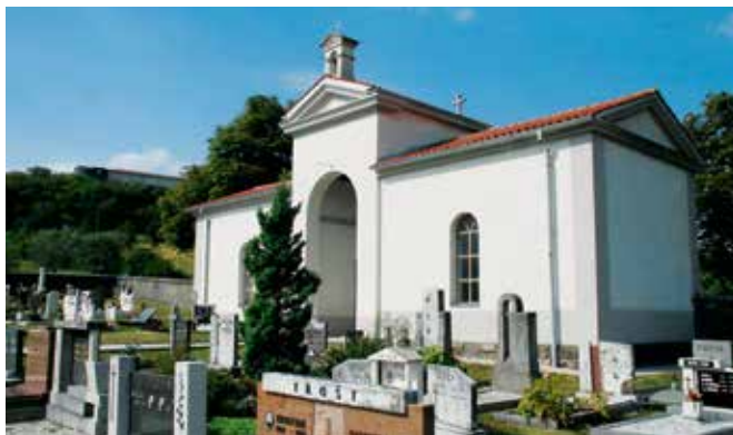
Vipavski Križ, pokopališka kapela z vežico po obnovi (foto: A. Ščukovt, 2016)
