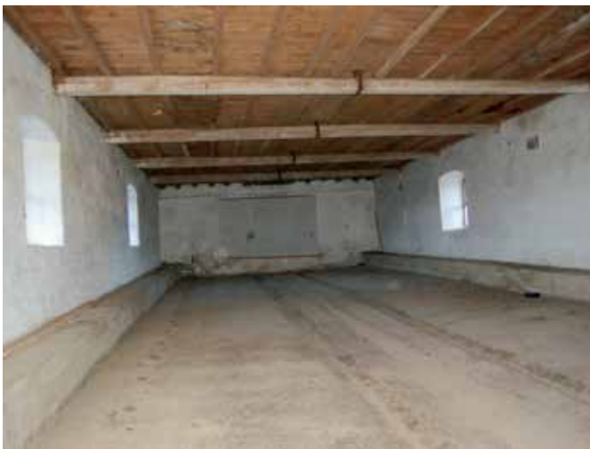
Žeje pri Prestranku, posestvo Bile, notranjost hleva pred obnovo (foto: E. Belingar, 2012)
