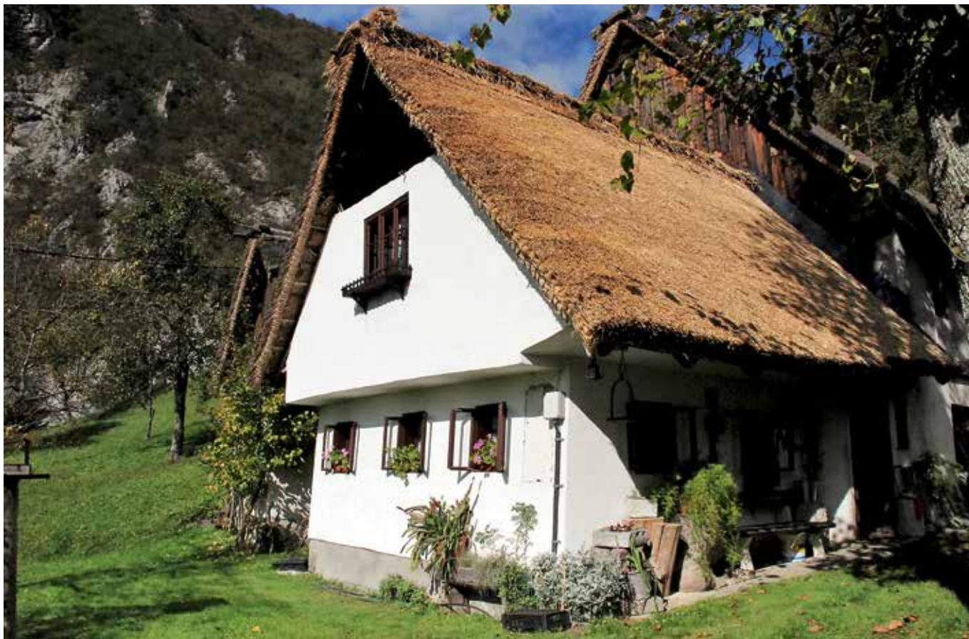
Dolenji Novaki, domačija Dolenji Novaki 5 po zamenjavi slamnate kritine (foto: A. Ščukovt, 2016)
