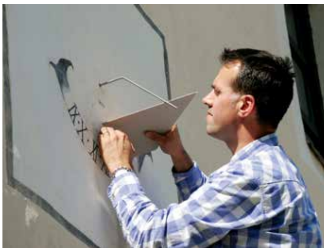
Trebnje, cerkev Marijinega vnebovzvetja, montaža kovinskega kazalca (foto: T. Mesojedec)
