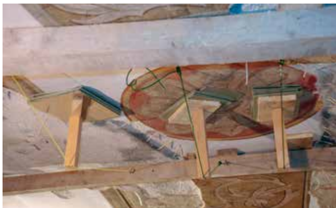
Novo mesto, cerkev sv. Lenarta, nekonstrukcijsko injektiranje ometov (foto: T. Mesojedec)
