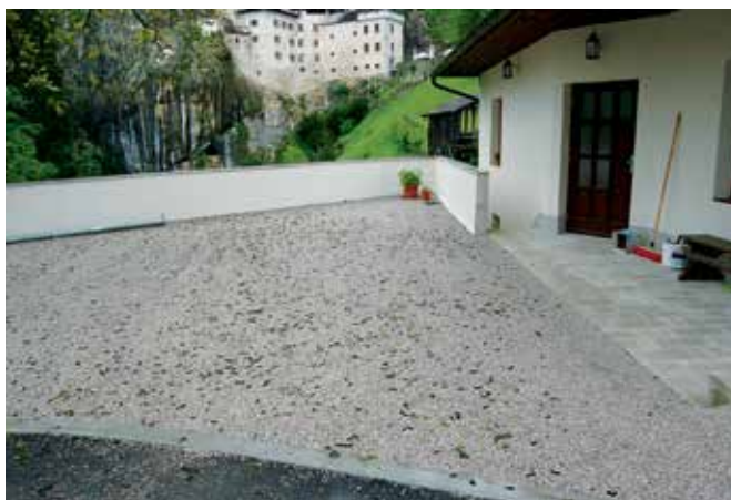
Predjama, domačija Predjama 3, dvorišče in ograja dvorišča po zaključku del (foto: E. Belingar, 2016)
