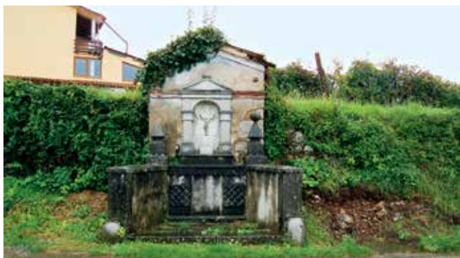
Kopriva, pil pri Krepah pred pričetkom del (foto: E. Belingar, 2014)
