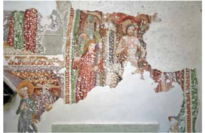
Bled, cerkev Marijinega vnebovzetja, detajl severne stene med posegi – zakitane naključvanine (foto: J. Kuret)
