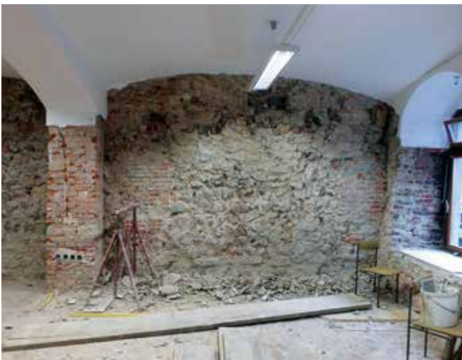
Ptuj, hiša Murkova ulica 7, pritlični prostor med posegi (foto: Beno Korošec)
