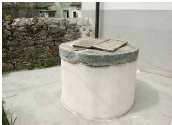
Matavun 7, obnovljen vodnjak (foto: E. Belingar, 2017)
