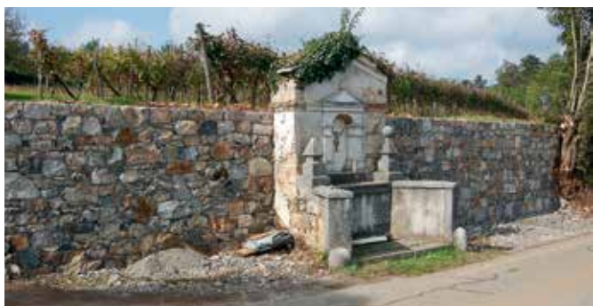
Kopriva; domačini so dela nadaljevali na znamenju. Odstranjen je bil omet, očiščeni, restavrirani in domodelirani so bili kamniti detajli (foto: E. Belingar, 2015).
