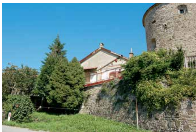
Prem, hiša po pričetku obnove v letu 2015, ko so že odstranili prizidek (foto: E. Belingar, 2015)
