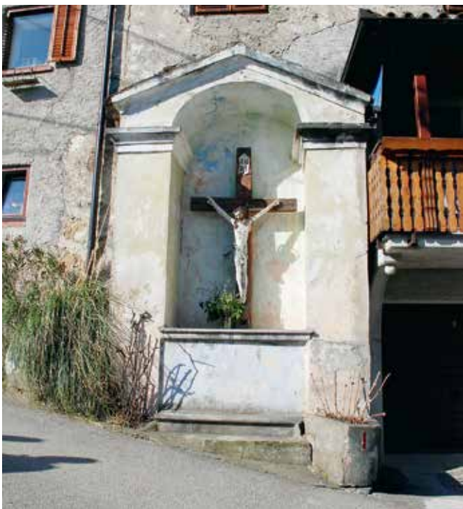
Velike Žablje, Douganova kapelica pred obnovo (foto: A. Ščukovt, 2015)
