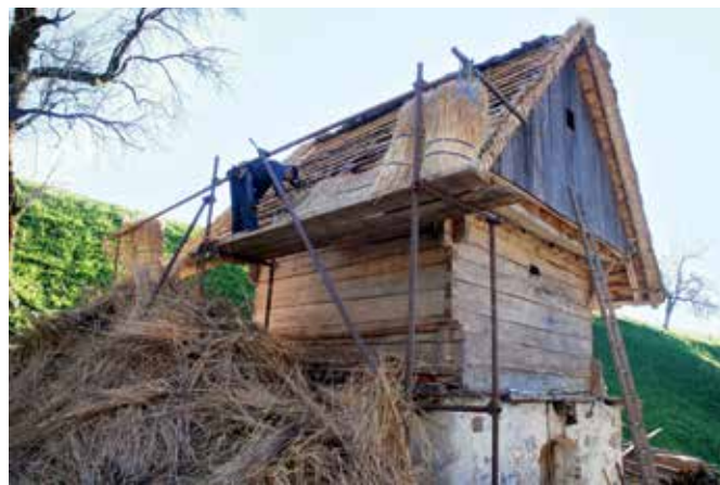
Podmelec, kašča pri hiši 49 med prekrivanjem strehe s slamo (foto: A. Ščukovt, 2015)
