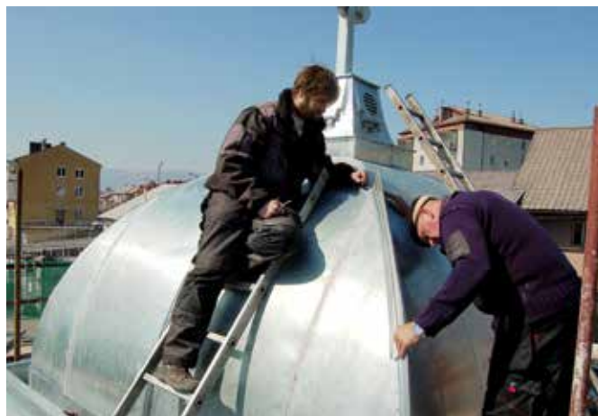
Postojna, grobnica rodbine Jurca, prekrivanje strehe s pločevino (foto: E. Belingar, 2016)
