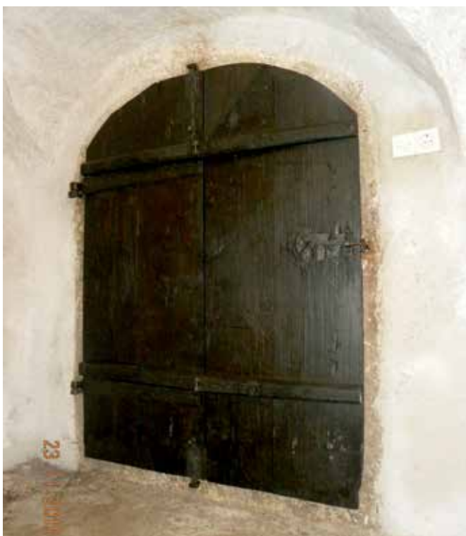
Puštal, domačija Puštal 74, vrata po obnovi (foto: D. Pediček, 2015)
