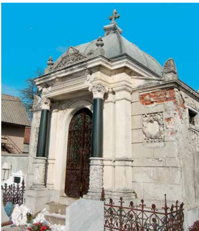
Postojna, grobnica rodbine Jurca pred obnovo (foto: E. Belingar, 2012)
