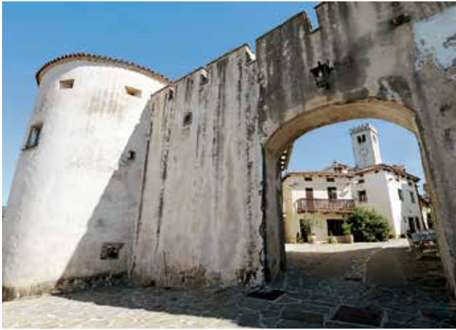
Šmartno v Brdih, zahodno obzidje pred obnovo (foto: A. Ščukovt, 2012)
