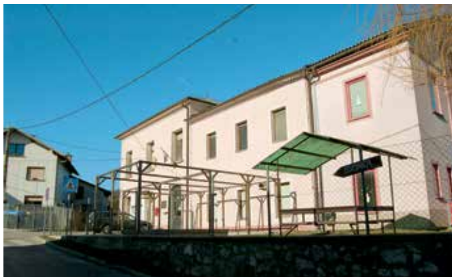
Pivka, Pot na Orlek 2, stavba vrtca pred energetska sanacijo (foto: E. Belingar, 2012)
