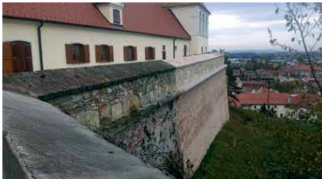
Ptuj, grad, obzidje po rekonstrukciji (foto: M. Ježovnik)
