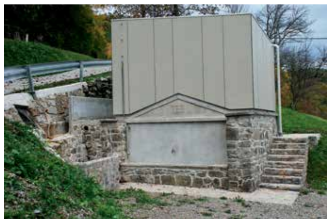
Čolnica, vodni zbiralnik po obnovi (foto: A. Ščukovt, 2016)
