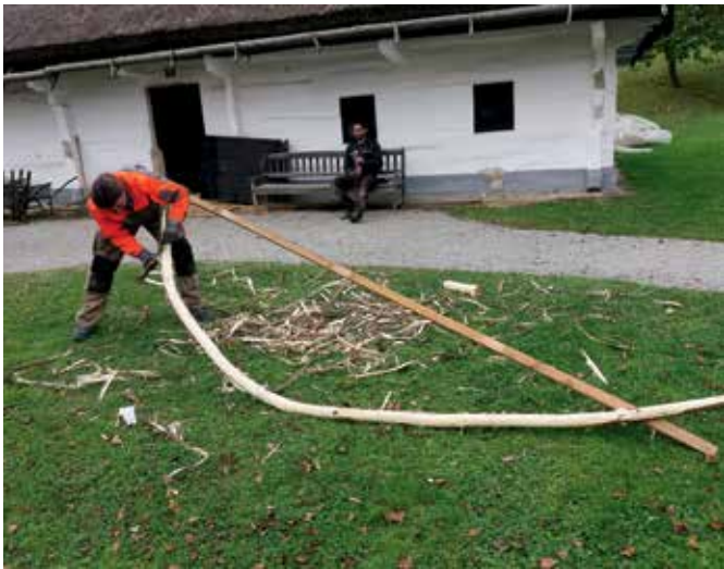
Rogatec, muzej na prostem, osnovno ogrodje za gradnjo oboka (foto: B. Hostnik, 2016)
