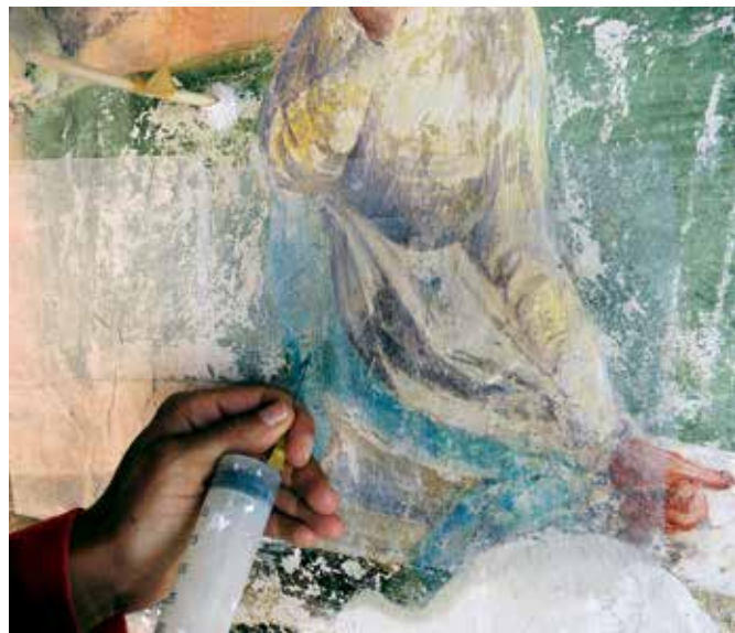
Črna pri Kamniku, cerkev sv. Primoža in Felicijana; zelo tanke plasti ometa in ozke razplastitve so bile injektirane z disperzijo CaLoSiL® (foto: A. Mladenovič).
