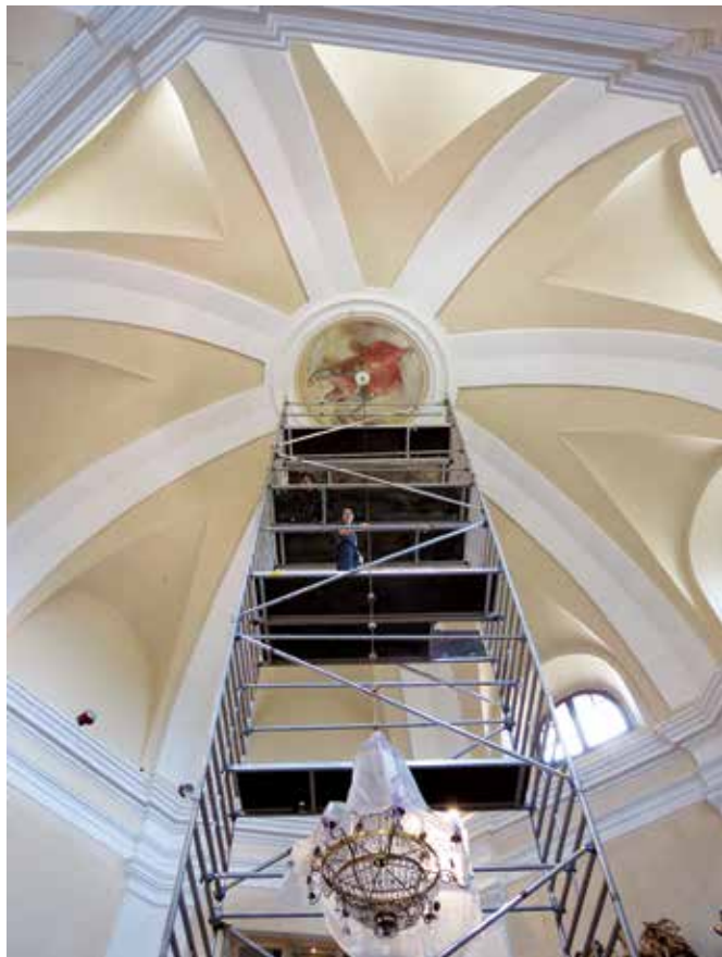
Škofja Loka, grad, postavev začasnega premičnega odra ob sondiranju poslikav v kapeli (foto: A. Kavčič Klančar, arhiv ZVKDS, RC)
