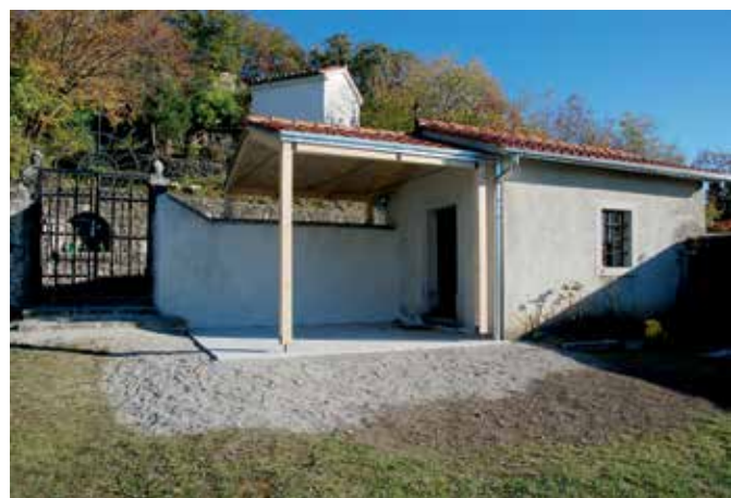
Erzelj, mrliška vežica na pokopališču po obnovi (foto: A. Ščukovt, 2015)
