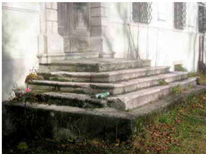
Visoko pri Poljanah, dvorec Visoko, vhodno stopnišče pred posegi (foto: D. Pediček, 2007)
