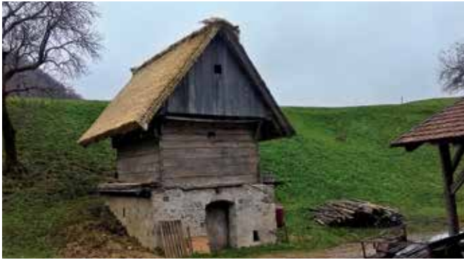
Podmelec, kašča pri hiši 49 po obnovi slamnate strehe (foto: A. Ščukovt, 2015)
