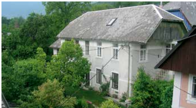
Bovec, hiša Klanc 20 pred obnovo (foto: M. Mihelič, Bovec, 2006)
