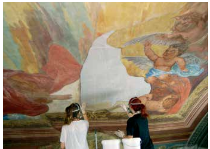
Ljubljana, cerkev Marijinega oznanjenja, nanašanje oblog amonijevega karbonata; odstranjevanje plesni, čiščenje in utrjevanje barvne površine (foto: M. Lesar Kikelj, arhiv RC ZVKDS)
