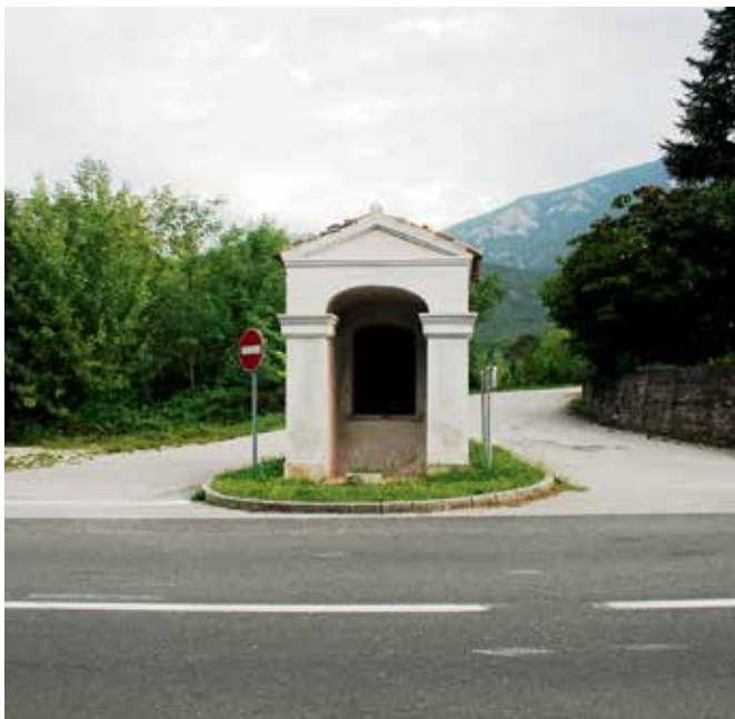
Črniče, kapelica pred obnovo (foto: A. Ščukovt, 2015)
