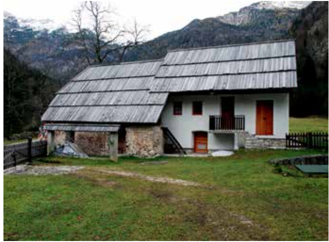
Trenta, zaselek Pri Cerкви, hiša 65a po obnovi (foto: A. Ščukovt, 2016)
