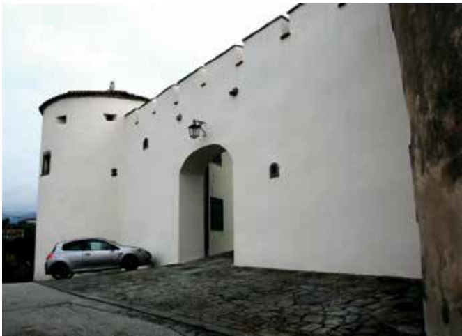
Šmartno v Brdih, zahodno obzidje po obnovi (foto: A. Ščukovt, 2016)
