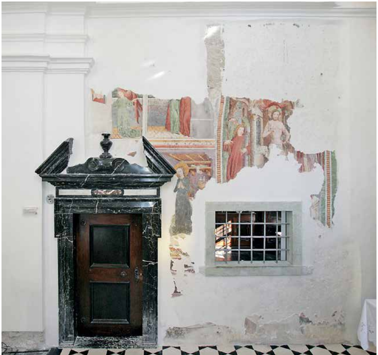
Bled, cerkev Marijinega vnebovzetja, severna stena po posegih (foto: T. Benedik)
