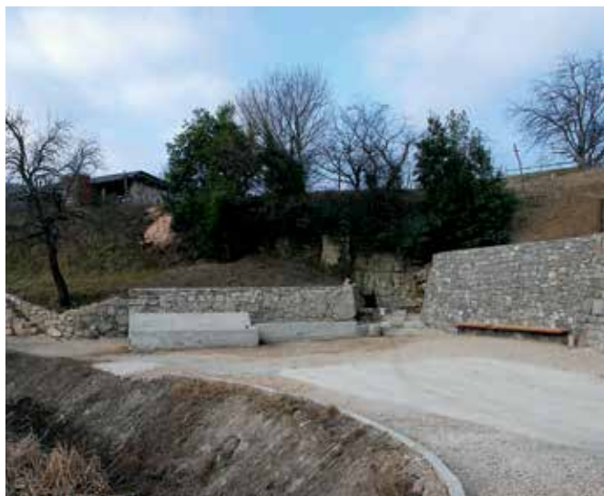
Ravnica, korita in kal na vodi po obnovi (foto: A. Ščukovt, 2016)
