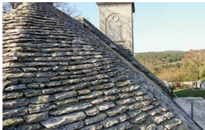
Dolenja vas pri Senožečah, cerkev Žalostne Matere božje, pogled na obnovljeno streho prezbiterijskega s sanirano obrobo na stiku s streho ladje (foto: M. Osojnik)
