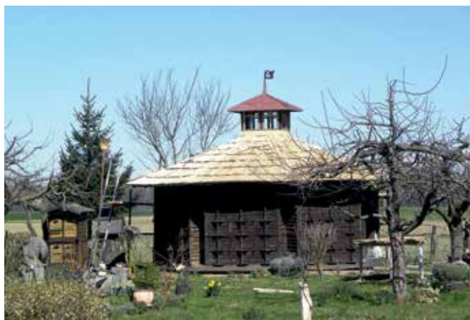
Veržej, Tigelijev čebelnjak po prenovi skodlaste strehe (foto: S. Vešligaj, marec 2014)
