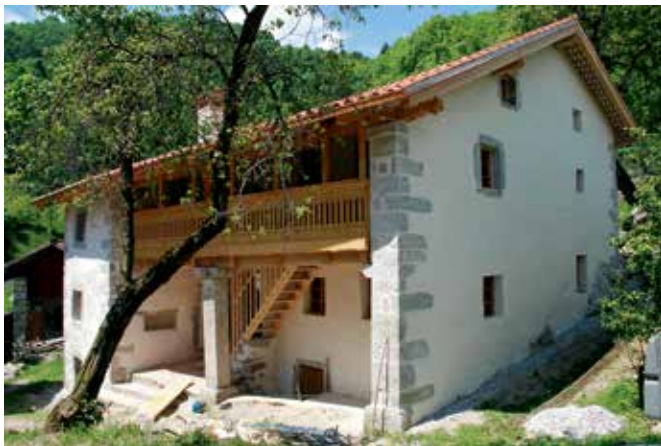
Jevšček, hiša pri Cendolu po obnovi (foto: A. Ščukovt, 2015)
