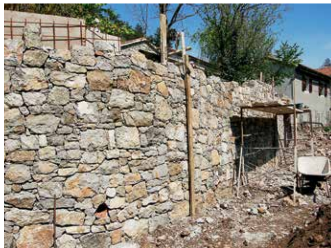
Betanja 5, gradnja podpornega zidu na domačiji (foto: E. Belingar, 2015)
