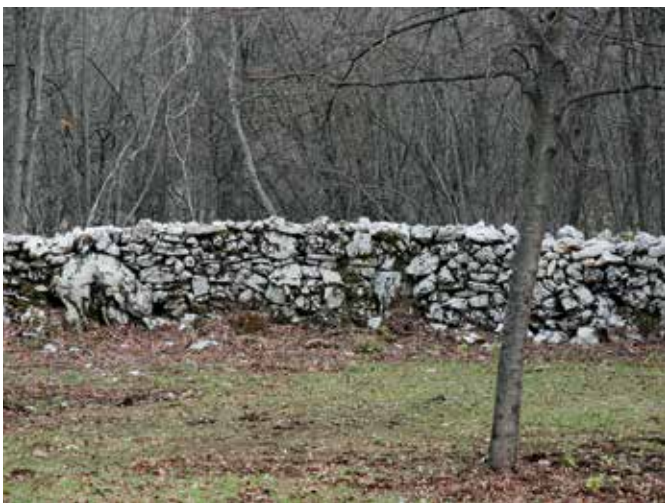
Kobilarna Lipica, saniran suhi zid (foto: M. Lah)
