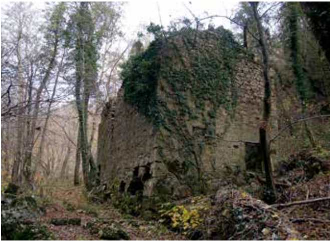
Škocjan pri Divači, ruševine mlina v Uknah pred pričetkom del (foto: E. Belingar, 2015)
