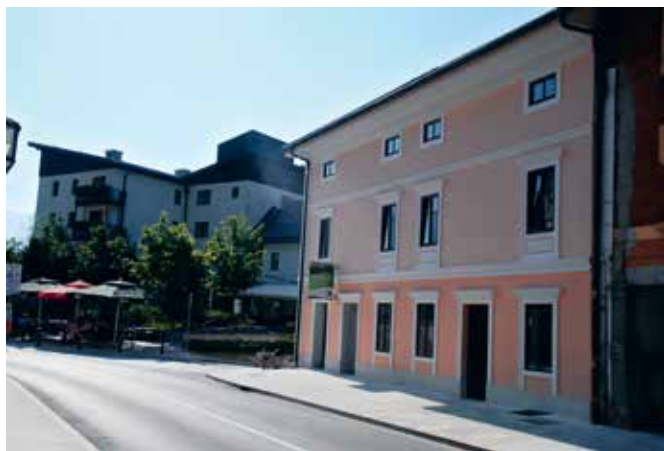
Bovec, Trg golobarskih žrtev 49 po celoviti popotresni sanaciji (foto: A. Ščukovt, 2016)
