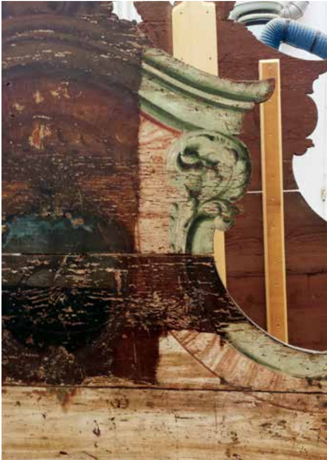
Koper, Palača Kidričeva ulica 19, odstranjevanje filmotvornih premazov, detajl naslonjala klopi (foto: S. Dolinšek)
