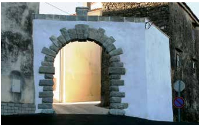
Vipavski Križ, severna mestna vrata po obnovi (foto: A. Ščukovt, 2015)
