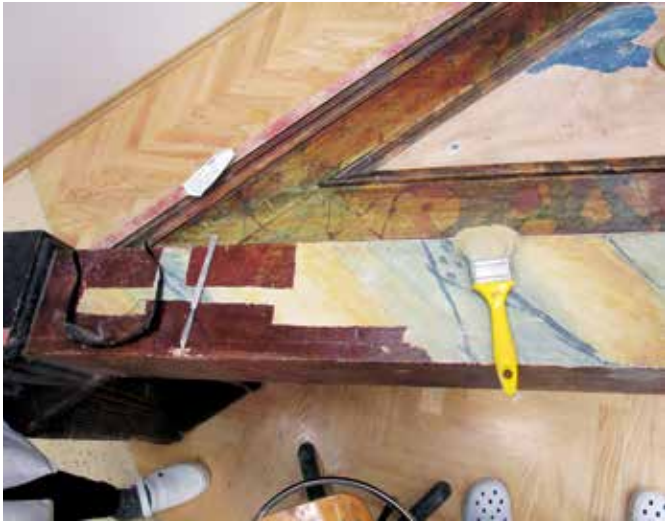
Bled, cerkev Marijinega Vnebovzetja, odstranjevanje filmotvornih materialov, detajl stopnišča prižnice (foto: L. Deisinger)
