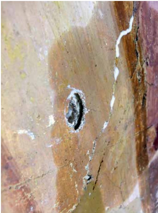
Črna pri Kamniku, cerkev sv. Primoža in Felicijana; votla mesta med plastmi ometov so bila zapolnjena z injekcijsko maso CalXnova (foto: A. Mladenovič).
