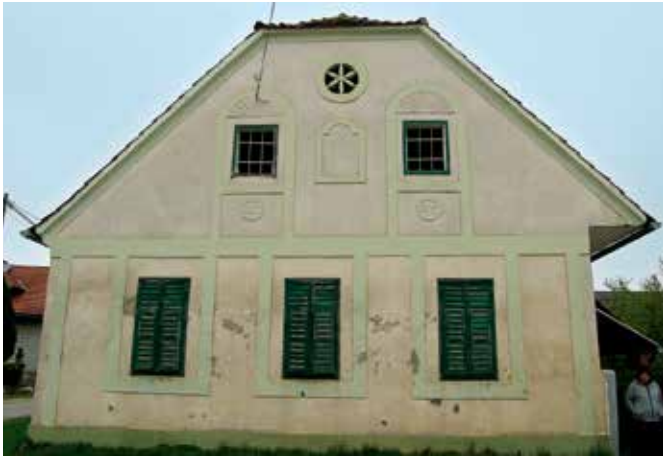
Krapje, domačija Babič, zahodno pročelje pred obnovo (foto: S. Vešligaj, april 2008)
