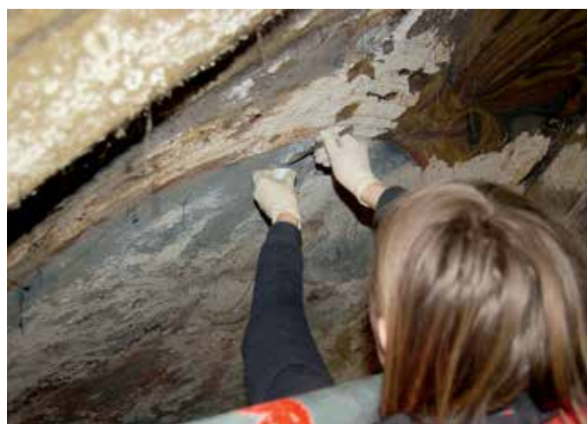
Ljubljana, cerkev Marijinega oznanjenja, preliminarnе raziskave v letu 2012; odvzem vzorcev, poskusi občutljivosti pigmentov na vodo (foto: Saša Snoj, arhiv RC ZVKDS)
