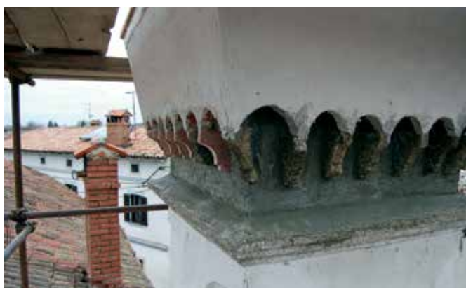
Kobdilj 9, na dimniku so bili vsi poškodovani ali uničeni elementi po zgledu ohranjenih izvedeni na novo (foto: E. Belingar, 2015).
