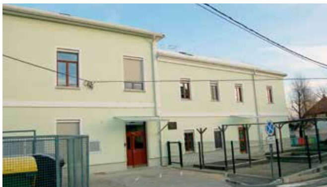
Pivka, Pot na Orlek 2, po izvedbi sanacijskih del (foto: E. Belingar, 2016)
