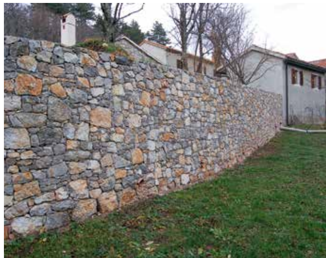
Betanja 5, podporni zid po zaključku del (foto: E. Belingar, 2015)
