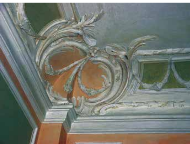
Ljubljana, Arhiv Slovenije, štukature v predsobi po končanem konservatorsko-restavratorskem posegu (foto: K. Zalar)
