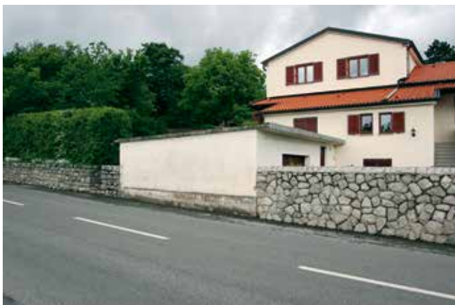
Matavun, na garaži hiše Matavun 1 so popravili streho, ki je bila dotrajana in je zamakala, obnovili fasado in izvedli mejni zid (foto: E. Belingar, 2013).
