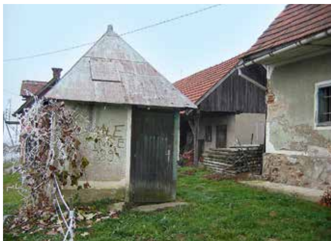
Kremberk 39, viničarija Pergarjev vrh, stavbe pred obnovo (foto: J. Skalicky, 2011)
