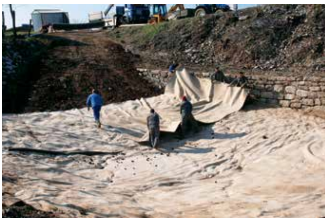
Lokvica, polaganje bentonita na dno kala, 2013 (foto: A. Ščukovt)
