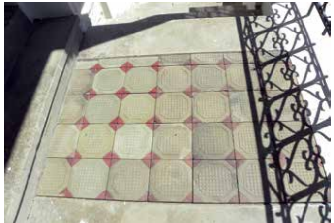
Lukavci, podest stebričastega stopnišča Muršičeve hiše (foto: S. Vešligaj, julij 2013)
