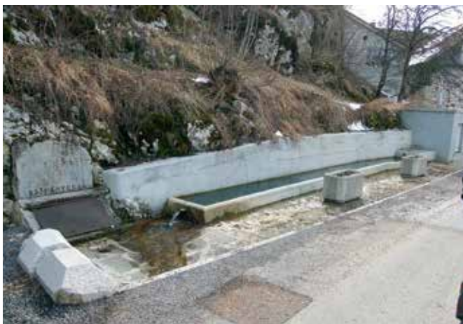
Belsko, Korito 1 pred obnovitvenimi posegi (foto: E. Belingar)
