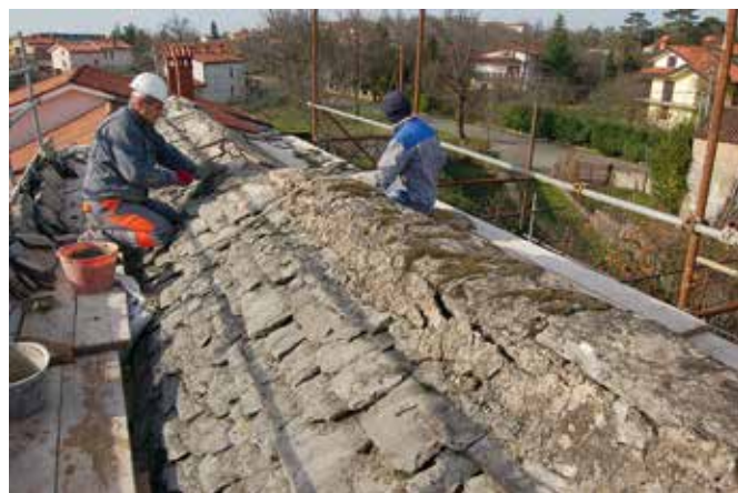
Tupelče, domačija Tupelče 4, popraviljanje slemena stanovanjske hiše in priprava na prekrivanje z novimi slemenjaki (foto: E. Belingar, 2015)
