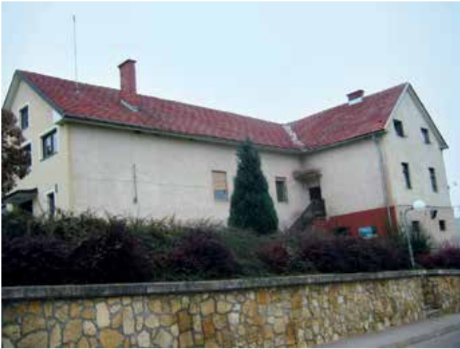
Kulturni dom v Jurovskem Dolu pred obnovo (foto: J. Saklicky, 2009)
