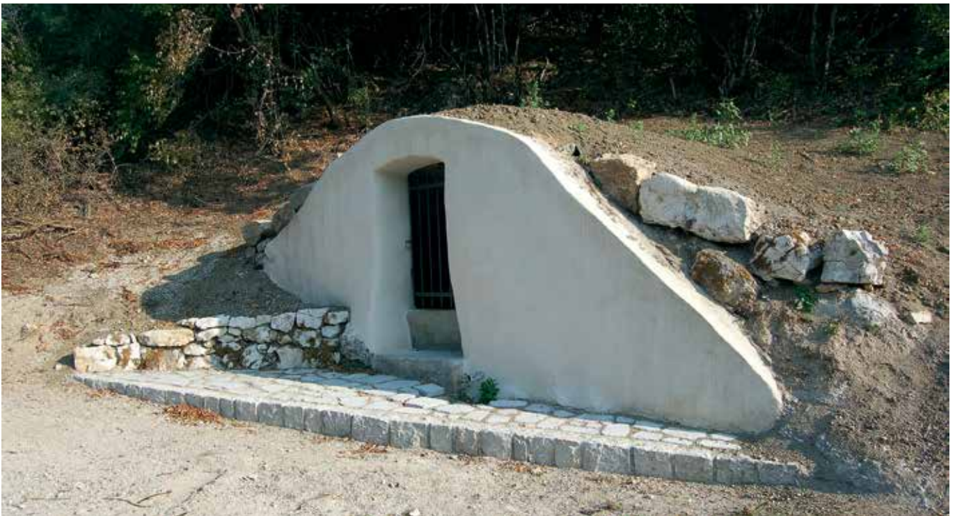
Gorenje pri Postojni, izvir po obnovi (foto: E. Belingar, 2014)
