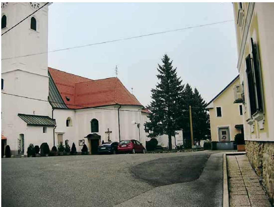
Trg v Jurovskem Dolu pred obnovo (foto: J. Saklicky, 2009)
