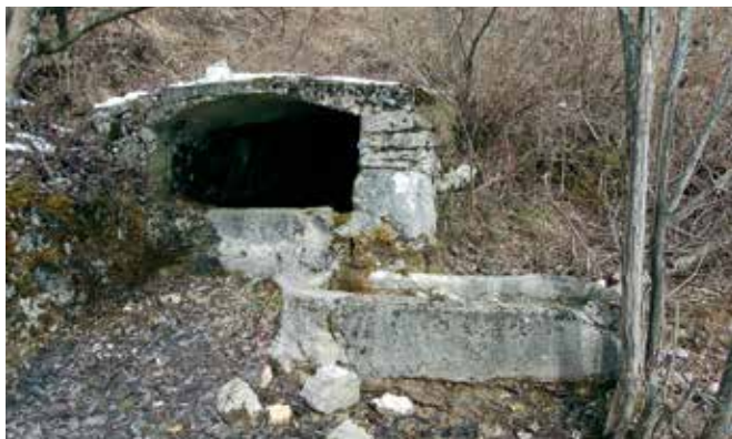
Gorenje pri Postojni, izvir Pri lipi pred obnovitvenimi deli (foto: E. Belingar, 2010)
