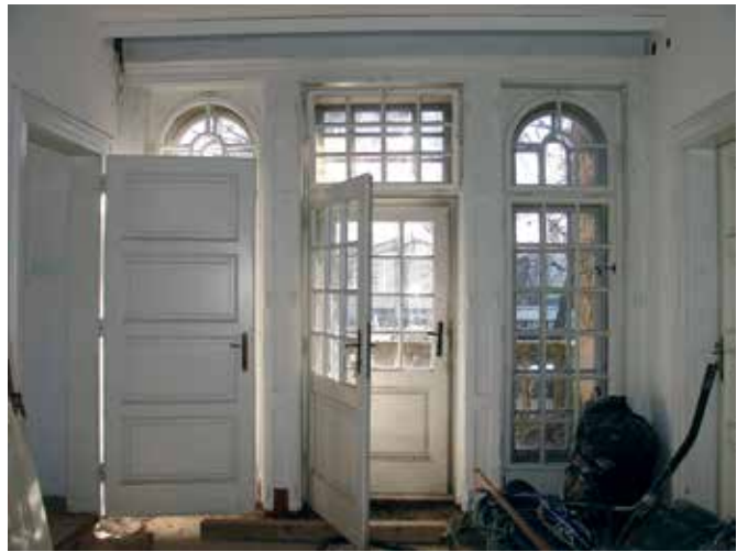
Ljubljana, vila Svetčeva ulica 4, pogled iz notranjosti na obstoječa okna in vrata na terasi obcestne fasade v pritličju, 2012 (foto: I. Vesel)
