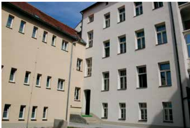
Ptuj, Osnovna šola Olge Meglič, fasade notranjega dvorišča po energetske sanaciji (foto: S. Menoni)
