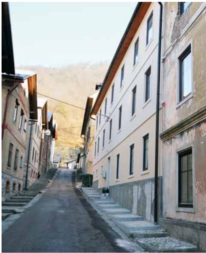
Idrija, rudarski bloki, fasada in tlakovanje po obnovi (foto: J. Svetina, 2013)
