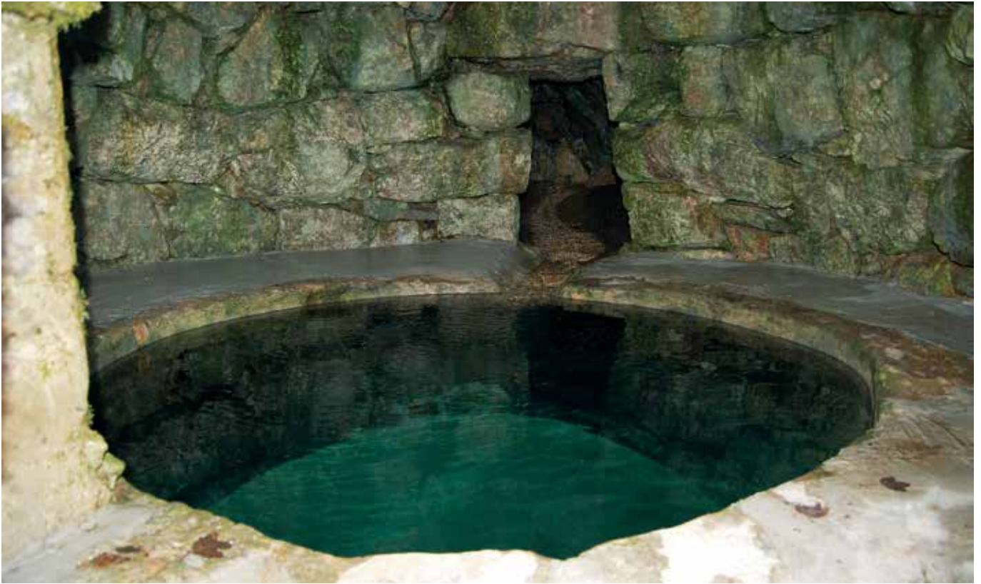
Bukovje, notranjost studenca. Izvirna voda priteka skozi odprtino v kupoli v vodni zbiralnik (foto: E. Belingar, 2014).
