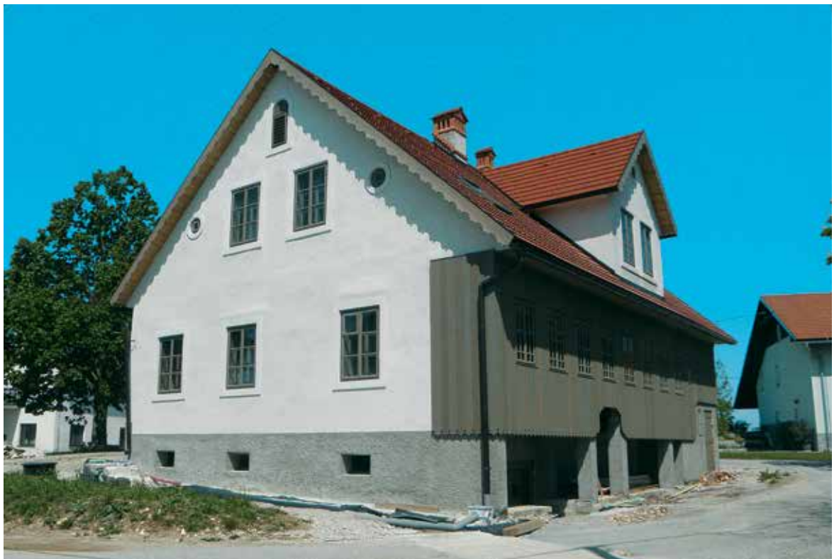
Sveti Vid pri Cerknici, hiša Sveti Vid 12 po obnovi (foto: D. Pediček, 2012)
