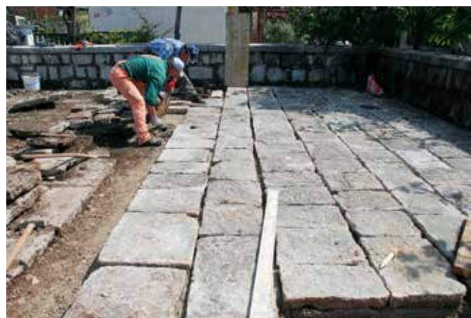
Sela na Krasu, ponovno polaganje kamnitega tlaka nad cisterno (foto: A. Ščukovt, 2014)
