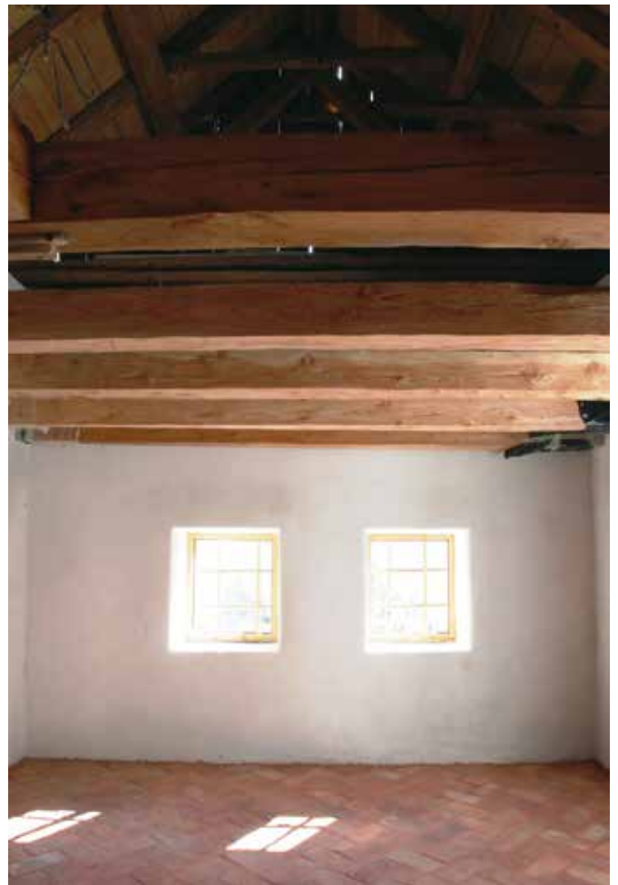
Kneške Ravne, gospodarski objekti na domačiji pri Francu, pritličje s tesanimi tramovi in tlakom iz planet, 2014 (foto: A. Ščukovt)
