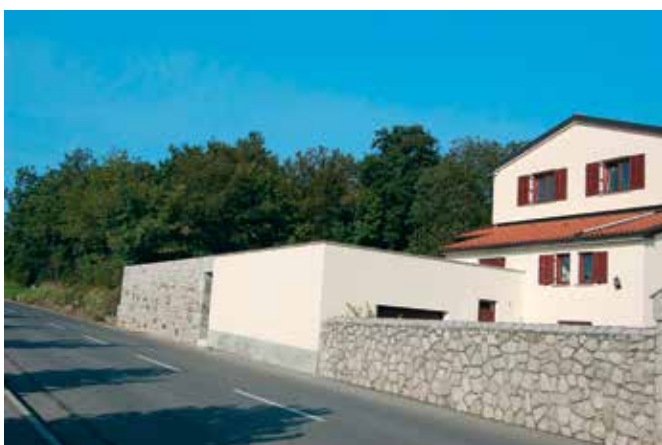
Matavun, hiša Matavun 1 po izvedbi del (foto: E. Belingar, 2014)
