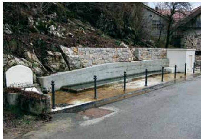
Belsko, Korito 1 po obnovi (foto: E. Belingar)
