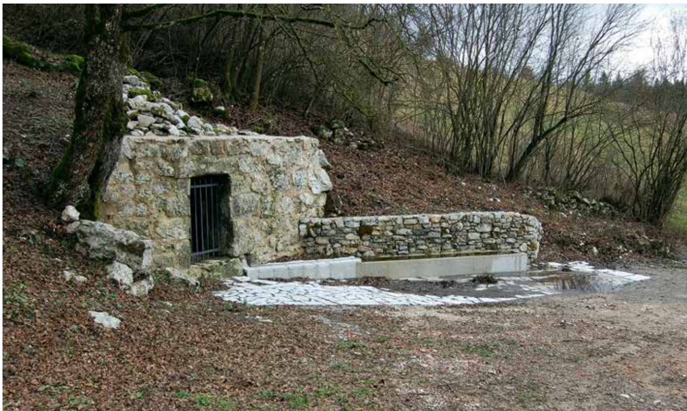
Bukovje, Studenec in novo kamnito korito po zaključku obnovitvenih del (foto: E. Belingar, 2014)
