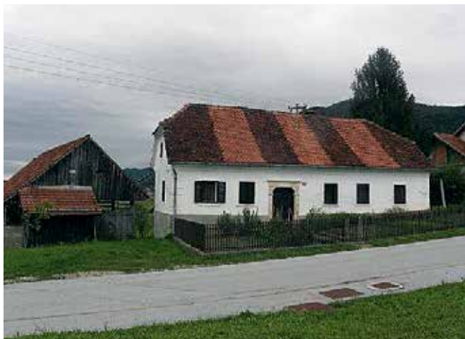
Bistrica ob Sotli 26, hiša pred obnovo (foto: B. Hostnik, 2010, arhiv ZVKDS, OE Celje)
