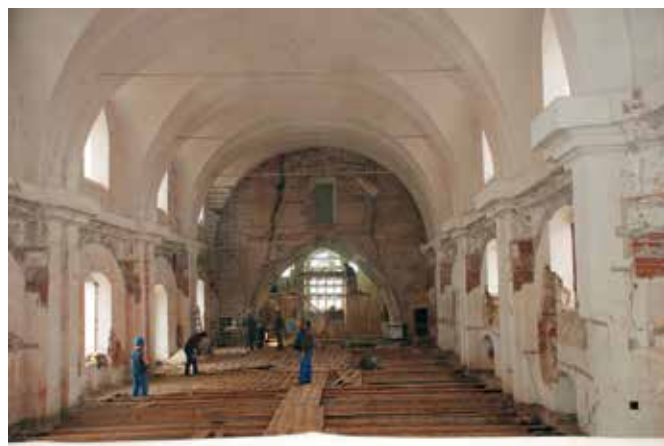
Ptuj, dominikanski samostan, cerkvena ladja med obnovo (foto: V. Čobal Sedmak)
