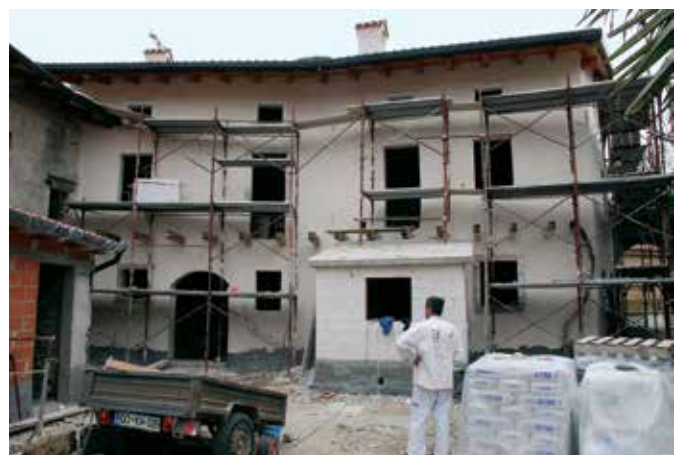
Kozana, dvoriščna fasada hiše Kozana 69 po nanosu apnenega obrizga (foto: A. Ščukovt, 2014)
