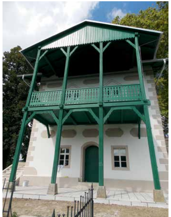
Sevnica, park gradu, obnovljena vrtna hiša (foto: N. Podkrižnik, 2015)
