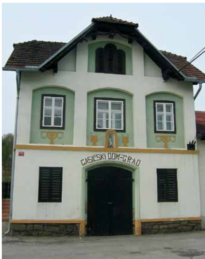
Grad, gasilski dom pred obnovo (foto: S. Vešligaj)
