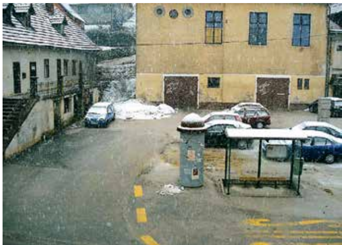
Makole, večnamenski prostor pred obnovo (foto: Igor Erker, arhiv Občine Makole, 2013)
