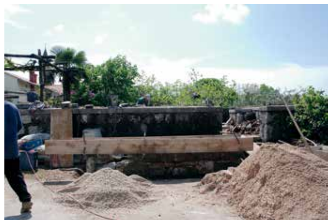
Sela na Krasu, sanacija vodnega zbirnika z napajalnim koritom (foto: A. Ščukovt, 2014)
