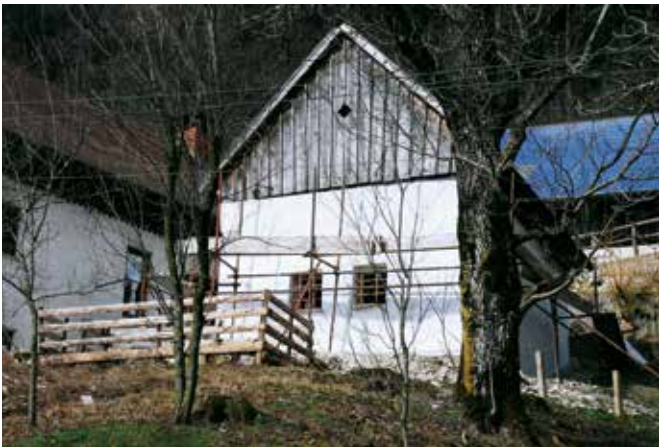
Kneške Ravne, gospodarski objekti na domačiji pri Francu, obnovljena fasada, 2014 (foto: A. Ščukovt)
