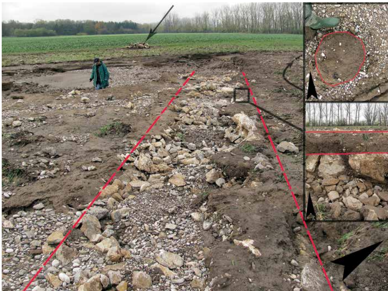
Gorenje Skopice. Pogled na ruševine nasipa na ledini Gorenje/Dolenje cesarsko od jugovzhoda nekaj ur po odmiku vodovja. Ob desni strani – detalj preseka ohranjenega dela nasipa in pogled od zgoraj na okroglo liso – polnilo jame domnevnega pilota. V ozadju (označeno s puščico) je groblja kamenja, ki so jo natrebili iz ornice pred jesensko setvijo še pred povodnijo (foto in obdelava: J. Rihter, 7. 11. 2012).
