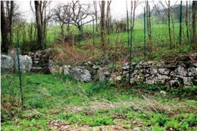
Bate, zaselek Podlaka, kal, stanje pred obnovo, 2013 (foto: A. Ščukovt)
