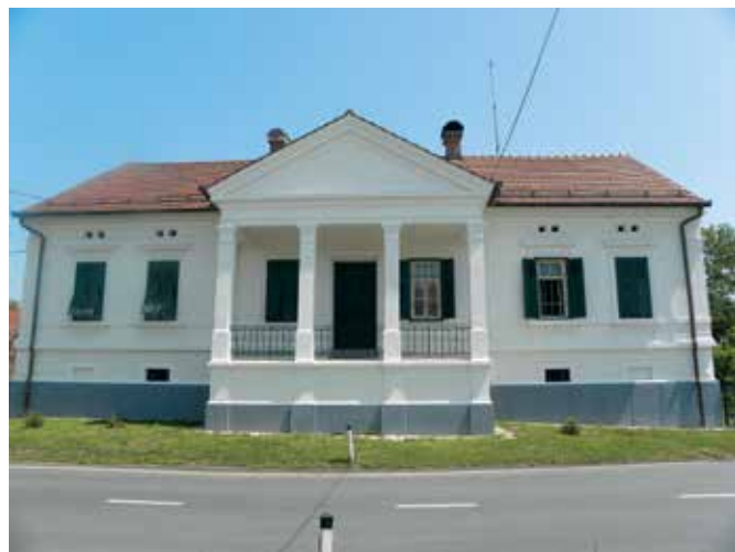
Lukavci, Kranjčeva hiša po obnovi (foto: S. Vešligaj, maj 2015)
