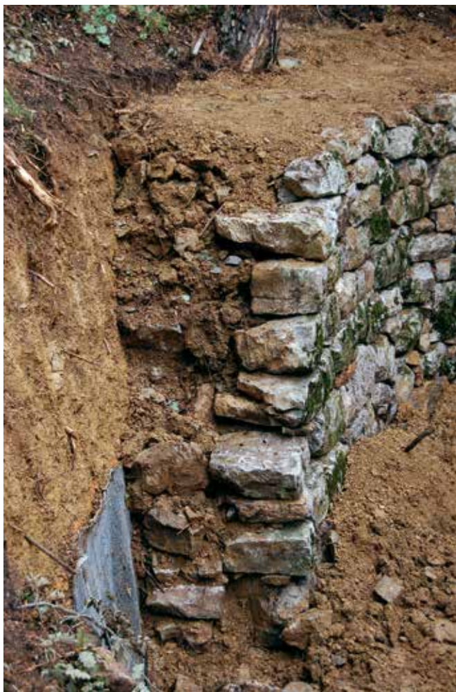
Sežana, nova štirna, prerez na novo zloženega zidu (foto: E. Belingar, 2013)
