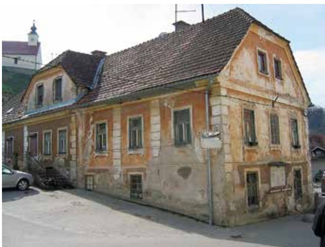
Makole 42, hiša pred obnovo (foto: J. Skalicky, 2014)
