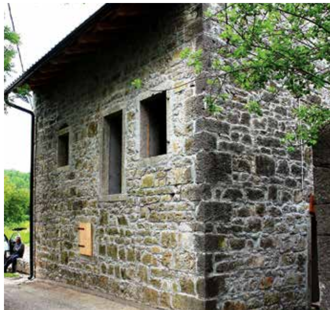
Robidišče, cestna in del stranske fasade saniranega objekta, 2013 (foto: A. Ščukovt)
