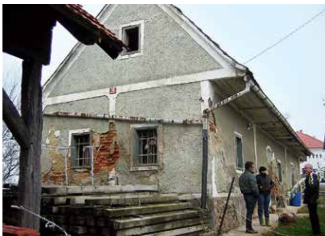
Kremberk 39, viničarija Pergarjev vrh, zidanica pred obnovo (foto: J. Skalicky, 2011)
