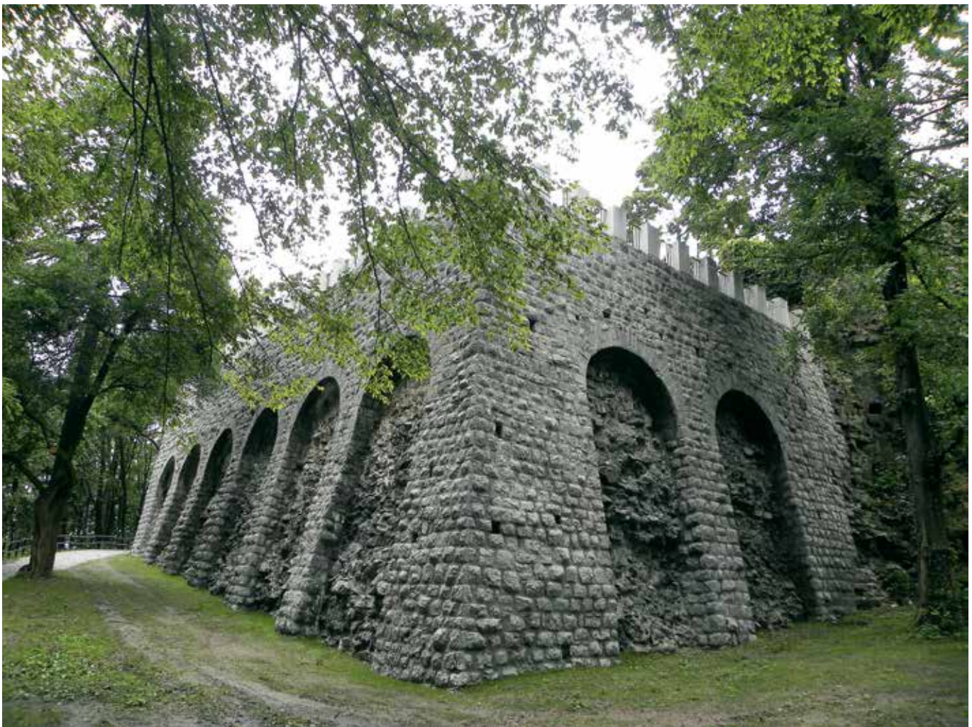
Ljubljana, parkovna ureditev grajske planote, podporni zidovi po sanaciji, 2014 (foto: I. Vesel)
