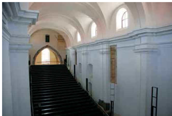
Ptuj, dominikanski samostan, cerkvena ladja po obnovi (foto: V. Čobal Sedmak)
