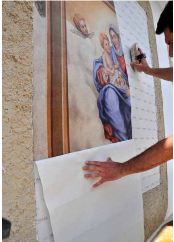
Krško, cesta Krških žrtev 2 – Mencingerjeva hiša, med apliciranjem rekonstruirane poslikave na novo pripravljeni omet (foto: T. Pristov, 2013)
