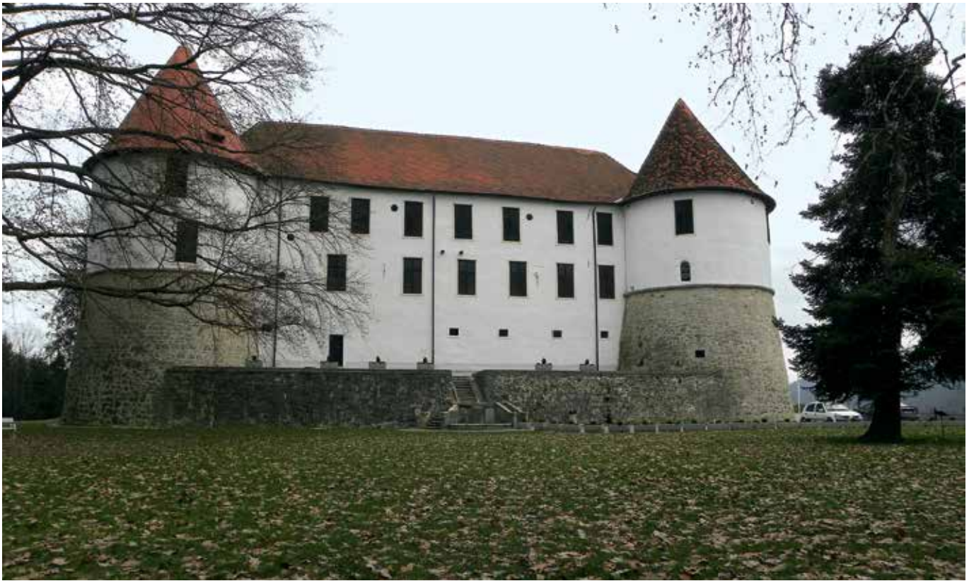
Sevnica, park gradu, zahodni plato pred prenovu (foto: A. Mišelčič Koželj, 2010)
