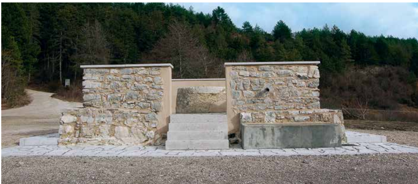
Gorenje pri Postojni, vodnjak po zaključku obnovitvenih del (foto: E. Belingar, 2014)
