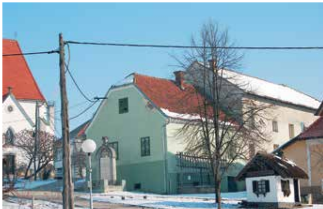
Juršinci, kulturni dom pred obnovo (foto: S. Vešligaj, februar 2010)
