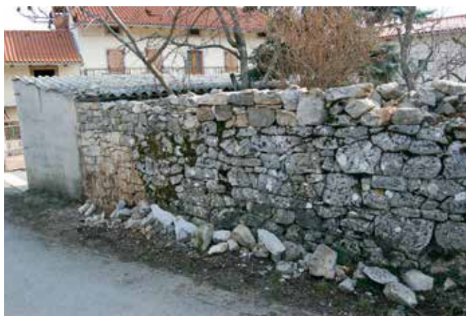
Kačiče, domačija Kačiče – Pared 13, kamniti zid vrta pred obnovo (foto: E. Belingar, 2013)
