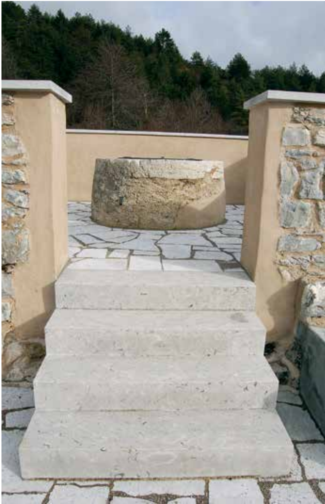
Gorenje pri Postojni, na oklepu vodnjaka so se dopolnili slabi in poškodovani kosi ometa z novim ometom (foto: E. Belingar, 2014).
