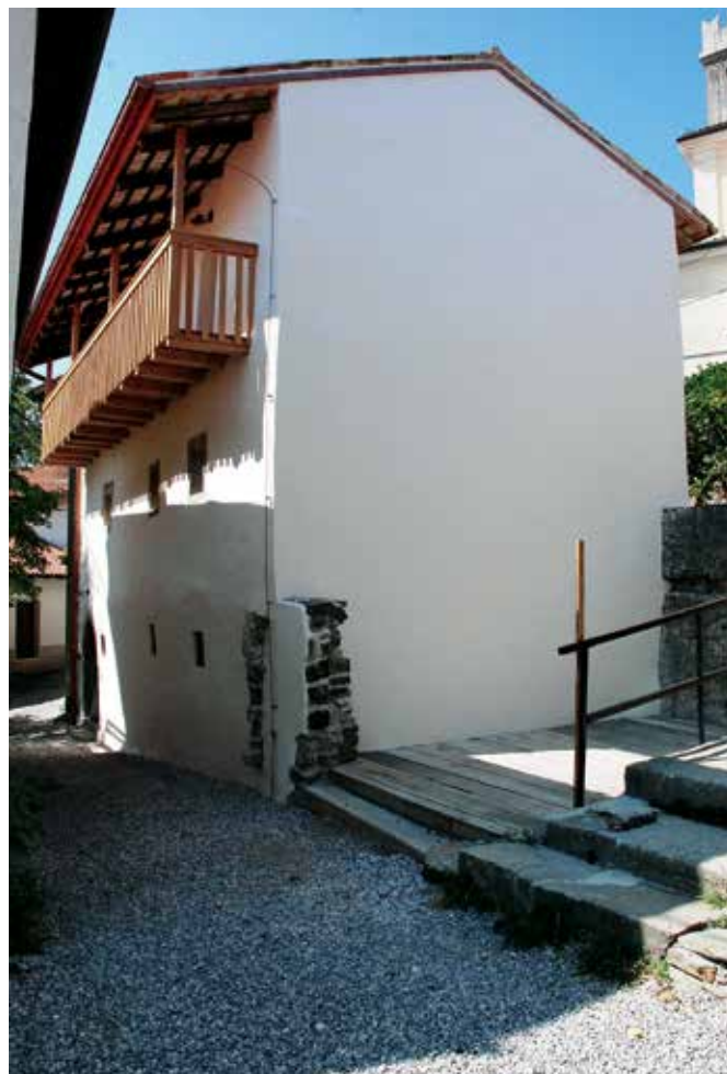
Šmartno v Brdih, t. i. gotska hiša, južna in vzhodna fasada po obnovi, 2013 (foto: A. Ščukovt)
