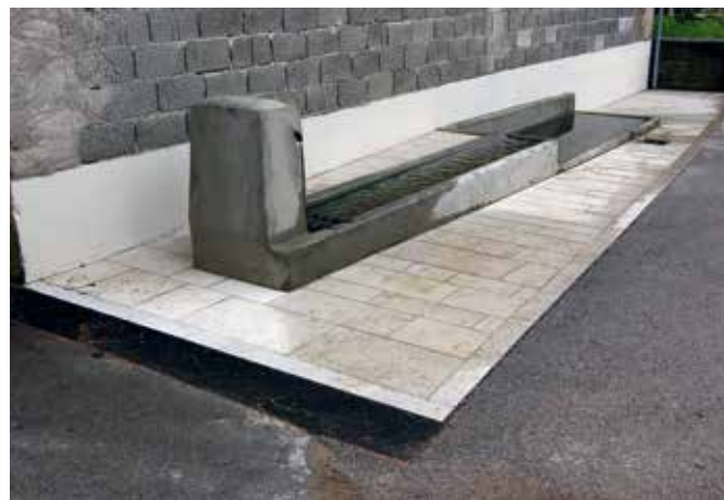
Belsko, Korito 2 po obnovi (foto: E. Belingar, 2014)
