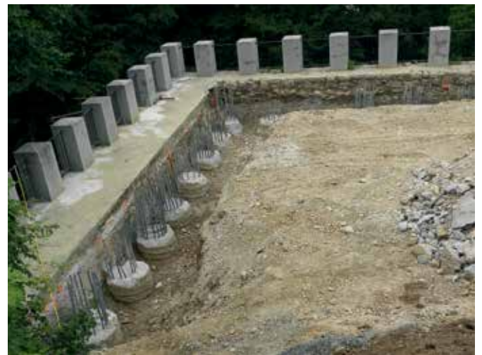
Ljubljana, parkovna ureditev grajske planote, betoniranje pilotov, 2014 (foto: I. Vesel)
