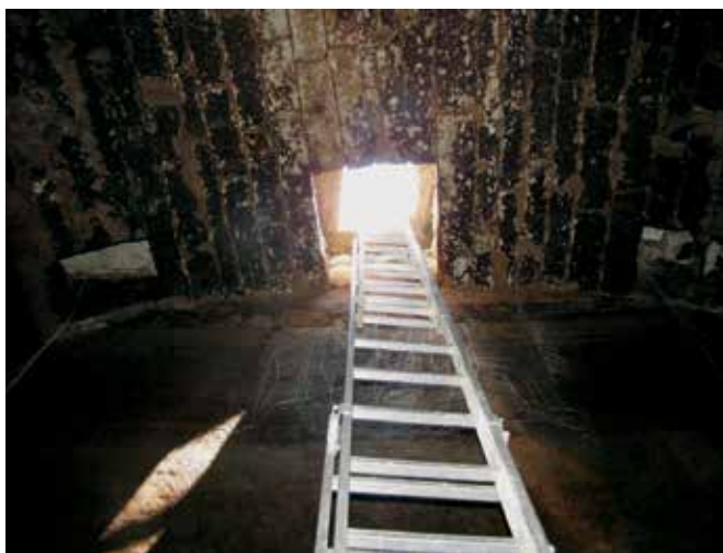
Sežana, notranjost zbiralnika z odprtino za zajemanje vode v vrhu (foto: M. Svetina, 2014)
