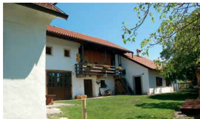
Kal pri Pivki, domačija Kal 18, skedenj in svinjski hlev po obnovi (foto: E. Belingar, 2014)
