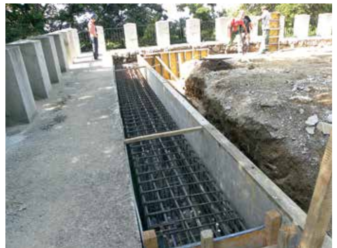
Ljubljana, parkovna ureditev grajske planote, izvedba vezne armiranobetonske grede nad piloti, 1914 (foto: I. Vesel)
