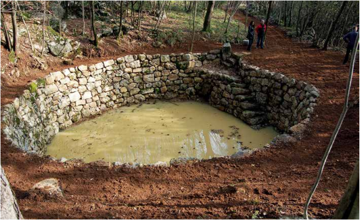
Sežana, nova štirna po dokončanju del (foto: E. Belingar, 2013)
