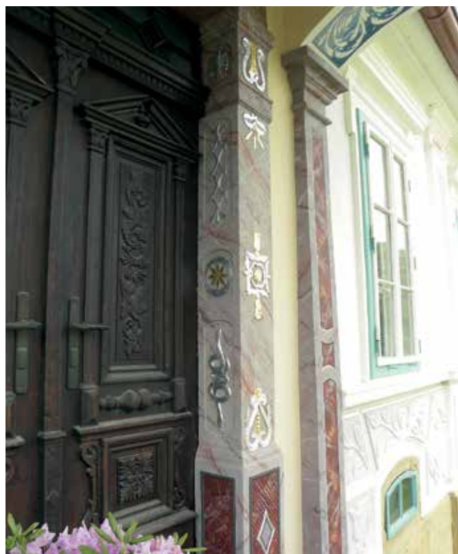
Bolehnečici, Županova domačija, restavrirani kamnoseški detajli glavnega portala (foto: S. Vešligaj, maj 2013)
