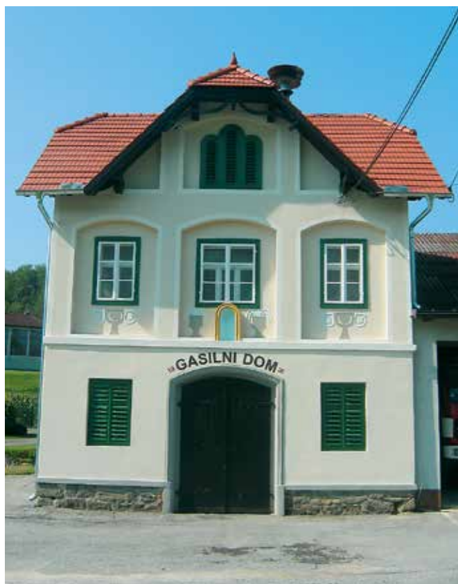
Grad, gasilski dom po obnovi (foto: S. Vešligaj)
