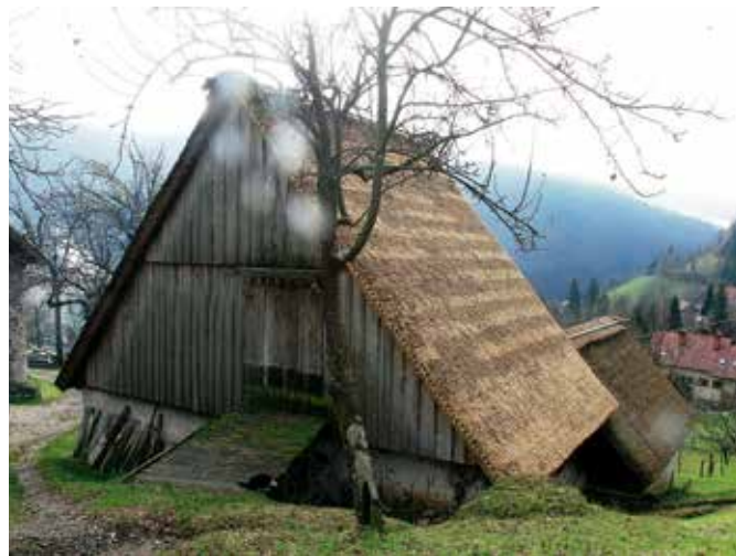
Dolenji Novaki, obnovljena severna streha steljnika (foto: A. Ščukovt, 2014)
