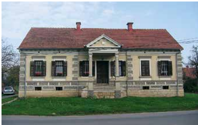
Lukavci, Muršičeva hiša pred obnovo (foto: S. Vešligaj, oktober 2008)
