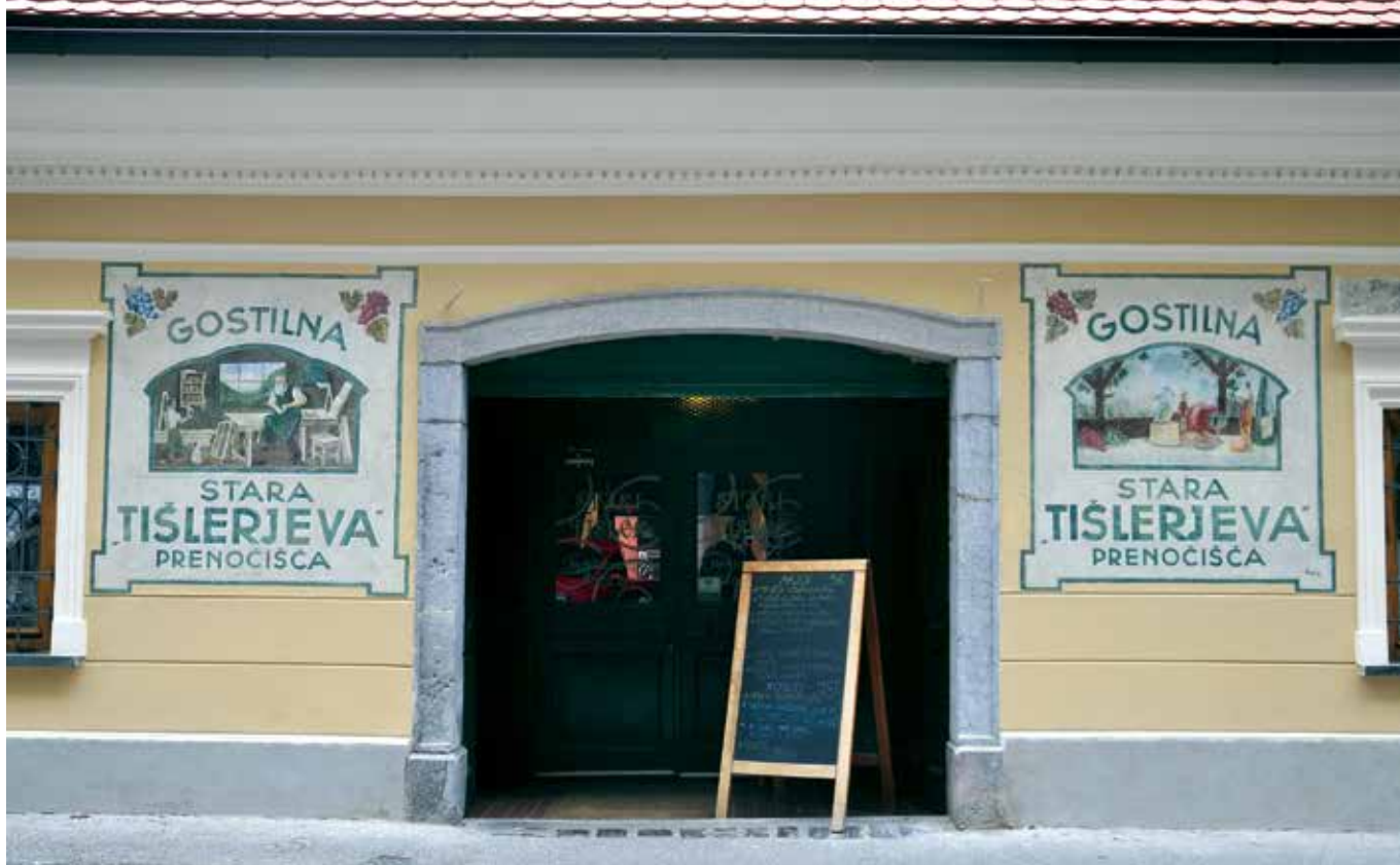
Ljubljana, Kolodvorska ulica 8 – Gostilna Stari Tišler, poslikavi po končanih konservatorsko-restavratorskih posegih (foto: T. Pristov, 2012)
