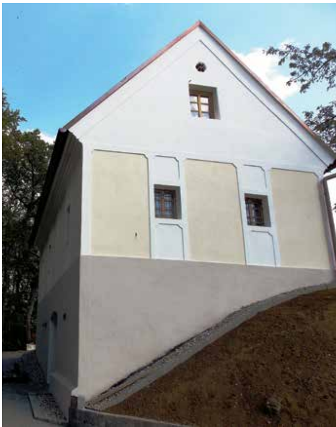
Modraže 25, obnovljena zunanjščina zidanice (foto: J. Skalicky, 2013)
