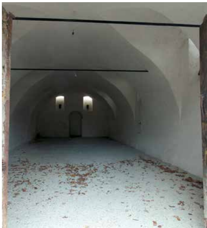
Jelovec pri Makolah 58, obnovljeni kletni prostor (foto: J. Skalicky, 2005)
