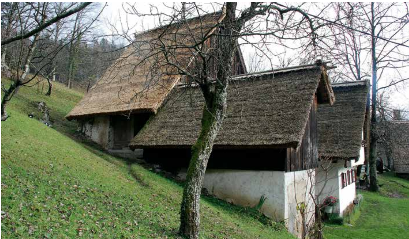
Dolenji Novaki, obnovljene strehe objektov domačije na Kamlonaršah (foto: A. Ščukovt, 2014)
