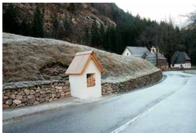
Trenta, Tožbarjevo znamenje po obnovi, december 2013 (foto: A. Ščukovt)
