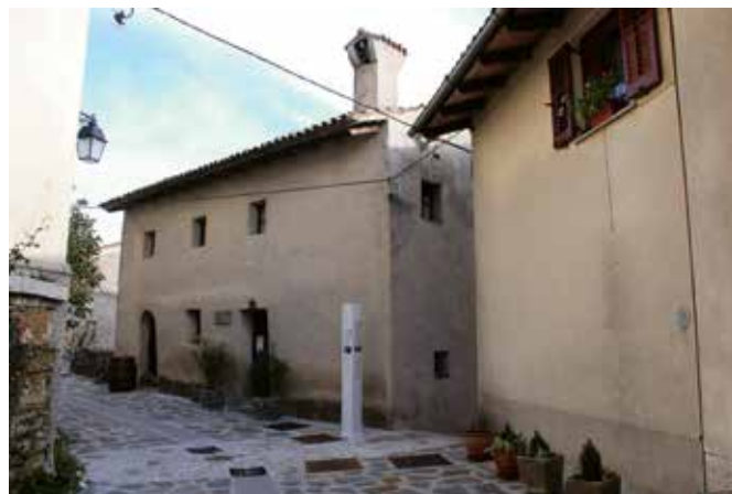
Šmartno v Brdih, pogled na vhodno fasado hiše Šmartno št. 49 pred obnovo, 2012 (foto: A. Ščukovt)
