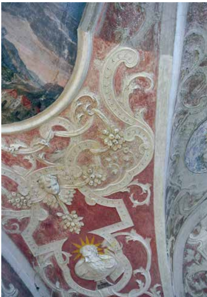
Ptuj, dominikanski samostan – refektorij, primerjava treh faz posega: neočiščen predel v zgornjem delu, očiščen predel v sredini in očiščen predel z retuširanim ozadjem v spodnjem delu (foto: S. Stržinar)
