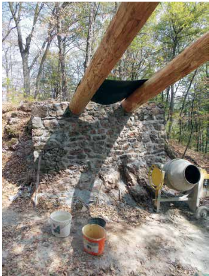
Radlje ob Dravi, razvaline gradu Mahrenberg, pogled na ostaline zidanega temelja za dvizni most oziroma mostovž med arheološkim dokumentiranjem in gradbenimi deli (foto: arhiv ZVKDS in Arheoterra, d. o. o.)
