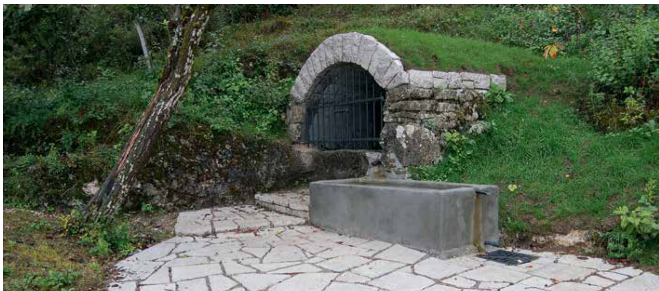
Gorenje pri Postojni, izvir Pri lipi po obnovi (foto: E. Belingar, 2014)
