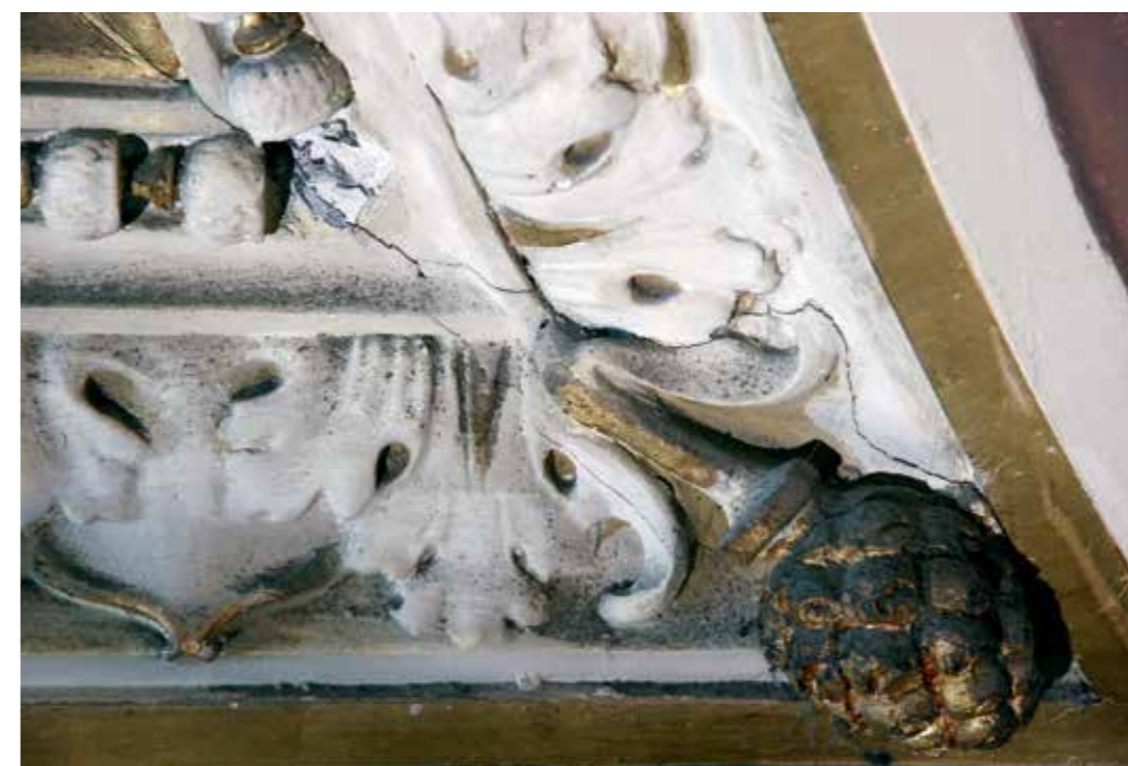
5. Debeli sloji prahu in umazanije na štukaturah stropa (foto: Emanuela Querini)
