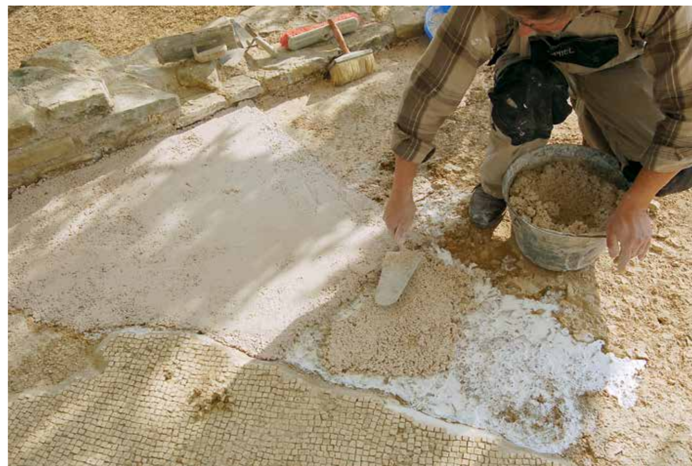
19. Izdelava testnega polja plasti rudusa enake debeline in v enakem nivoju, kot je bila originalna plast rudusa, ter stanje testnega polja po enem letu (slika 19.a) (foto: Nataša Škrjanec)
