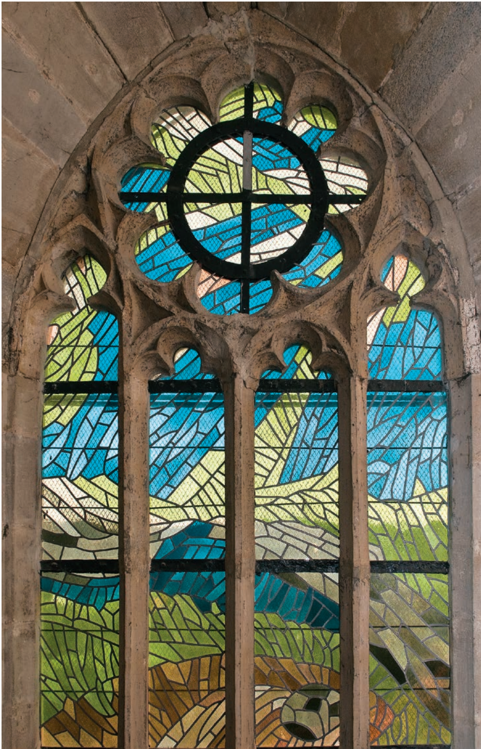
5. Ptujška Gora, bazilika Marije Zavetnice, okno v južni steni ladje z originalnimi kovanimi prečkami in zasteklitvijo Ide Brišnik Remec (foto: Robert Peskar)
