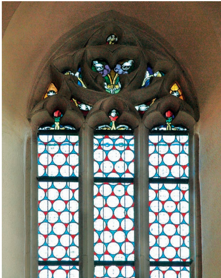
17. Novo mesto, cerkev sv. Nikolaja, jugovzhodno okno z ohranjenimi vitraji v krogovičju iz leta 1901 in novo zasteklitvijo (foto: Robert Peskar) 17. Novo Mesto, St. Nicholas' Church, southeast window with preserved stained glass in the tracery from 1901 and new glazing (Photo: Robert Peskar)
