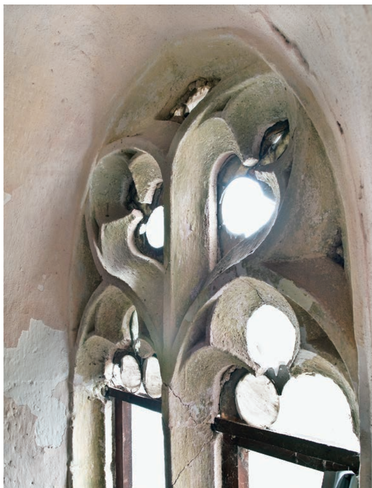
12. Gradišče pri Podsredi, cerkev Marije sedmih žalosti na Stari Sveti gori, pogled na ohranjeno krogovičje severovzhodnega okna iz zgodnjega 15. stoletja z ostanki originalne zasteklitve (foto: Robert Peskar)
