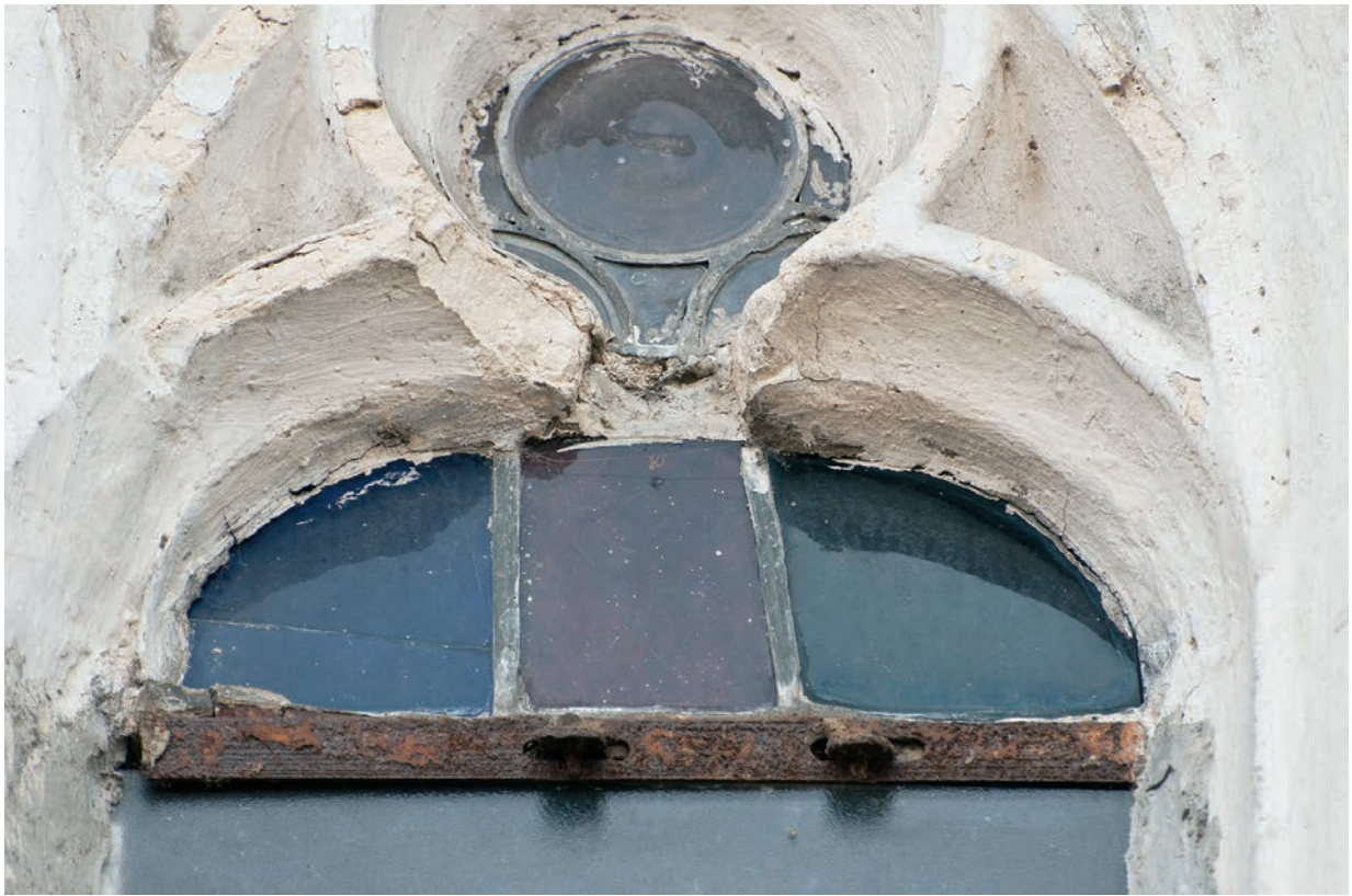
19. Mirna na Dolenjskem, cerkev sv. Janeza Krstnika, detajl vzhodnega okna z ostankom originalne zasteklitve (foto: Robert Peskar)
