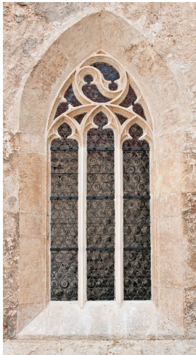
24. Ptuj, dominikanski samostan, krogovičje okna vzhodnega kraka križnega hodnika po posegih (foto: Robert Peskar)
