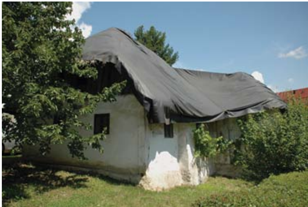
Metlika, hiša Bare Juričine, stanje pred obnovo kritine leta 2011 (foto: D. Strgar)
