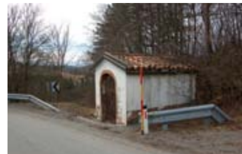
Bukovje, kapelica pred obnovo (foto: E. Belingar, 2012)
