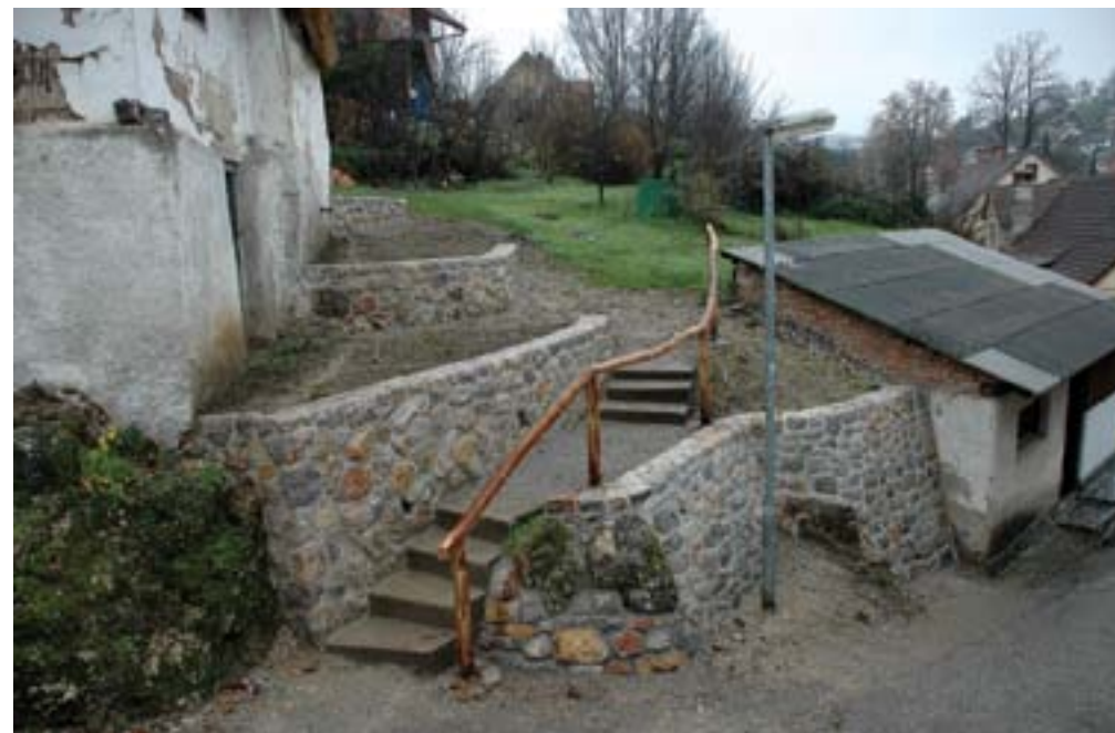
Metlika, hiša Bare Juričine, oporni zidovi po obnovi (foto: D. Strgar)
