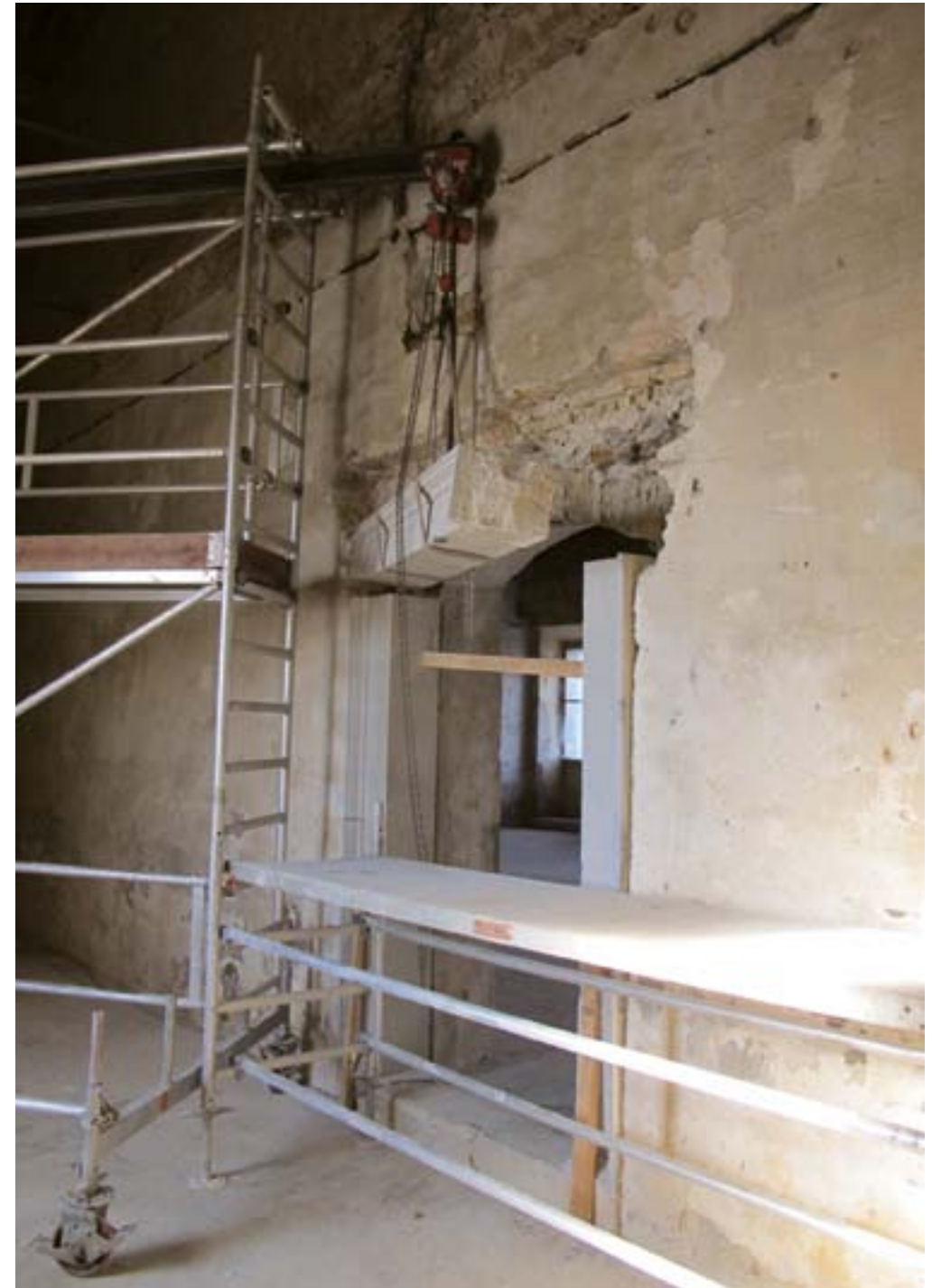
Vipolže, vila Vipolže, montaža zlepljene preklade na kamnitem portalu (foto: Š. Govže)
