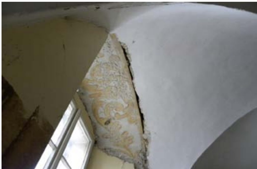
Vipava, Lanthierjeva graščina, kamniti obočni stropi so bili v baroku prislonjeni na poslikane stene (foto: M. Mozetič, 2012).
