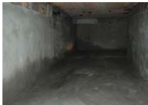
Kostanjevica na Krasu, cisterna vodnjaka (foto: A. Ščukovt, 2012)
