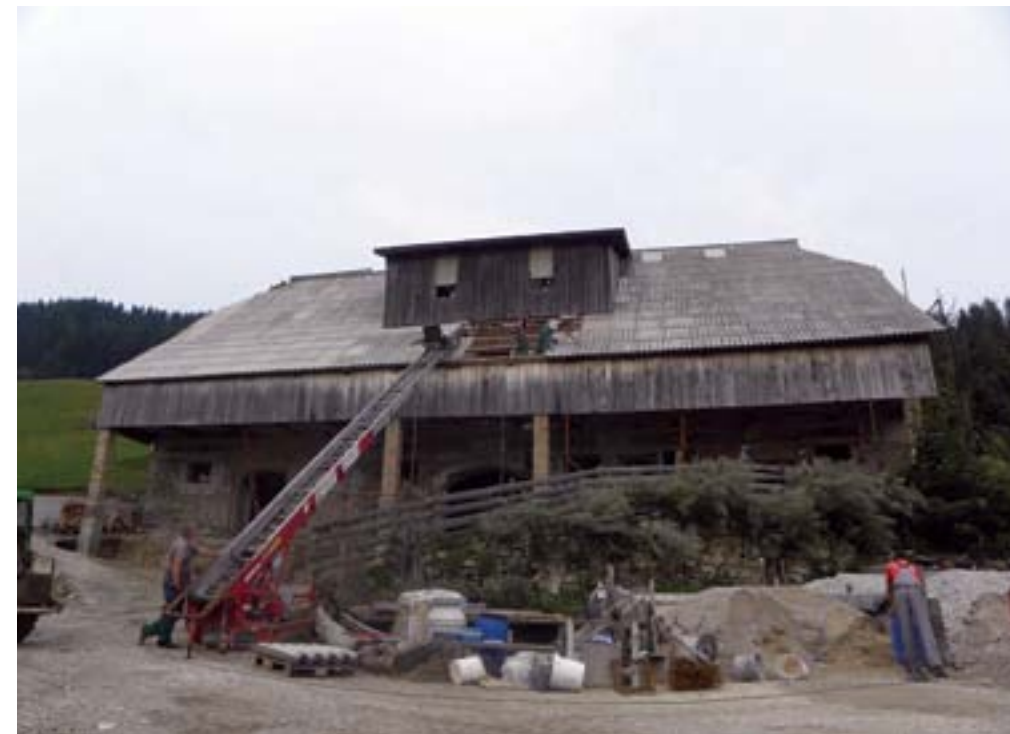
Robanov Kot, domačija Robanov Kot 39, obnavljanje hleva (foto: T. Hohnec)
