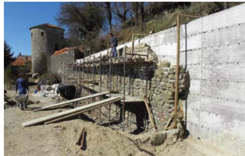
Prem, grad, rekonstrukcija podpornih zidov grajskih teras (foto: M. Mozetič, 2012)
