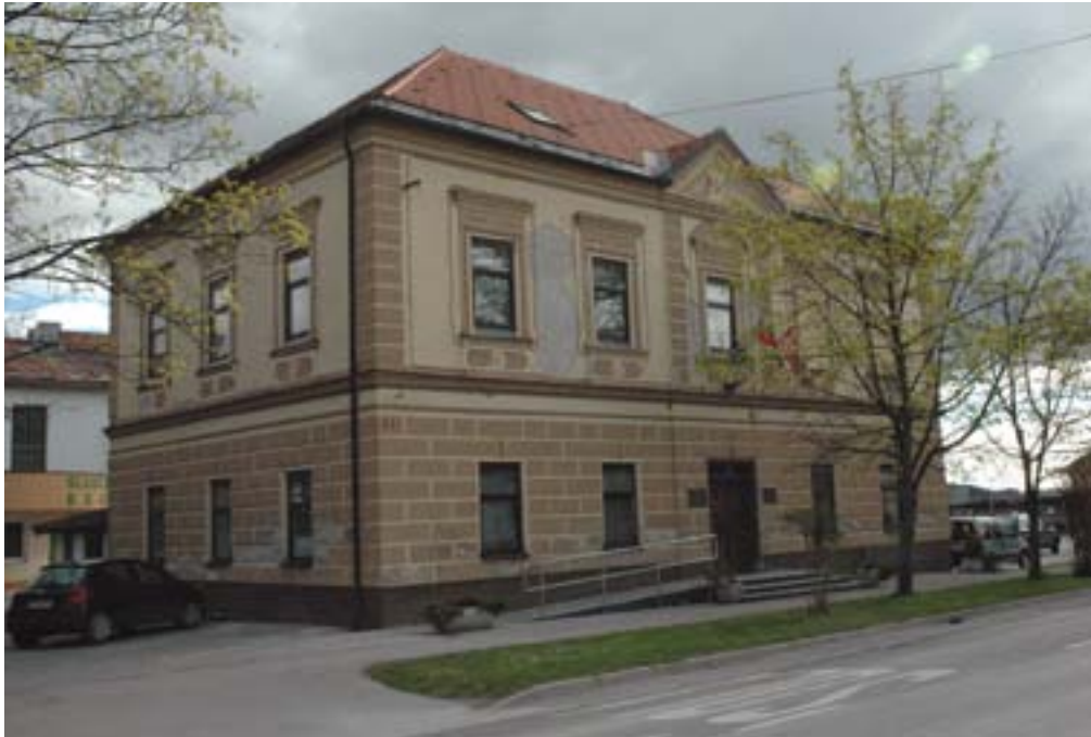
Polzela, stavba Polzela 8, stanje objekta pred obnovo (foto: N. Podkrižnik, 2009)
