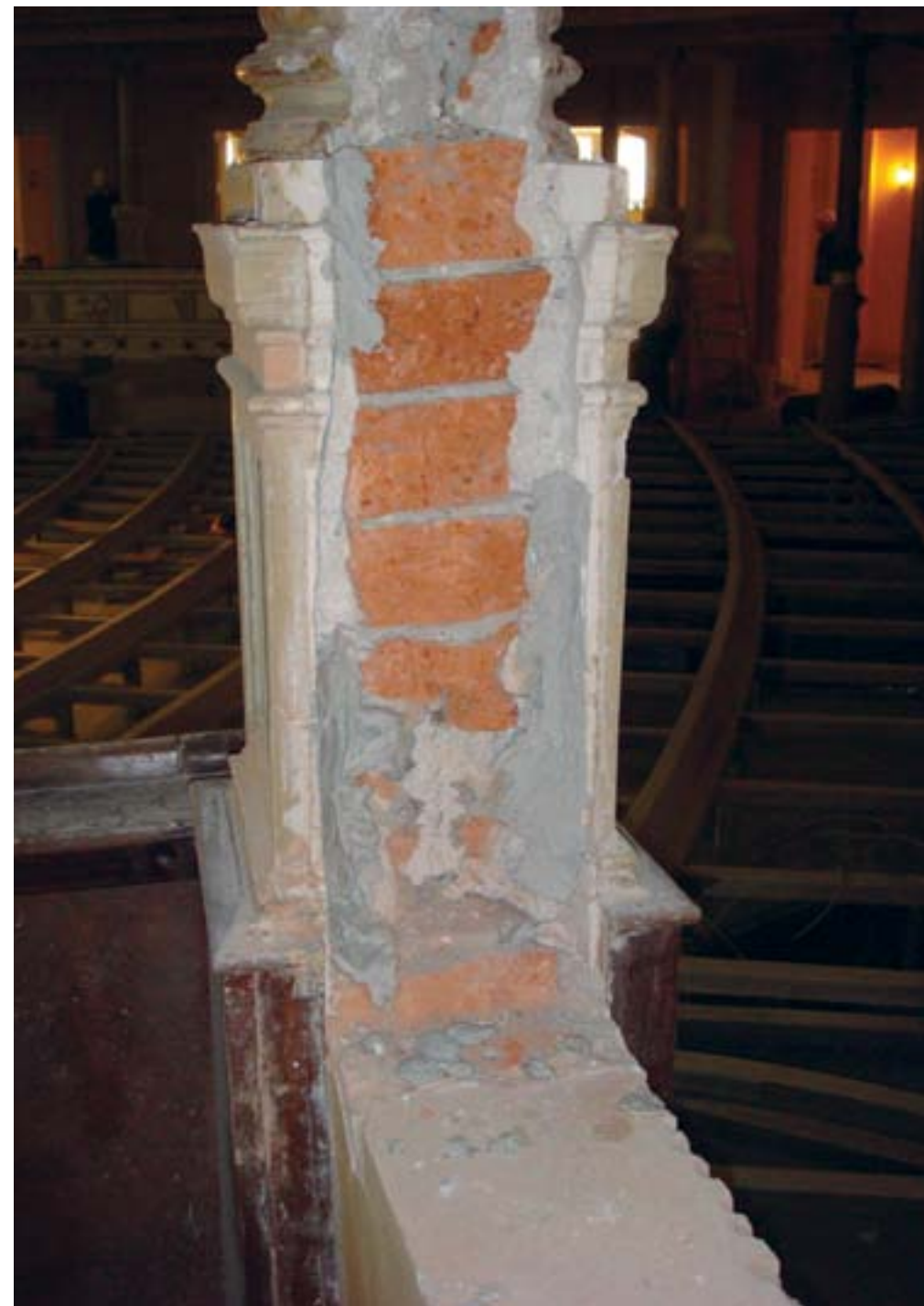
Ljubljana, Opera, manjkajoči del stebra po odstranitvi stene med ložami, detajl (foto: S. Dolinšek)
