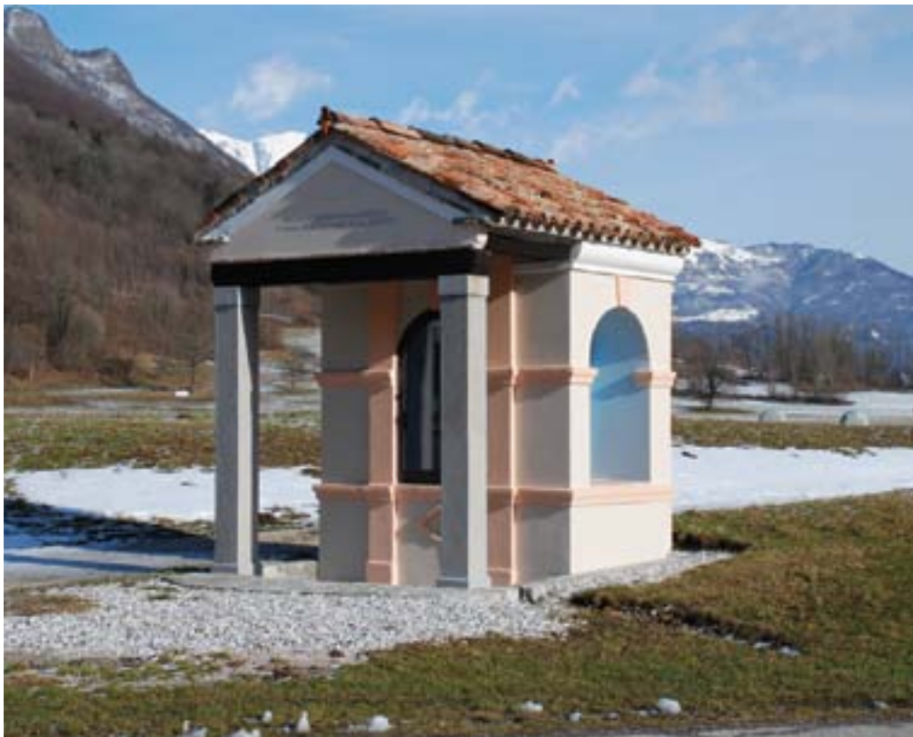
Kred, pogled na kapelico po celoviti obnovi (foto: A. Ščukovt, 2013)
