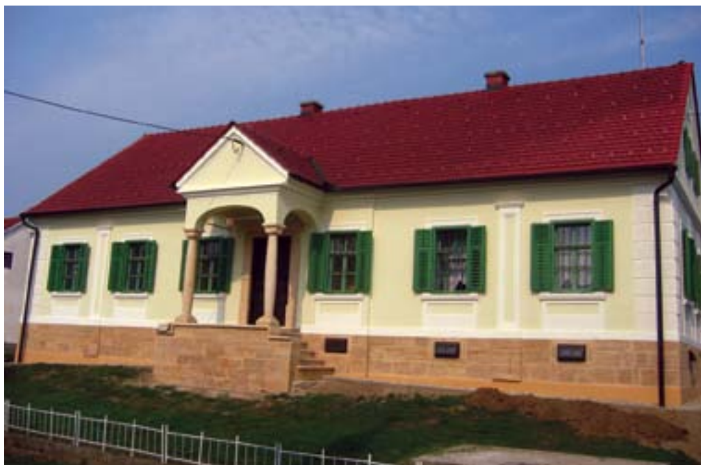
Bunčani, stanovanjska hiša domačije Jelenovi po obnovi (foto: Suzana Vešligaj, september 2012)
