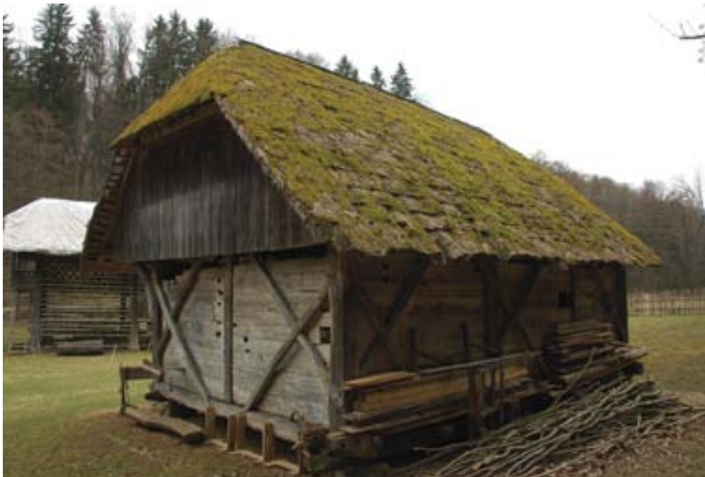
Pleterje, muzej na prostem, stanje kritine na Dobrovoljčevem podu (foto: D. Strgar)
