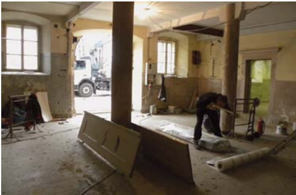
Vipava, Lanthierjeva graščina, del vhodne avle pred prenovno – ohranjena vrata so bila odpeljana v restavratorsko delavnico (foto: M. Mozetič, 2011).
