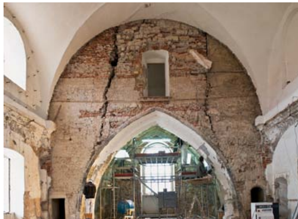
Ptuj, dominikanski samostan, pogled na gotski slavolok po odstranitvi sekundarne opečne obloge, pod katero so se pokazale široke razpoke, in med čiščenjem poslikave iz zgodnjega 14. stoletja (foto: R. Peskar)
