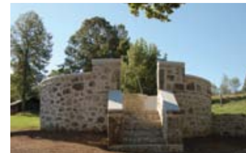
Klenik pri Pivki, vodnjak po zaključku del v letu 2012 (foto: E. Belingar, 2012)
