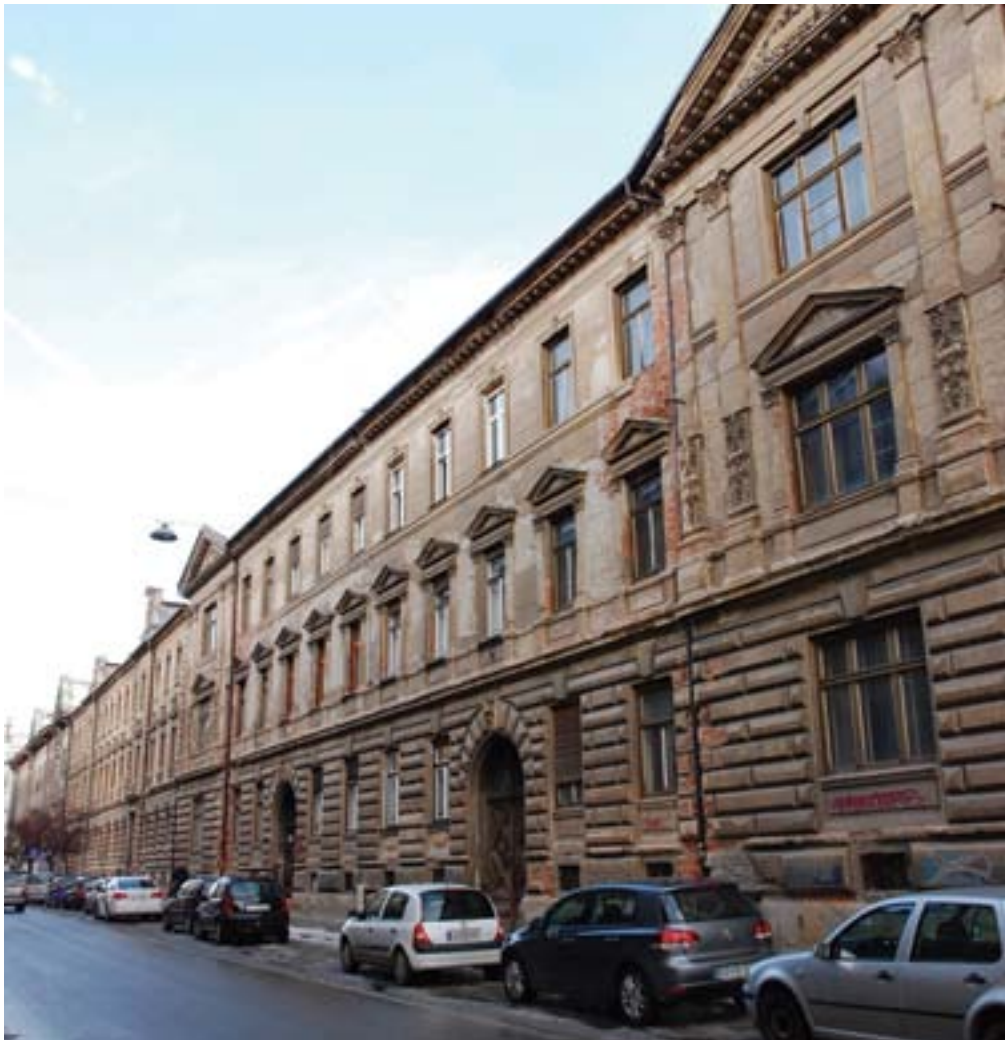
Celje, pročelji stavb Cankarjeva ulica 9–11 in 5–7 pred obnovo (foto: U. Kerbavec, 2010)
