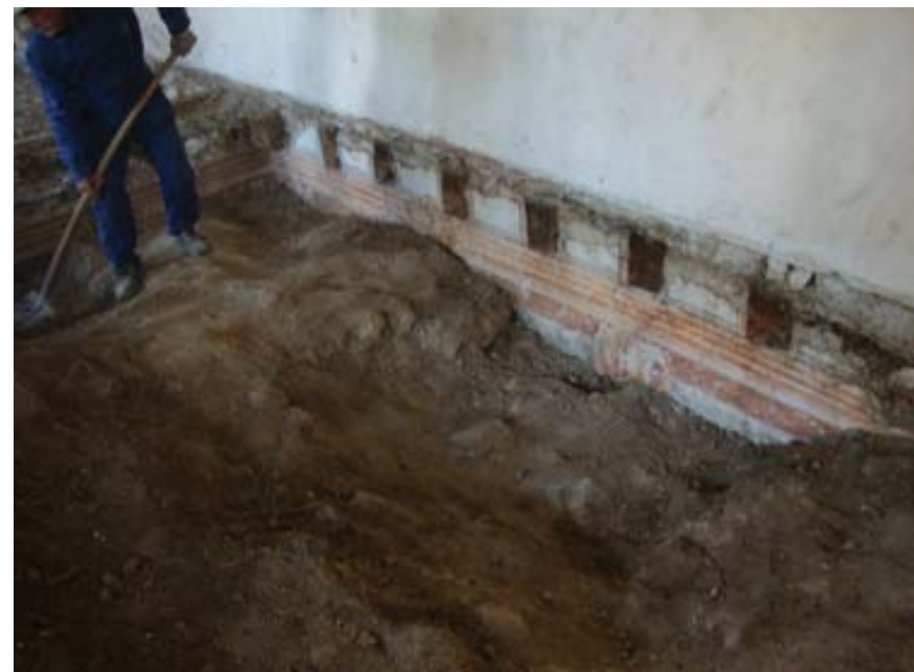
Vipava, Lanthierjeva graščina, ob vgradnji obočnih stropov so bili poslikani leseni stropi odrezani (foto: M. Mozetič, 2012).
