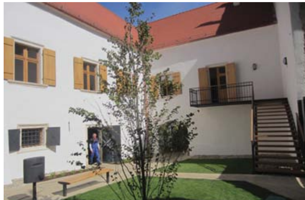
Gornja Radgona, hiša Jurkovičeva ulica 25, pogled na dvoriščno fasado po obnovo (foto: N. Sulič Urek, september 2012)
