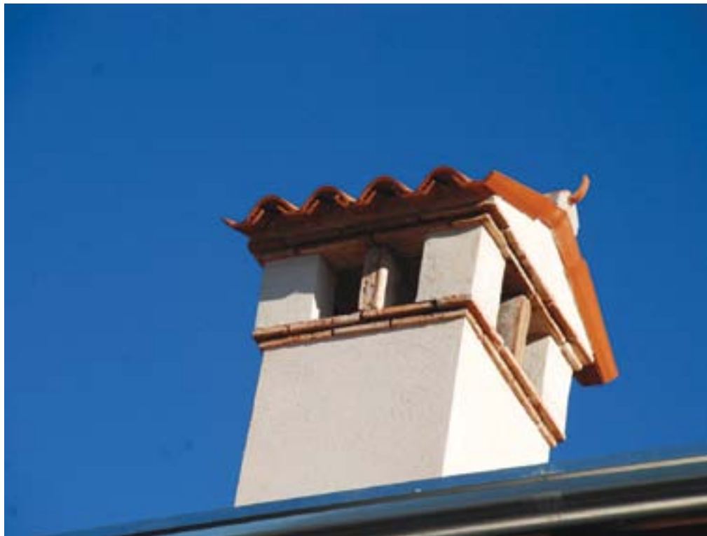
Drnovk, domačija Drnovk 8 in 9, dimnik po sanaciji (foto: A. Ščukovt, 2013)
