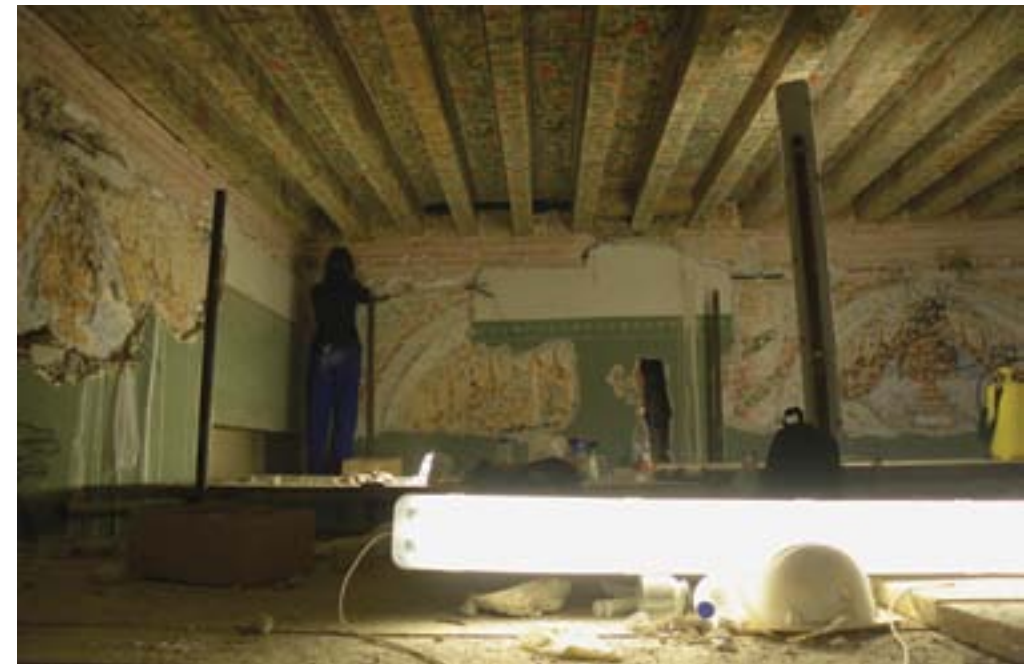
Vipava, Lanthierjeva graščina, odkrivanje stenskih poslikav pod debelo plastjo ometov (foto: M. Mozetič, 2012)
