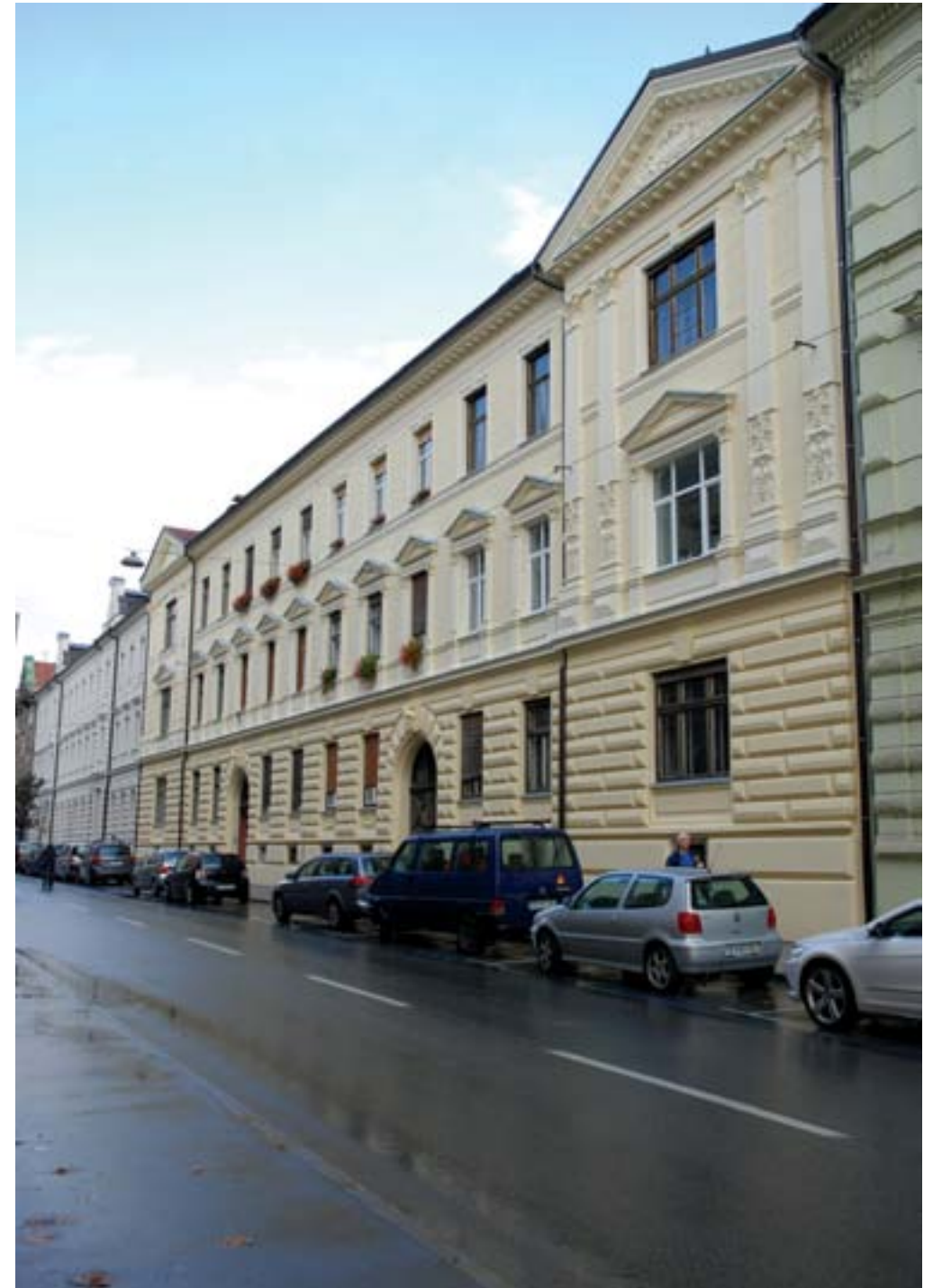
Celje, obnovljeni pročelji stavb Cankarjeva ulica 9–11 in 5–7 (foto: U. Kerbavec, 2012)
