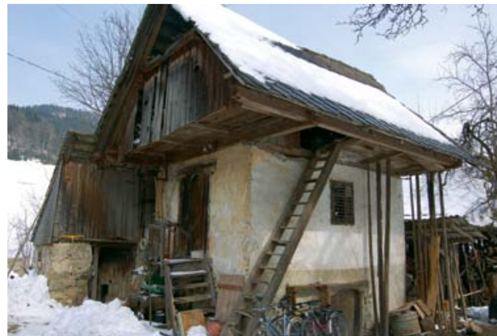
Bela, domačija Bela 18, kašča pred obnovo (foto: M. Tercelj Otorepec)
