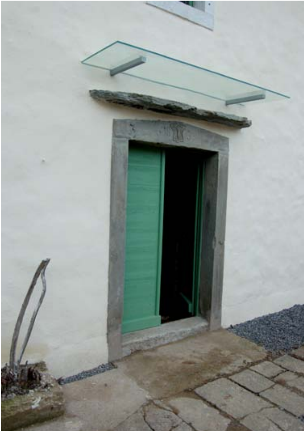
Kačiče, domačija Kačiče – Pared 13, s steklenim nadstreškom zaščitena vhodna vrata v staro hišo (foto: E. Belingar, 2012)
