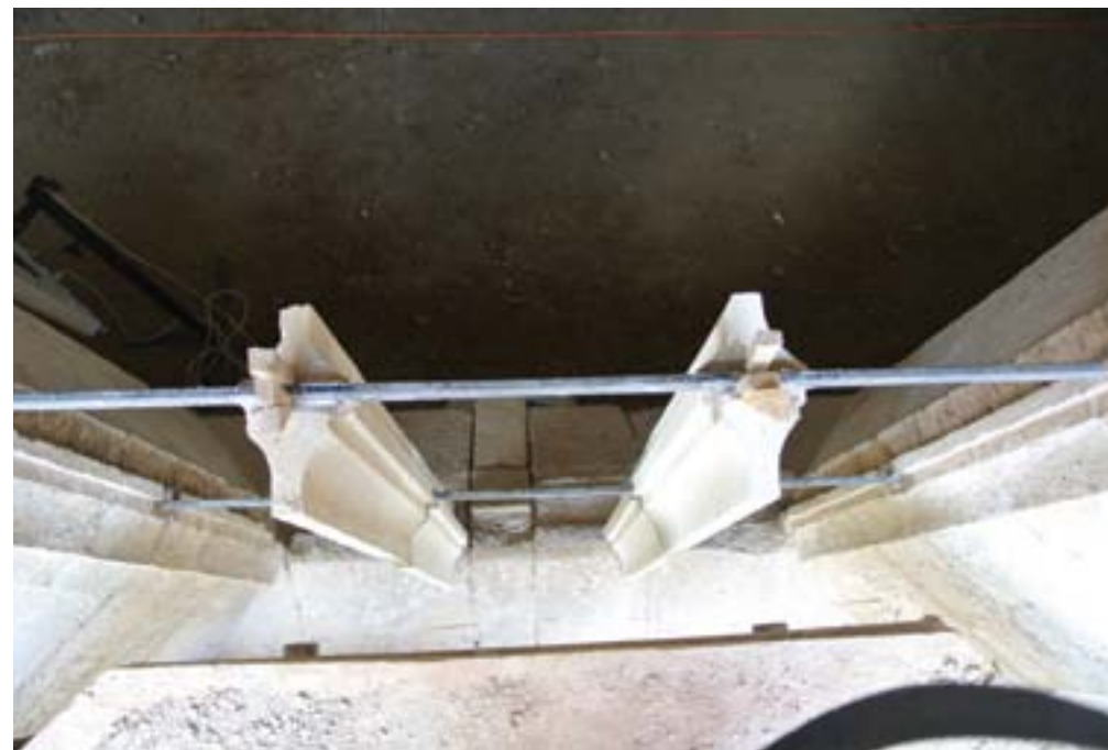
Ptuj, dominikanski samostan, rekonstrukcija gotskih oken, nameščanje kamnitih delilnih stebričev in kovanih prečk (foto: Robert Kuret)
