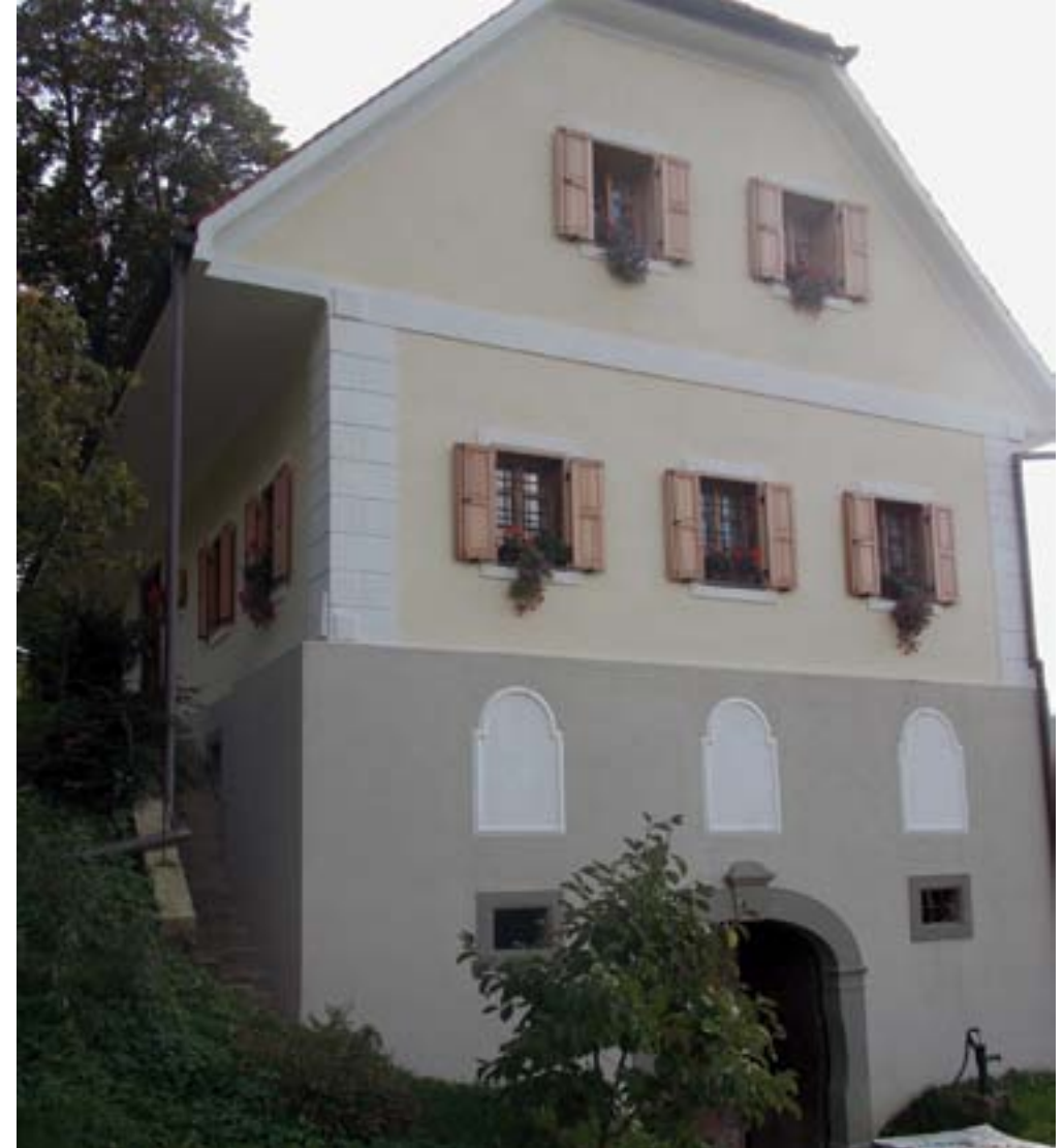
Jelovec pri Makolah 59, obnovljena hiša (foto: J. Skalicky, 2003)
