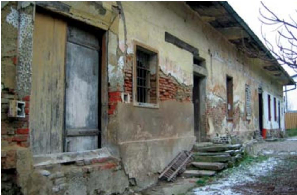
Kamnica, Vrbanska cesta 92, severna fasada pred obnovo (foto: J. Skalicky)
