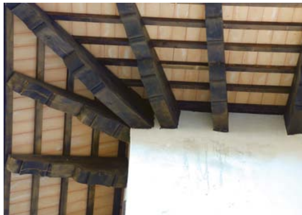
Drnovk, domačija Drnovk 8 in 9, pogled na dvojne špirovce in planete na letvah (foto: A. Ščukovt, 2013)
