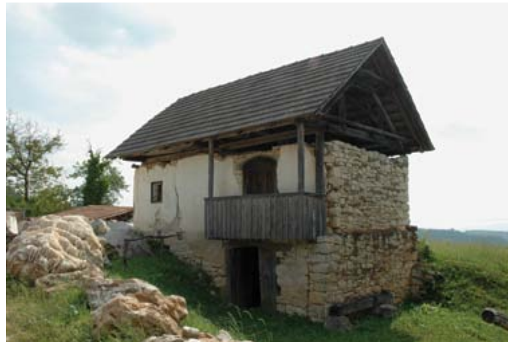
Zagrad pri Škocjanu, domačija Zagrad 4, kašča pred obnovo (foto: D. Strgar)
