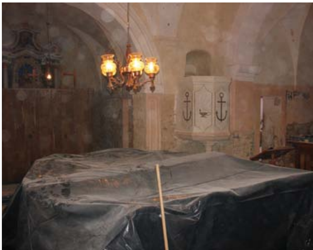
Kal pri Krmelju, cerkev sv. Martina, pogled v notranjščino objekta med obnovo (prižnica pred sondiranjem) (foto: M. Plevnik)
