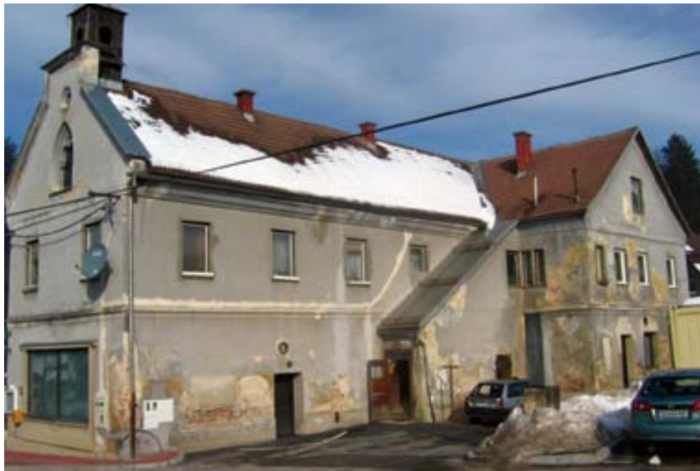
Leše, stavba Pozivalnice pred obnovo (foto: J. Skalicky, 2010)
