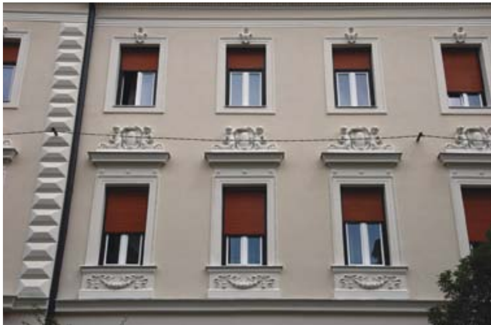
Celje, del obnovljenega pročelja stavbe Cankarjeva ulica 5–7 (foto: U. Kerbavec, 2012)
