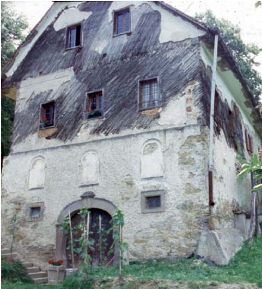
Jelovec pri Makolah 59, hiša pred obnovo (foto: J. Skalicky, 2003)
