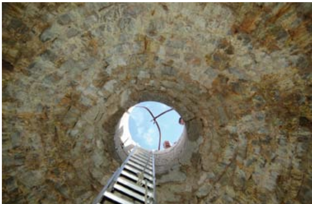
Klenik pri Pivki, kupola podzemnega vodnega zbiralnika (foto: E. Belingar, 2012)
