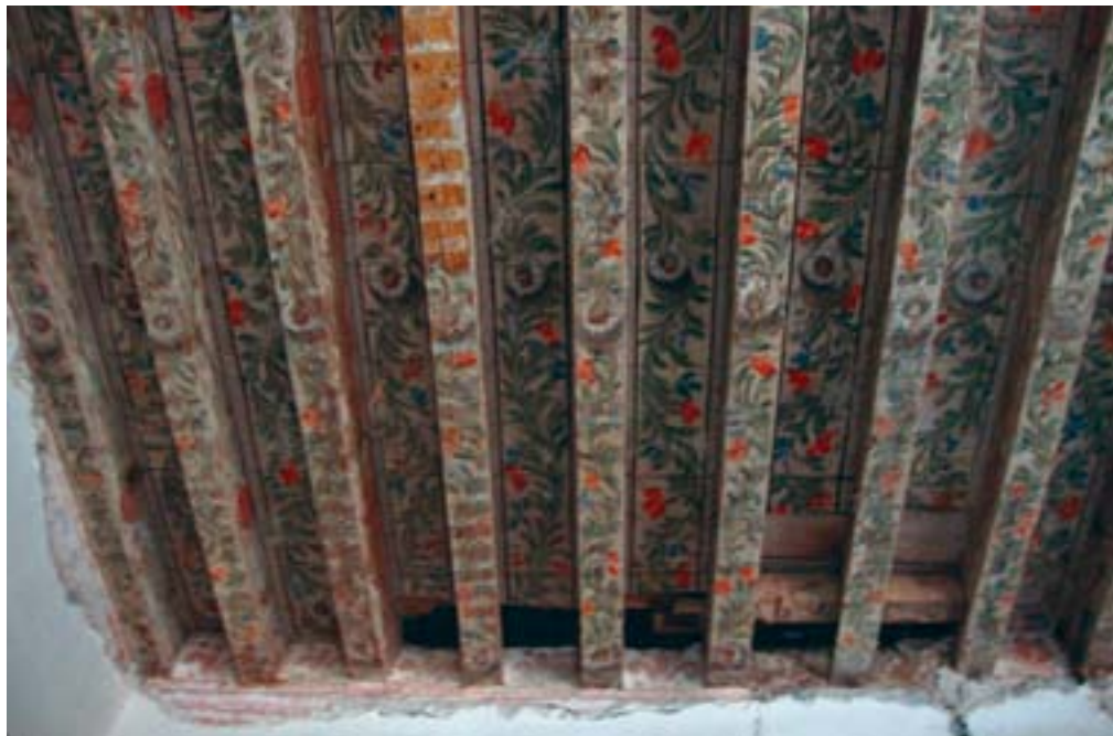
Vipava, Lanthierjeva graščina, poslikani leseni stropi so bili prekriti z ometom na letvah, poslikani zidovi pa s plastjo debejšega ometa (foto: M. Mozetič, 2012).
