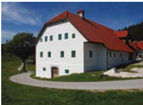
Vojsko pri Idriji, domačija Škratovše, pogled na gospodarsko-stanovanjski objekt (foto: A. Ščukovt, 2012)
