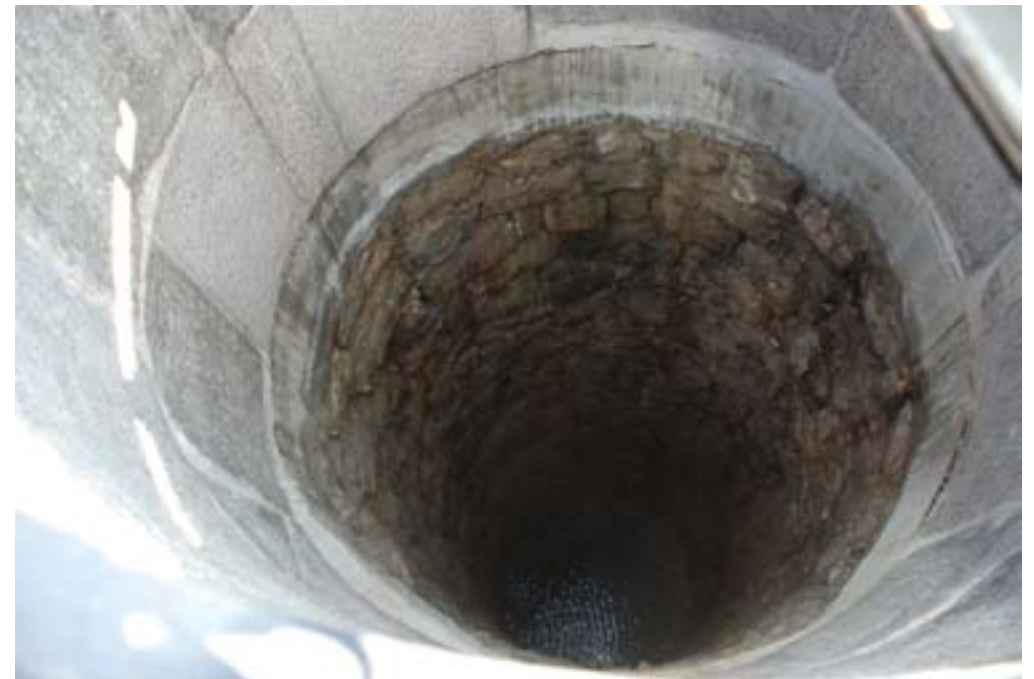
Bilje, Cisterna – podzemni del vodnjaka (foto: A. Ščukovt, 2013)
