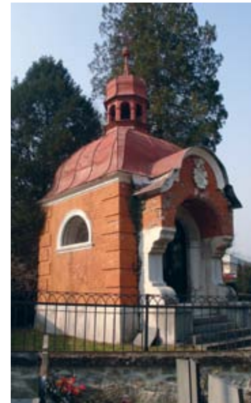
Radeče, pokopališče, pogled na grobno kapelo družine Gutmannsthal pred obnovo (foto: N. Podkrižnik, 2011)
