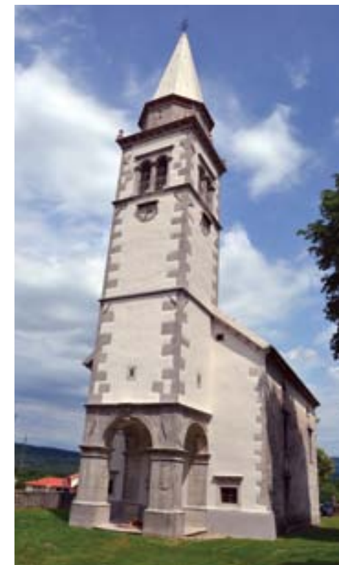
Povir, cerkev sv. Petra, pogled na zvonik in zahodno fasado po opravljenem posegu (foto: M. Osojnik, 2012)
