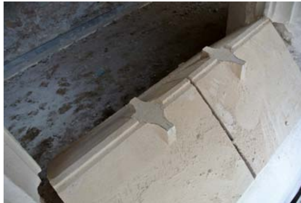
Ptuj, dominikanski samostan, rekonstrukcija gotskih oken, priprava okenske niše (foto: Robert Kuret)
