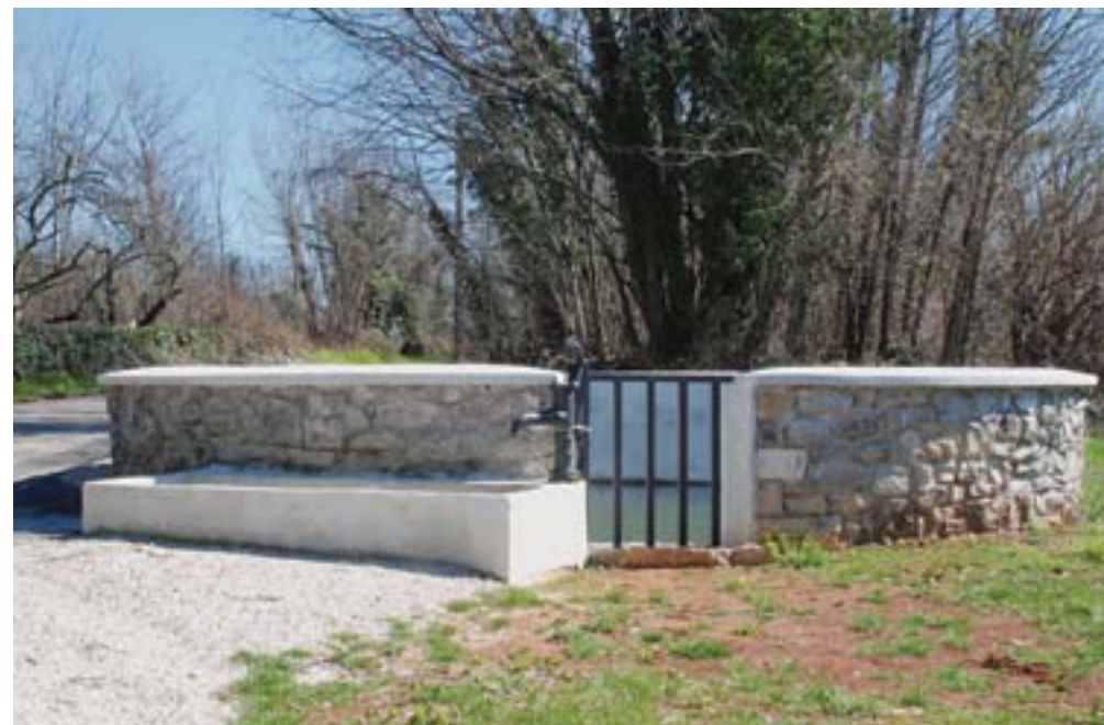
Korita na Krasu, pogled na sanirani zbiralnik vode, ki leži na jugovzhodnem robu vasi (foto: A. Ščukovt, 2013)
