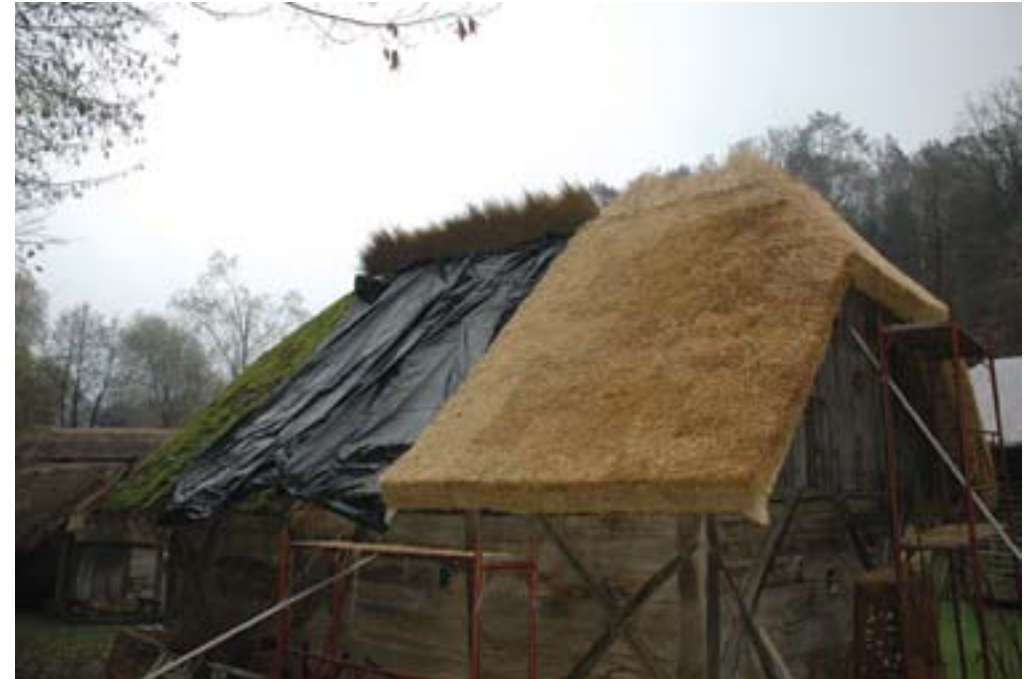
Pleterje, muzej na prostem, zamenjava dotrajane slamnate kritine (foto: D. Strgar)
