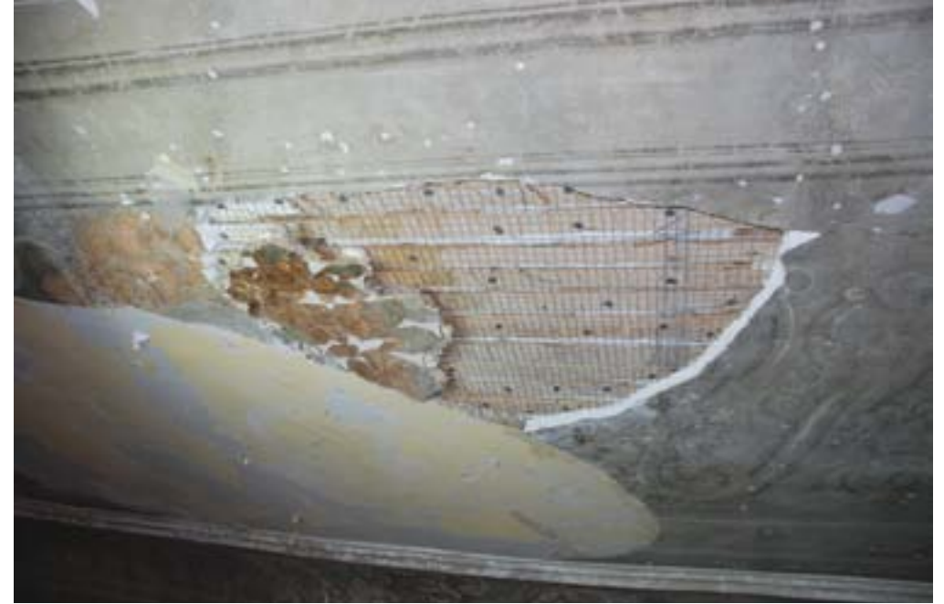
Vipava, Lanthierjeva graščina, strop salona. Detajl vzdolžnega polja med restavratorskimi posegi. Vidni so stara plomba v ometu, vrzel v ometu ter odpadli fragmenti osrednjega okvirja, ki so bili vrnjeni na strop (foto: A. Jazbec 2012).
