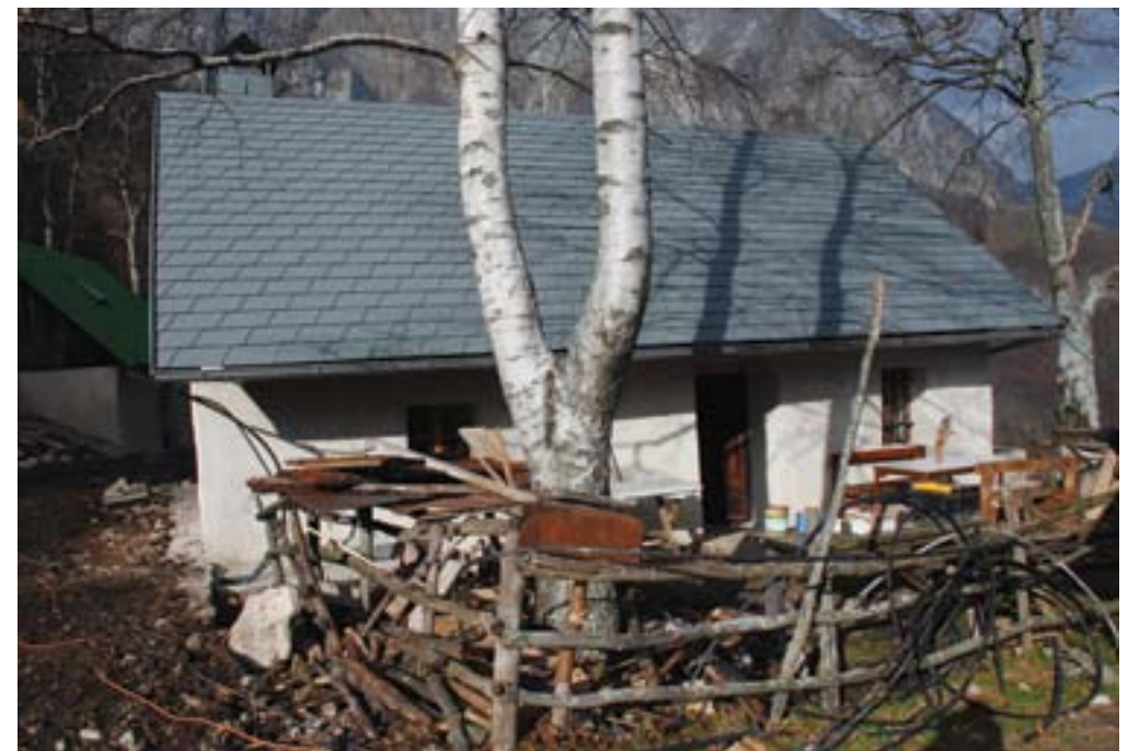
Zatolmin, planina Laška seč, stan po celoviti obnovi (foto: A. Ščukovt, november 2012)
