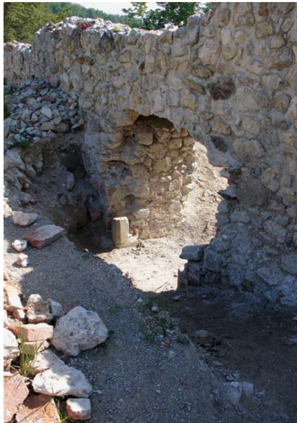
Žovnek, razvaline gradu, nedovoljeni poseg v zemeljske plasti (foto: D. Brišnik)
