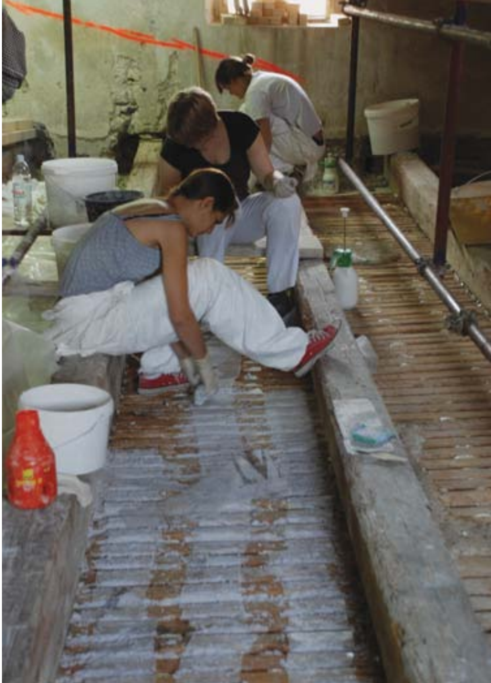
Vipava, Lanthierjeva graščina, utrjevalna dela na podstrešju. Nanos treh pasov mreže in fine apnene malte, med njimi pa nizkoekspanzijska poliuretanska pena (foto: A. Jazbec 2012)
