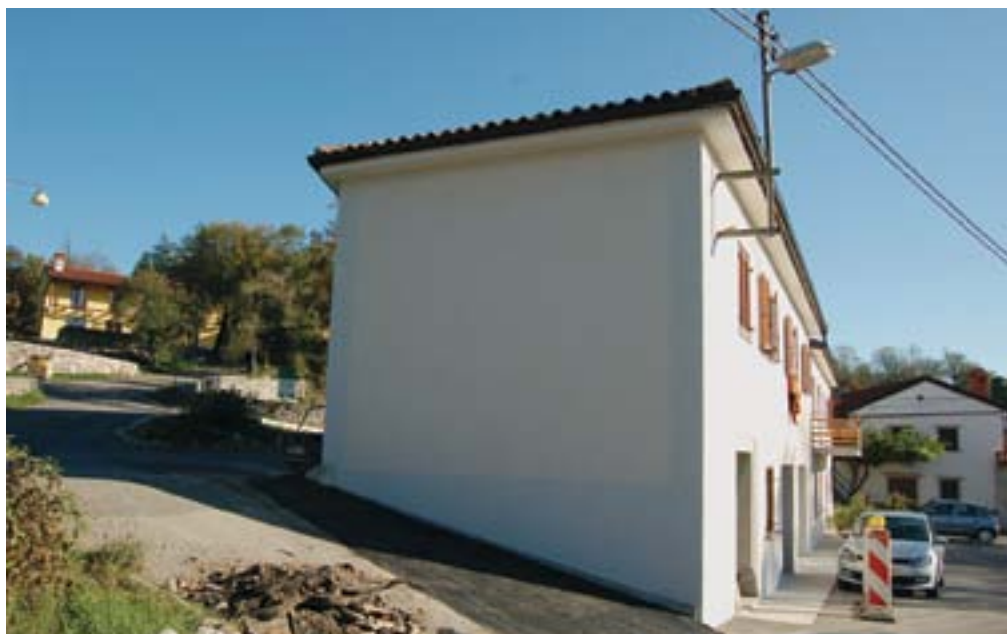
Matavun, domačija Matavun 4; na domačiji so zamenjali dotrajano stavbno pohišstvo in izdelali novo fasado (foto: E. Belingar, 2012).
