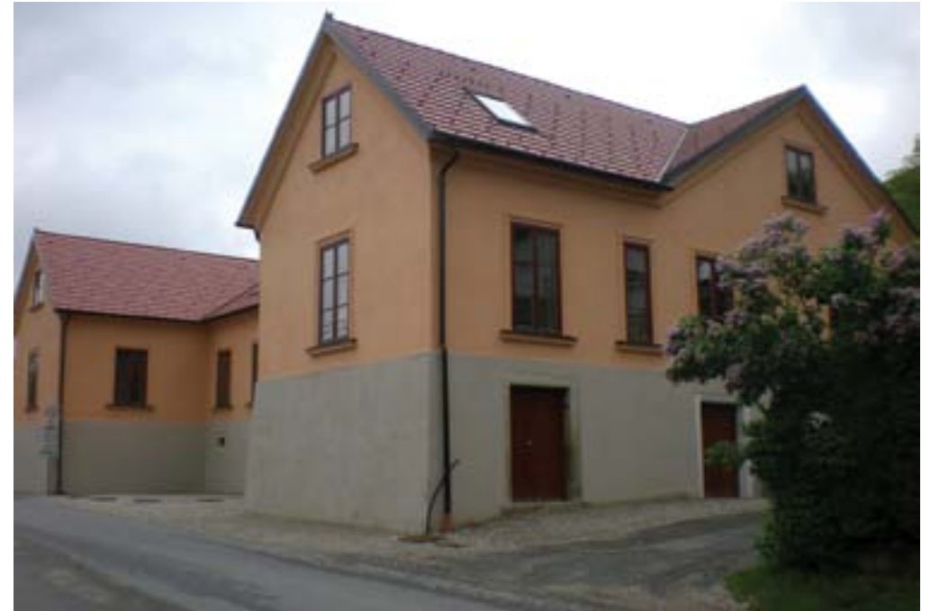
Kamnica, Vrbanska cesta 92, obnovljena južna in vzhodna stran stavbe (foto: J. Skalicky)
