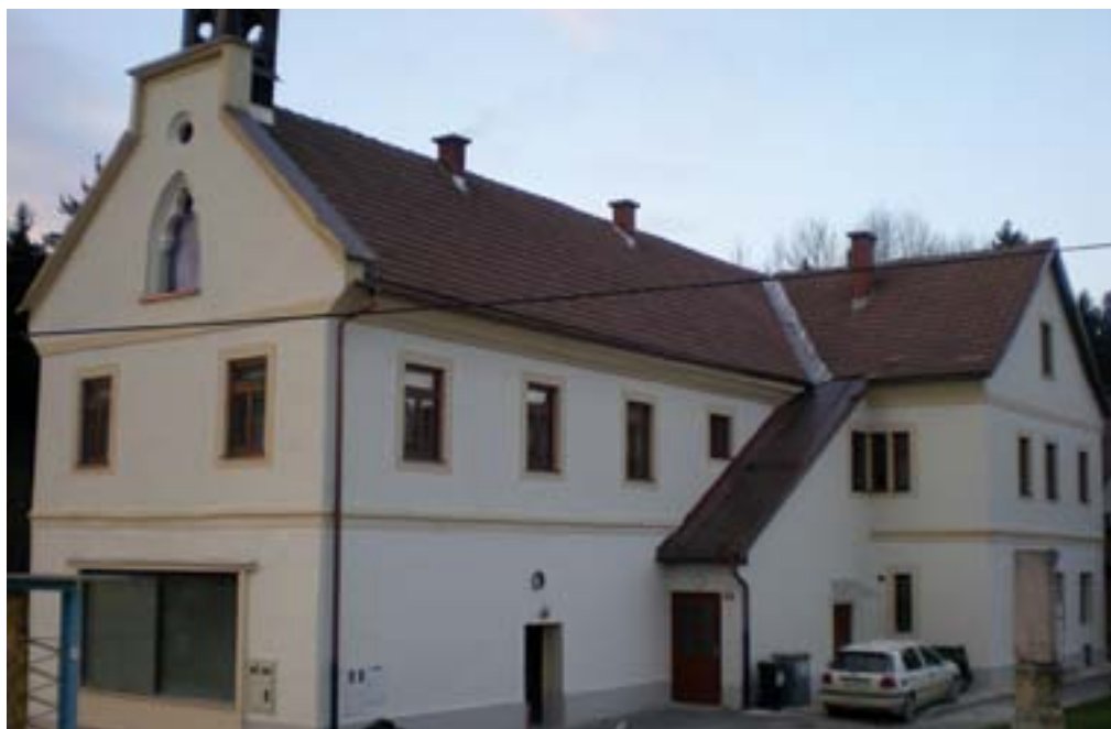
Obnovljena stavba Pozivalnice v Lešah (foto: J. Skalicky, 2012)
