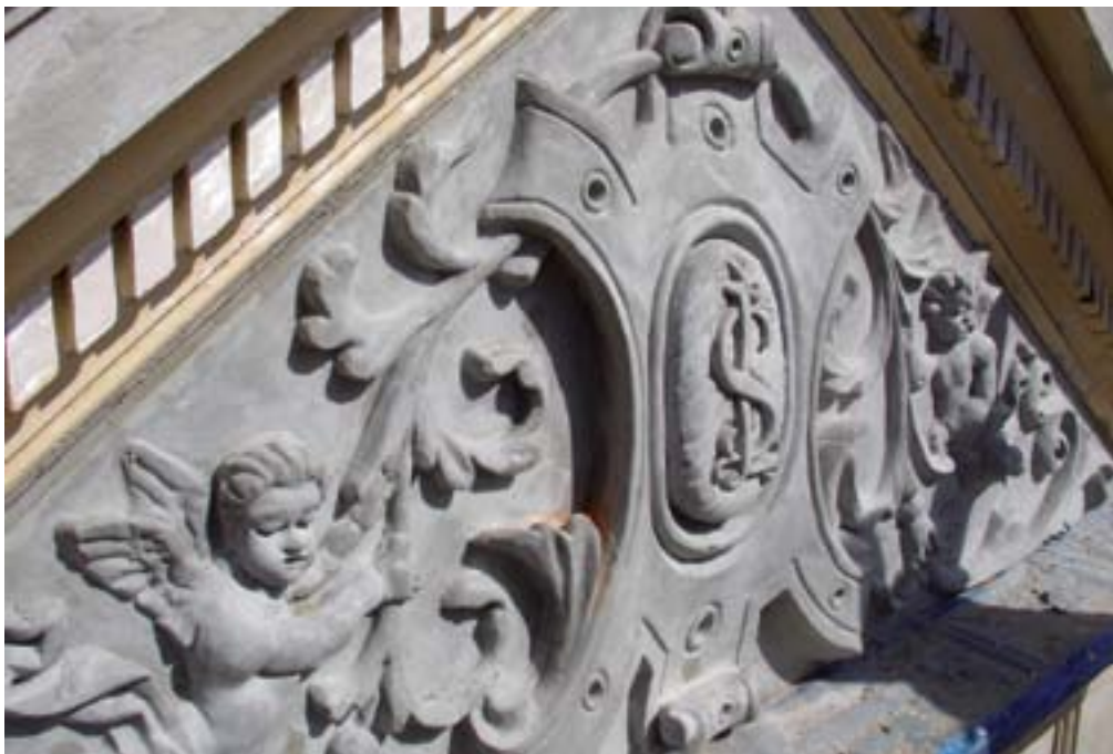
Polzela, stavba Polzela 8, odlitek ornamentike v atičnem zaključku (foto: N. Podkrižnik, 2009)
