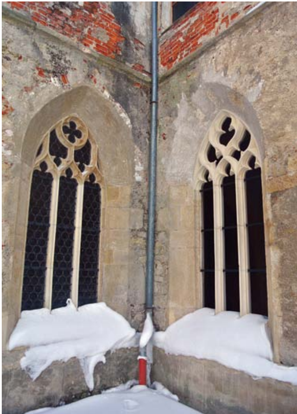
Ptuj, dominikanski samostan, restavrirano in zastekljeno gotsko okno (levo) in rekonstrukcija gotskega okna pred zasteklitvijo (desno) (foto: Nuška Dolenc Kambič)
