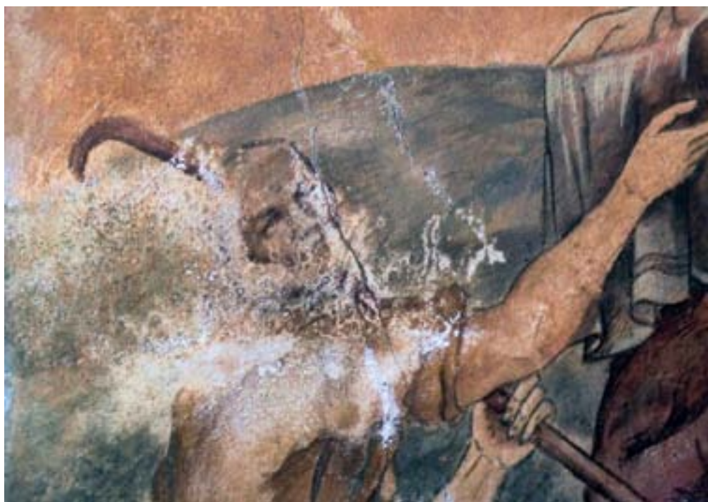
Drežnica, cerkev Srca Jezusovega, poškodbe, nastale zaradi zamakanja (foto: A. Mladenovič, 2012)
