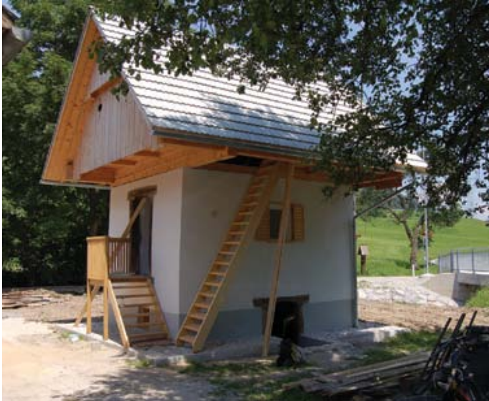
Bela, domačija Bela 18, kašča po obnovi (foto: M. Terceļj Otorepec)
