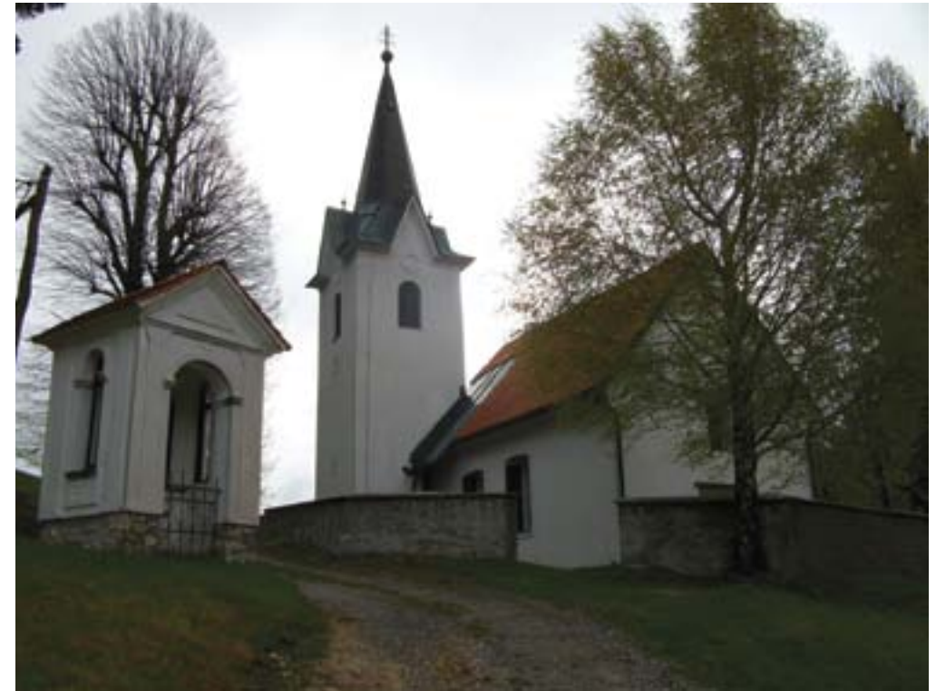
Dobrovlje, cerkev sv. Janeza in Pavla, prenovljena fasada brez izvedenih toniranih elementov arhitekturne členitve (foto: N. Podkrižnik, 2013)
