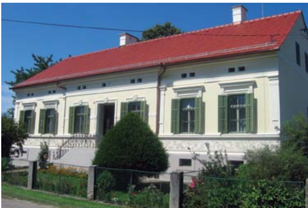
Bunčani, stanovanjska hiša domačije Petovar po obnovi (foto: Suzana Vešligaj, avgust 2012)
