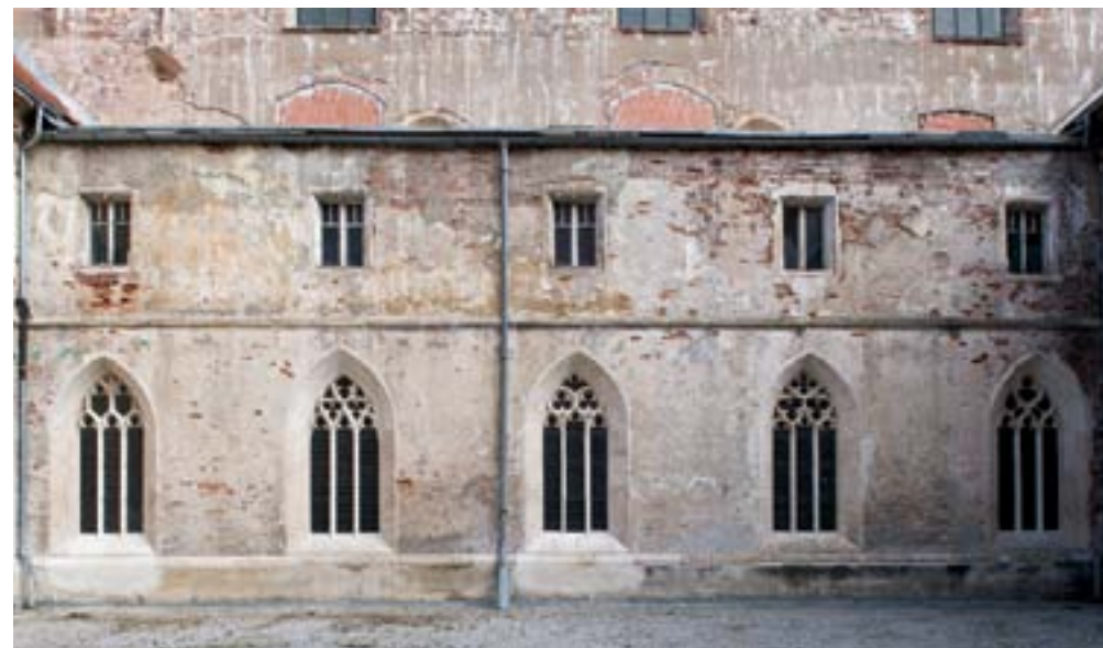
Ptuj, dominikanski samostan, severni krak križnega hodnika po restavriranju okenskih krogovičij in po zasteklitvi (foto: R. Peskar)
