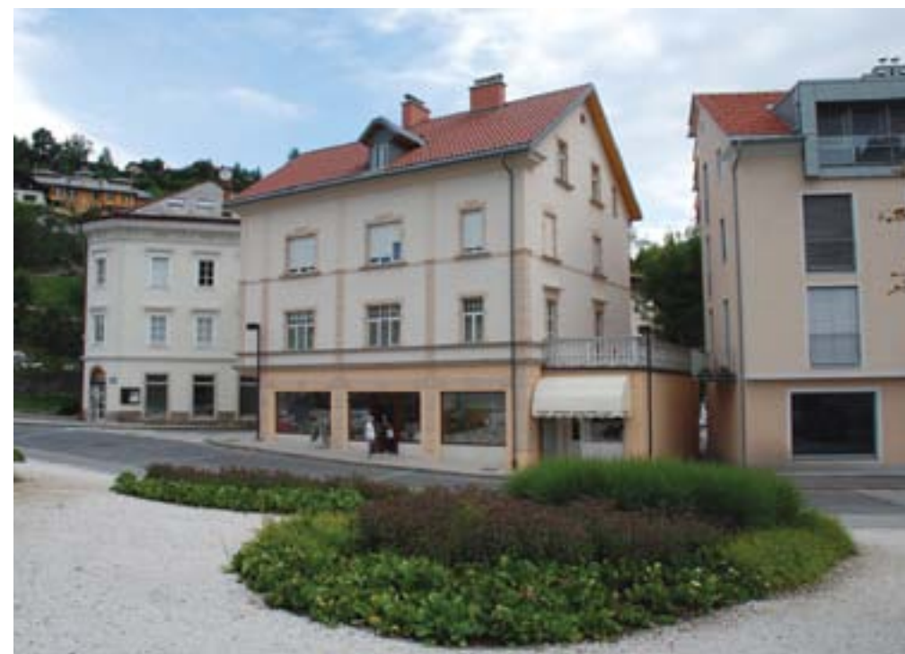
Idrija, objekt Mestni trg 12 po obnovi strehe in fasad (foto: A. Ščukovt, 2012)
