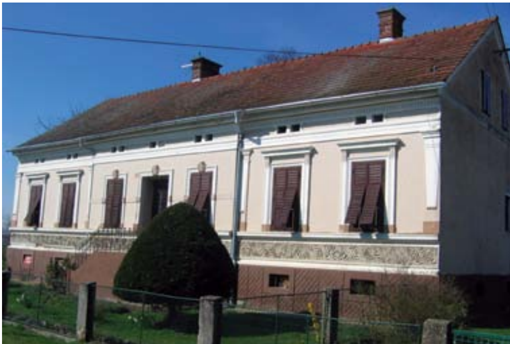
Bunčani, stanovanjska hiša domačije Petovar pred obnovo (foto: Suzana Vešligaj, marec 2008)
