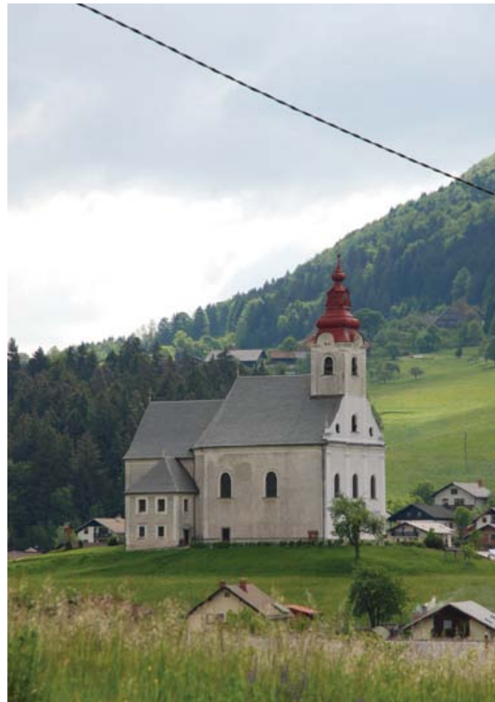
Vitanje, cerkev sv. Marije Pomočnice, pogled na prenovljene strehe (foto: U. Kerbavec, 2012)
