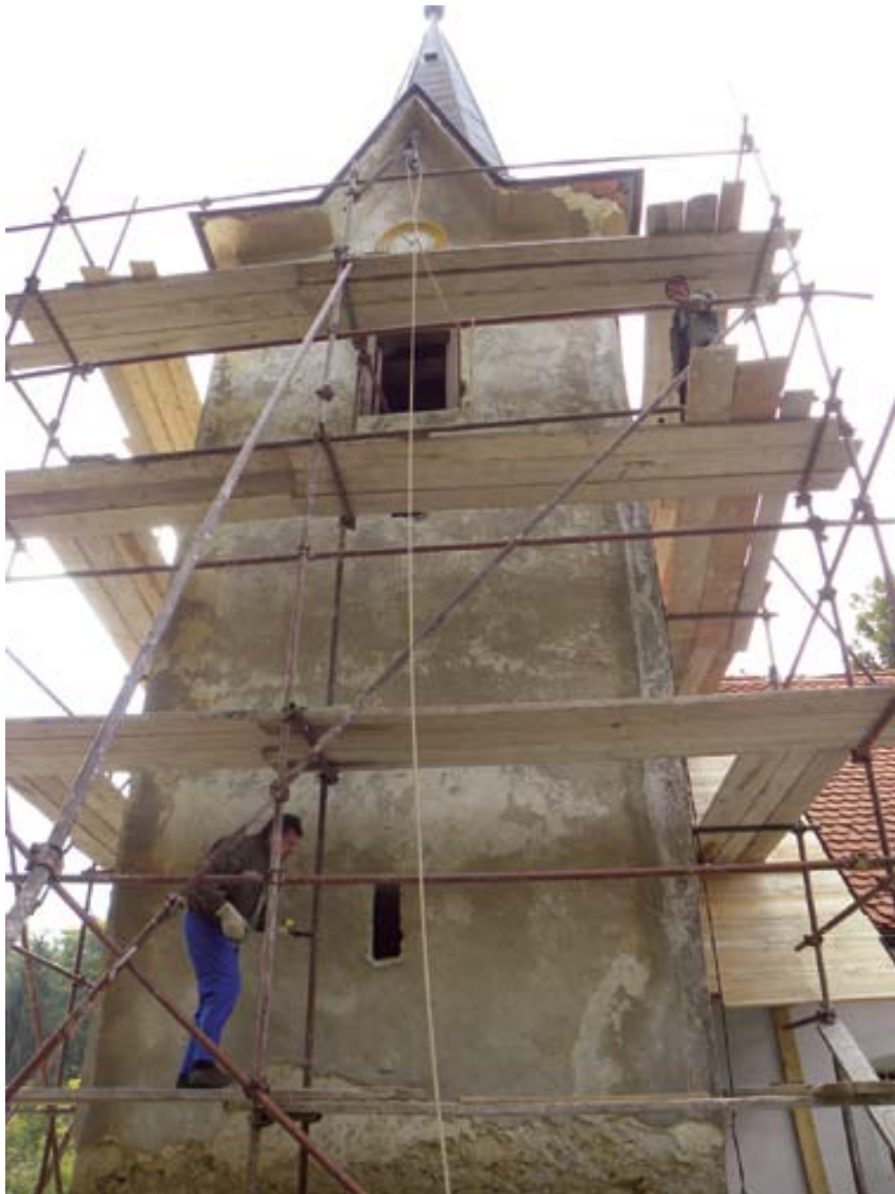
Dobrovlje, cerkev sv. Janeza in Pavla, sondiranje zvonika (foto: N. Podkrižnik, 2010)
