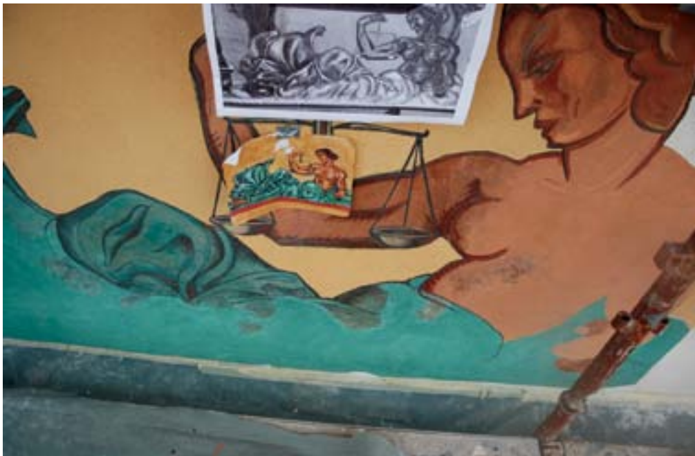
Ljubljana, hiša Prešernova cesta 4, rekonstrukcija poslikave med delom (foto: M. Režek Kambič, 2012)
