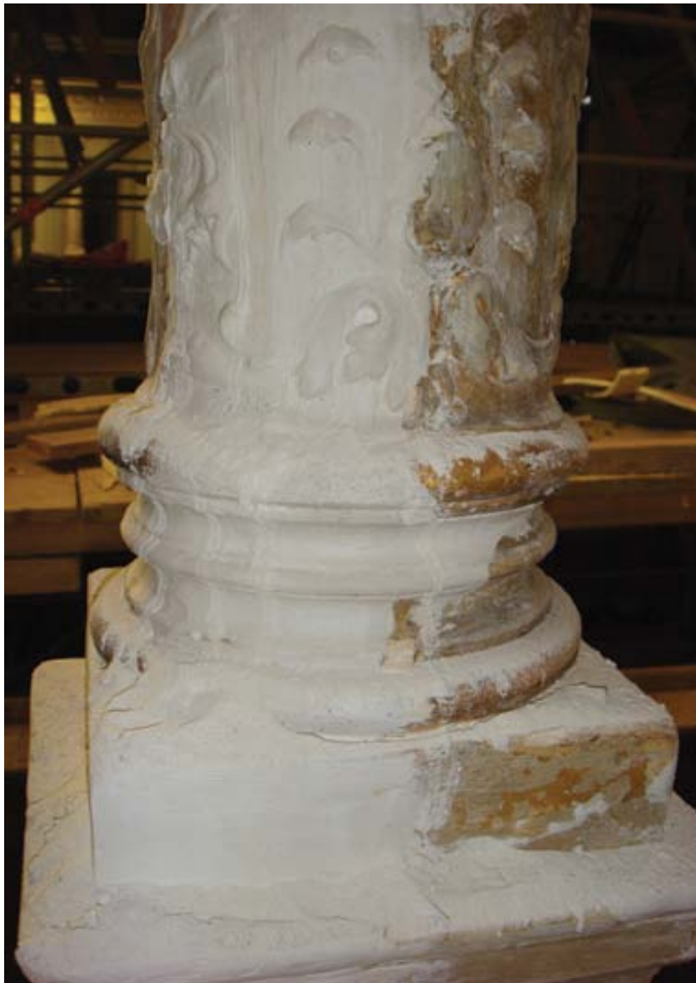
Ljubljana, Opera, rekonstrukcija manjkajočega dela stebra, detajl (foto: S. Dolinšek)
