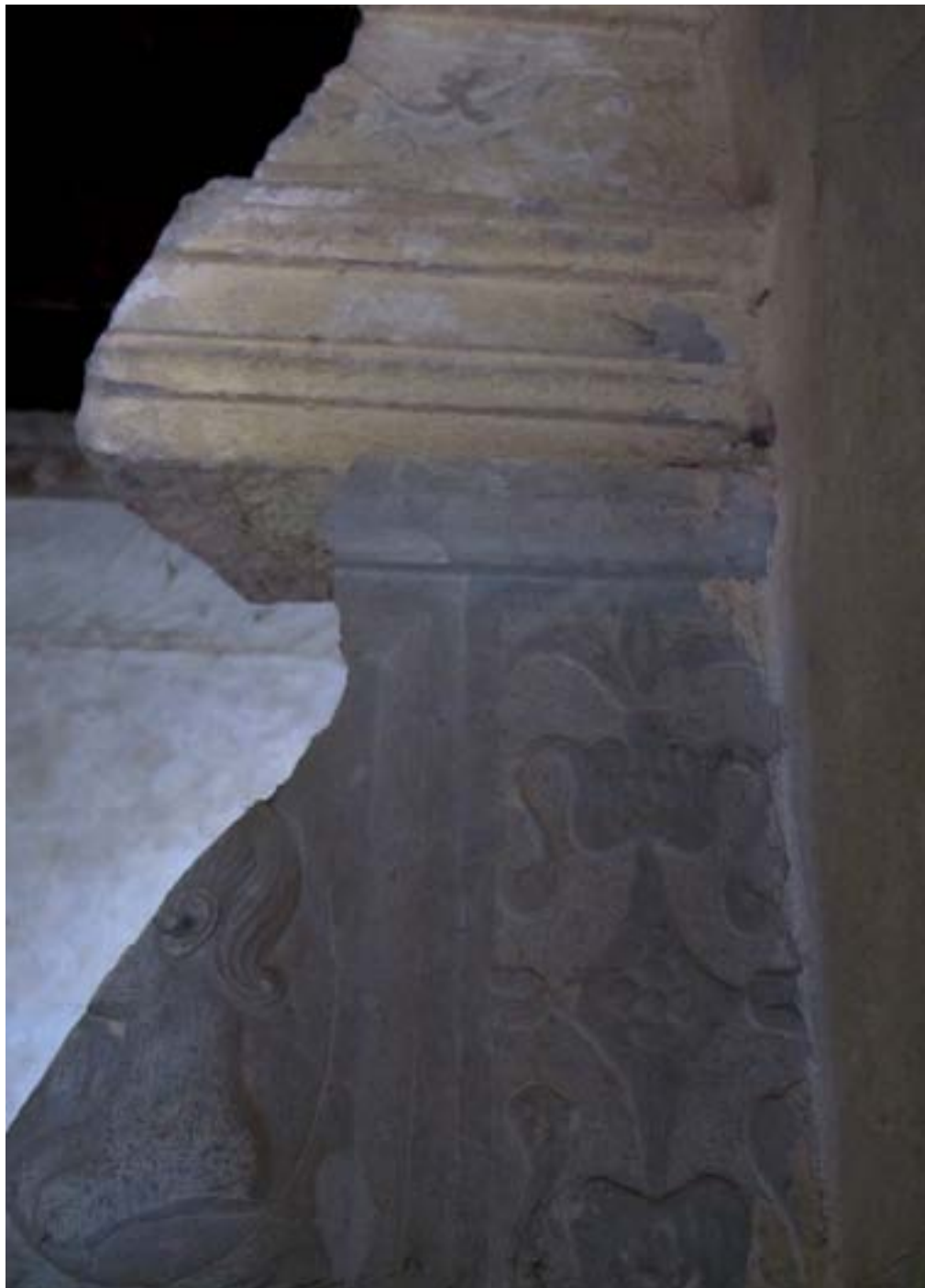
Vipolže, vila Vipolže, detajl fragmentarno ohranjene reliefno oblikovane stranice kamina v nadstropju: v spodnjem delu pod profilom so že odstranjeni sekundarni premazi (foto: Š. Govže).
