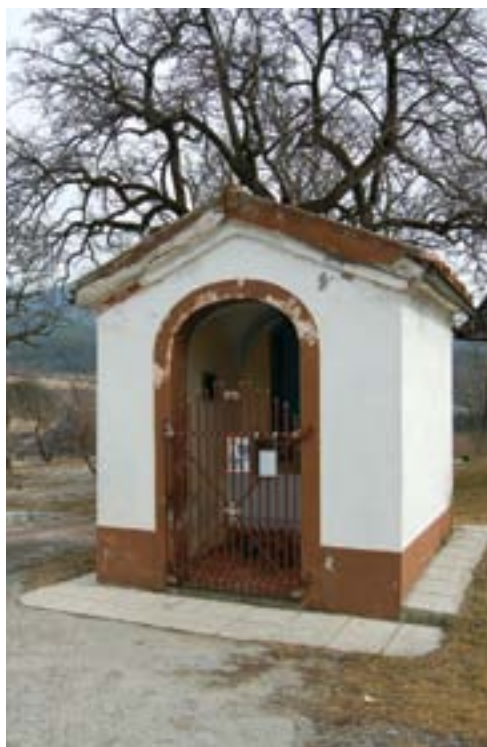
Bukovje, kapelica pred obnovo (foto: E. Belingar, 2012)
