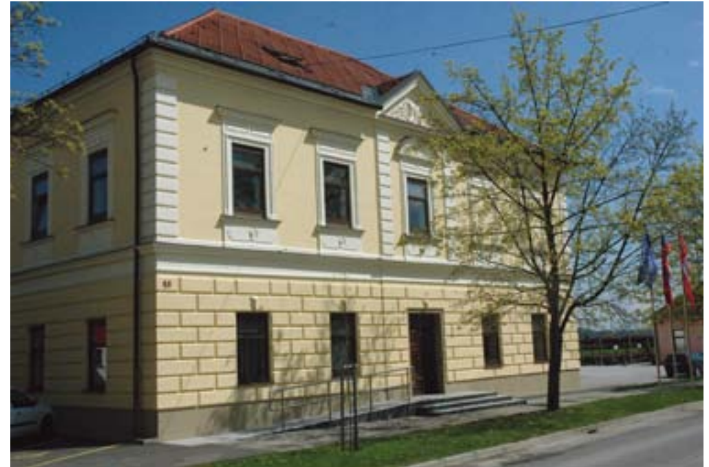
Polzela, stavba Polzela 8, objekt po zaključku obnove (foto: N. Podkrižnik, 2010)
