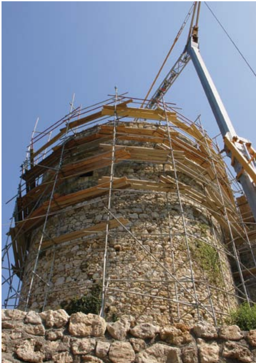
Žovnek, razvaline gradu, začetek obnove okroglega stolpa (foto: M. Plevnik)
