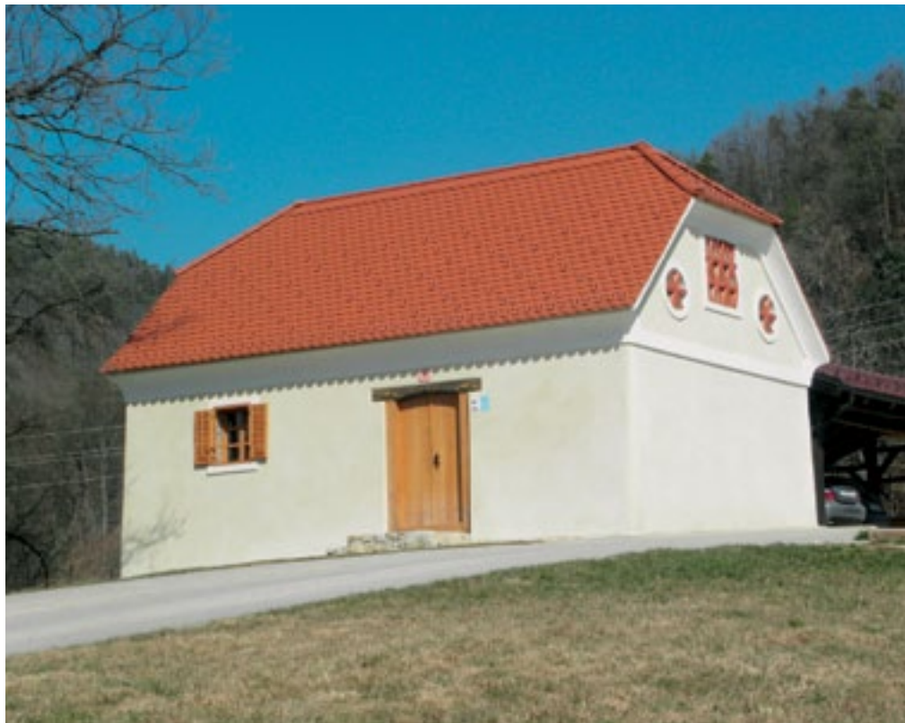
Zidanica Železno 18 po obnovi (foto: B. Hostnik)
