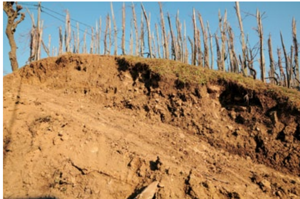
Hmeljčič, gradišče Karlin, pogled na izkop za vodovod čez obzidje z ostanki kamnitega zida (foto: B. Križ)
