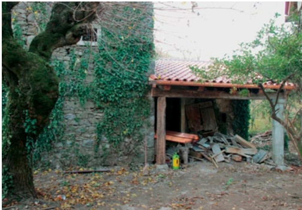
Podraga, domačija Podraga 51, nadstrešek nad vhodnim pročeljem najstarejšega objekta, spodaj vinska klet s faladurjem in letnico 1683 na portalu (foto: A. Ščukovt, november 2011)
