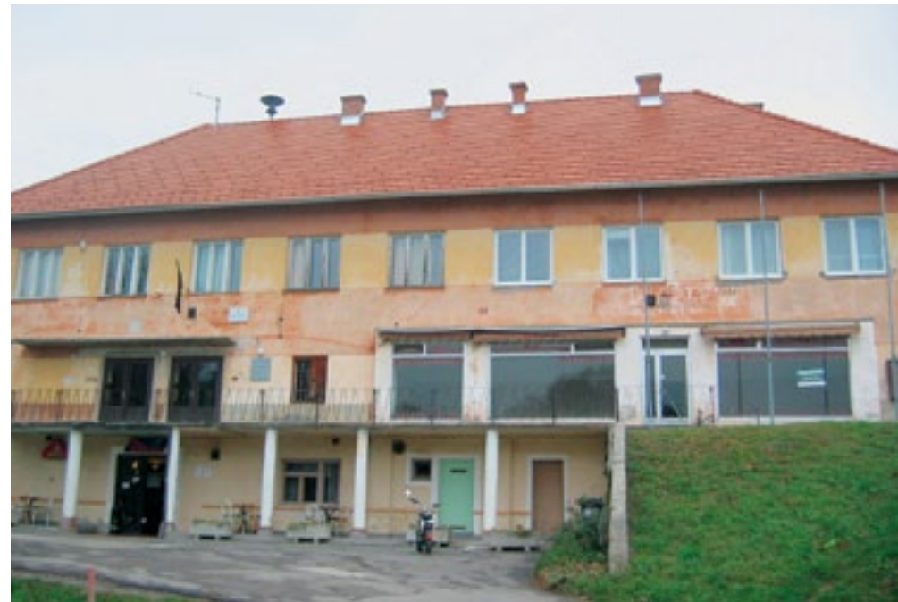
Miklavž pri Ormožu, kulturni dom pred obnovo, november 2008 (foto: S. Vešligaj)
