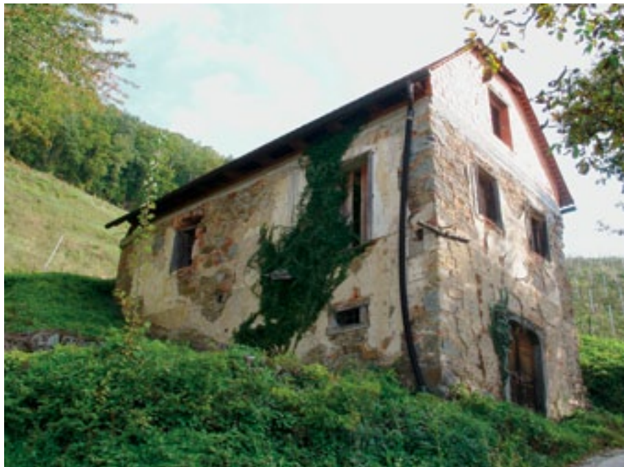
Cerovec pod Bočem, Calska gorca, pred obnovo (foto: T. Hohnec)
