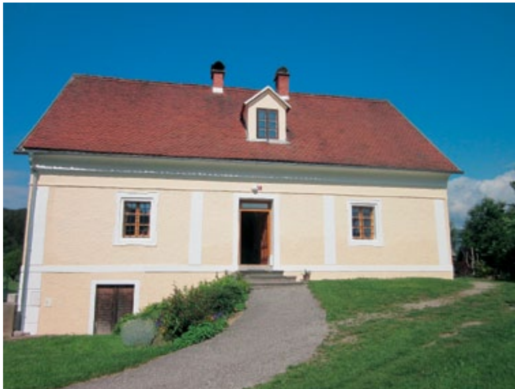
Zupnišče v Vuhredu po obnovi, maj 2011 (foto: L. Medved)
