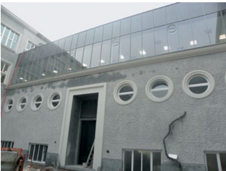
Maribor, južni trakt po posegu (foto: N. Kiš)
