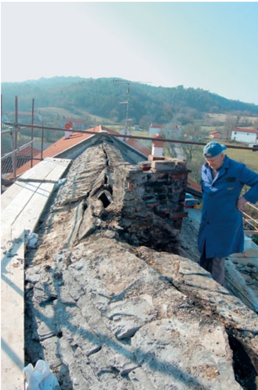
Naklo 14, skrlata streha je bila brez slemena, dimnik je bil dotrajan (foto: E. Belingar, 2011)
