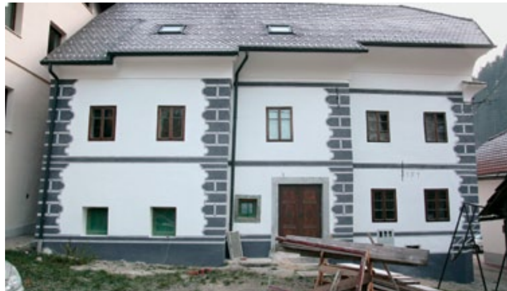
Železniki, hiša Na Plavžu 69 po posegih (foto: A. Klančar Kavčič)
