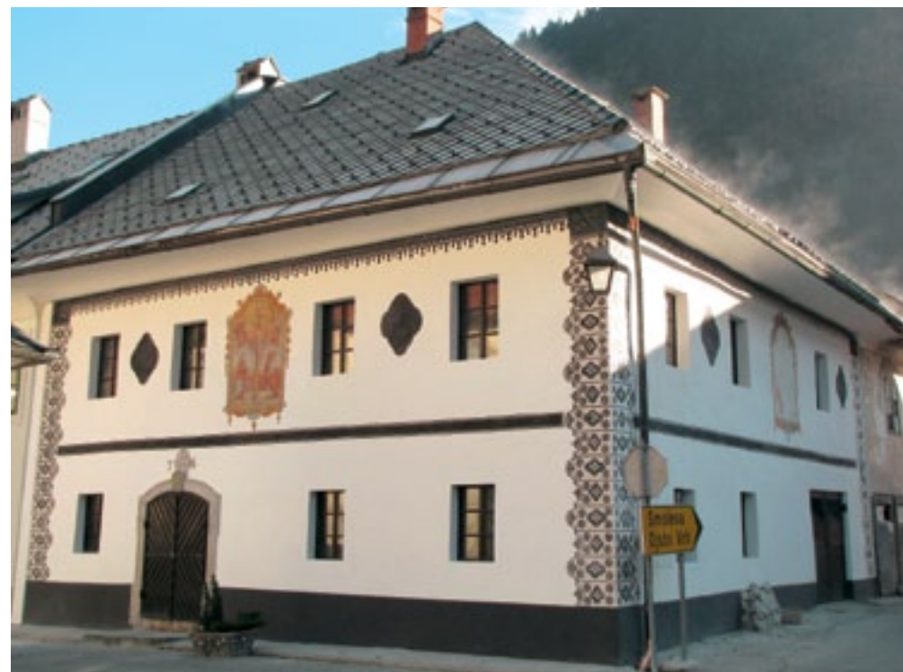
Železniki, fasada hiše Na Plavžu 12 po posegih (foto: A. Klančar Kavčič)
