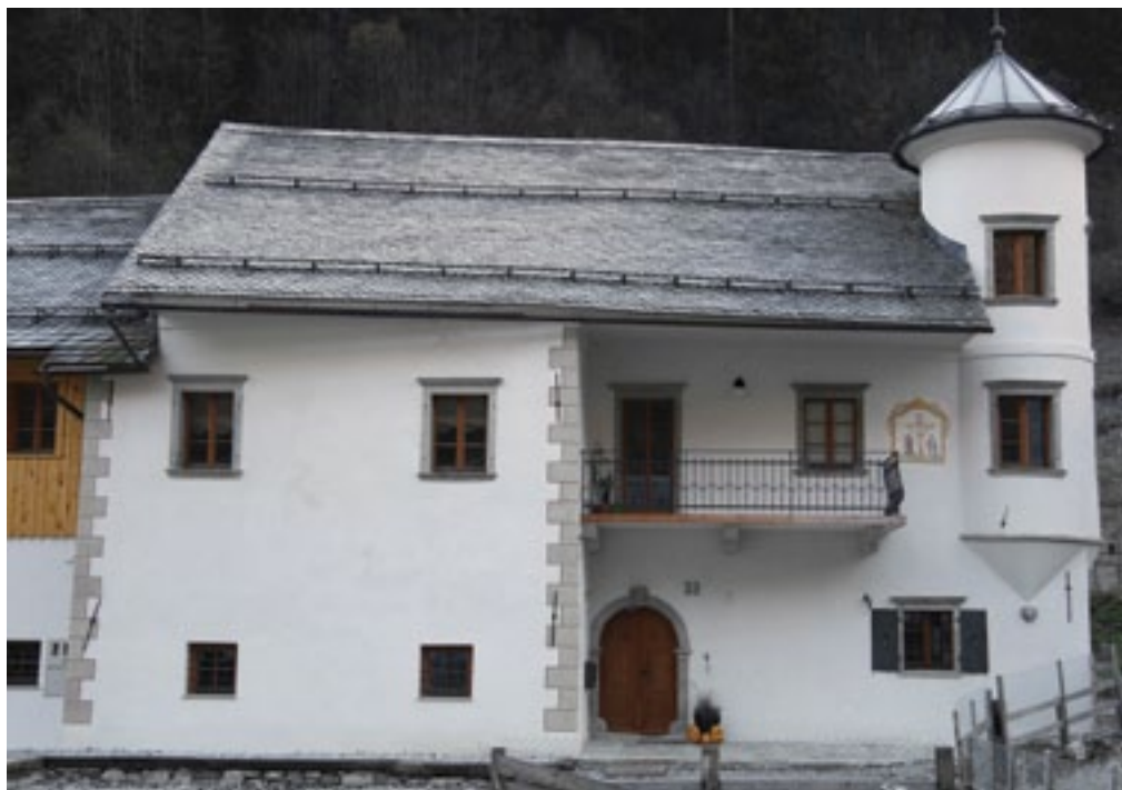
Železniki, hiša Trnje 33 po obnovi (foto: A. Klančar Kavčič)
