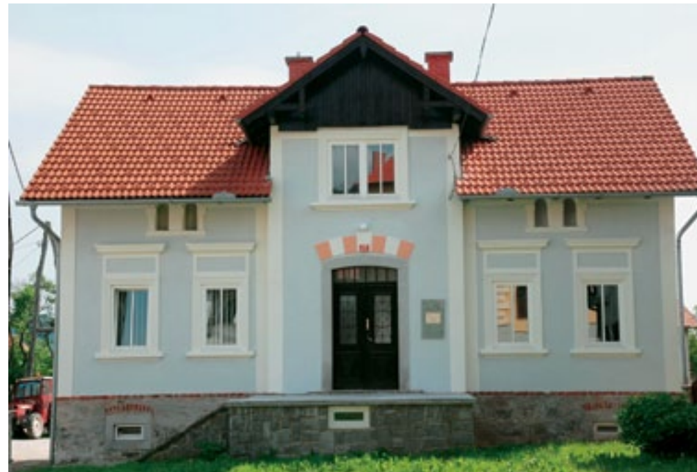
Ribnica na Pohorju, Vicmanova vila po obnovi, junij 2011 (foto: L. Medved)
