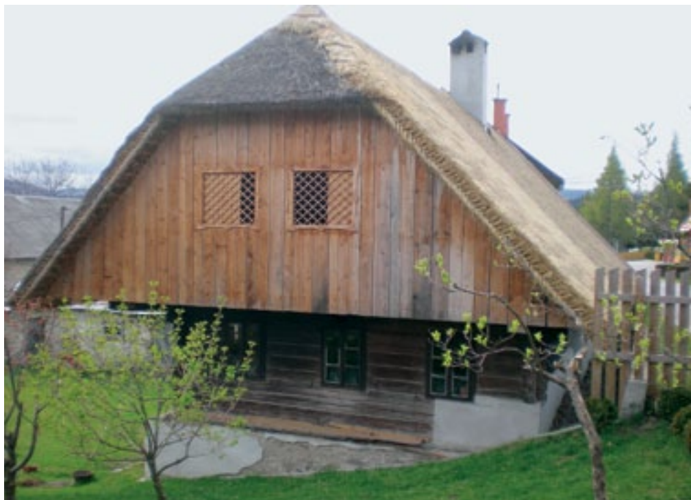
Šmartno na Pohorju 17, obnovljena Marotova hiša z novo slamnato streho (foto: J. Skalicky, 2012)
