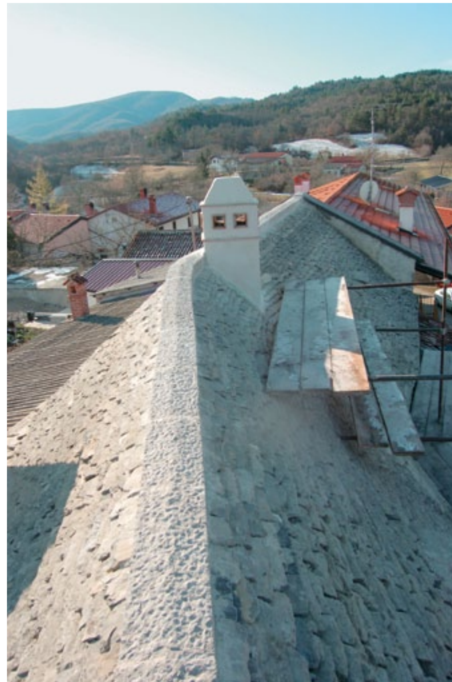
Naklo 14, streha po izvedbi gradbenih del (foto: E. Belingar, 2011)
