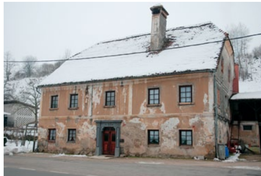
Verpete 14, hiša pred obnovo (foto: B. Hostnik)
