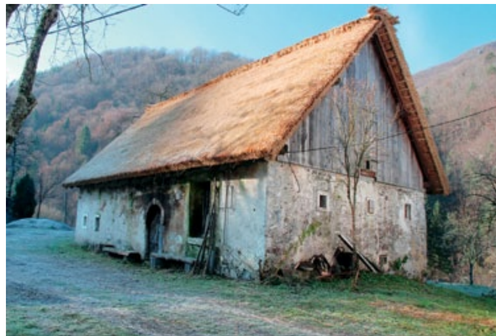
Gorenja Trebuša, domačija Gorenja Trebuša 112, 113, hiša po prekritju strehe s slamo (foto: A. Ščukovt, november 2011)
