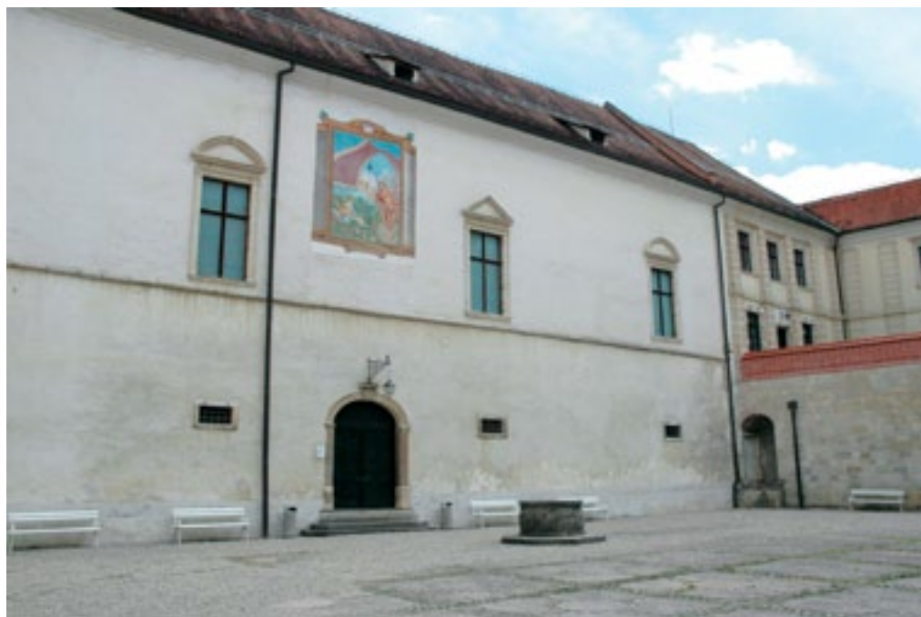
Grad Brežice, dvoriščna fasada vzhodnega stanja pred obnovo (foto: T. Golob, 2010)
