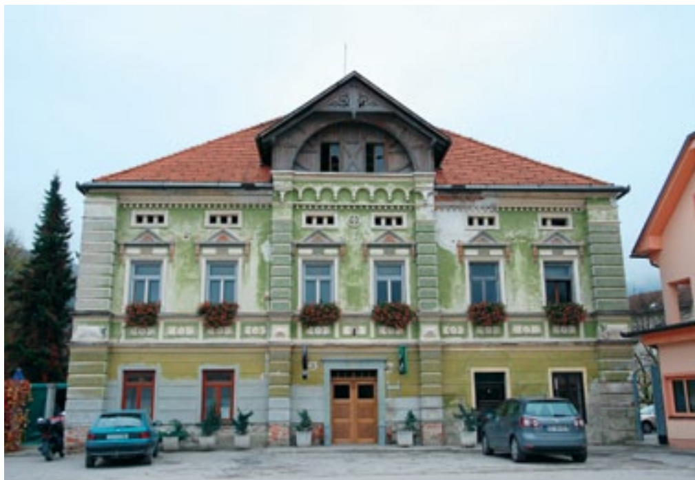
Nazarje, Bohačeva gostilna pred obnovo (foto: U. Kerbavec, 2008)
