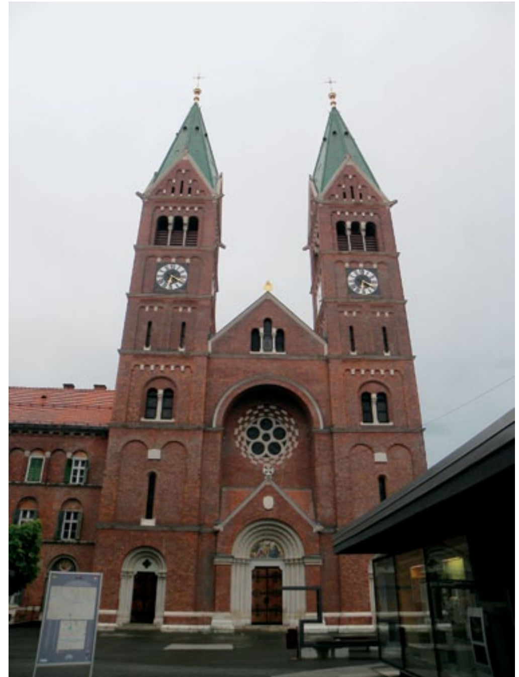
Maribor, frančiškanski samostan, vzhodna fasada po obnovi (foto: N. Nahtigal)
