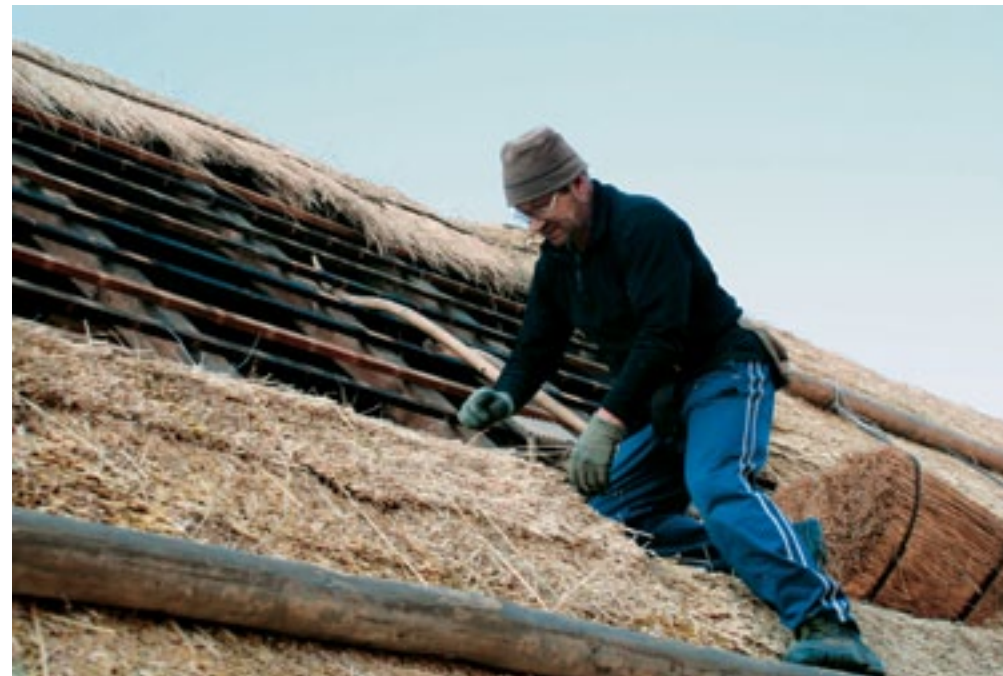
Gorenja Trebuša, domačija Gorenja Trebuša 112, 113; Slavko Šortli med pokrivanjem strehe s slamo (foto: A. Ščukovt, november 2011)
