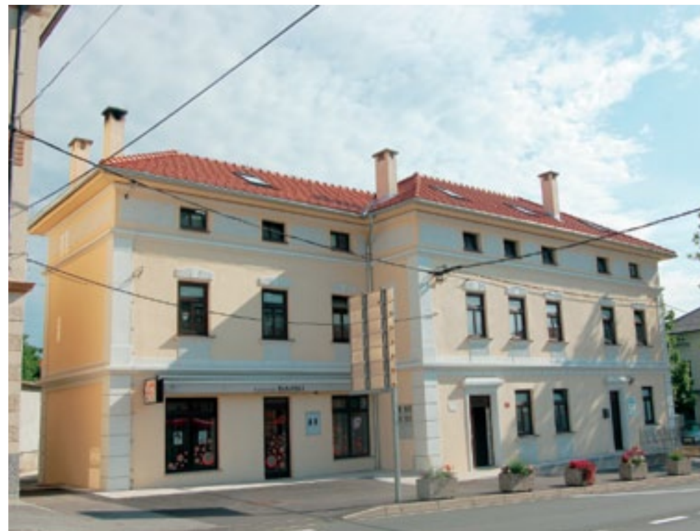
Pivka, Kolodvorska cesta 4, objekt po izvedeni rekonstrukciji strehe in fasade (foto: E. Belingar, 2012)
