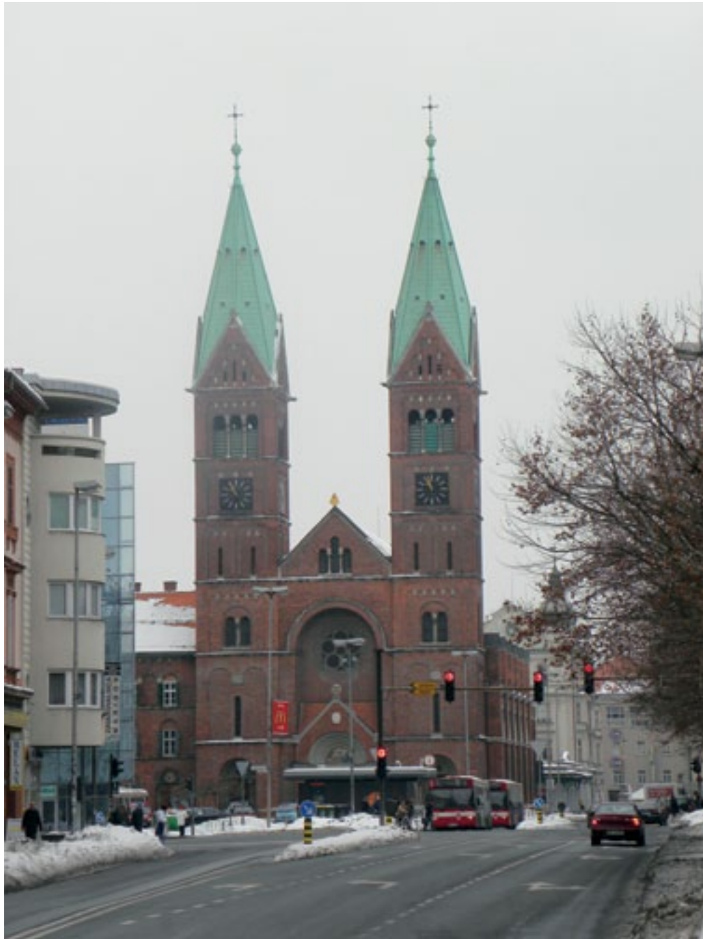
Maribor, frančiškanski samostan, vzhodna fasada pred obnovo (foto: N. Nahtigal)
