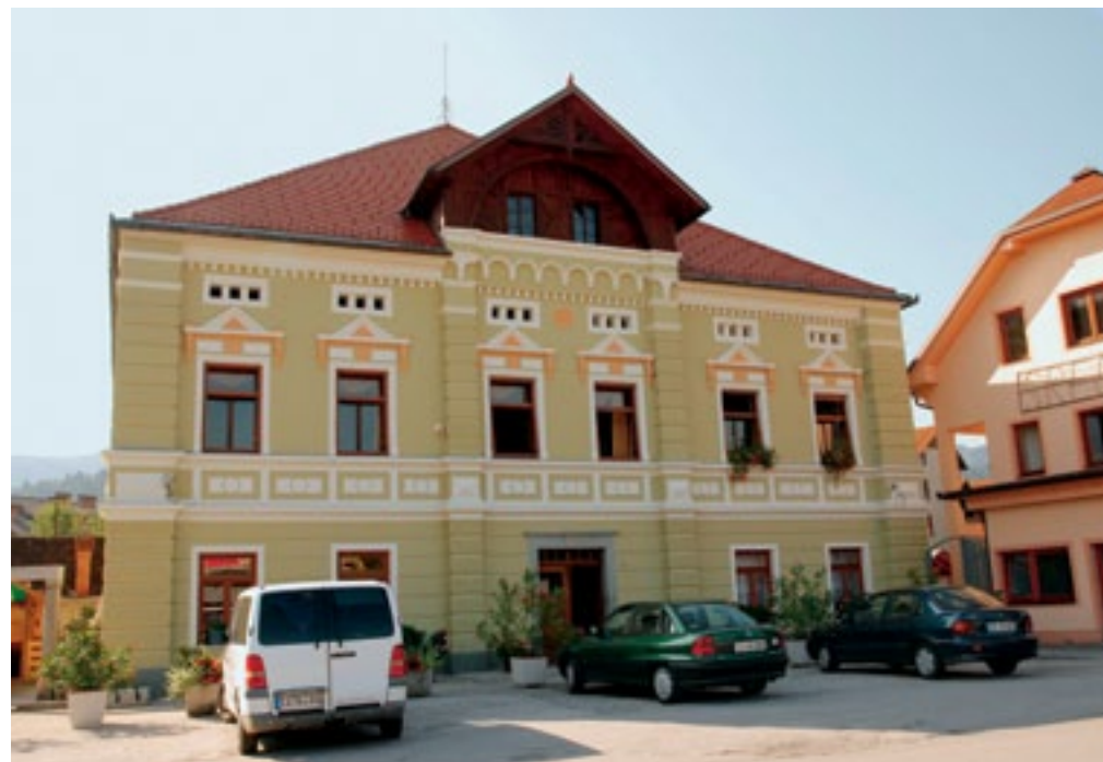
Nazarje, Bohačeva gostilna po obnovi (foto: U. Kerbavec, 2011)
