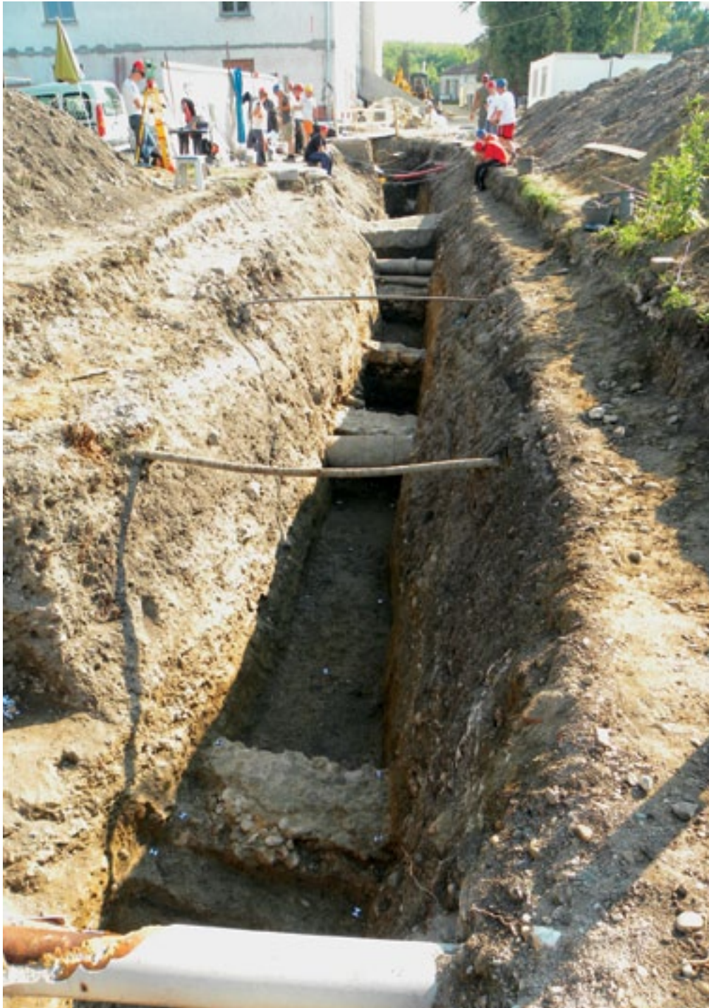
Ptuj, vojašnica, objekt 2, pogled na arheološke strukture na območju izkopa za meteorno kanalizacijo (foto: E. Lazar)
