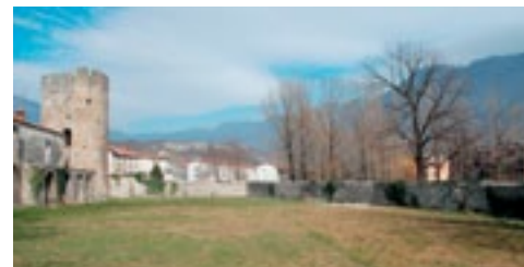
Ajdovščina, nekdanji grajski vrt s ponovno pozidanim kamnitim zidom (foto: A. Ščukovt, marec 2011)
