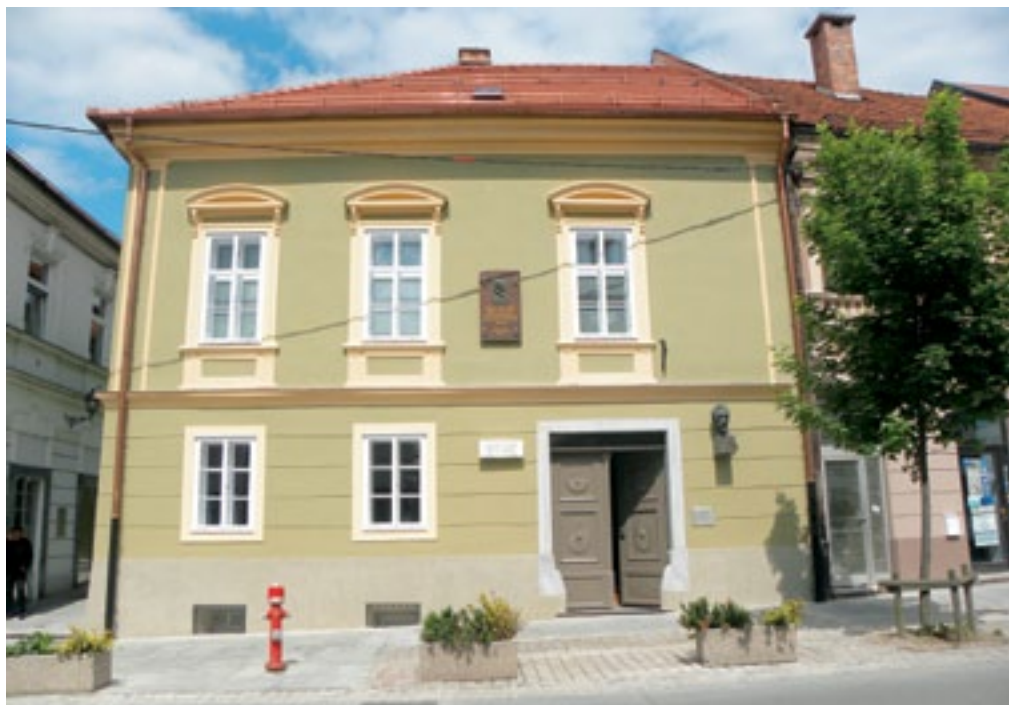
Slovenj Gradec, hiša Glavni trg 40, ulična fasada po obnovi (foto: S. Kurelac)
