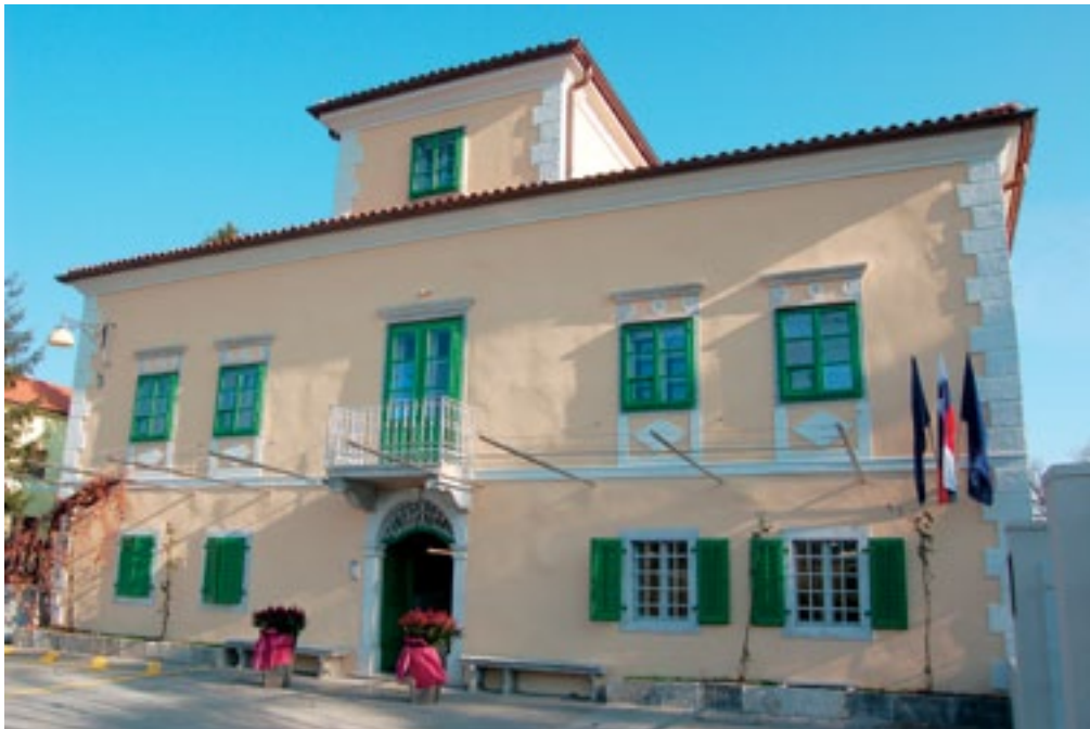
Domačija Matavun 8, posebna pozornost je bila posvečena izdelavi dekorativnih elementov fasade. Zunanjščina vhodne fasade na dan slovesnega odprtja prenovljenega objekta 25. novembra 2011 (foto: E. Belingar, 2011)
