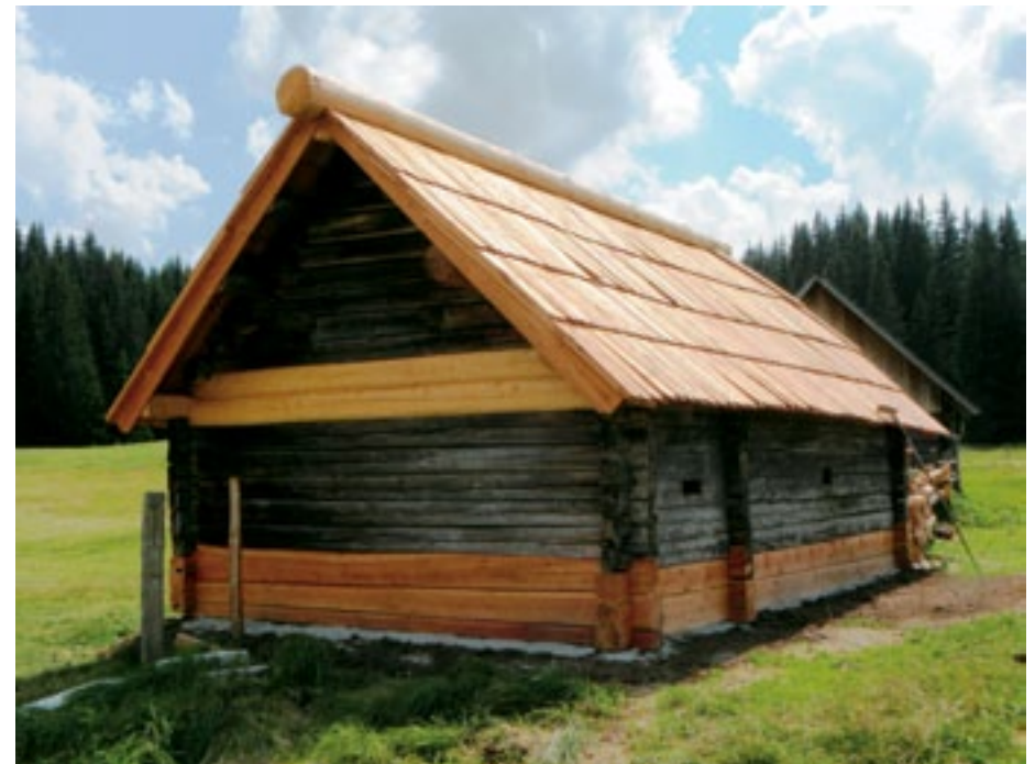
Goreljek, Knoflov stan: zadnja stran stanu po opravljenih delih (foto: S. Roškar)
