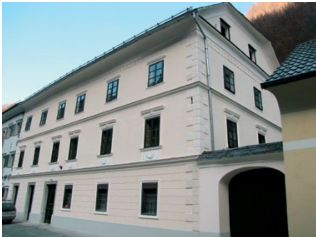
Železniki, hiša Na Plavžu 57 po obnovi (foto: A. Klančar Kavčič)
