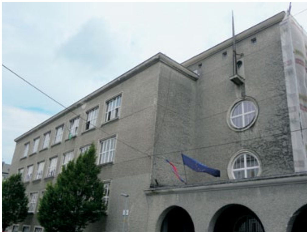
Maribor, mestna in meščanska šola, Žolgarjeva ulica 2–4, del glavne fasade pred obnovo (foto: N. Kiš)
