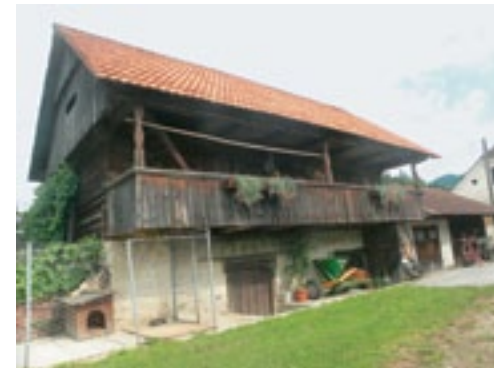
Juvanje 11, kašča pred obnovo (foto: B. Hostnik)
