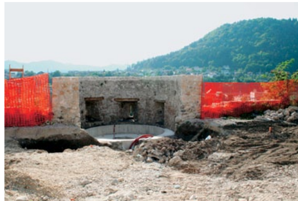
Kranj, izkopno polje ob rekonstruiranem srednjeveškem stolpu, v ozadju Šmarjeta gora (foto: M. Urek)
