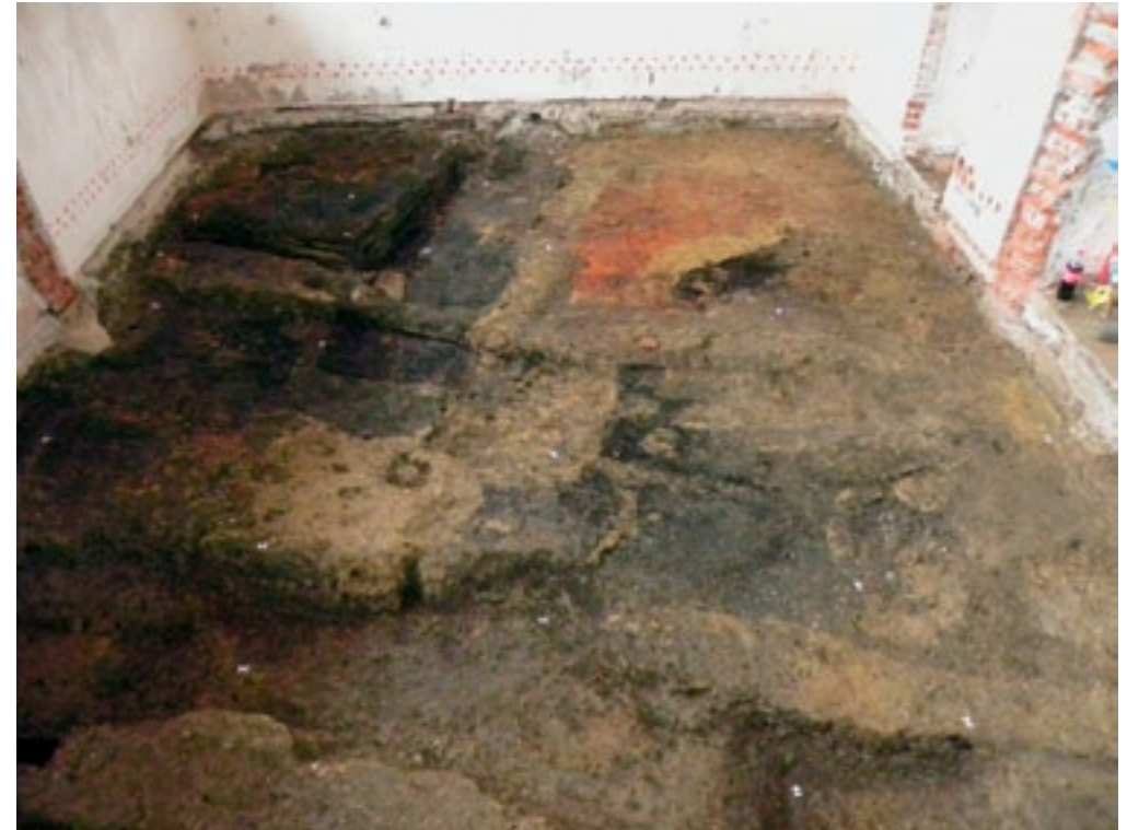
Ptuj, vojašnica, objekt 2, pogled na ostanke lesene gradnje v severovzhodnem koncu objekta (foto: D. Kovačič)
