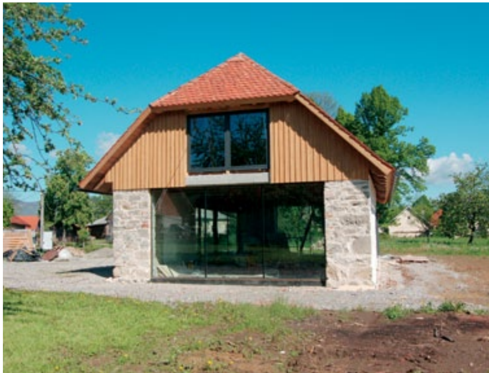
Grobišče 11, odprtine skednja so zaprte s steklenimi površinami (foto: E. Belingar, 2012)
