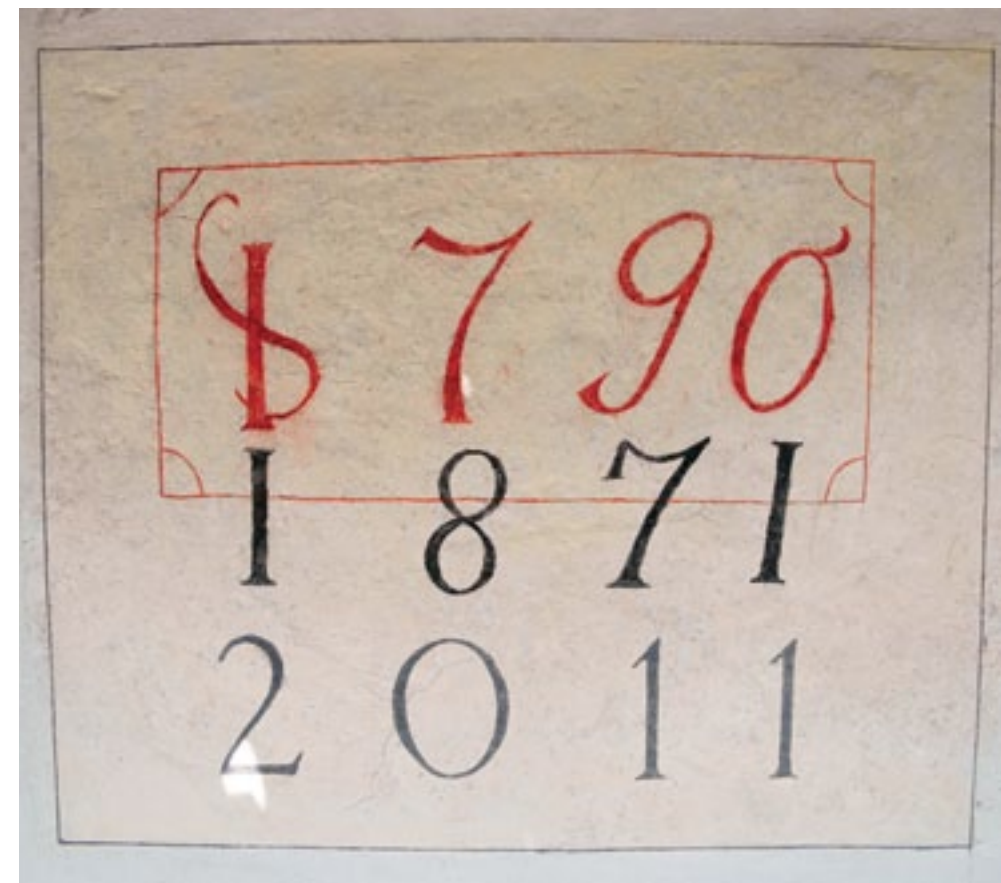
Brezen, cerkev sv. Antona, restavratorsko obnovljeni del originalnega ometa z zapisom letnic na južni kapeli (foto: U. Kerbavec, 2011)
