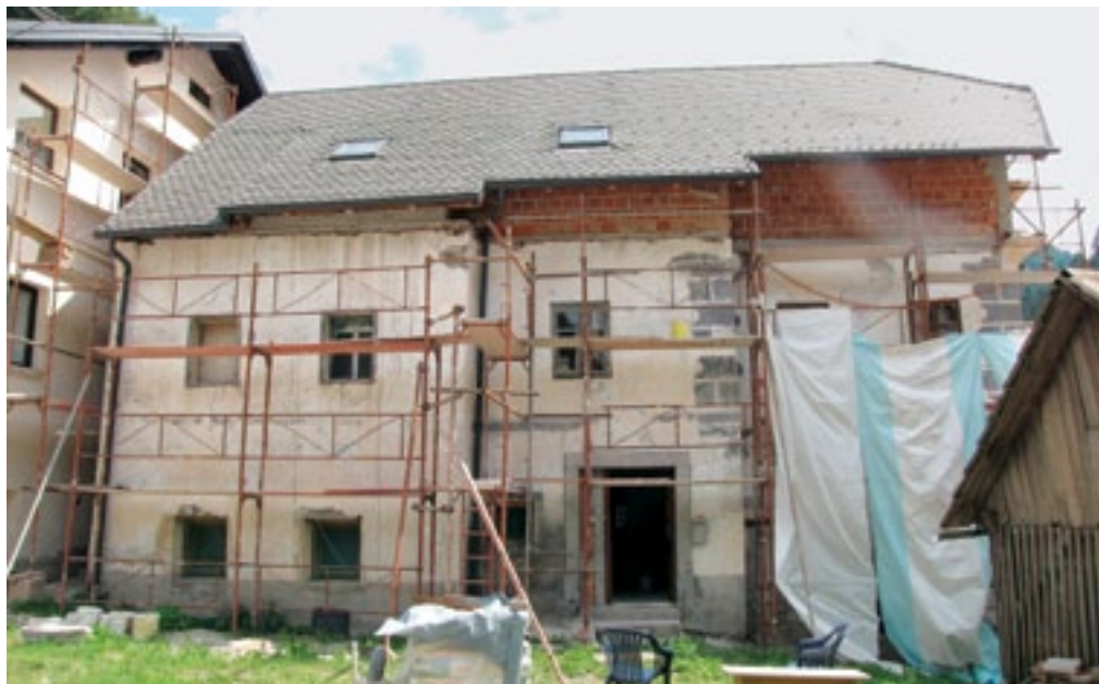
Železniki, hiša Na Plavžu 69 pred posegi (foto: A. Klančar Kavčič)
