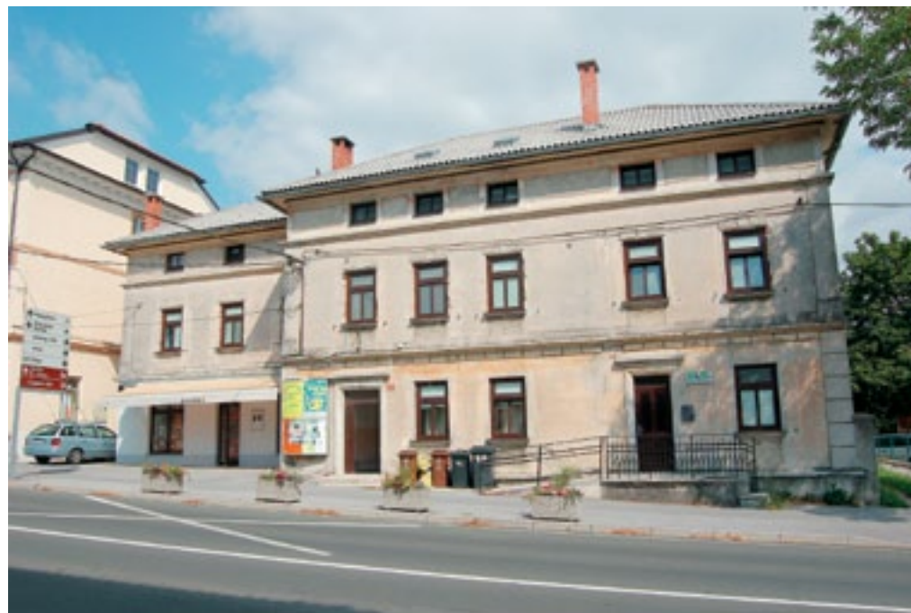
Pivka, Kolodvorska cesta 4, objekt pred prenovom v letu 2011 (foto: E. Belingar, 2011)
