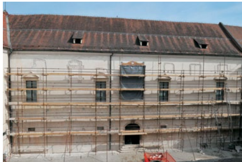
Grad Brežice, sanacija dvoriščne fasade in zazidanih oken iz časa pred izgradnjo viteške dvorane v začetku 18. stoletja (foto: T. Golob, 2011)
