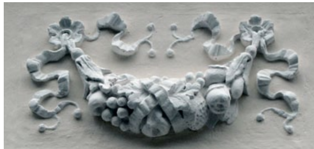
Železniki, hiša Na Plavžu 57, detajl po obnovi (foto: A. Klančar Kavčič)
