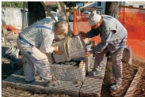
Voglje na krasu, zlaganje oštevilčenih kamnitih blokov na prej pripravljen in utrjen temelj (foto: E. Belingar)
