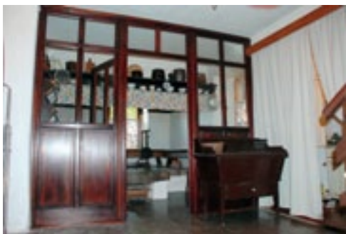
Kambreško 15, nova lesena predelna stena v kuhinji z ognjiščem (foto: A. Ščukovt, julij 2011)
