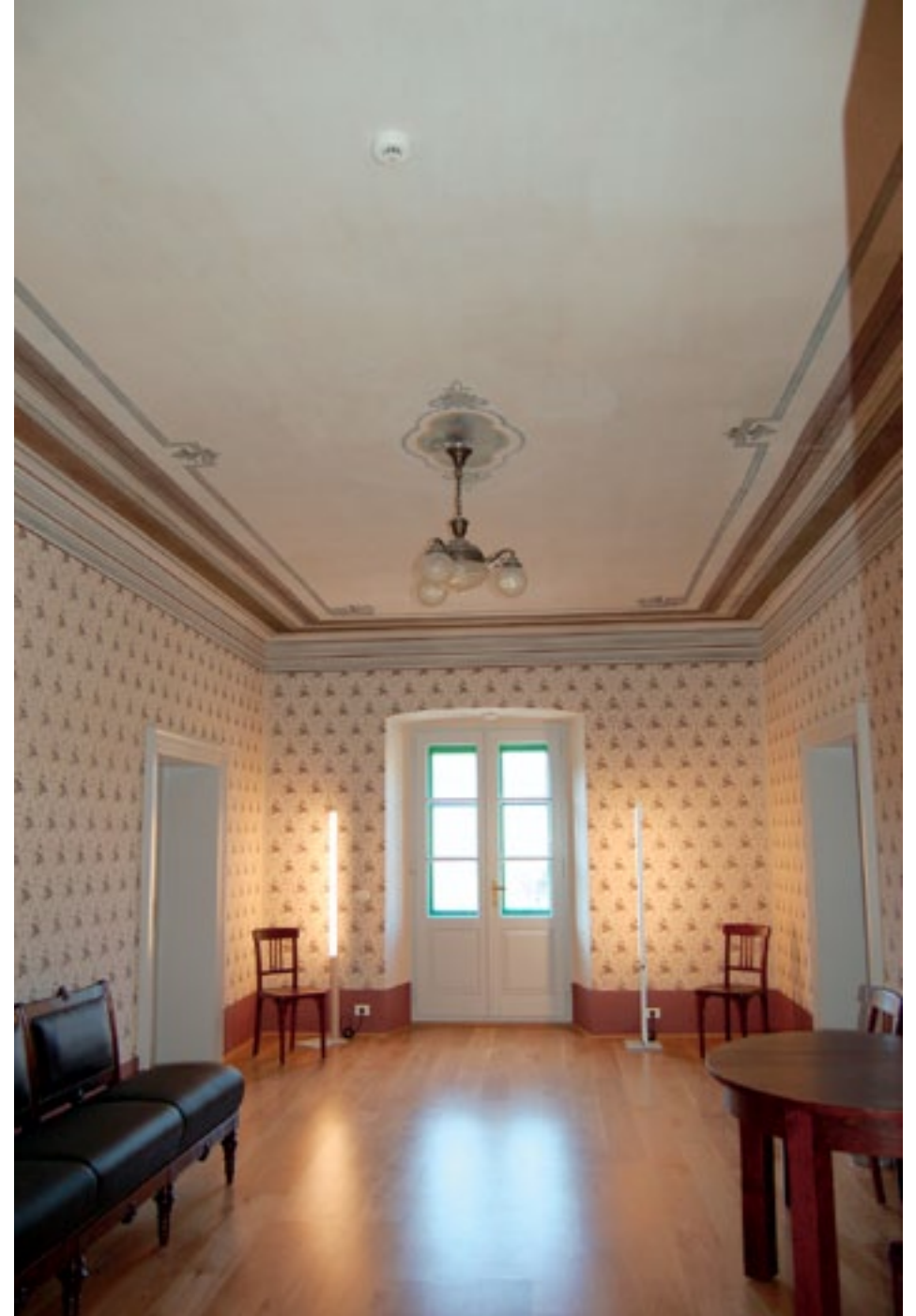
Domačija Matavun 8, salon po dokončanju del in namestitvi opreme. Strop se je restavriral na svojem mestu, stene so s šablono poslikane na novo (foto: E. Belingar, 2011)
