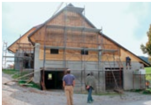
Vojsko pri Idriji, objekt med popotresno sanacijo, barvanje zatrepnih sten na lopi hleva (foto: A. Ščukovt, september 2011)
