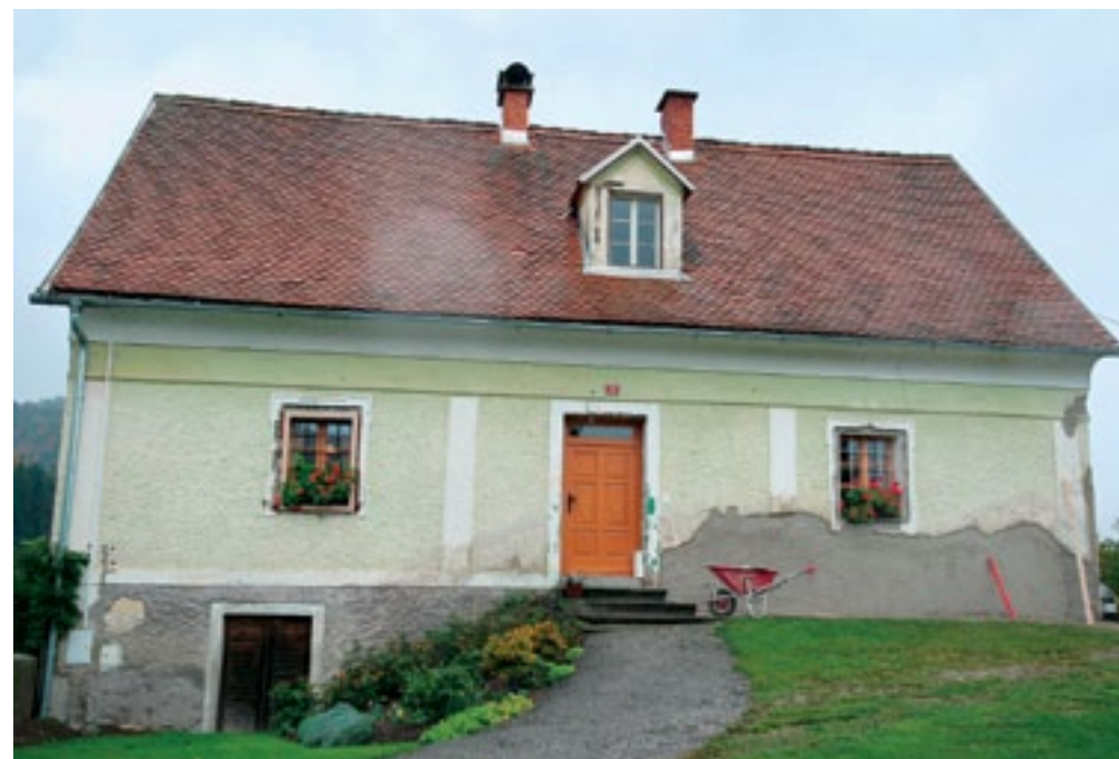
Župnišče v Vuhredu pred obnovo fasade, oktober 2010 (foto: L. Medved)
