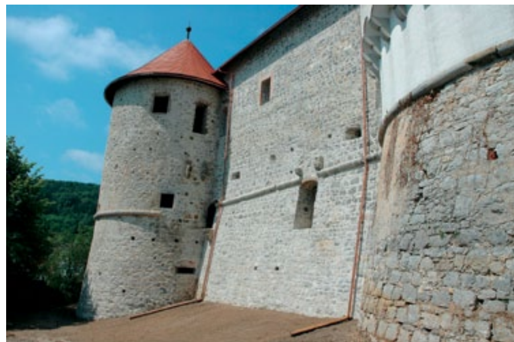
Grad Žužemberk, zunanji fasadi stolpa št. 7 in stene »B« po obnovi (foto: T. Golob, 2011)
