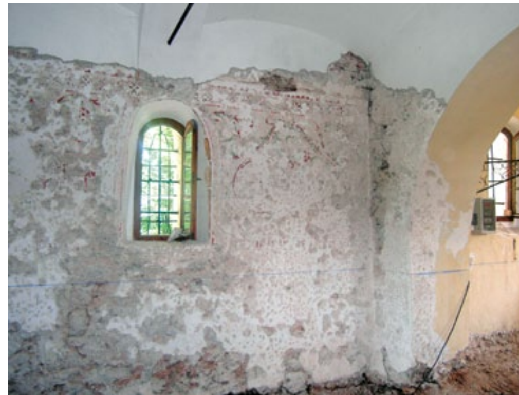
Jezero, cerkev sv. Lovrenca, odbijanje kasnejših plasti ometov in odkrivanje poslikav (foto: T. Pristov, 2010)
