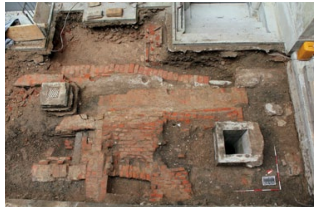
Maribor, grad, 2011: pogled z vzhoda na severni del izkopnega polja znotraj južnega dela notranjega dvorišča, v ospredju opečnati kolektor za vodo, levo in desno betonska jaška, v ozadju pa še novejši jarek z opečnatim kanalom (foto: B. Tušek)
