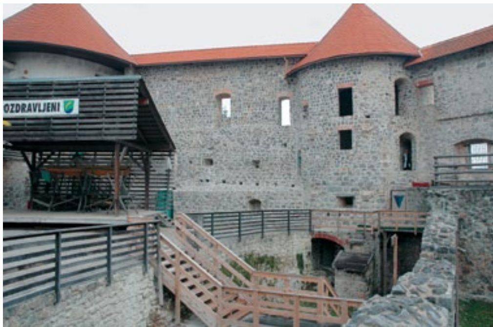
Grad Žužemberk, dvorišni fasadi stolpa št. 7 in stene »B« po obnovi (foto: T. Golob, 2011)
