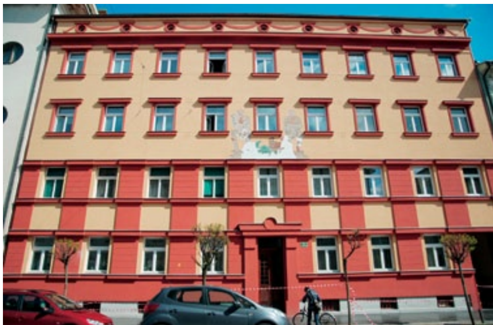
Ljubljana, Prešernova cesta 4, ulična fasada po obnovi (foto: M. Režek Kambič, 2011)
