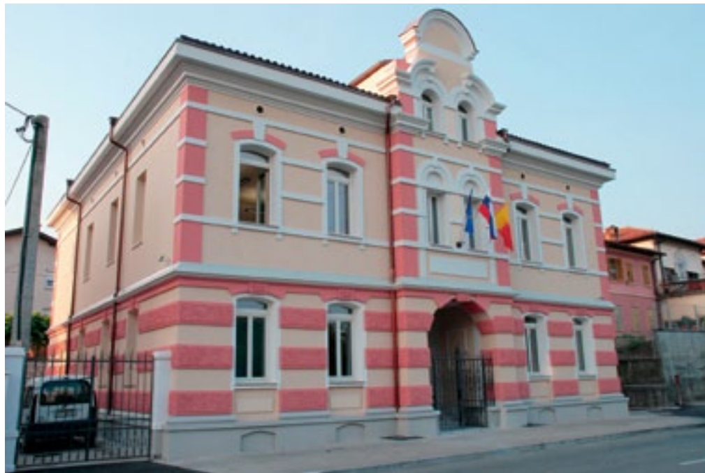
Miren, celovito obnovljena občinska stavba (foto: A. Ščukovt, avgust 2011)
