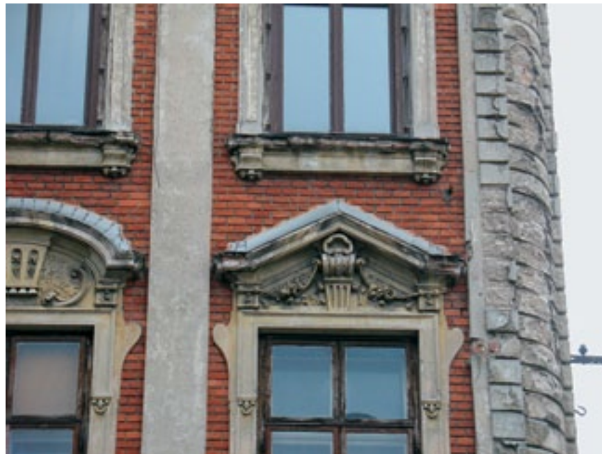
Ljubljana, Erjavčeva cesta 25, detalj ulične fasade pred obnovo (foto: M. Režek Kambič, 2007)
