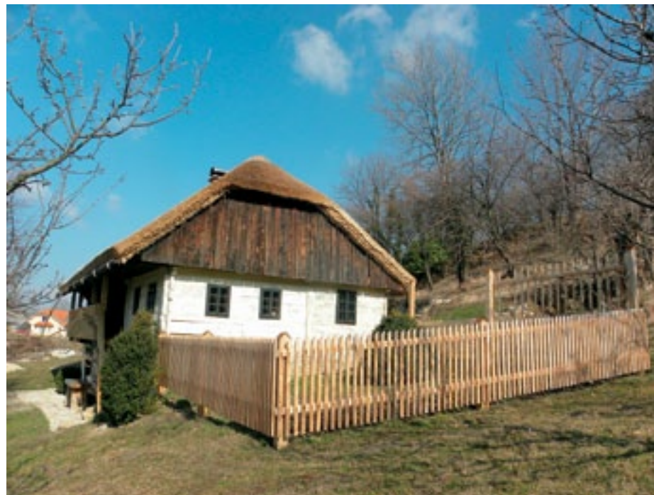
Hiša Repuš 8 po obnovi (foto: B. Hostnik)
