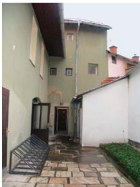
Slovenj Gradec, hiša Glavni trg 40, dvorišče pred obnovi (foto: N. Kiš)
