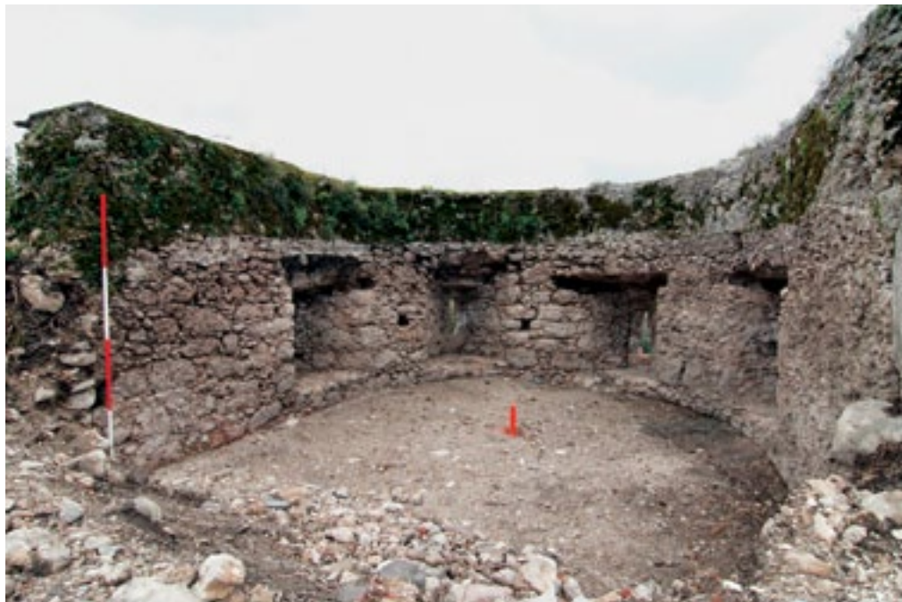
Kranj, notranji obod polkrožnega obrambnega stolpa s štirimi nišami z vzdanimi strelnicami (foto: Š. Tomažinčič)
