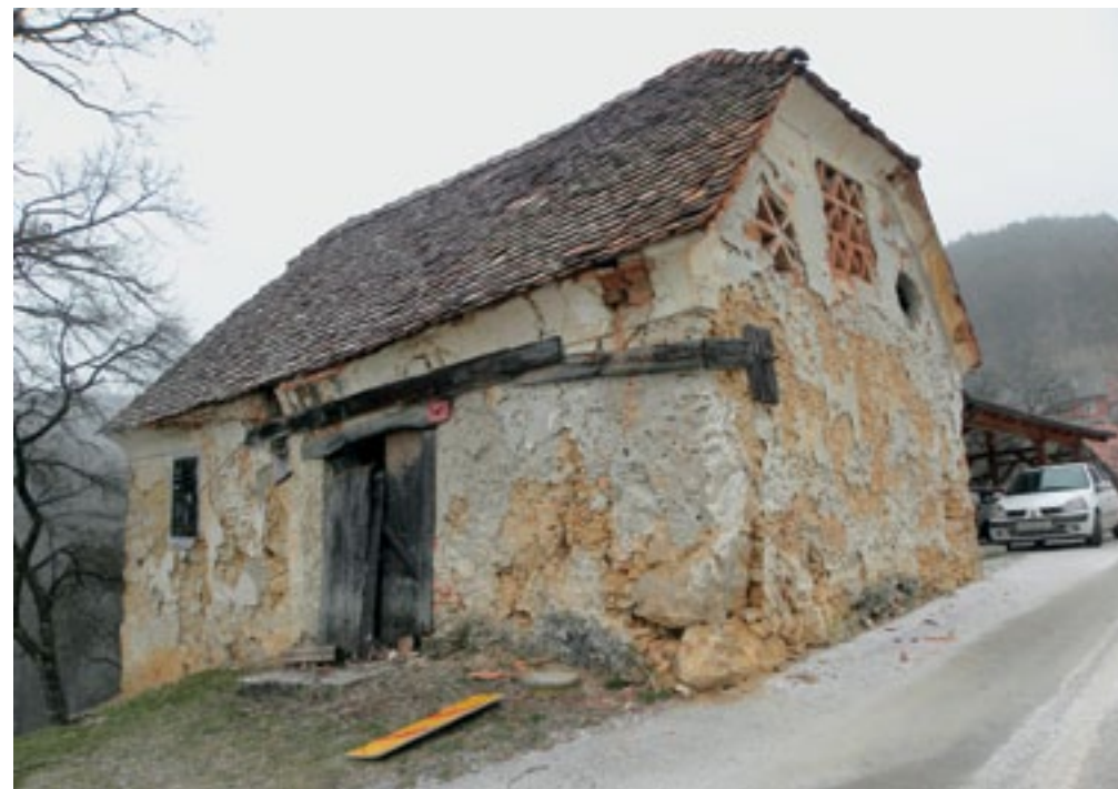
Zidanica Železno 18 pred obnovo (foto: B. Hostnik)
