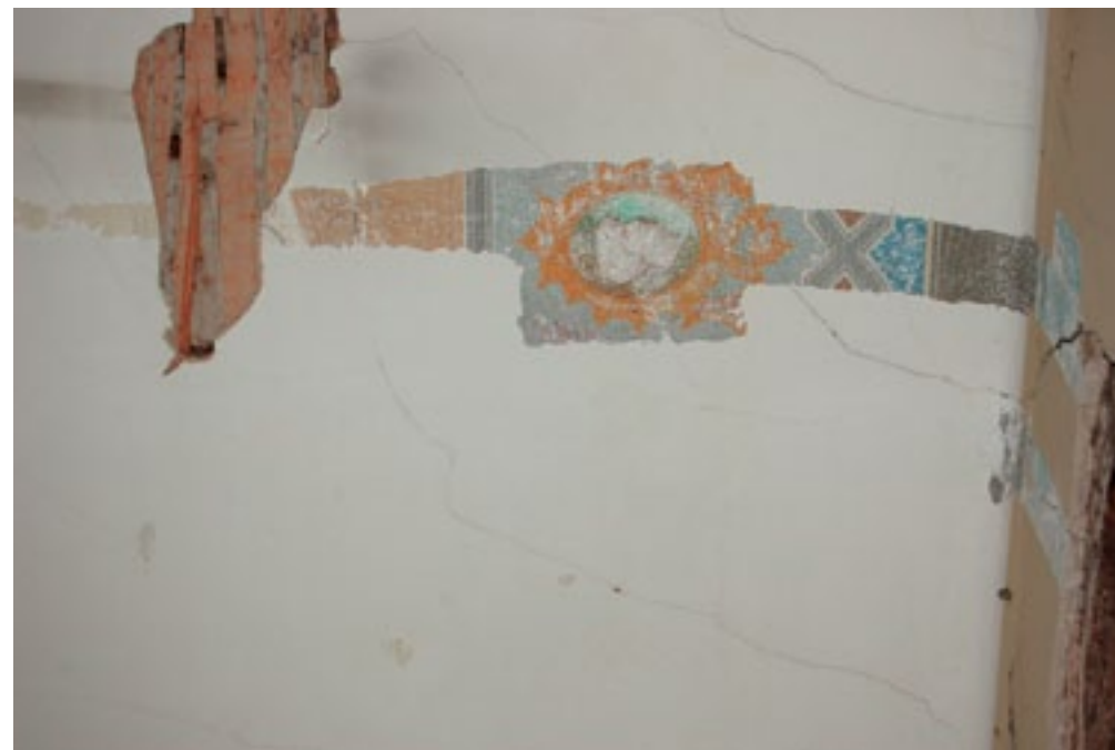
Sežana, Mahorčičeva domačija, sondaže stropne poslikave salona v nadstropju (foto: E. Belingar, 2011)
