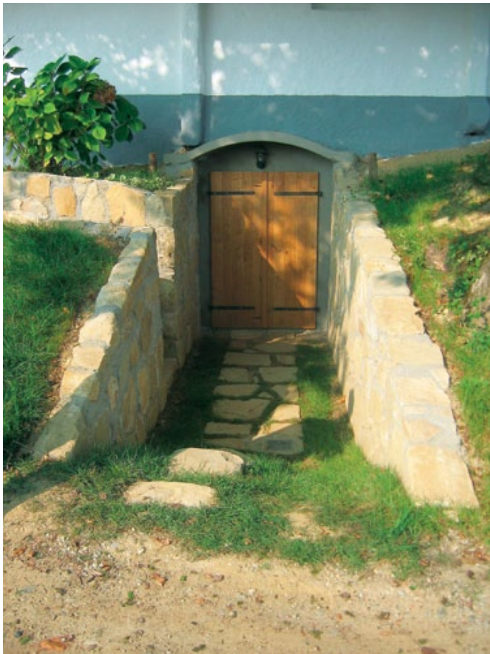
Koračice, Brumnova klet, kamnita škarpa s tlakovano in zatravljeno potjo pred vhodom v podzemni del kleti, september 2011 (foto: S. Vešligaj)
