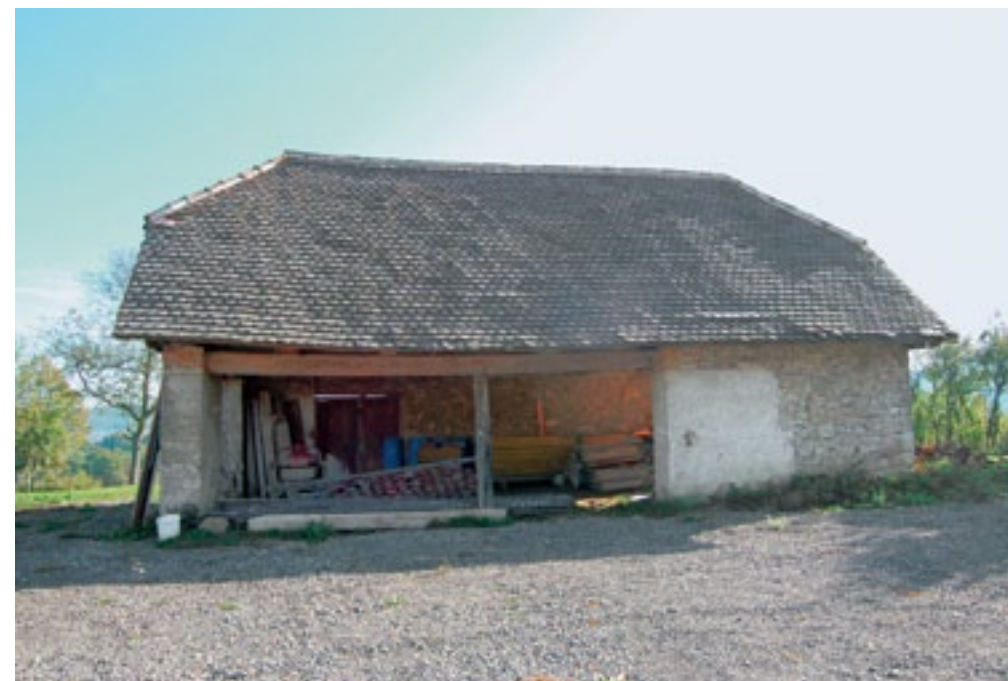
Grobišče 11, skedenj pred prenovo (foto: E. Belingar, 2009)
