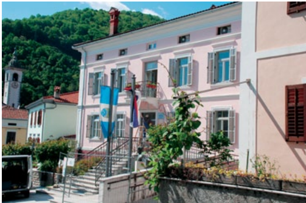
Kanal, stavba Občine Kanal in NKBM (foto: A. Ščukovt, maj 2011)
