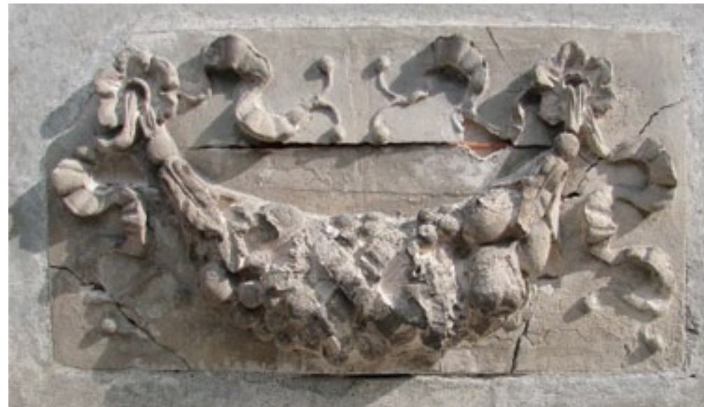
Železniki, hiša Na Plavžu 57, detajl pred obnovo (foto: A. Klančar Kavčič)
