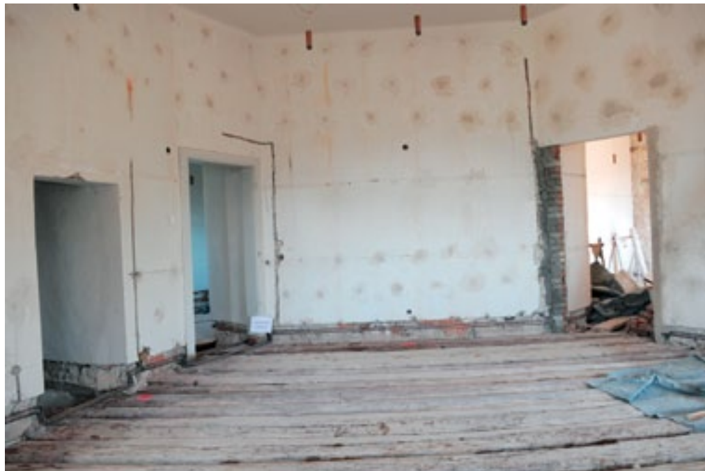
Grad Brežice, selektivno injektiranje zidov v razstavnih prostorih in lesena stropna konstrukcija v nivoju drugega nadstropja (foto: T. Golob, 2011)
