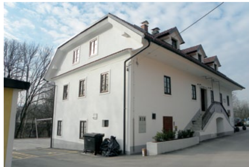
Ljubljana, hiša Pot sodarjev 2 po obnovi (foto: D. Pediček)
