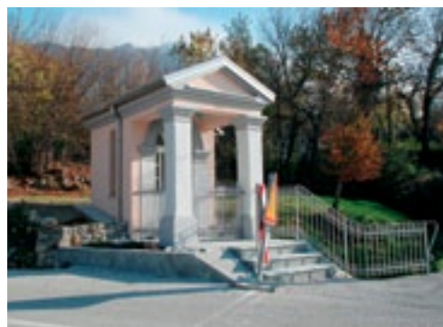
Lokavec, pogled na celovito obnovljeno kapelico (foto: A. Ščukovt, november 2011)
