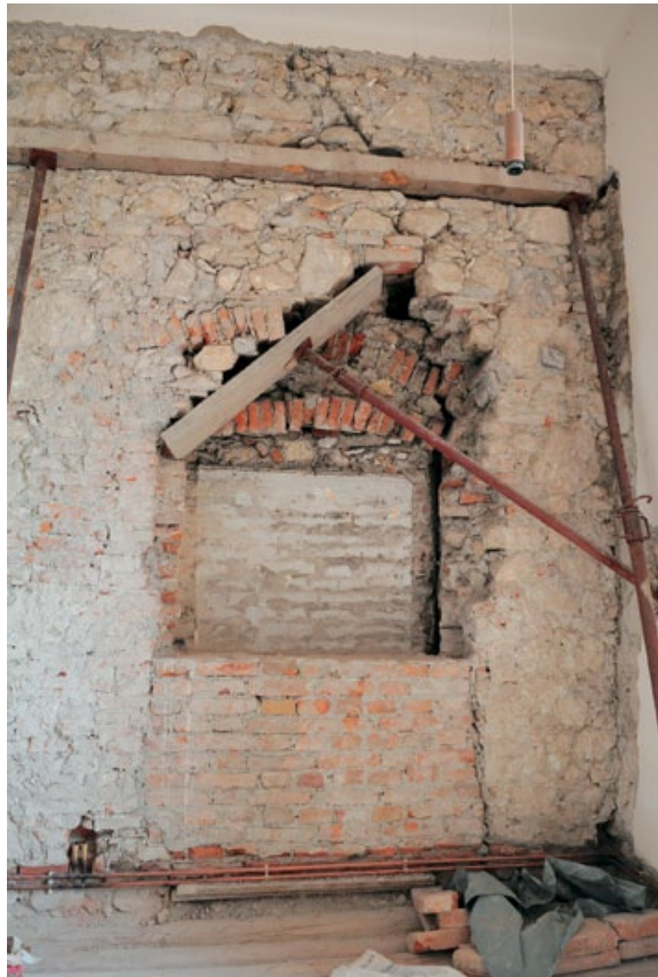
Grad Brežice, zazidana vrata v južni obodni steni vitezke dvorane in ogrevalni toplovodni sistem temperiranja zidov (foto: T. Golob, 2011)
