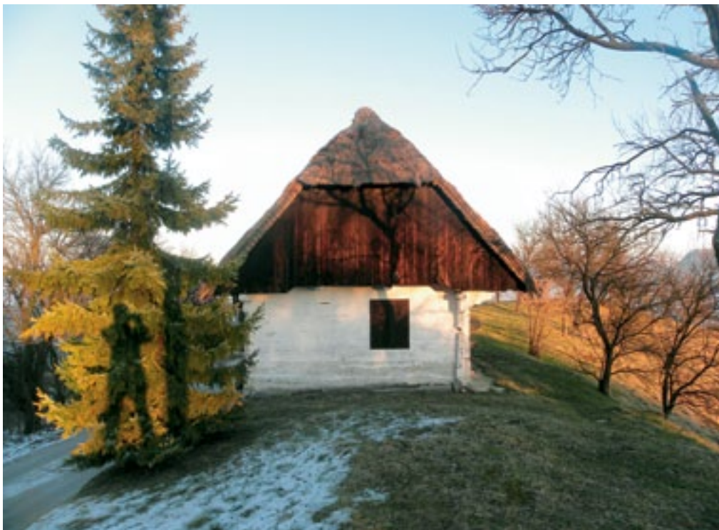
Hiša Slivnica 31 pred obnovo (foto: B. Hostnik, 2011)
