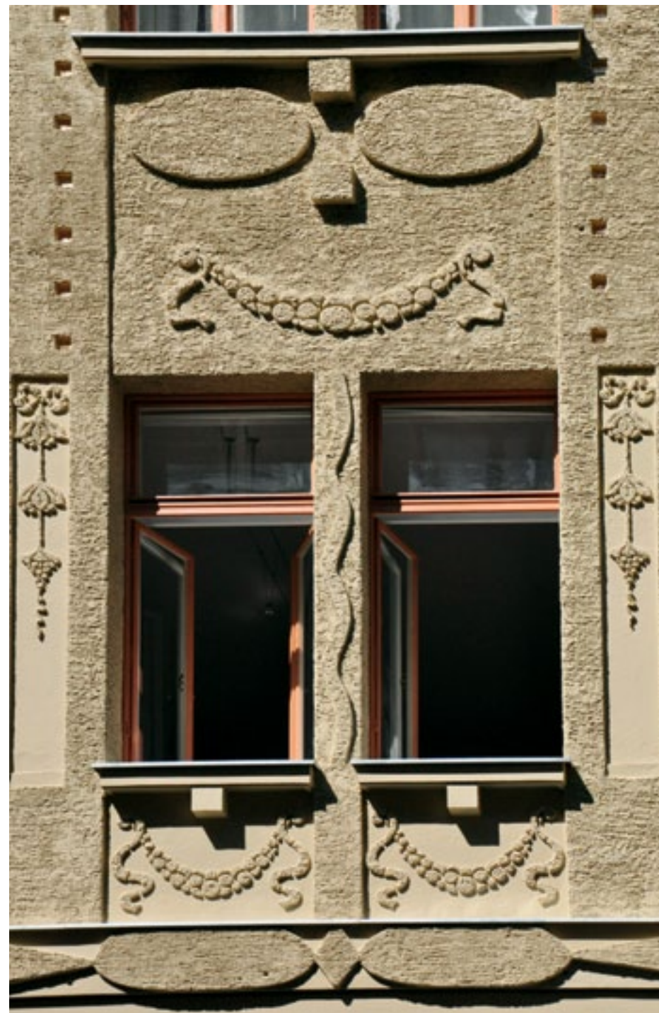
Ljubljana, prenovljena ulična fasada hiše Beethovnova ulica 9, detajl (foto: M. Režek Kambič, 2011)
