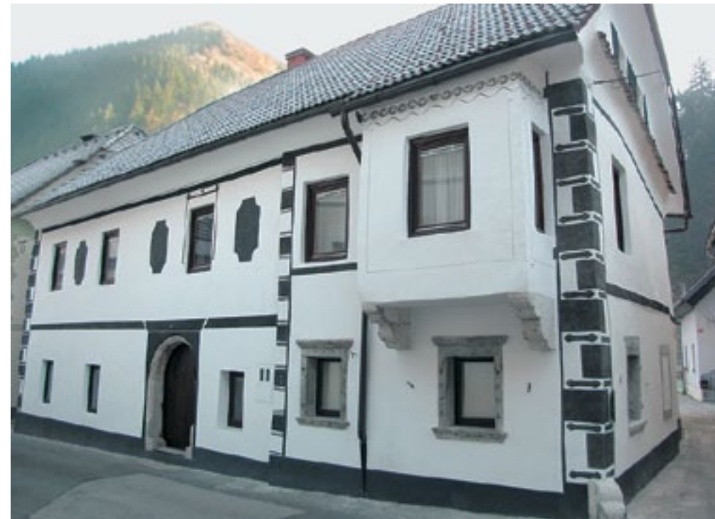
Železniki, fasada objekta Na Plavžu 39 po posegih (foto: A. Klančar Kavčič)
