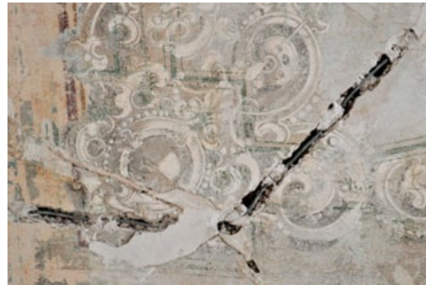
Ljubljana, palača Novi trg 4 – soba I, stropna poslikava med odkrivanjem in odstranjevanjem neustreznih inštalacij (foto: T. Pristov, 2011)
