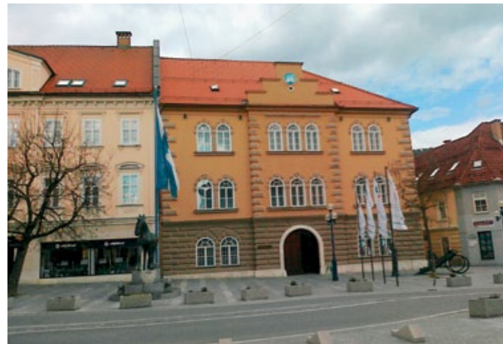
Slovenj Gradec, hiša Glavni trg 24, ulična fasada po obnovi (foto: S. Kurelac)
