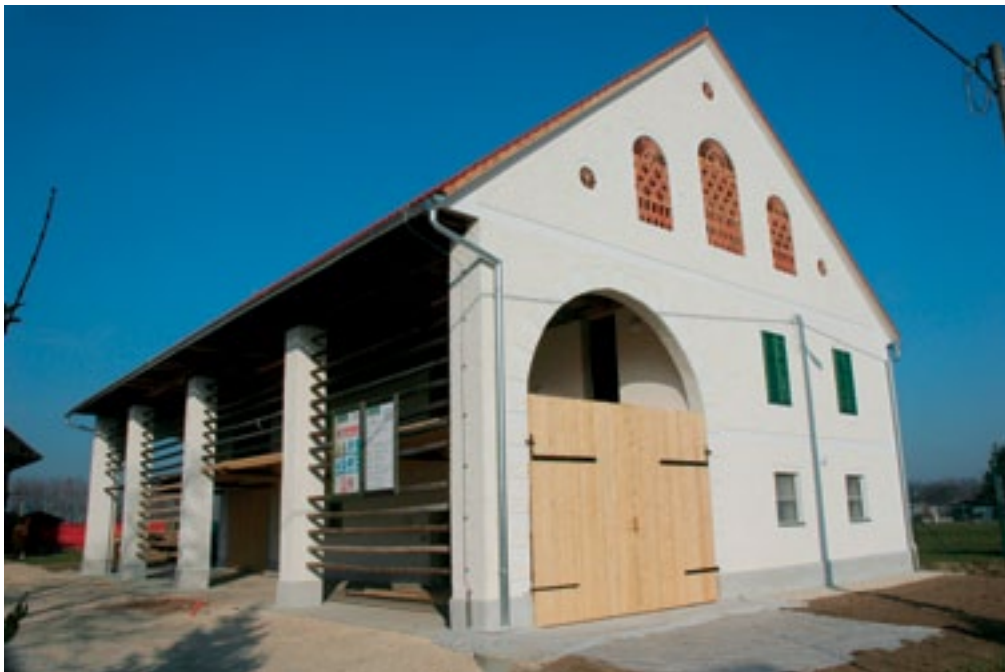
Leskovec 25 po obnovi (foto: I. Gričar)
