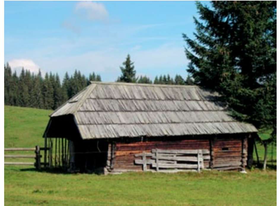
Goreljek, Knoflov stan pred začetkom obnove (foto: S. Roškar)
