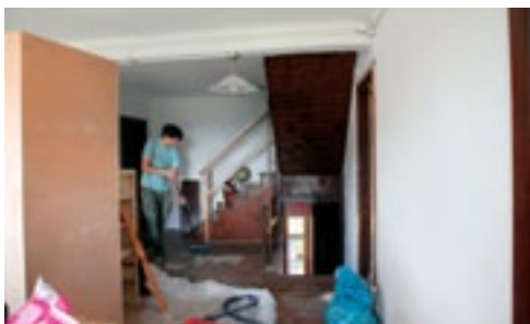
Kambreško 15, nadstropje objekta: nov pod, stopnice, ograja (foto: A. Ščukovt, julij 2011)
