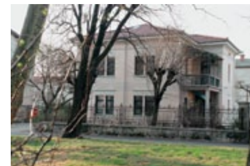
Ajdovščina, obnovljeno pročelje vile na Cesti 5. maja 5 (foto: A. Ščukovt, marec 2012)
