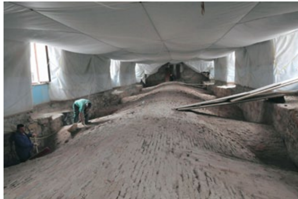
Grad Brežice, opečna obočna konstrukcija kleti v nivoju viteške dvorane (foto: T. Golob, 2010)
