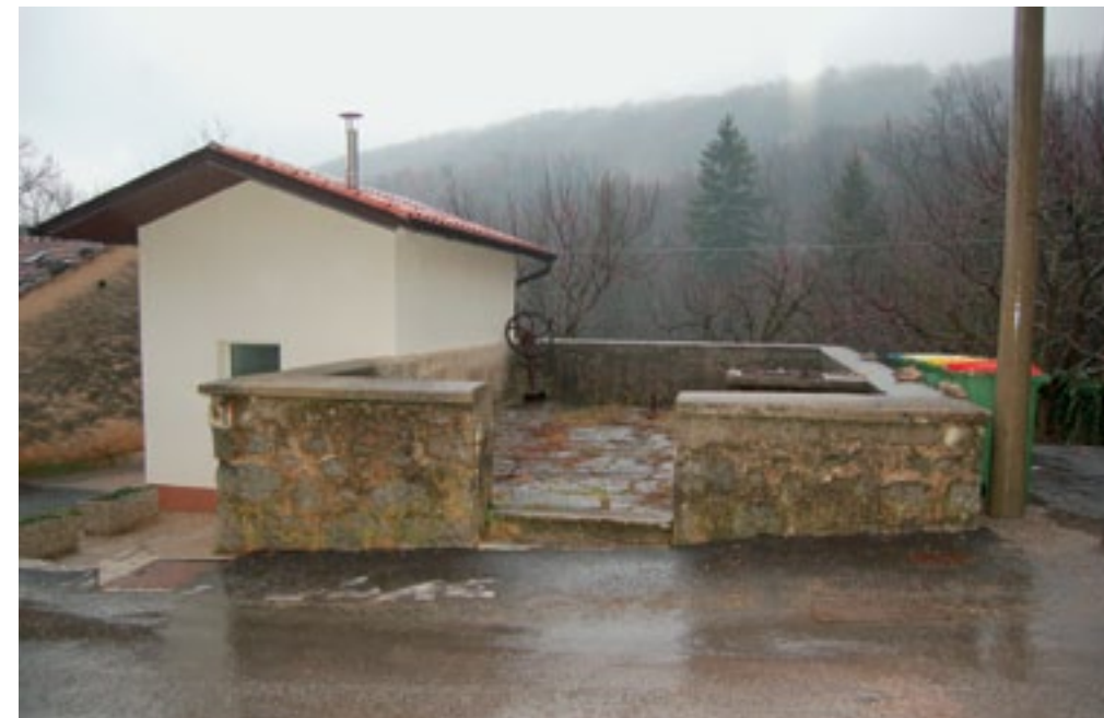
Dolenje pri Štjaku, vodnjak z obzidanim platojem pred pričetkom del (foto E. Belingar, 2010)
