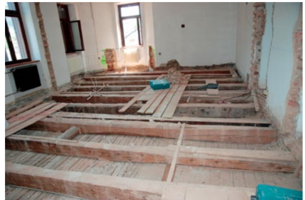
Ilirska Bistrica, Bazoviška cesta 22, leseni stropovi so se ohranili. Nosilnost so okrepili z jeklenimi nosilci (foto: E. Belingar, 2010).
