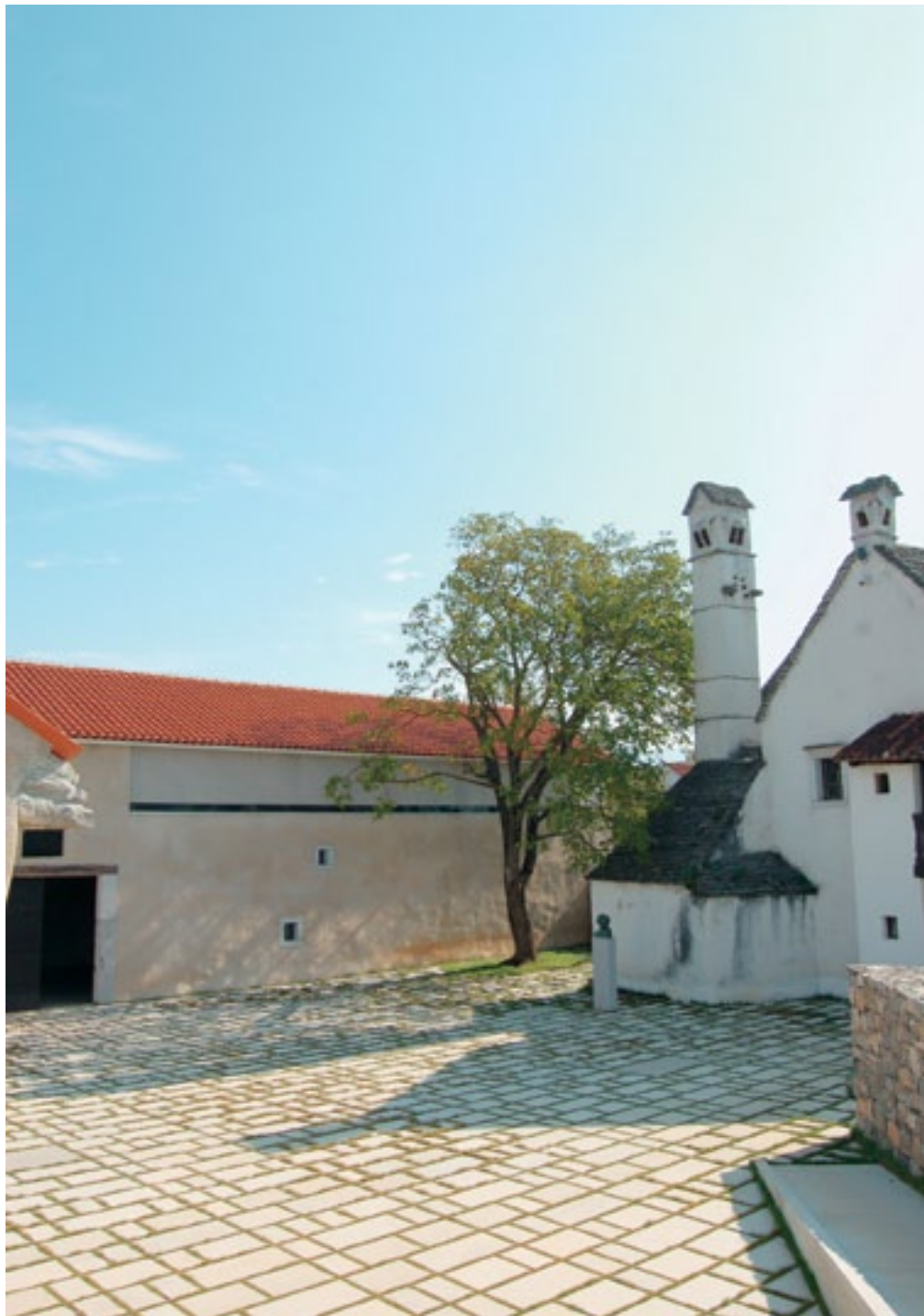
Divača, domačija Kraška cesta 26, poslopje nekdanje štale po obnovi in ureditvi okolice (foto: E. Belingar, 2011)
