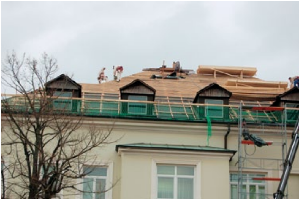
Postojna, vila Jenkova 3, nameščanje novih letvic na predhodno položeno hidro izolacijo (foto: E. Belingar, 2010)
