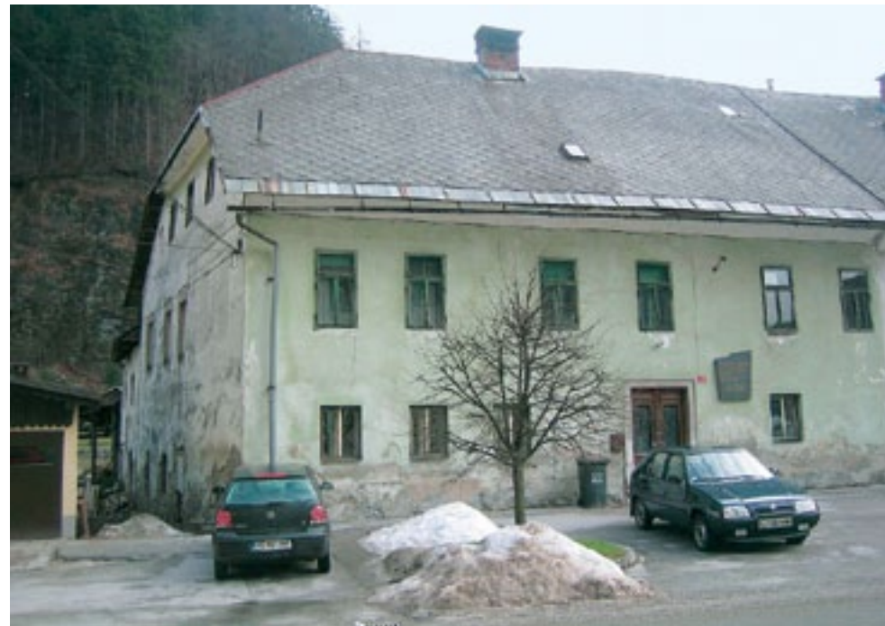
Železniki, Na Plavžu 11, Dermotova hiša pred poplavam (foto: D. Pediček)
