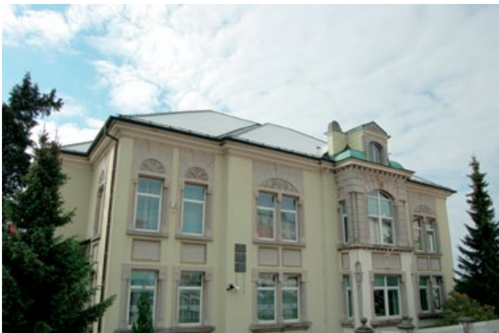
Postojna, vila Jenkova 3 po zaključku del (foto: E. Belingar, 2011)
