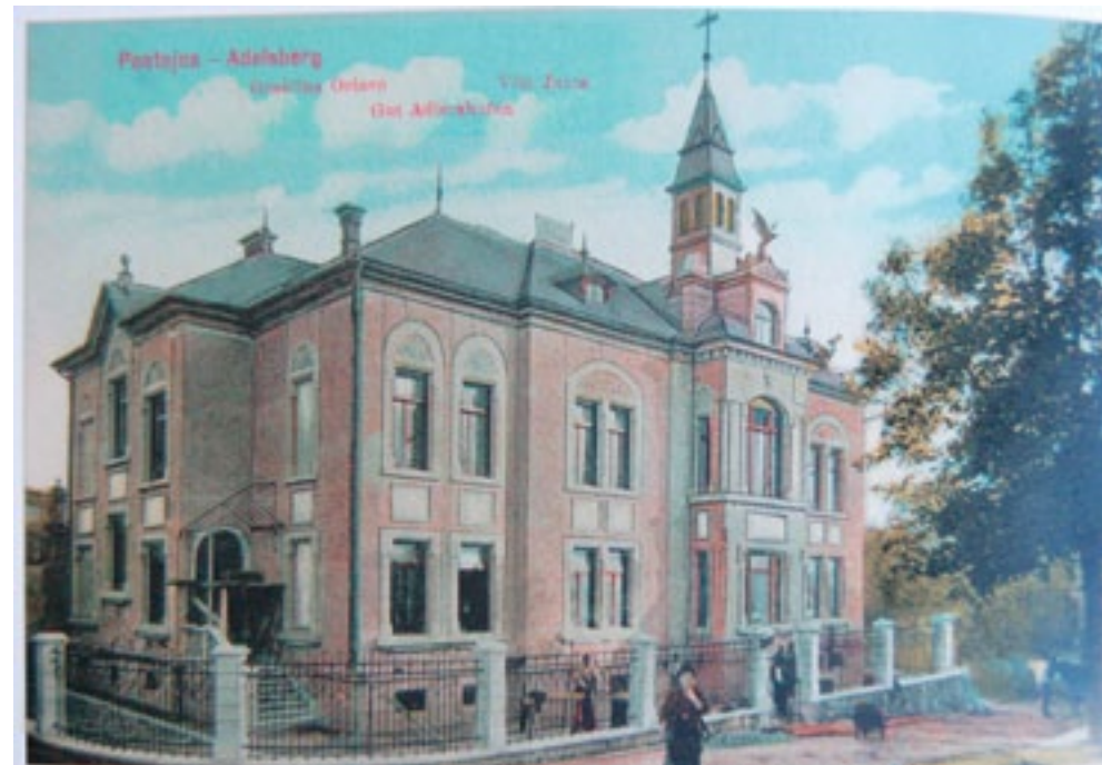
Postojna, stavba sodišča, vila Jurca, na razglednici, odposlani 17. julija 1911 (vir: Čuk, Alenka, Postojna na prelomu stoletij, Postojna, 2008)
