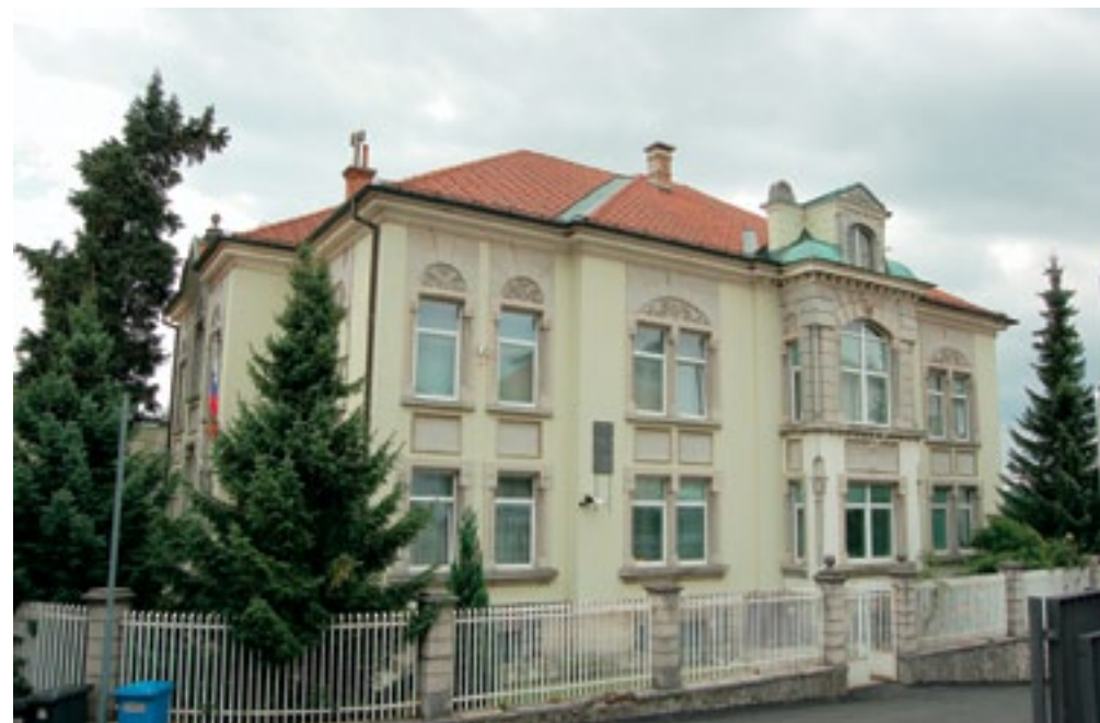
Postojna, stavba sodišča pred pričetkom del (foto: E. Belingar, 2010)
