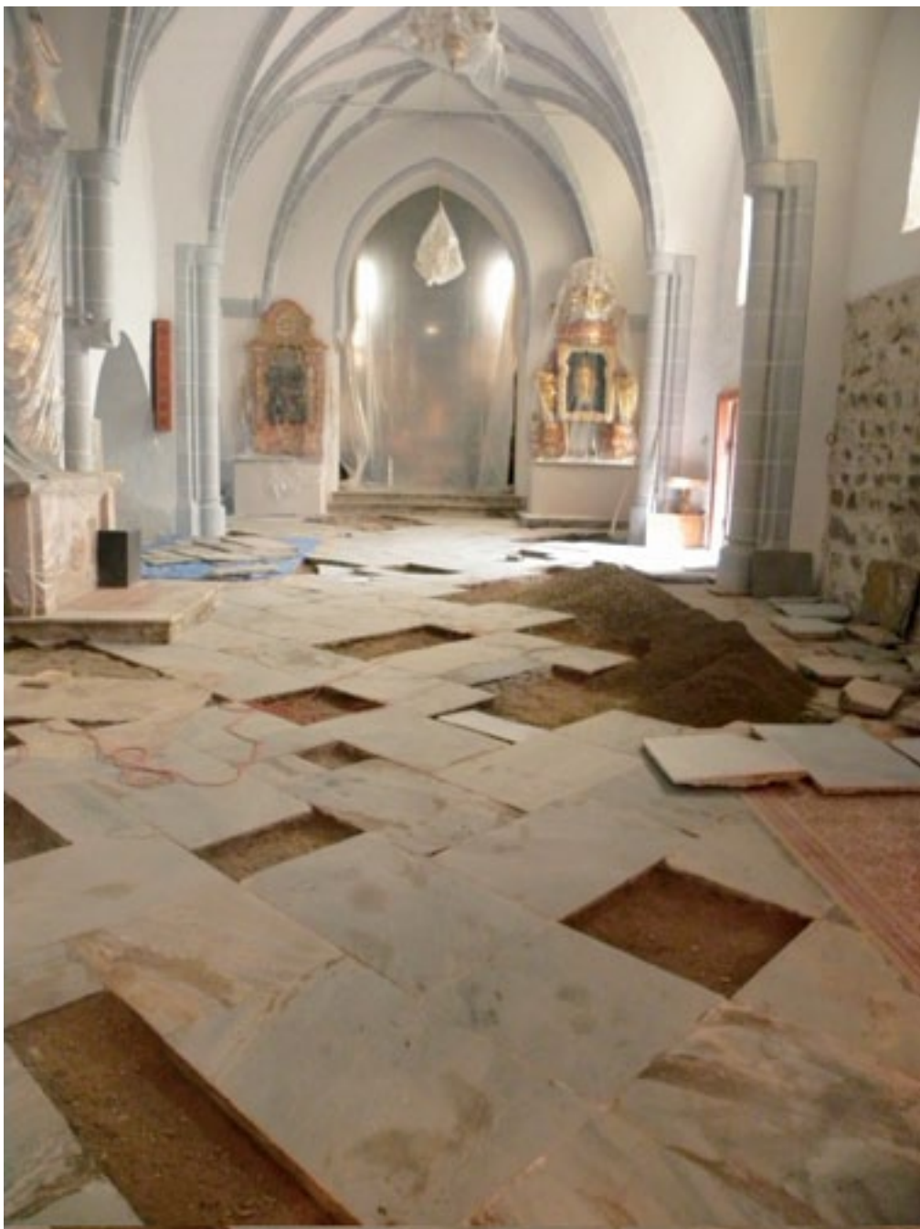
Vuzenica, cerkev sv. Nikolaja, obnova kamnitega tlaka v glavni ladji, pogled proti vzhodu, november 2010 (foto: N. Nahtigal)
