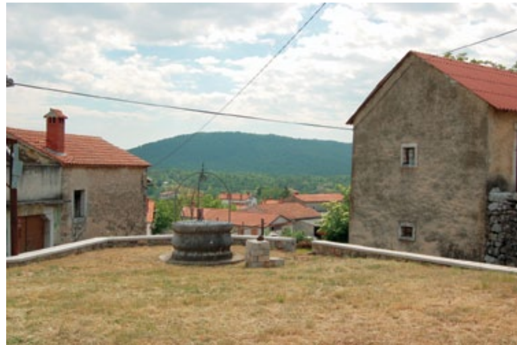
Kreplje, komunška štirna po izvedenih delih (foto: E. Belingar, 2011)
