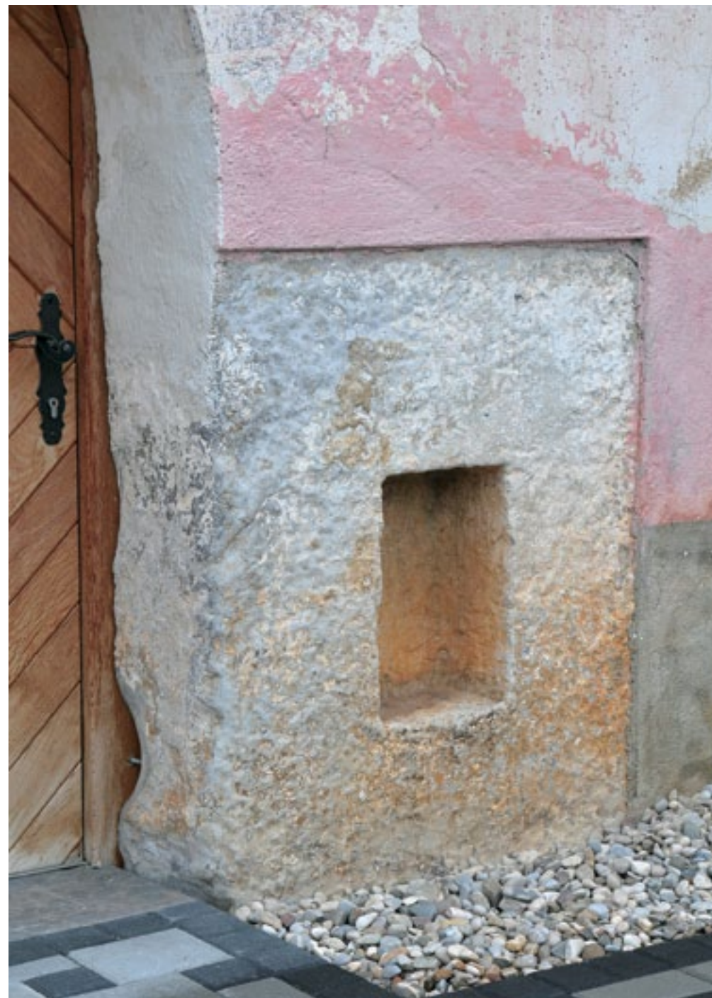
Štatenberk, cerkev sv. Martina, položaj temeljnega kamna z utorom, vzdianega v južno steno cerkvene ladje kot del podboja stranskega portala (foto: M. Pršina, Arhiv ZVKDS, OE Novo mesto)
