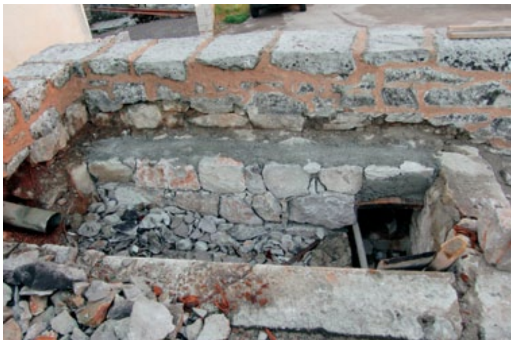
Kopriva, čistilnik po odstranitvi vrhnjih plošč. Levo cev, po kateri je dotekala voda, v sredini del kamenja, ki je služilo kot filter, in desno preliv, iz katerega se je voda stekala v zbiralnik (foto: E. Belingar, 2010).
