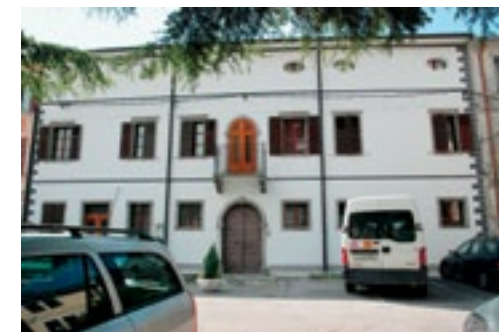
Obnovljena fasada župnišča v Kanalu (foto: A. Ščukovt, 2010)
