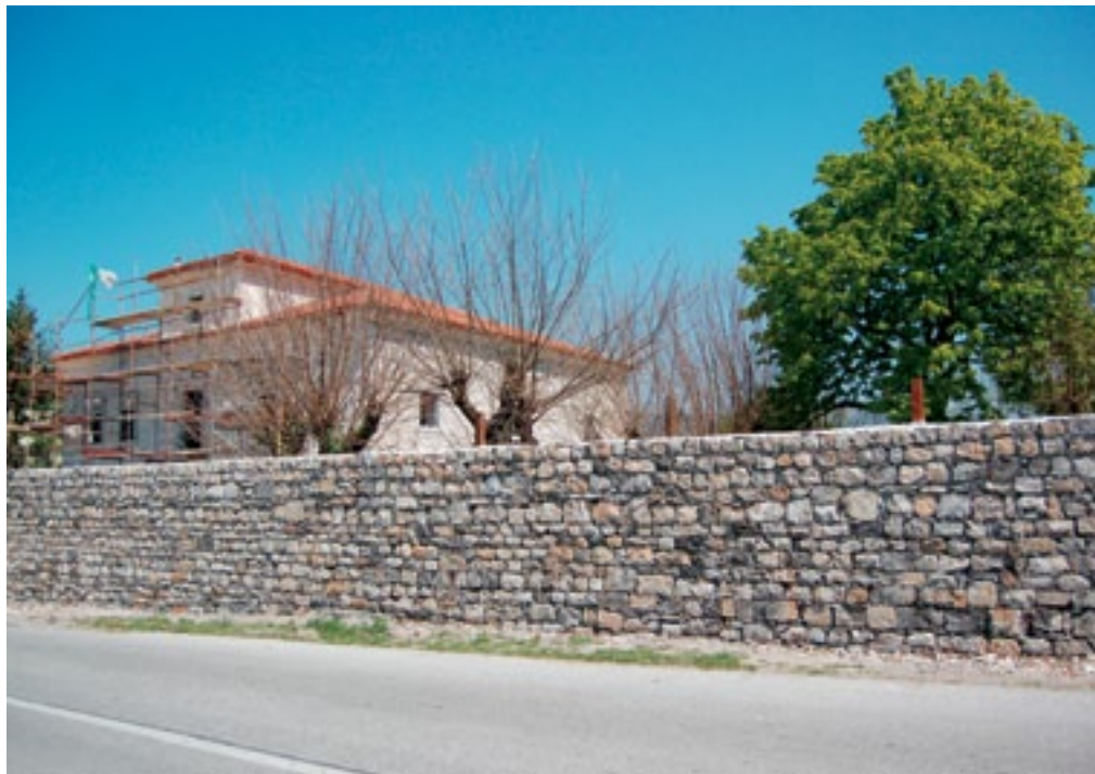
Domačija Matavun 8, pozidava obcestnega kamnitega zidu (foto: E. Belingar, 2011).
