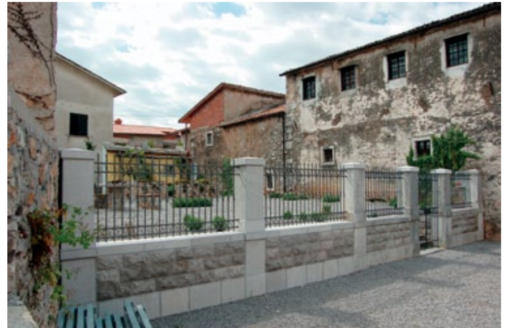
Dutovlje 65, vrt s saniranim in na novo izvedenim podpornim zidom in ograjo (foto: E. Belingar, 2011)
