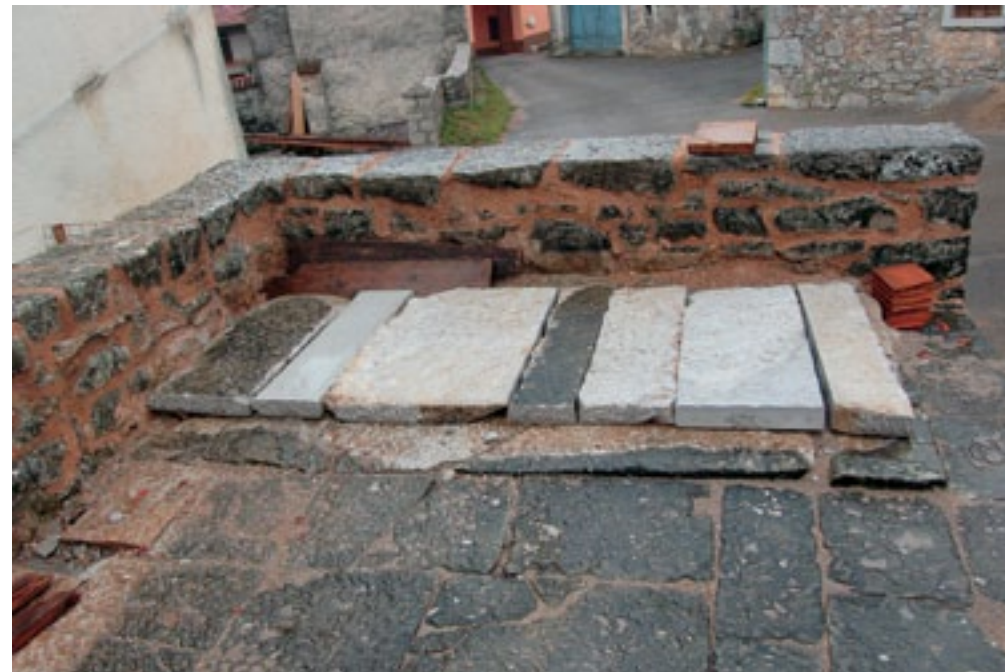
Kopriva, del platoja vodnjaka s čistilnikom, prekritim s kamnitimi ploščami (foto: E. Belingar, 2010)
