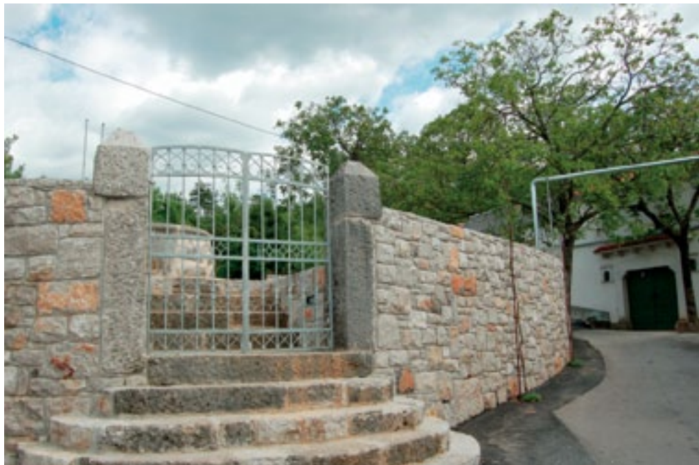
Vrhovlje pri Sežani, na novo pozidani zid ter na novo položene kamnite stopnice, ki vodijo skozi kamnito kalono z obnovljenimi starimi vrati k vodnjaku. Do vodnjaka se po pločevinastih ceveh steka deževnica z bližnjih streh (desno) (foto: E. Belingar, 2011).
