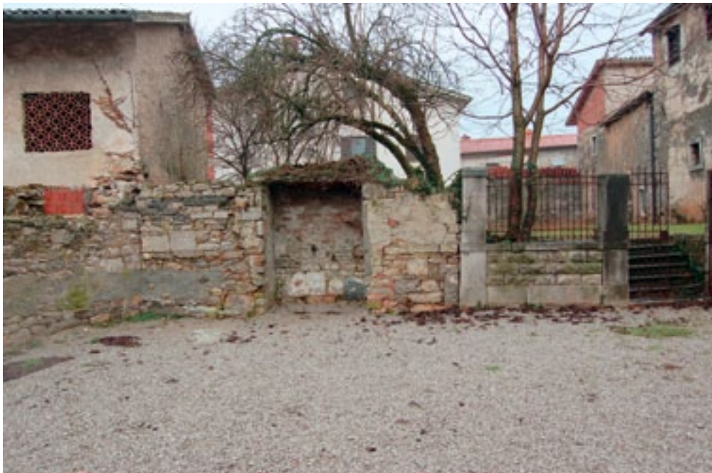
Dutovlje 65, vrt na dvignjeni terasi z razpadajočim podpornim zidom (foto: E. Belingar, 2010)
