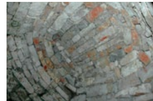
Velika sela, del obnovljenega kamnitega oboka vodenice (foto: D. Strgar)
