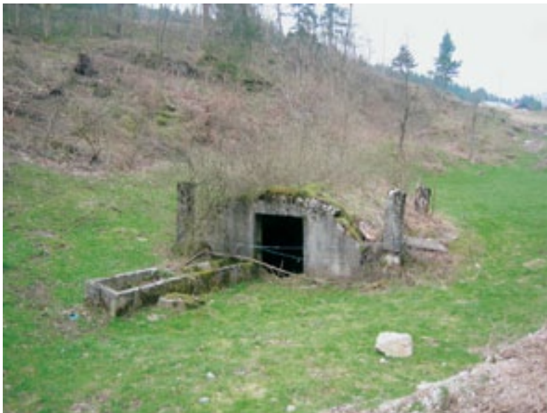
Grčarevec, vodni zbiralnik, kotla pred prenovi (foto: D. Pediček)
