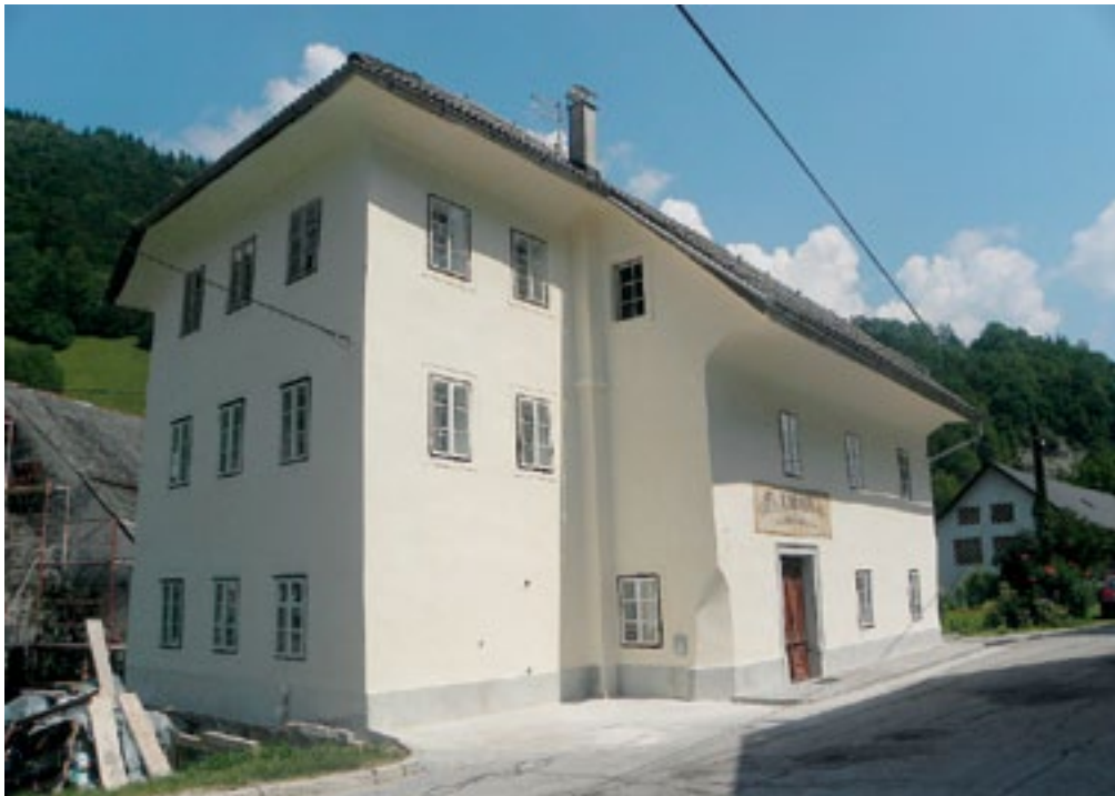
Železniki, Racovnik 50, hiša po obnovi oken in fasad (foto: D. Pediček)
