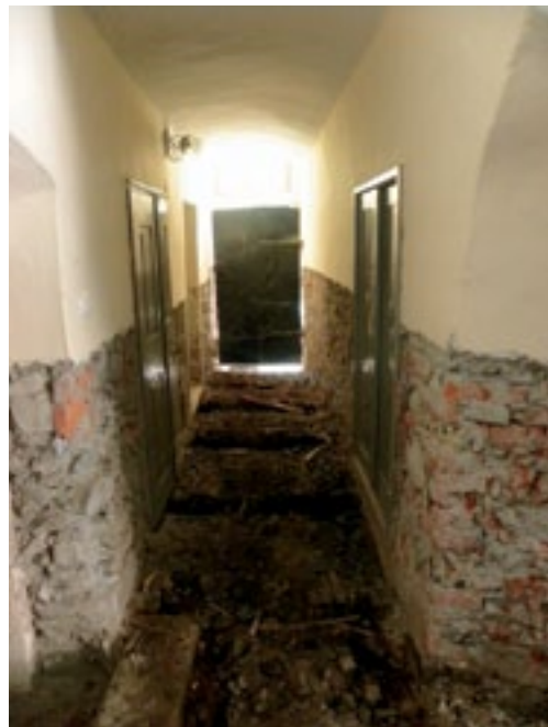
Železniki, Racovnik 9, odstranjeni ometi in podnice v veži (foto: D. Pediček)
