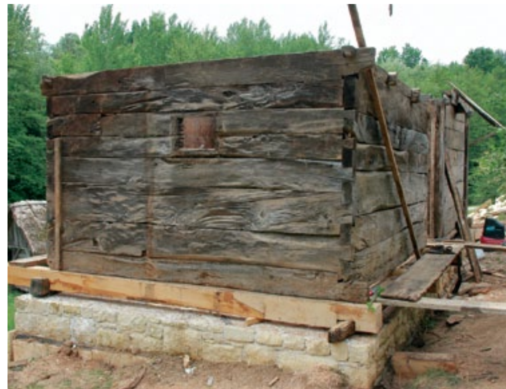
Brezova Reber pri Semiču, postavljanje lesenega dela kašče (foto: D. Strgar)
