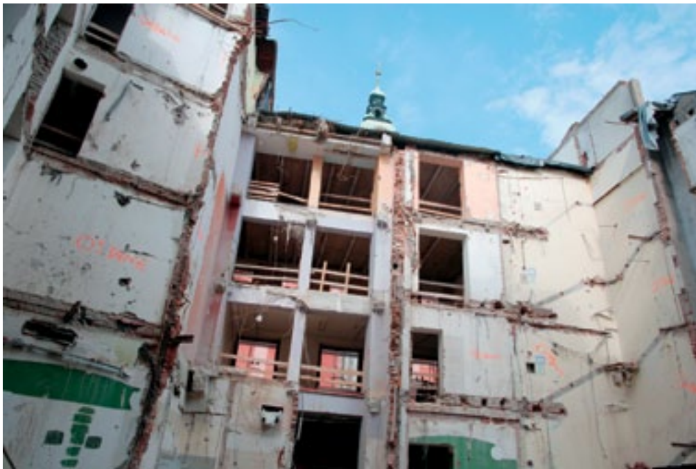
Ljubljana, Trgovina Urbanc, dvoriščna fasada, očiščena prizidka (foto: M. Režek Kambič, 2009)
