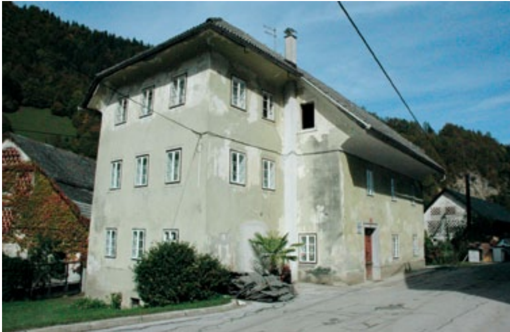
Železniki, Racovnik 50, Popčeva hiša pred obnovo (foto: D. Pediček)
