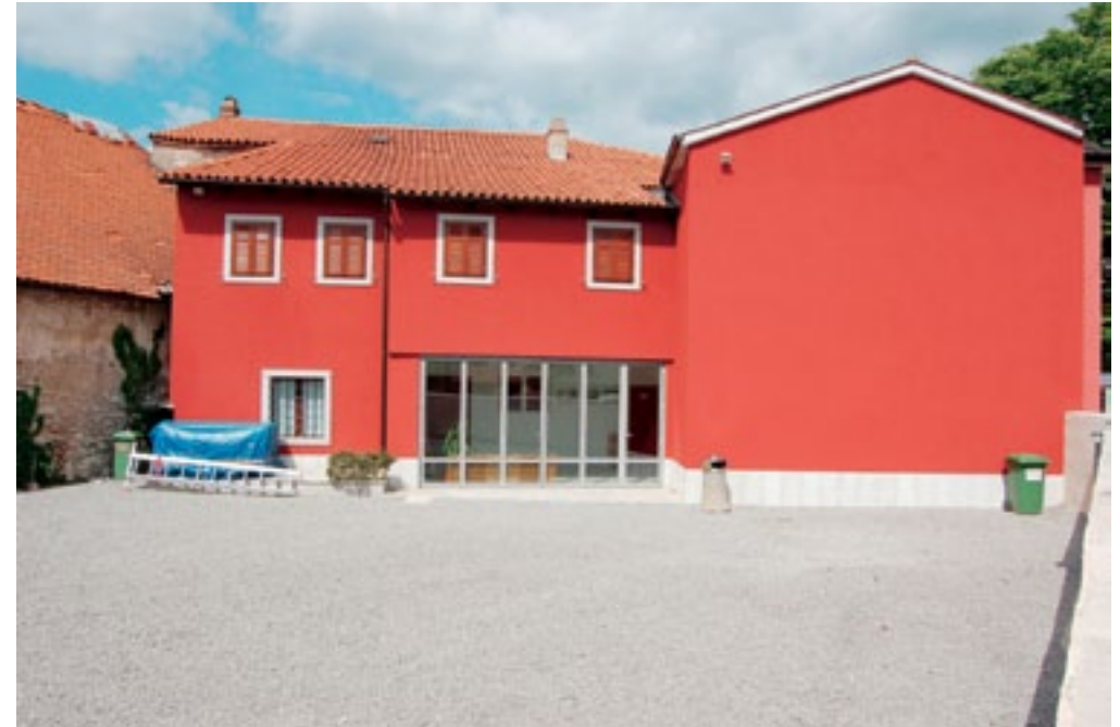
Dutovlje 65, dvoriščna fasada Bunčetove domačije po dokončanju del (foto: E. Belingar, 2011)
