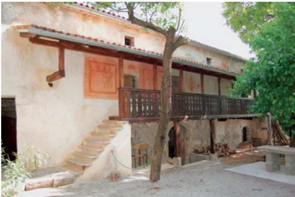
Domačija Kobjeglava 57, stara hiša po izvedenih gradbenih in restavratorskih delih, 2010 (foto: E. Belingar, 2011)
