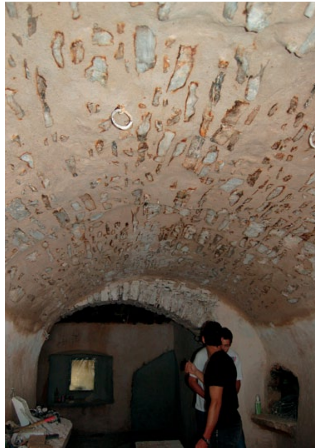
Divača, domačija Kraška cesta 26, na novo ometan banjasto obokan predprostor spahnjence v hiši (foto: E. Belingar, 2010)
