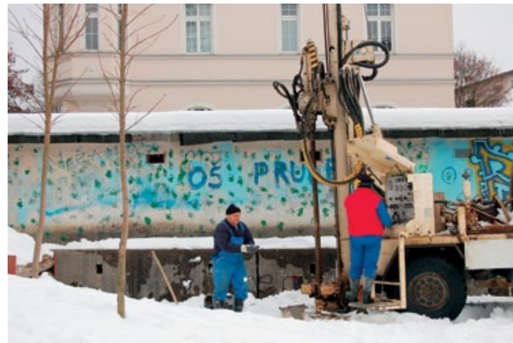
Ljubljana, prikaz geomehanskega vrtnja s pridobivanjem jedra ob osnovni šoli Prule (foto: A. Žorž)
