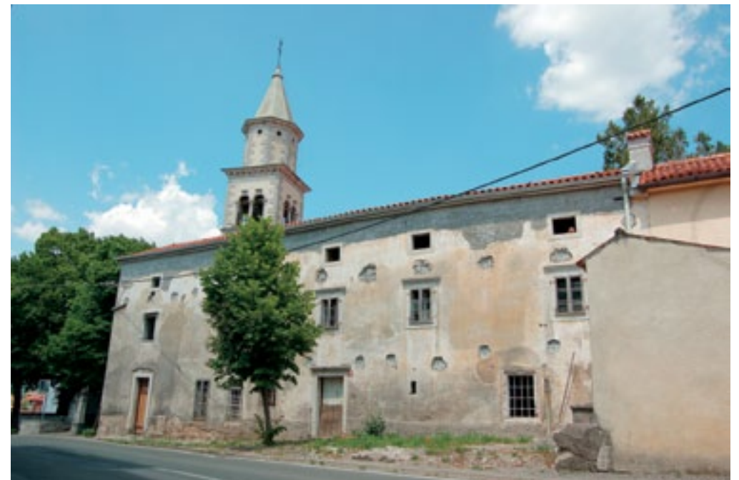
Lokev, cerkev sv. Mihaela, obcestna fasada po izvedenih delih v letu 2010 (foto: E. Belingar, 2011)
