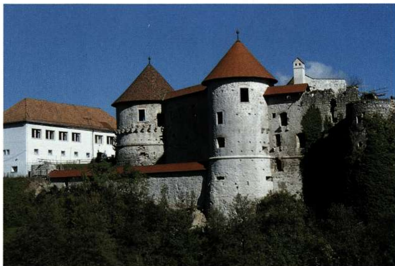
Obnovljeni zid obrambnega jarka ob zahodni fasadi gradu: pogled z desnega brega Krke, dokumentacija Zavod za varstvo kulturne dediščine Slovenije, OE Novo mesto, foto: Tomaž Golob.
