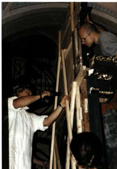
Montaža oltarjev v cerkvi sv. Štefana v Ribnici, (foto: Lucija Močnik)
