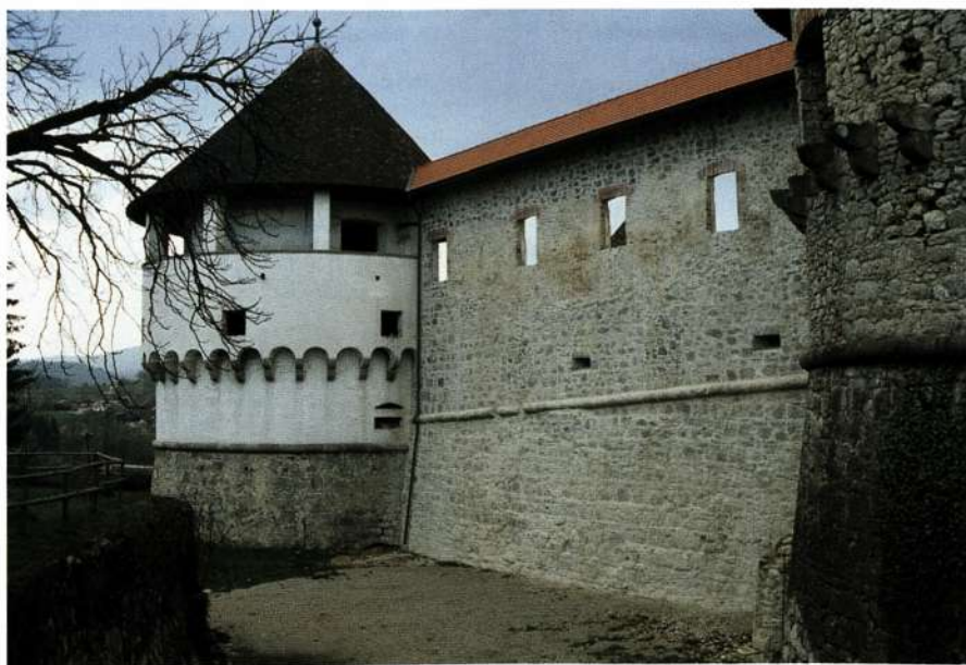
Obnovljena stena "A": dokumentacija Zavod za varstvo kulturne dediščine Slovenije, OE Novo mesto, foto: Tomaž Golob.
