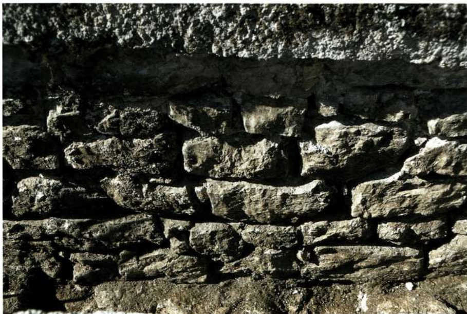
Struktura gradnje severne stene spodnje cerkve (foto: Robert Peskar)
