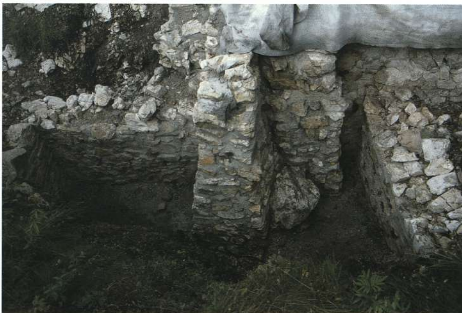
Pogled na sanirani jugozahodni vogal
