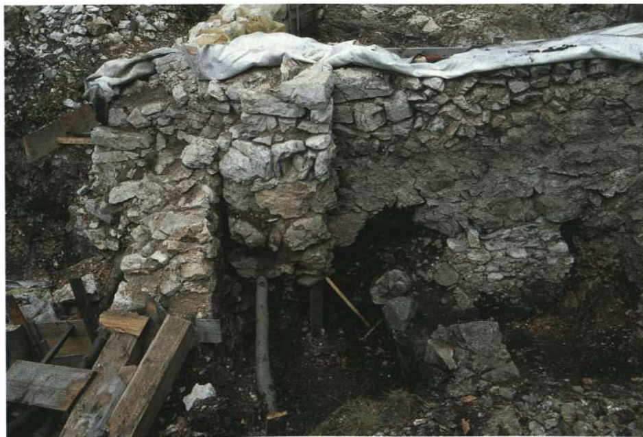
Stanje jugozahodnega vogala ob pričetku sanacijskih del
