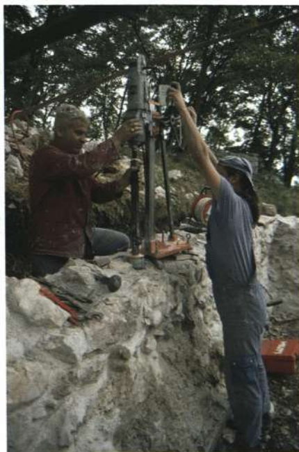
Vgrajevanje horizontalnih AB vezi v nadzidani del zidov, v ozadju rekonstruirana severna stena.
