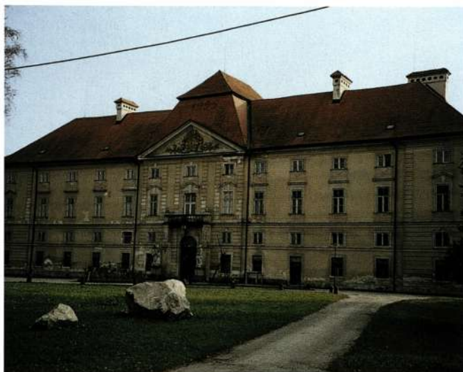
Glavna fasada dvorca Novo Celje, sedanje stanje (foto: Igor Weigl)
