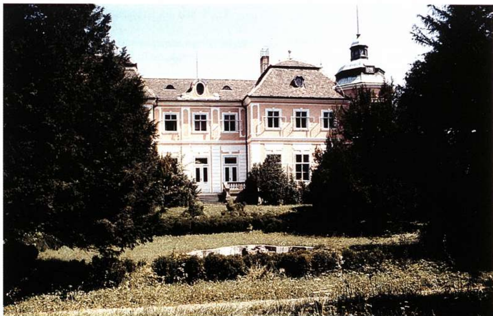
Južni vrt ob dvorcu pred obnovo, dokumentacija ZVNKD, foto: A. Kolšek.
