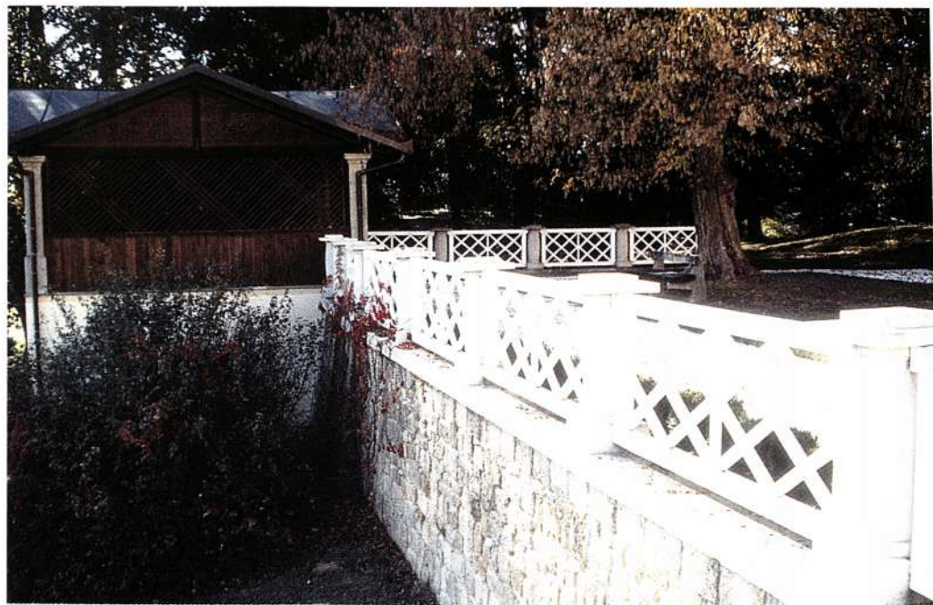
Škarpa z ograjo po obnovi, dokumentacija ZVNKD Celje, foto: A. Kolšek.
