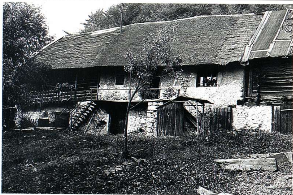
Budnarjeva hiša pred konservatorskim posegom, pogled z jugozahoda, 1986.
