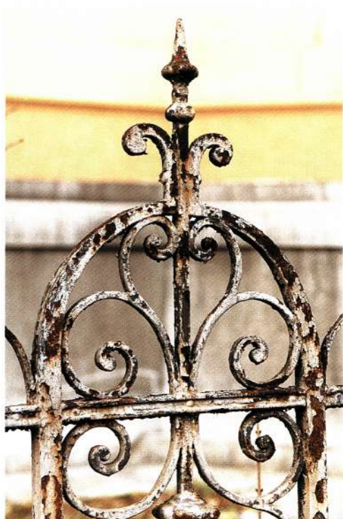
Detajl originalne vrtno ograje; foto Katarina Višnar.
