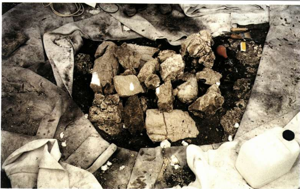
Zavarovanje občutljivih ostankov estriha s filcem, med delom na zidovih in ostanku oltarne menze.
