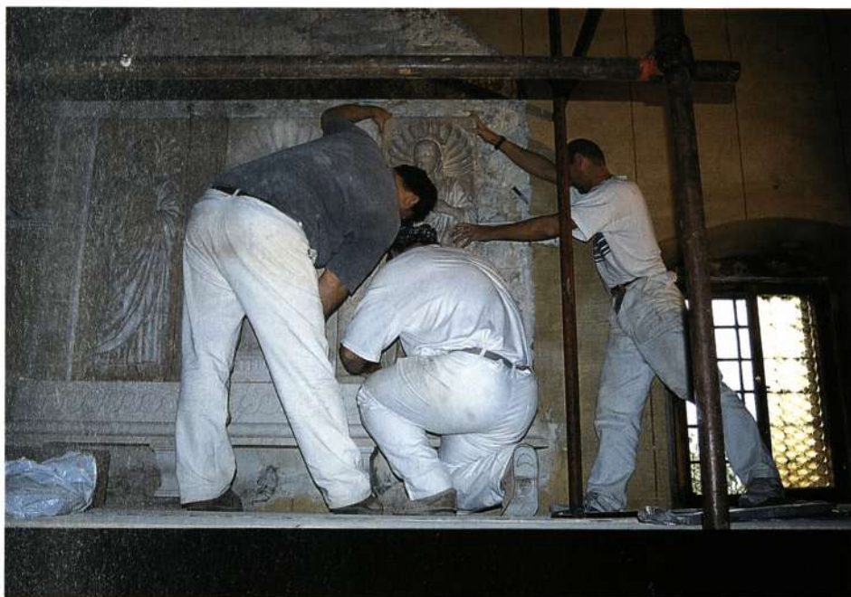
Oltar med vgradnjo v severno steno prezbiterija, foto Mateja Kavčič
