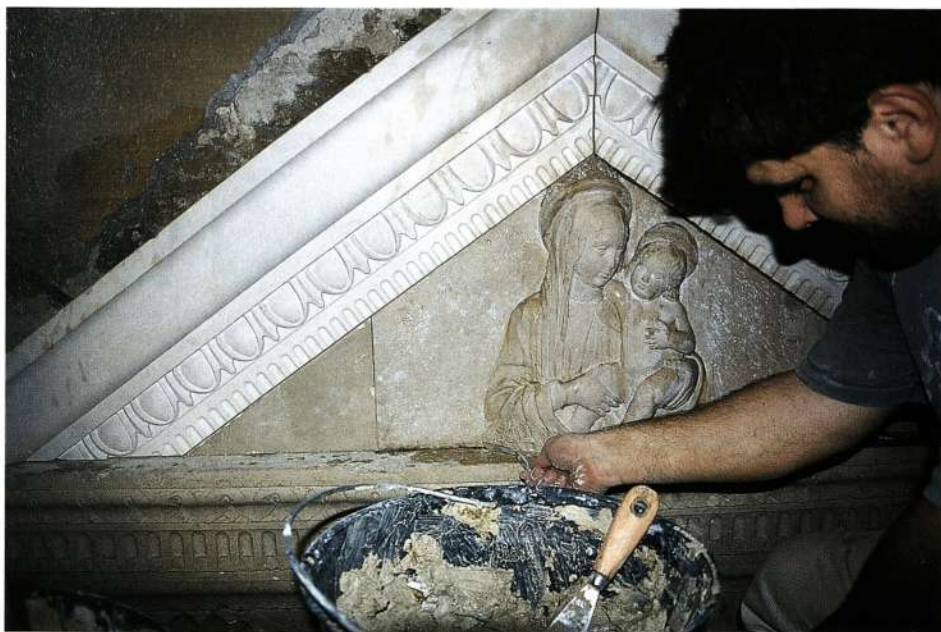
Kitanje fug na vzdani atiki oltarja, v sredini original reliefa Marije z detetom, zaključen z rekonstrukcijo jajčnega motiva, foto Mateja Kavčič
