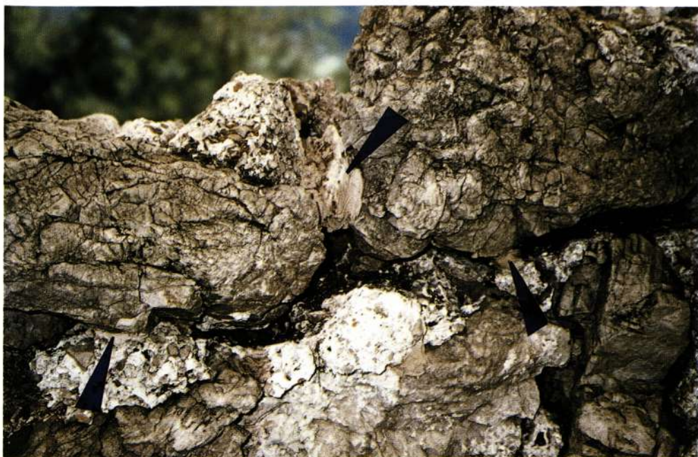
Točkovno lepljenje kamnov v globini fug.
