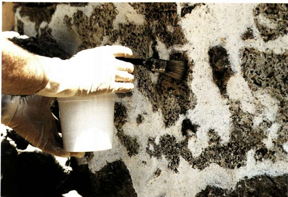
Poizkus utrjevanja ostankov originalnih ometov z utrjevalnim sredstvom za peščenjak.
