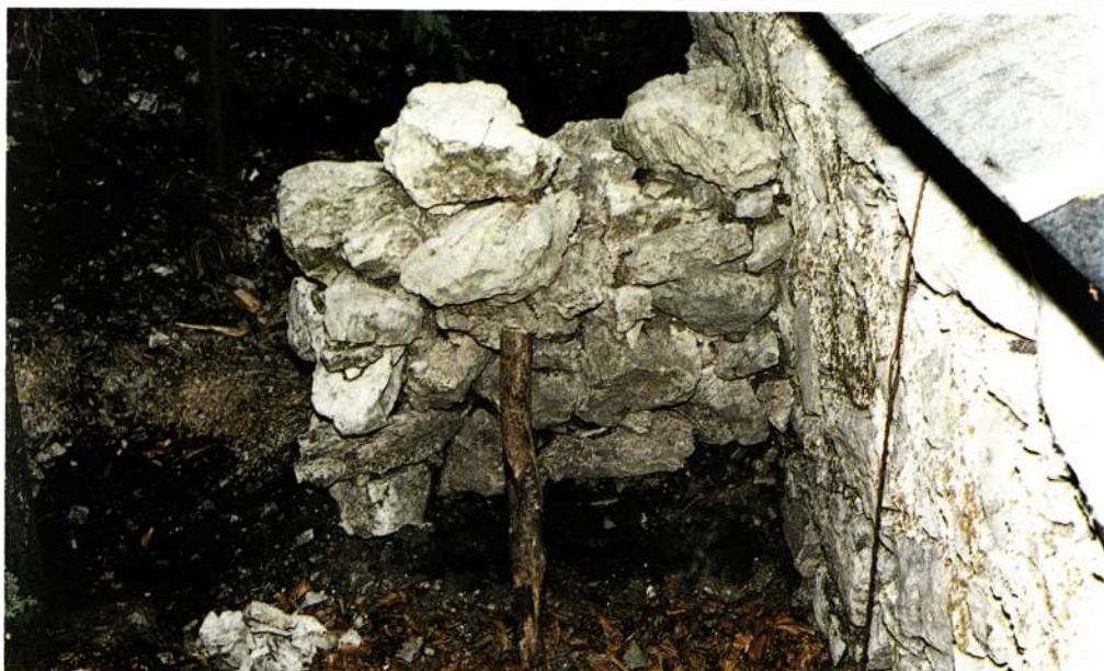
“Suhozid” pri spodnjem objektu, na katerem smo opravili preizkus metode, v fazi točkovega lepljenja kamnov in odstranjevanja humusa.
