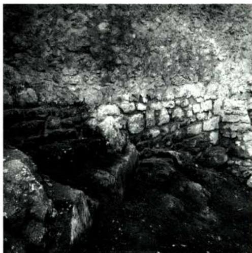
Sl. 3 Ostanki romanskega stolpa v severni fasadi sedanjega razglednega stolpa
