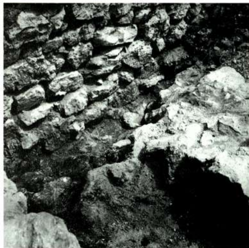
Sl. 8 Stik med južnim zidom starejšega palacija in sekundarnim delom obzidja (odebelitev navznoter)
