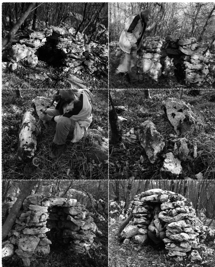
[6-11] Obnova hiške z enojnim zidom v Podlipah. F.: B. Čok
