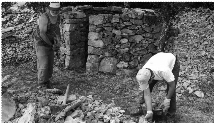
[16] Ko je obodni nosilni zid sezidan do predvidene višine, začnemo odbirati prve skrle za previsevanje strehe. F.: Z. in D. Okoren
