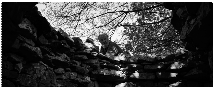
[20] Začetek previsevanja škrl z nosilnega zidu hiške s pravokotnim tlorisom F.: B. Čok
