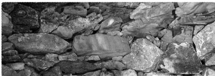
[25] Notranji velb. Lepo se vidijo manjše ščajce, s katerimi podložimo skrle, da dobimo nagib navzven proti nosilnemu zidu. F.: Z. in D. Okoren
