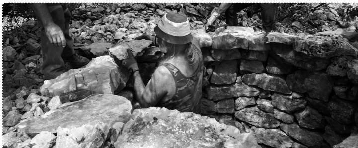
[17] Polaganje prvih skrl, venca po nosilnem zidu. F.: Z. in D. Okoren
