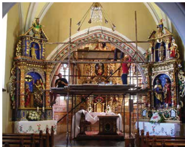
Sliki 8a, 8b: Odstranitvi recentnih beležev in ometov ter kitanju poškodb v slikovni plasti je sledilo dopolnjevanje poškodovane in manjkajoče dekorativne poslikave slavoloka v ladji župnijske cerkve sv. Janeza v Suhi pri Škofji Loki.
