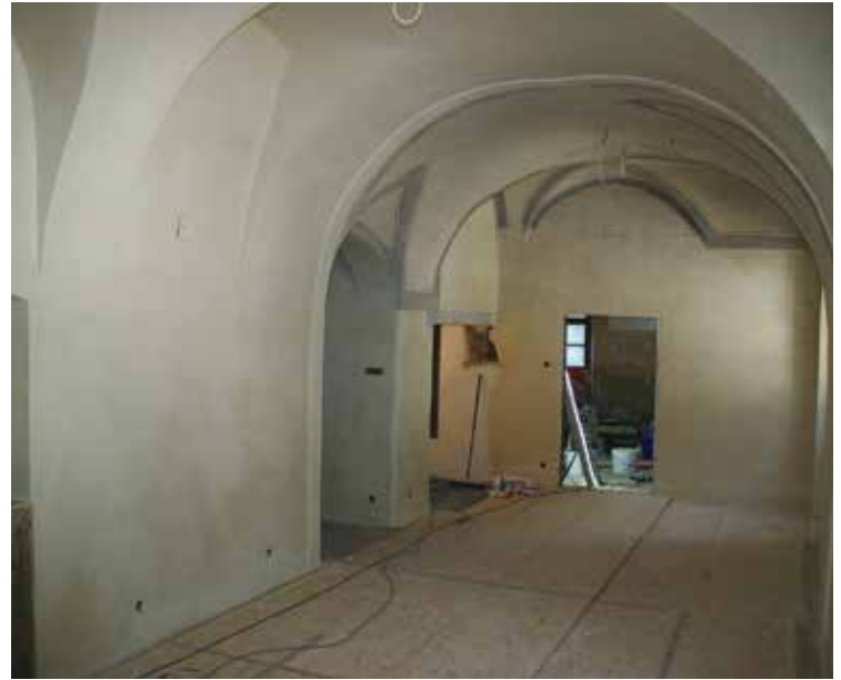
Slika 4: Stanje istega prostora po rekonstrukciji apnenih ometov in kitanju originalnih površin. Izdelan je že tudi osnovni apneni oplet.
