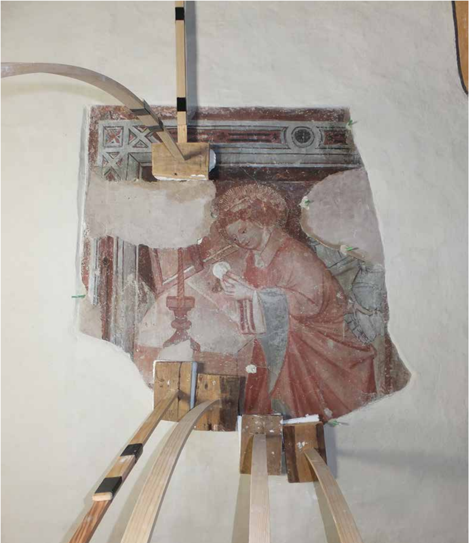
Slika 10: Zaščitna dela na južni steni prezbiterja farne cerkve v Šmohorju/Hermagor v sklopu monitoringa julija 2018.
