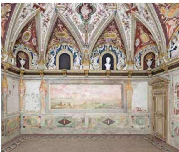
Slika 7c: Stanje po konservatorsko-restavratorskih posegih, zaključenih leta 2012. Pokrajina v okvirju je bila reintegrirana v tehniki tratteggio .
