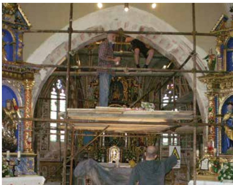
Sliki 8a, 8b: Odstranitvi recentnih beležev in ometov ter kitanju poškodb v slikovni plasti je sledilo dopolnjevanje poškodovane in manjkajoče dekorativne poslikave slavoloka v ladji župnijske cerkve sv. Janeza v Suhi pri Škofji Loki.
