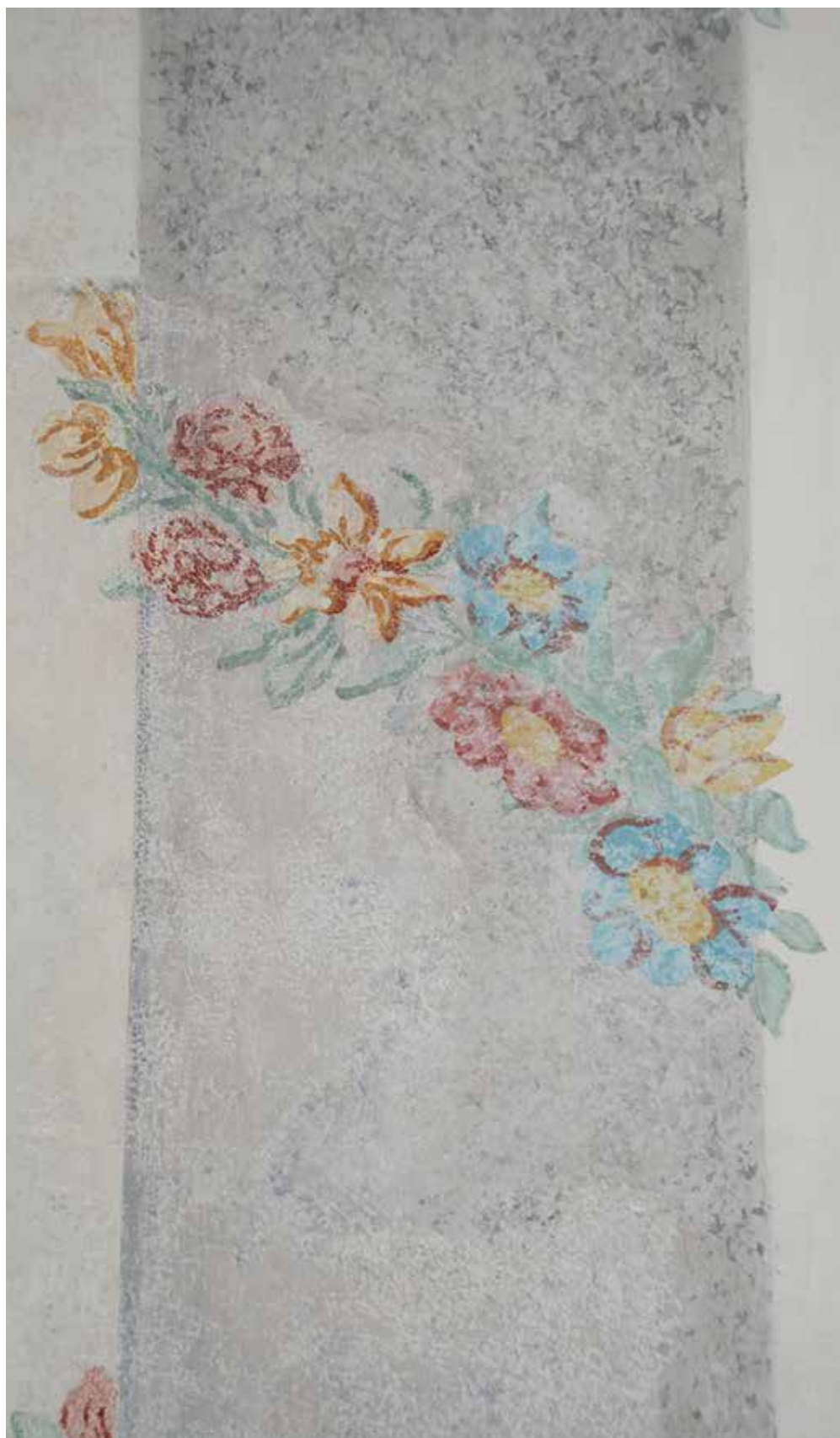
Slika 6: Levi spodnji del naslikanega stebra iz Lanthierijevega dvorca v Vipavi je original z retušo, izvedeno s pikicami. Zgornji desni del je rekonstrukcija v apnenem beležu. Rastlinske kite in cvetovi so rekonstruirani z matricami in naknadno senčeni po vzoru originala.
