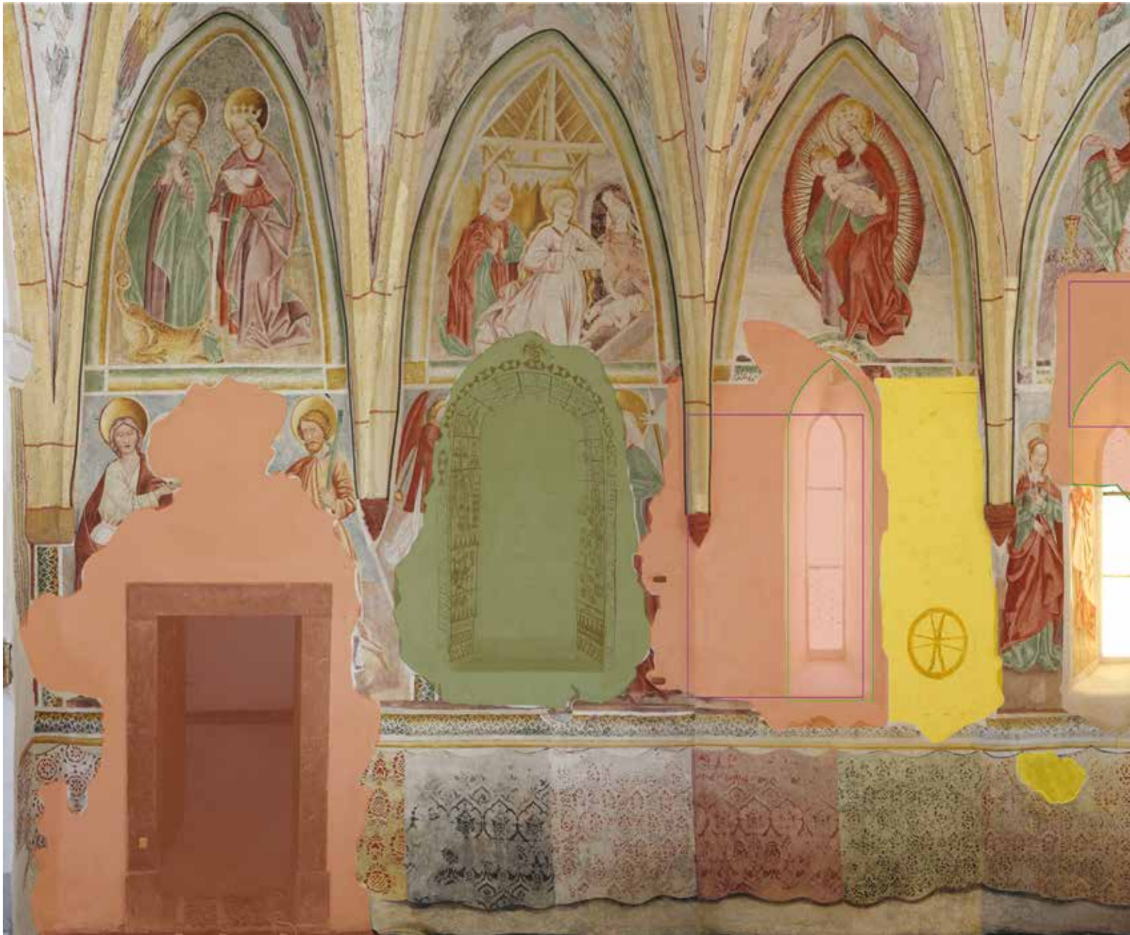
Slika 6: Različni nivoji in obdelave ometa govorijo o zgodovinskem sosledju poslikav, prezidav in poškodb, kot vidimo na orto-foto posnetku poslikave prezbiterija cerkve sv. Kancijana v Vrzdencu z izrisom in označbami poškodb in prezidav.
