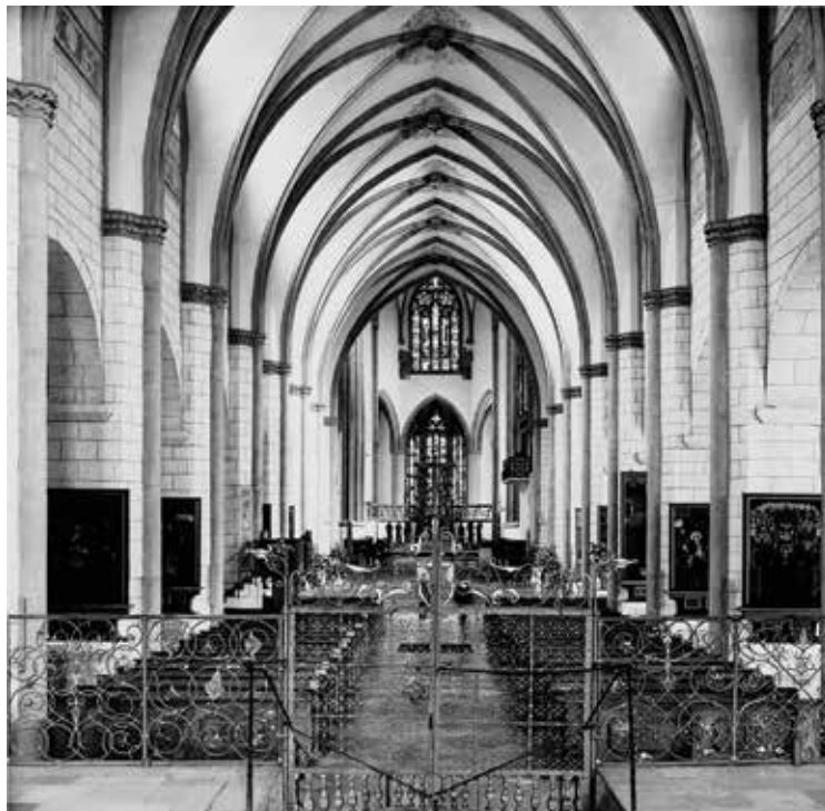
Slika 5a: Pogled v notranjščino augsburške katedrale proti oltarju na vzhodu z rekonstruiranim vzorcem kamna na arhitekturnih površinah. Vidimo stanje po konserviranju in beljenju originalnih najdb.
