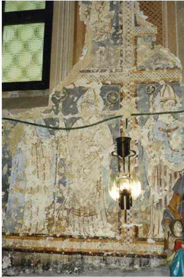
Slika 6a: Svetniške figure na severni steni ladje župnijske cerkve Svete Trojice v Veliki Nedelji med odkrivanjem.
