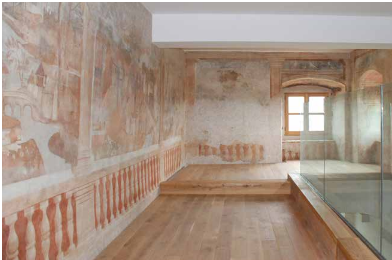
Sliki 4a, 4b: Pogled v prostor s poslikavo v vili Vipolže med posegi in po njih. Vrzeli v ometu so bile pokitane v nivoju poslikave in tonirane z barvami, nanesenimi s spužvami v svetlejših odtenkih okoliške poslikave. S tem manj izstopajo in so manj moteče.
