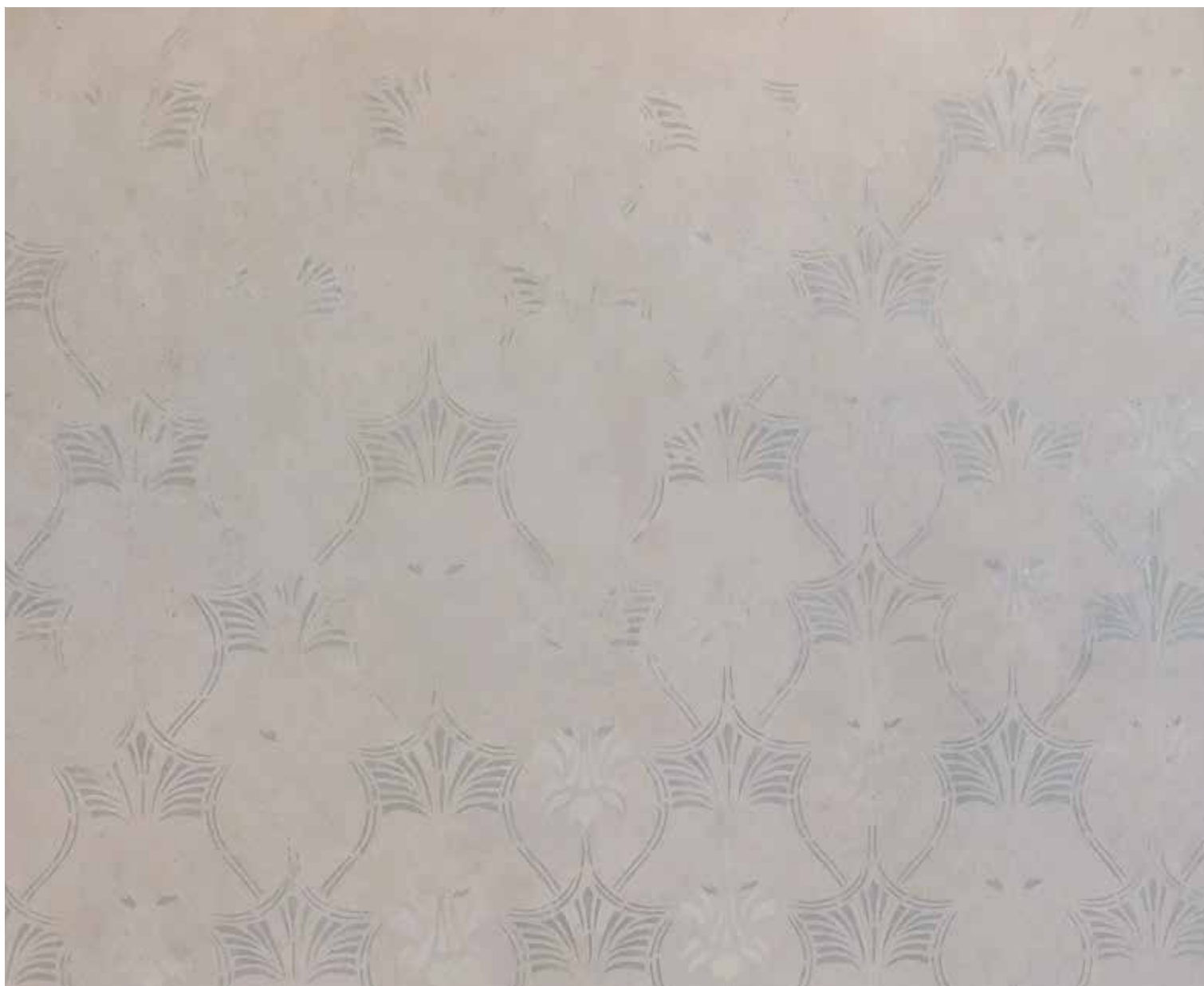
Slika 5: Na slabše ohranjenih površinah poslikav najprej tonsko obdelamo ozadje, kot vidimo na primeru iz stavbe Švicarija Pod turnom 4 v Ljubljani (2016/17). Taka površina je pripravljena za rekonstruiranje manjkajočih delov vzorca.
