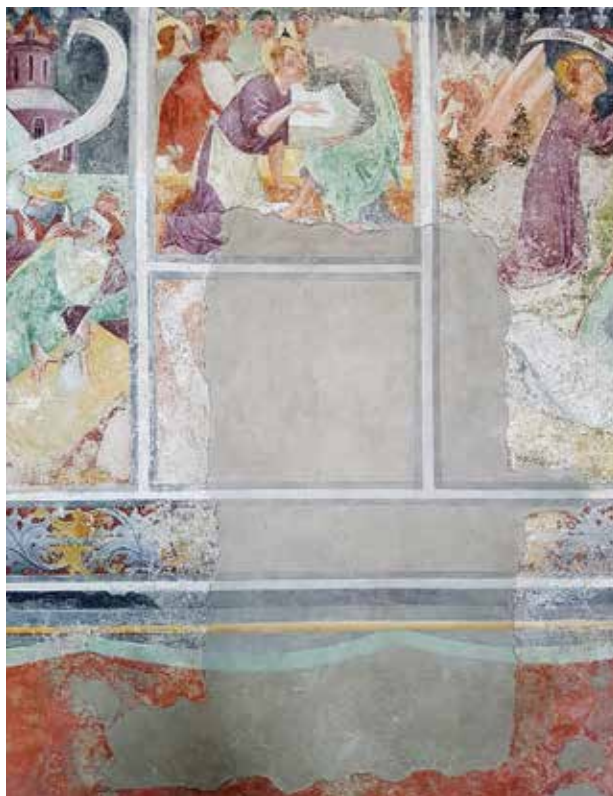
Slika 12: V cerkvi sv. Andreja v Vratih-Megvarjah/Thörl-Maglern so velike poškodbe dopolnjene z barvno usklajenim ometom in nakazano arhitektonsko členitvijo.
