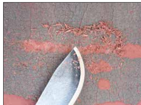
Slika 7: Emulzijski kit smo po sušenju površinsko obdelali in prilagodili strukturi originalne površine.
