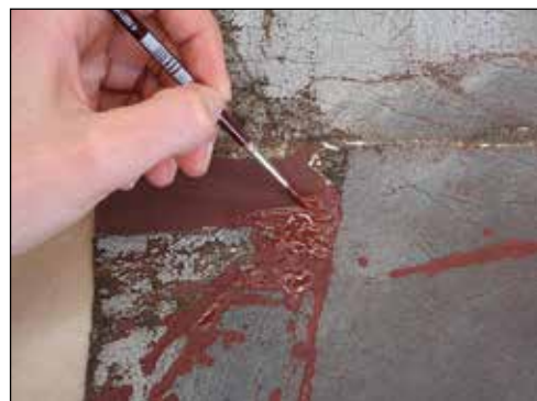
Slika 6: V primeru globokih poškodb smo v več slojih nanесли gosto maso, tanke razpoke pa smo zapolnjevali z redkejšo v enem sloju.
