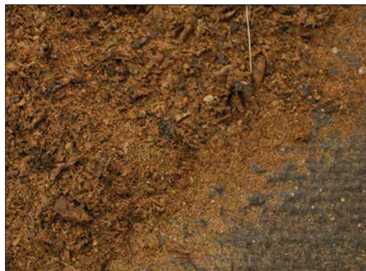
Slika 16: Detajl odstranjenega starega premaza.
