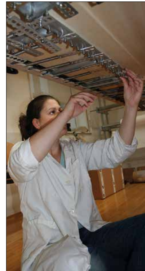
Fig. 28: Il graduale fissaggio delle placche perforate alle viti sulla cornice interna del telaio di alluminio.
