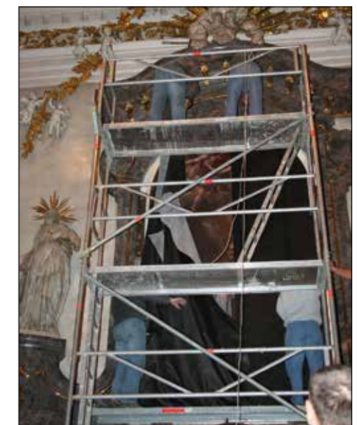
Fig. 12: Rimozione della pellicola protettiva dal dipinto dopo il posizionamento nella nicchia dell'altare.
