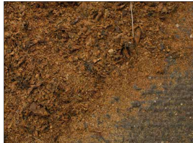
Fig. 16: Dettaglio della vecchia vernice rimossa.
