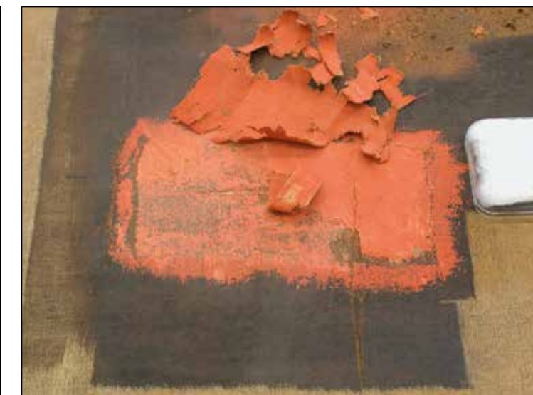
Fig. 15: Rimozione meccanica delle vecchie toppe e del minio rosso, sotto al quale si intravede la vecchia vernice.
