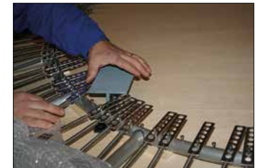
Fig. 8: Verifica della posizione dei supporti metallici sul telaio di alluminio.
