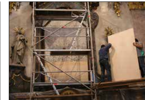
Fig. 7: Collocazione dei pannelli in legno sulla parete della nicchia dell'altare.
