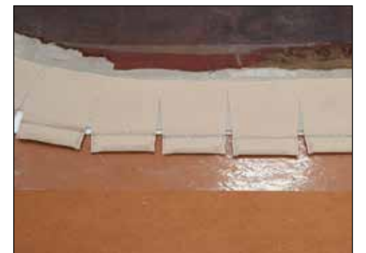
Fig. 20: Sul fronte i nastri sono incollati soltanto fino al supporto originale.
