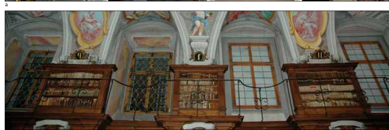
Sliki 17a in 17b: Severno slepo okno leta 2002 pred zadnjim restavriranjem, leta 2003 med njim in leta 2006 po njem v primerjavi z originalnim baročnim oknom v prostoru nad zakristijo (17a) in s slepimi okni v Semeniški knjižnici v Ljubljani (17b)
