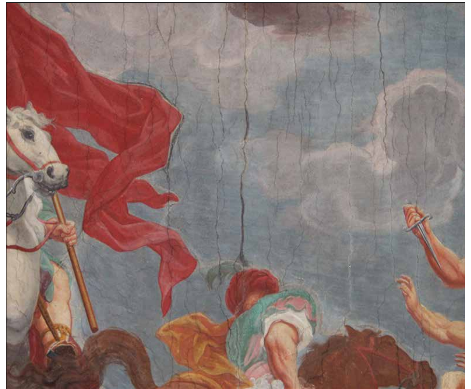
Slika 203: Območje oboka nad orglami z najgostejšo mrežo razpok; v sredini in levo ob rdeči draperiji potemnele retuše prejšnjega restavratorskega posega
