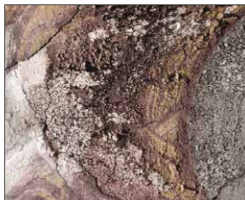
Slika 6: Kvadrant F3 – stanje nekaterih najbolj poškodovanih predelov poslikave v bližini severozahodnega zvonika
