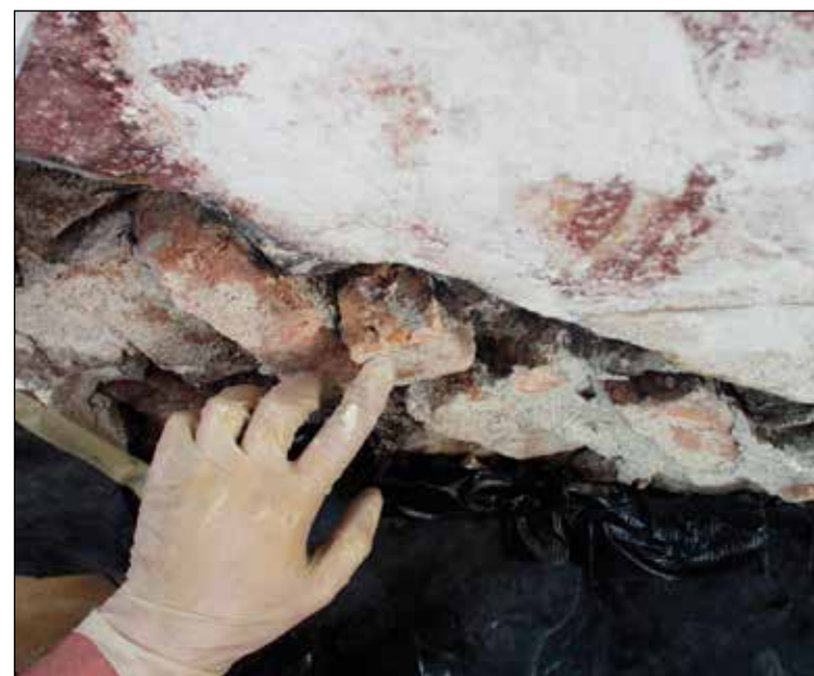
Slika 89: Razpoke na območju stika severnega zvonika in stene ladje
