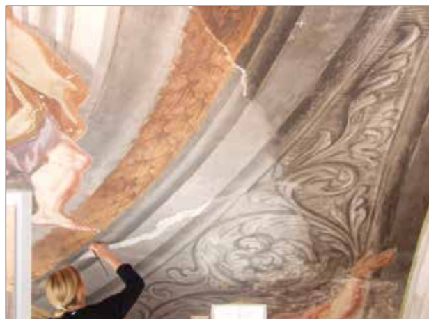
Slika 15: Potemnela rekonstruirana poslikava, nastala ob nanosu novega ometa na mestih, kjer je originalni omet odpadel med potresom leta 1895 (28. 5. 2004)
