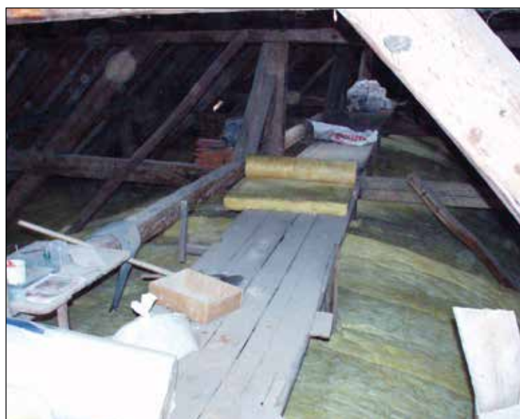
Slika 44: Polaganje termoizolacije na obok
