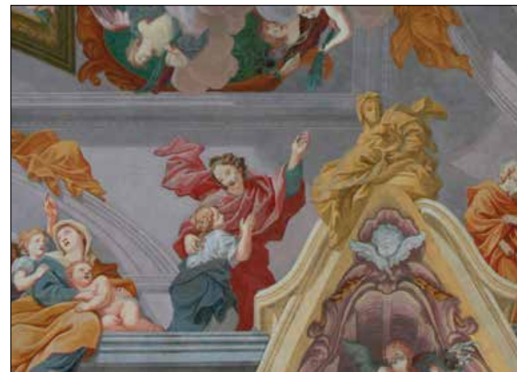
Slika 236: Stanje po obnovi z odstranjenimi znaki izsoljevanja
