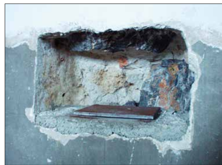
Slika 28: Vdolbina, nastala ob sidranju restavratorskega platoja
