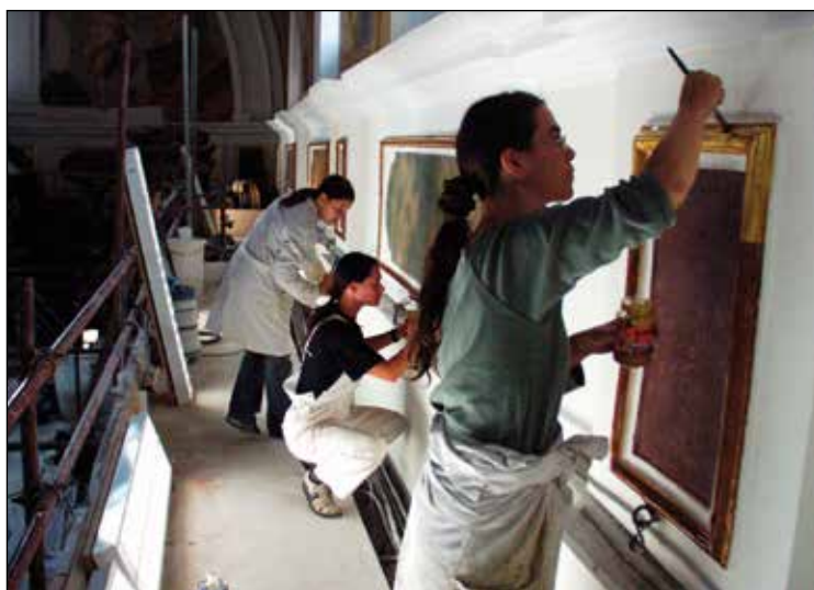
Slika 239: Zlatenje okvirjev na severni steni ladje
