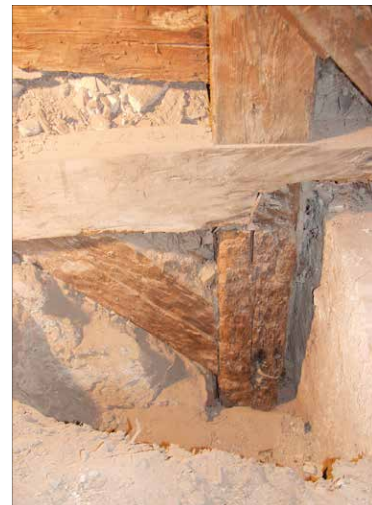
Slika 42: Sidranje strešne konstrukcije
