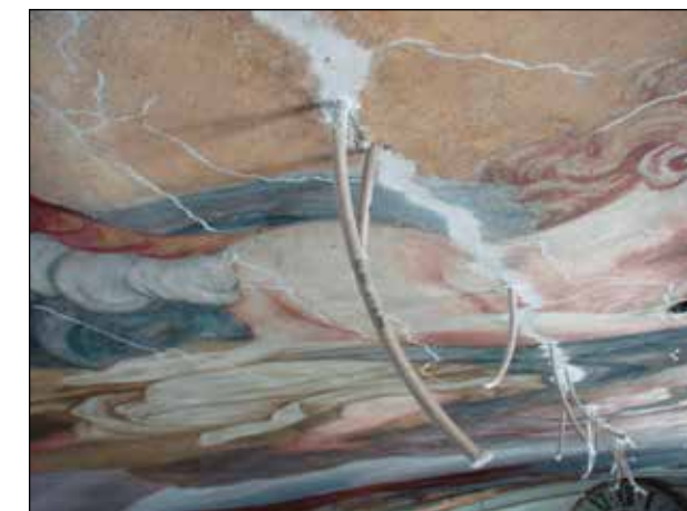
Slika 20: Cevke po končanem injektiranju (25. 5. 2005)
