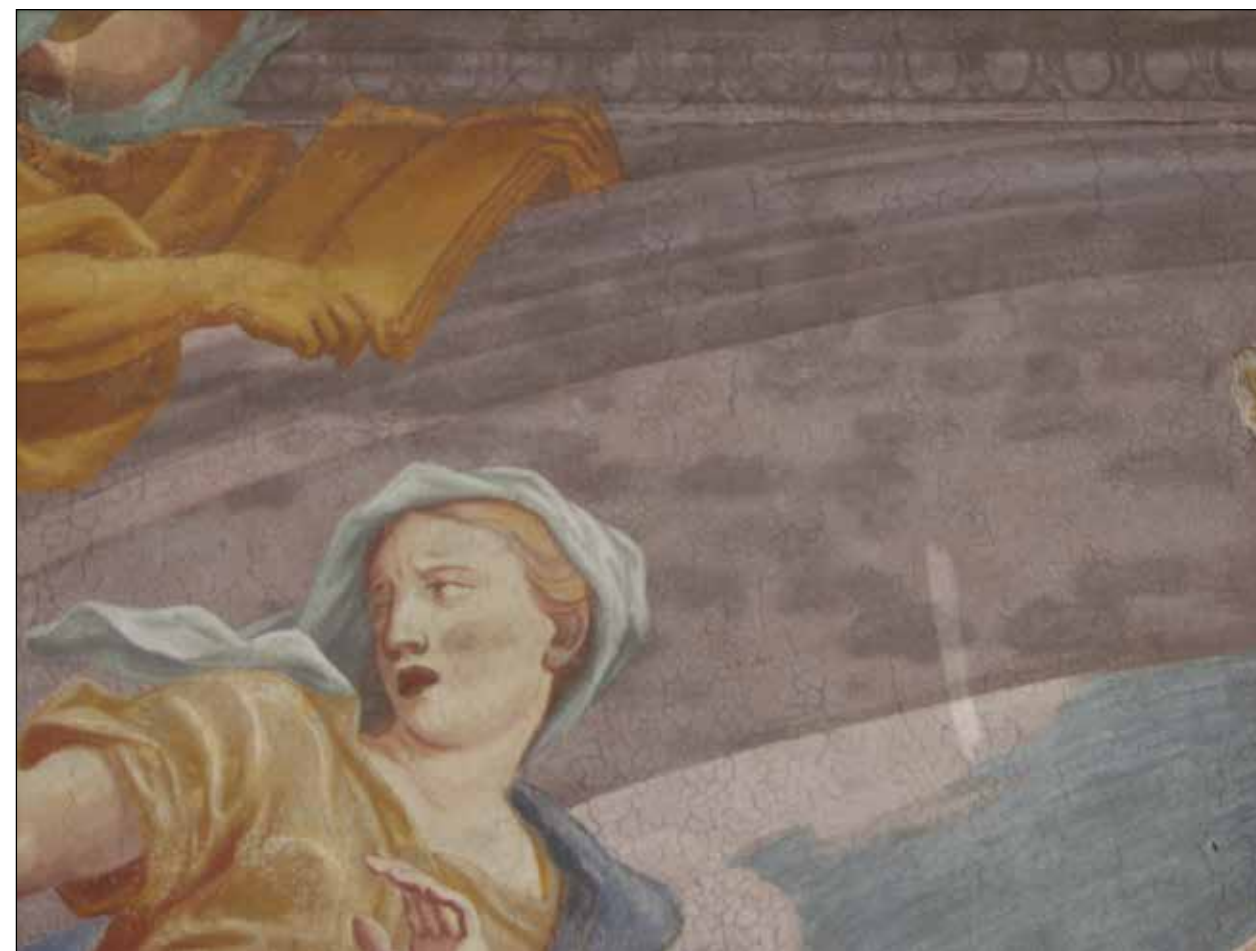
Slika 1: Kvadrant G12, 13 – potemnela površina z označenimi pravokotnimi madeži na perspektivno naslikani arhitekturi nad mestom, ki ustreza položaju opeke v zidu ladijskega oboka.
