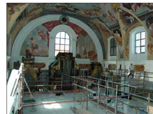
Slika 25: Zaključna dela po odstranitvi delovnega platoja (31. 8. 2006)
