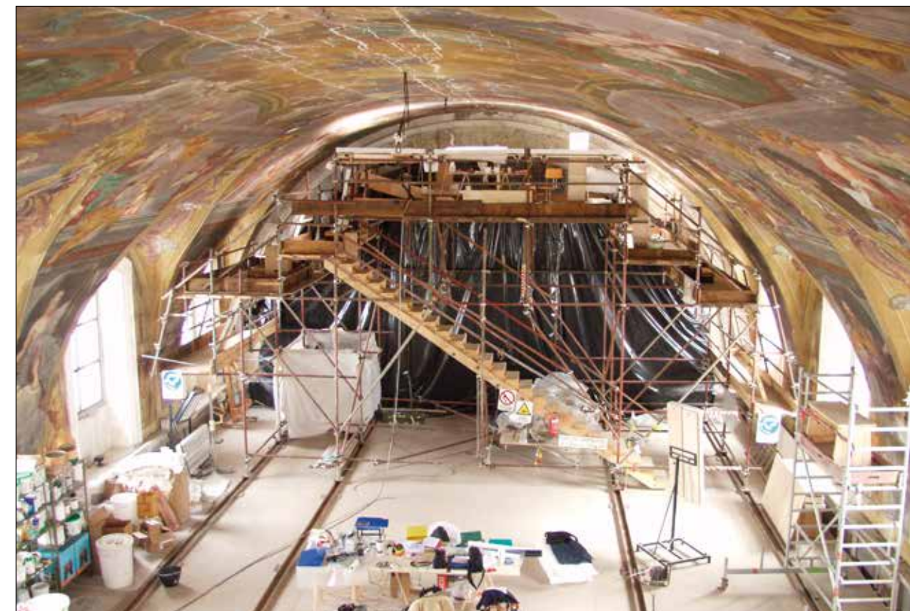
Slika 52: Pogled proti vzhodu: prečni oder na restavratorskem platoju
