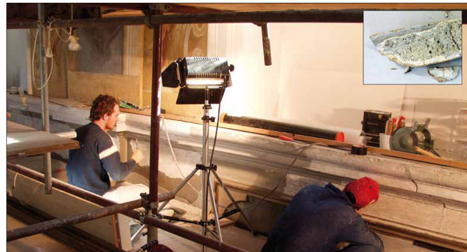
Slika 33: Odstranjevanje potemnelih beležev z venčne profilacije pod Quaglijevo poslikavo. Na manjši sliki vidimo plasti štukaturnega ometa na profilu venca.
