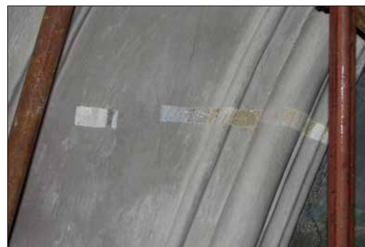
Slika 179: S sondiranjem je bila ugotovljena okrasta obarvanost profilacije večjega loka, profilacij ob oknu, kapitelov ter marmorirana površina na pilastrih.
