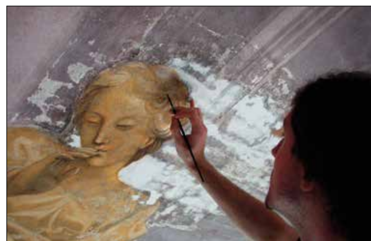
Sliki 217, 218: Pred rekonstrukcijo je bil na kraju poškodbe oblikovan apneni omet primerne strukture. Po obsegu je to največja rekonstrukcija poslikave na oboku.
