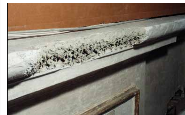
Slika 29: Nanos nove vezalne malte ob začetku rekonstrukcije venca
