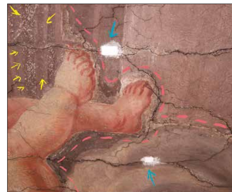
Slika 127: Premostitev razpok z mavcem – preprosta metoda za opazovanje dejavnosti razpok, ki pa je le informativna – če mavec počni v smeri razpoke, vemo, da je premik nastal, ne vemo pa, kdaj se je to zgodilo in ali je razpoka še aktivna.
