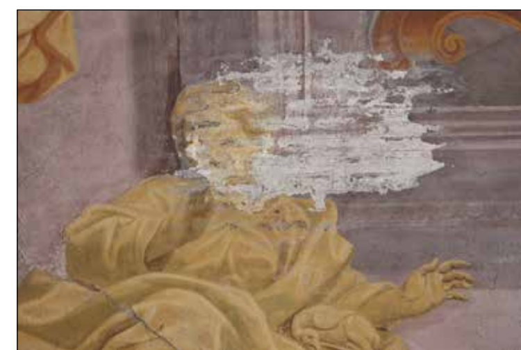
Slika 220: Stanje po dolgotrajnem zamakanju skozi opečno zidavo z izgubo barvne plasti v predelu obraza in lasišča. Poškodba pred posegom.
