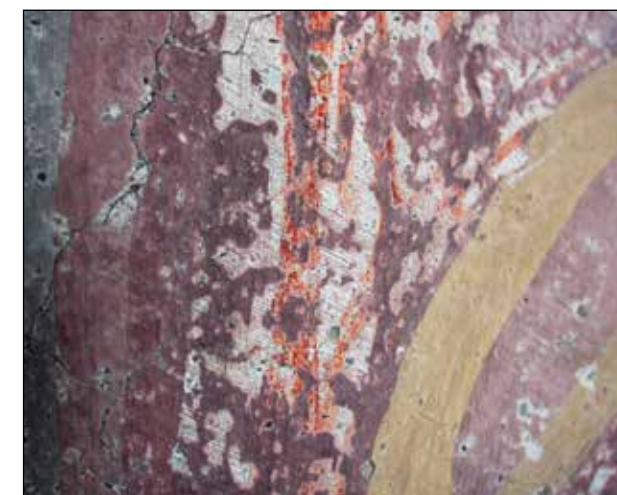
Slika 158: Plasti beležev, nanesene na že osušen glajenec in osnovni belež so se zaradi karbonizirane površine slabše oprijele podlage. Njihovo oprijemljivost je zagotavljala le tanka, slabotna plast kalcijevega karbonata, ki je nastala znotraj posameznih plasti beležev. Zato tudi odpadanje in luščenje slabo oprijetih zgornjih beležev.
