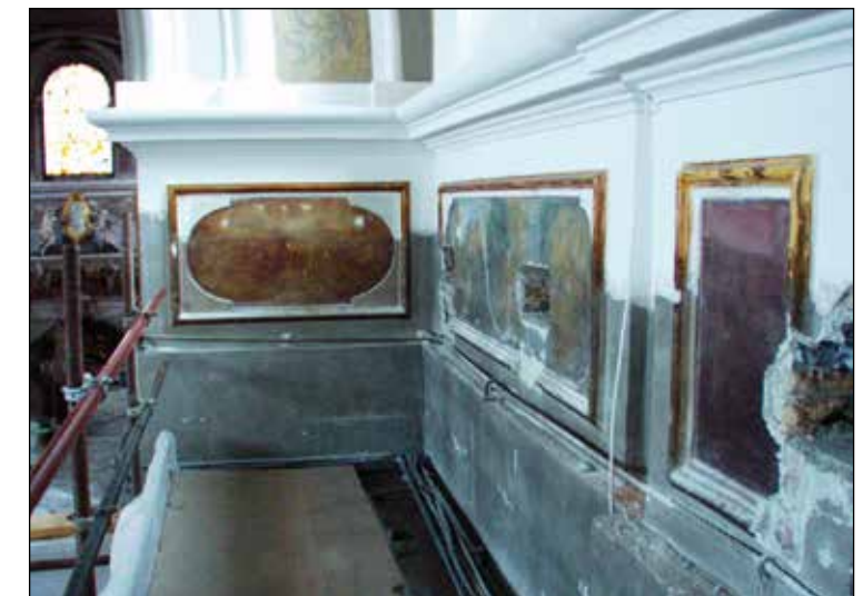
Slika 238: Vidne odprtine, v katere so bili nameščeni nosilci odra in razlika med očiščeno in neočiščeno površino
