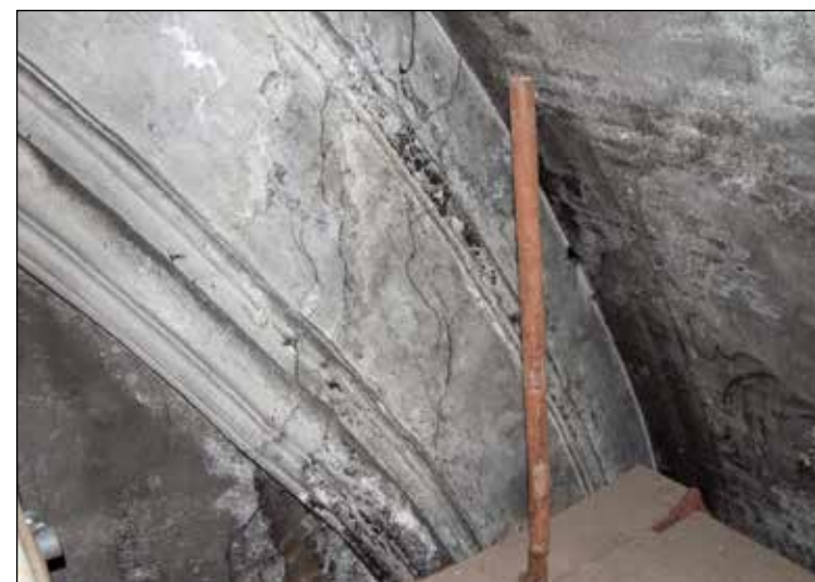
Slika 177: Luščenje ometa in značilni vzorci v rastru opeke v SZ-kotu
