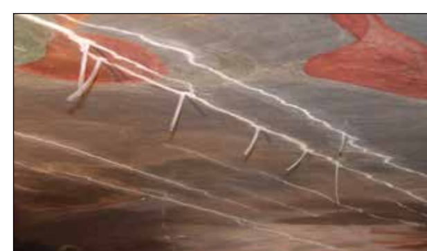
Slika 14: Vstavljanje cevok za injektiranje (2. 4. 2004)
