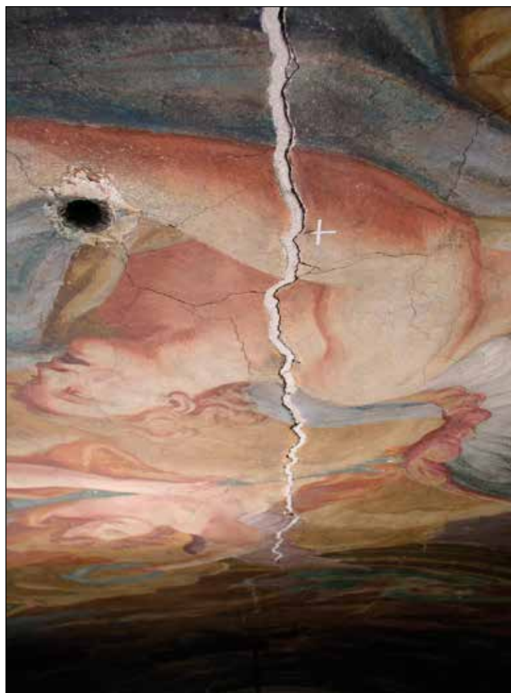
Slika 32: Stanje pred posegom – nova razpoka ob nekoč že zapolnjeni teče nekaj časa po eni, nekaj časa pa po drugi strani.
