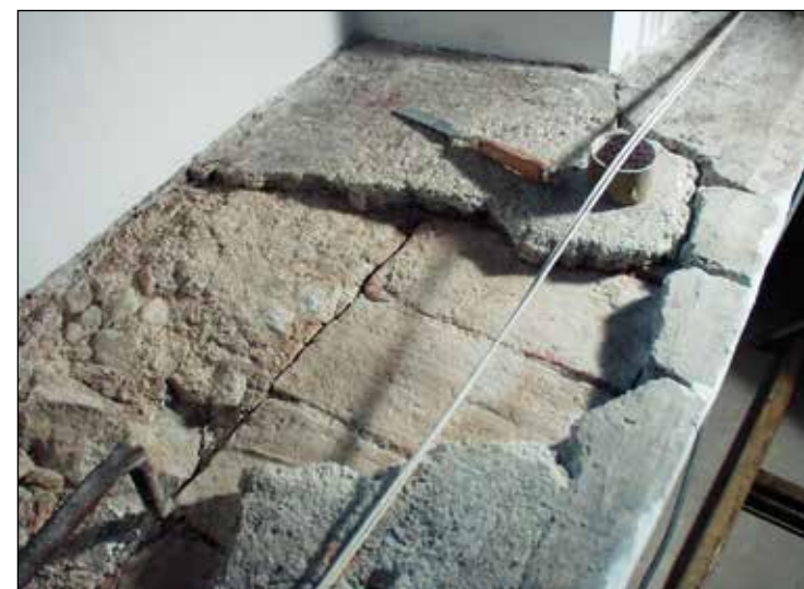
Slika 27: Polica pod obočnim oknom, kjer je vidna zidava profilov z opeko
