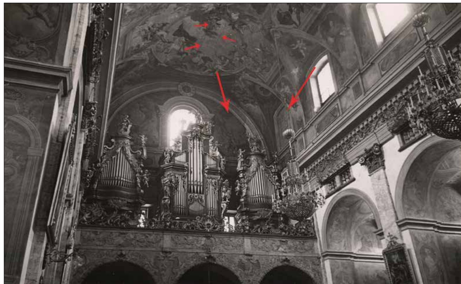
Slika 8b: Domnevno Železnikov posnetek notranjščine proti severozahodu z močnimi poškodbami v predelu stika z zvonikom in z okrasno poslikavo na slepem oknu
