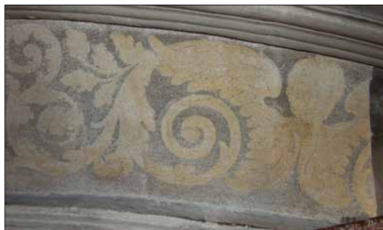
Slika 169: Stanje po odstranitvi beležev
