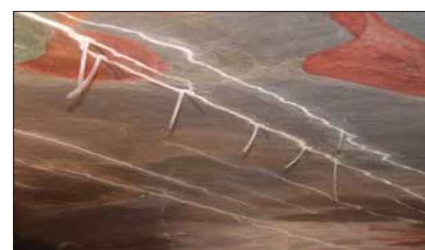
Fig. 14: Inserimento delle cannule per l'iniezione (2. 4. 2004).
