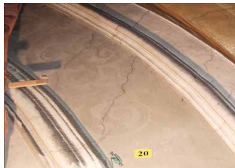
Fig. 167: Evidenti tracce delle pitture prima dei sondaggi.
