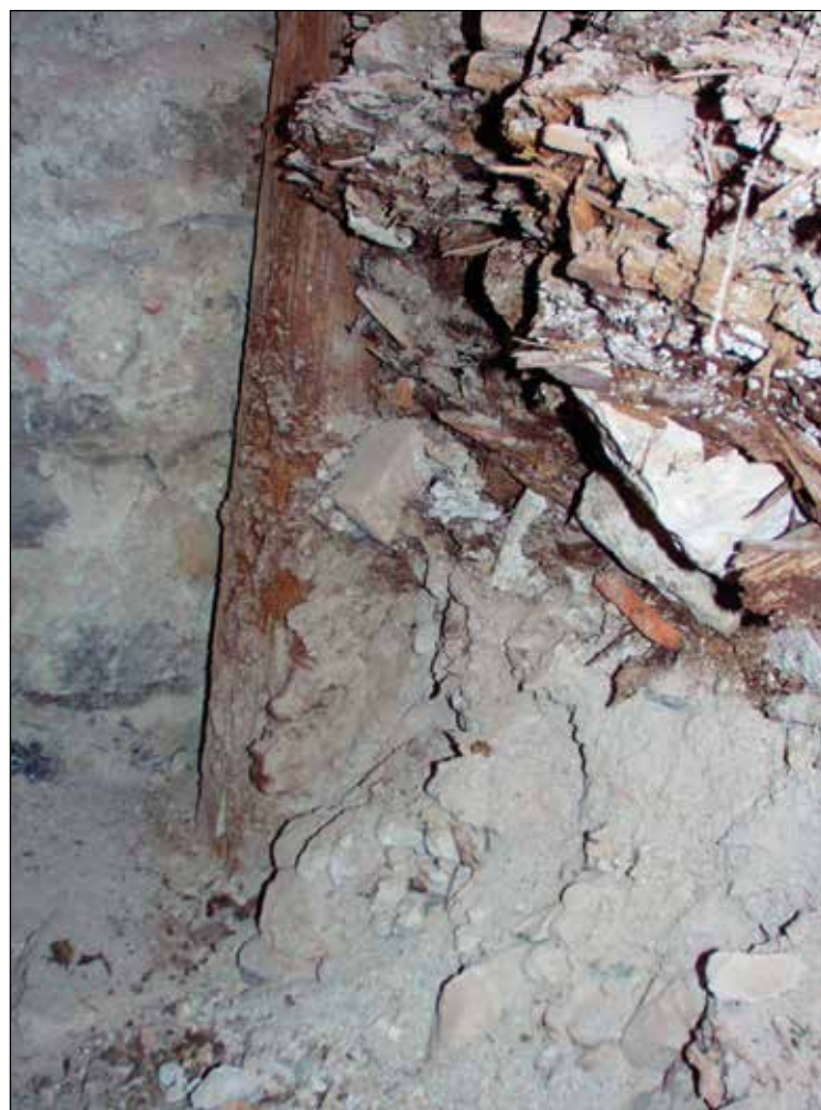
Fig. 39: Sondaggio del materiale di riempimento.
