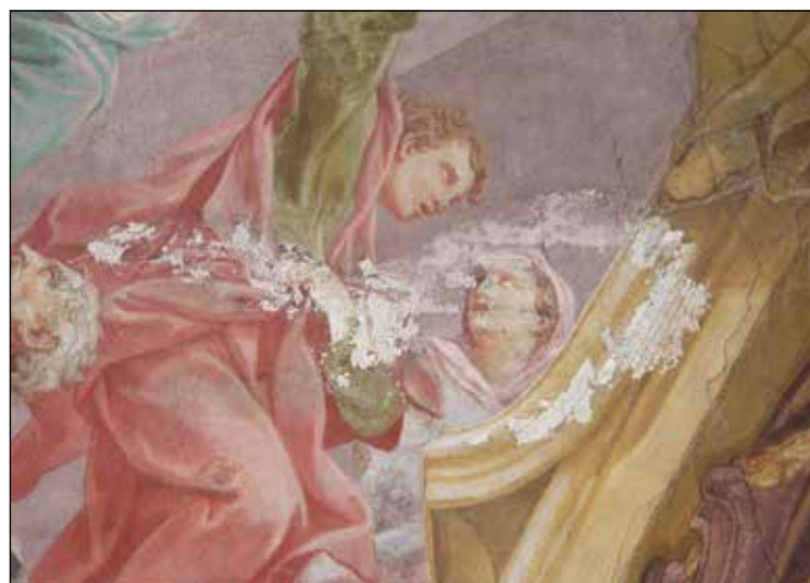
Fig. 223: La testa della figura nel quadrante F7 con massicci segni di solfatazione.
