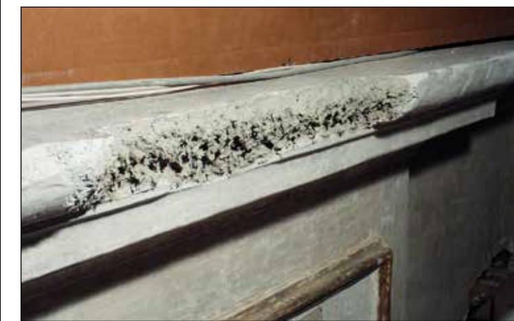
Fig. 29: Applicazione di nuova malta legante all'inizio della ricostruzione del cornicione.
