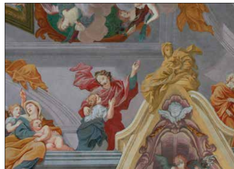
Fig. 236: Situazione dopo il rinnovo con l'eliminazione dei segni della solfatazione.
