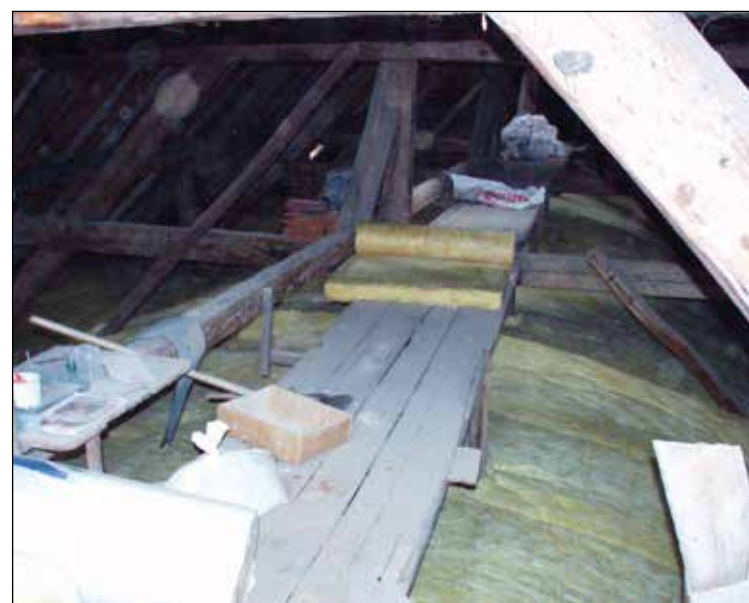
Fig. 44: Applicazione dell'isolante termico sulla volta.
