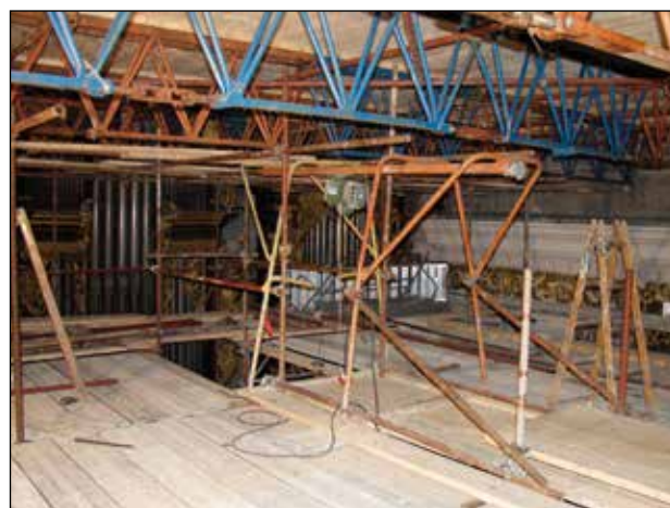
Fig. 1: Durante l'allestimento della piattaforma per il restauro (24. 10. 2002).
