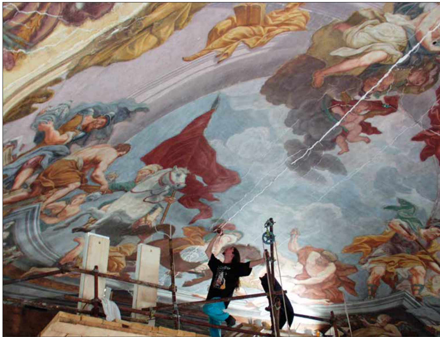
Fig. 208: Ritocco della fessura (fig. 203) ripulita e nuovamente sigillata, dove durante gli ultimi interventi di restauro era stato utilizzato un legante che con gli anni è scurito.
