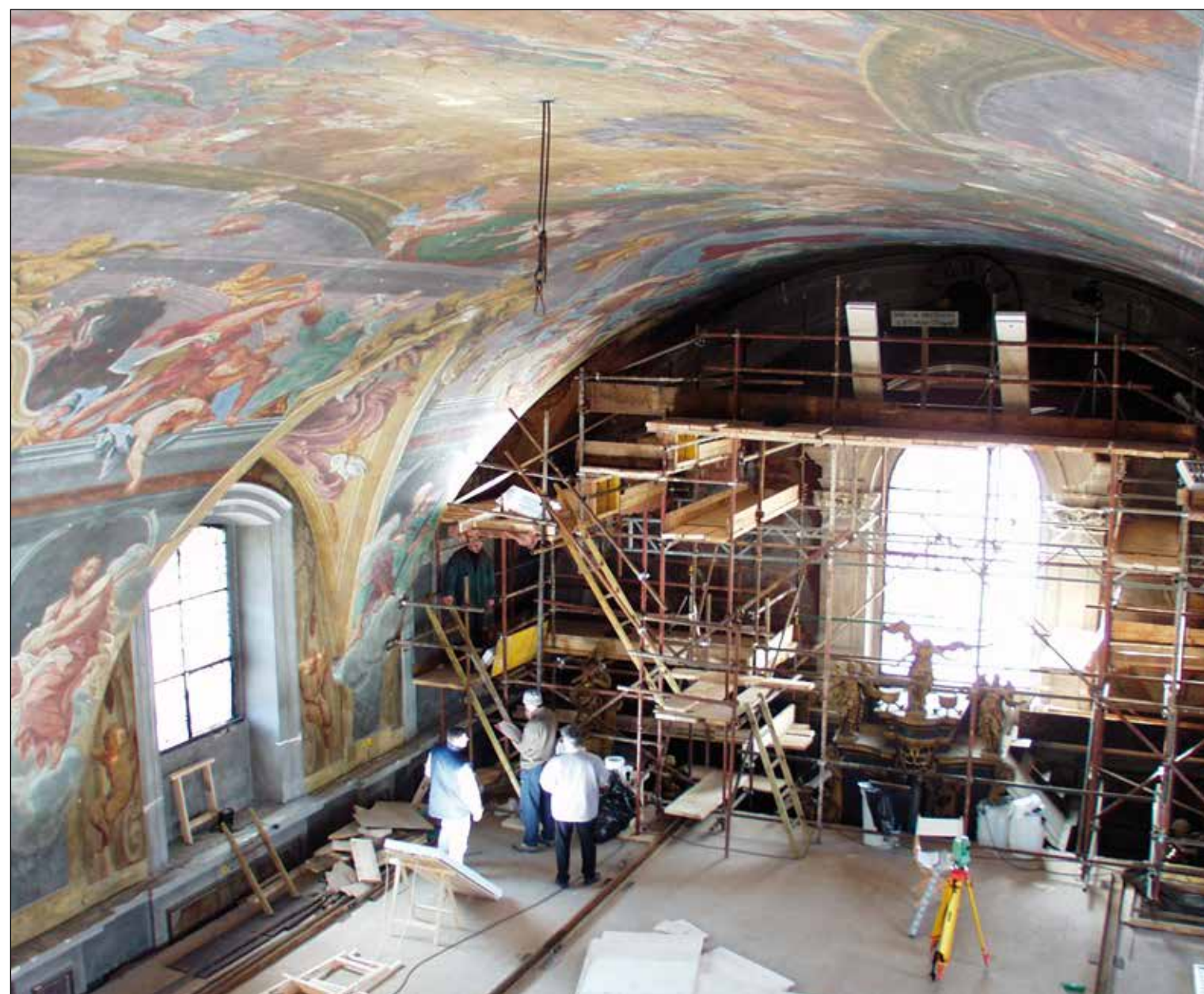
Fig. 7: Vista sulla parete occidentale – gennaio 2003. Nonostante l'intensa luce diurna, a causa del ponteggio senza illuminazione artificiale la controfacciata è in penombra.
