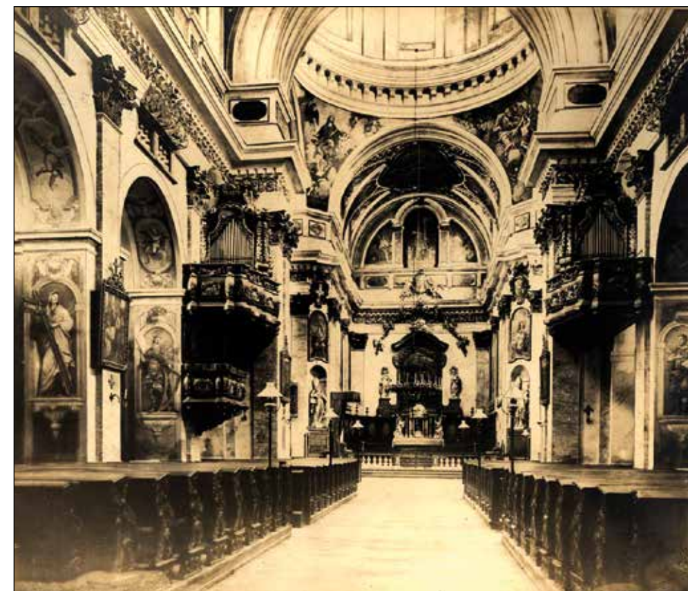
Fig. 5a: Le più antiche immagini degli interni della chiesa sono le foto del Kotar (pubblicate in: STESKA 1903). Sul retro dell'immagine con la vista dell'interno verso est (l'arco trionfale si presenta ancora senza pitture) c'è la scritta «1898», anno in cui il Kotar realizzò una serie di nuove cartoline di vari edifici di Lubiana ed in particolare delle chiese (vedi: Slovenski narod, 1898, p. 3).
