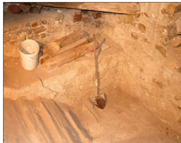
Fig. 41: Sondaggio esplorativo dopo l'asportazione temporanea del materiale di riempimento.
