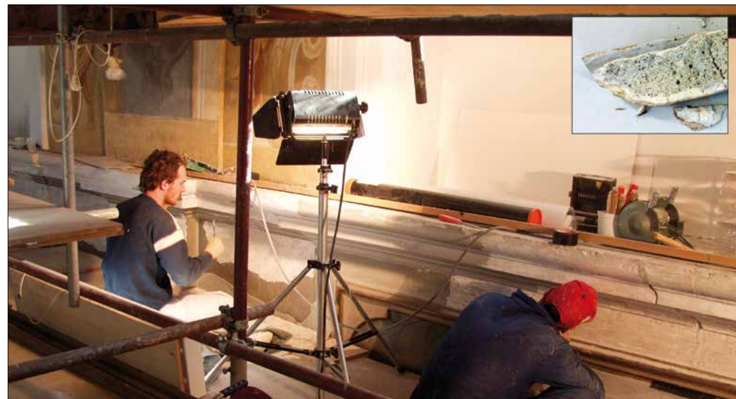
Fig. 33: Rimozione degli scialbi scuriti dai profili della cornice sotto l'affresco del Quaglio. Nella foto più piccola si vedono gli strati di intonaco dello stucco sul profilo della cornice.
