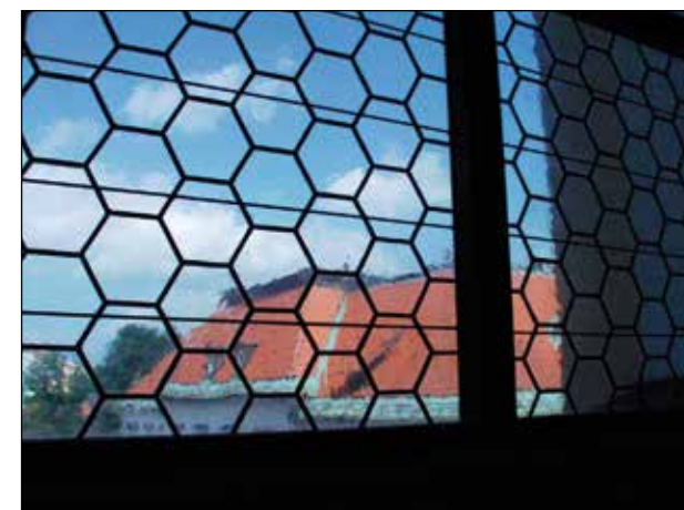
Fig. 21: La posa in opera delle nuove invetriate (7. 9. 2005).
