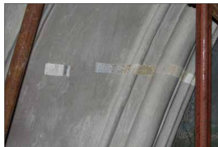
Fig. 179: Con i sondaggi è stata individuata la colorazione ocre della modanatura dell'arco maggiore, delle profilature accanto alla finestra e dei capitelli nonché la decorazione in finto marmo dei pilastri.
