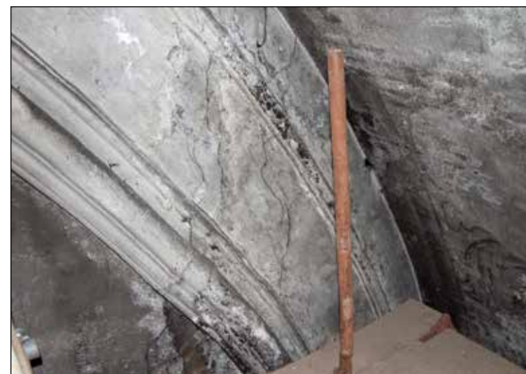
Fig. 177: Desquamazione degli intonaci ed elementi caratteristici nella struttura in mattoni nell'angolo NO.
