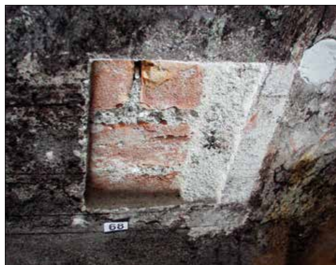
Fig. 24 e 25: L'intonaco di calce formato da due strati.
