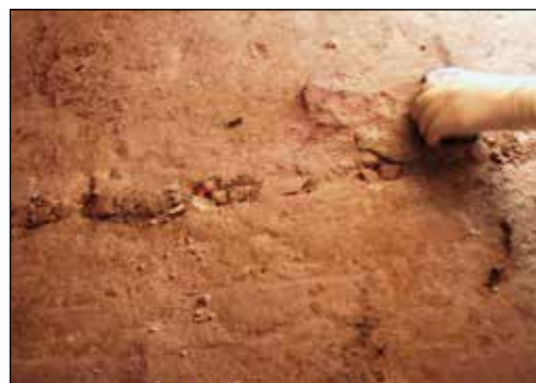
Fig. 160a e 160b: Iniezione delle fessure dall'estradosso della volta (sottotetto).
