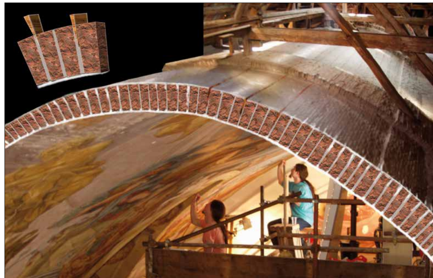
Fig. 18: Sezione della struttura in mattoni della volta.
