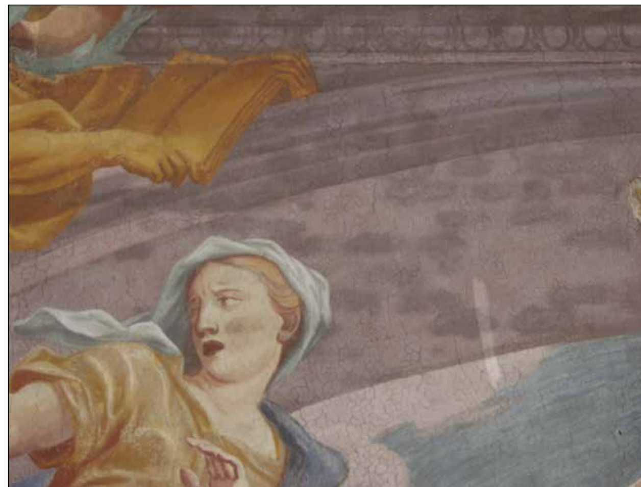
Fig. 1: Quadrante G12, 13 – scurimento della superficie pittorica, con evidenziazione delle macchie rettangolari presenti sullo sfondato architettonico in corrispondenza dei mattoni sottostanti alla volta.
