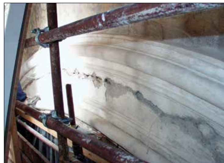
Figg. 170 e 171: Una fessura profonda oltre 80 cm.
