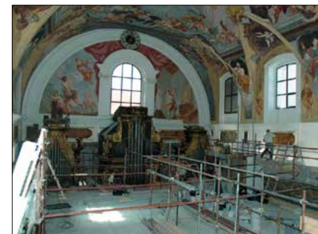
Fig. 25: Lavori conclusivi dopo lo smantellamento della piattaforma di lavoro (31. 8. 2006)
