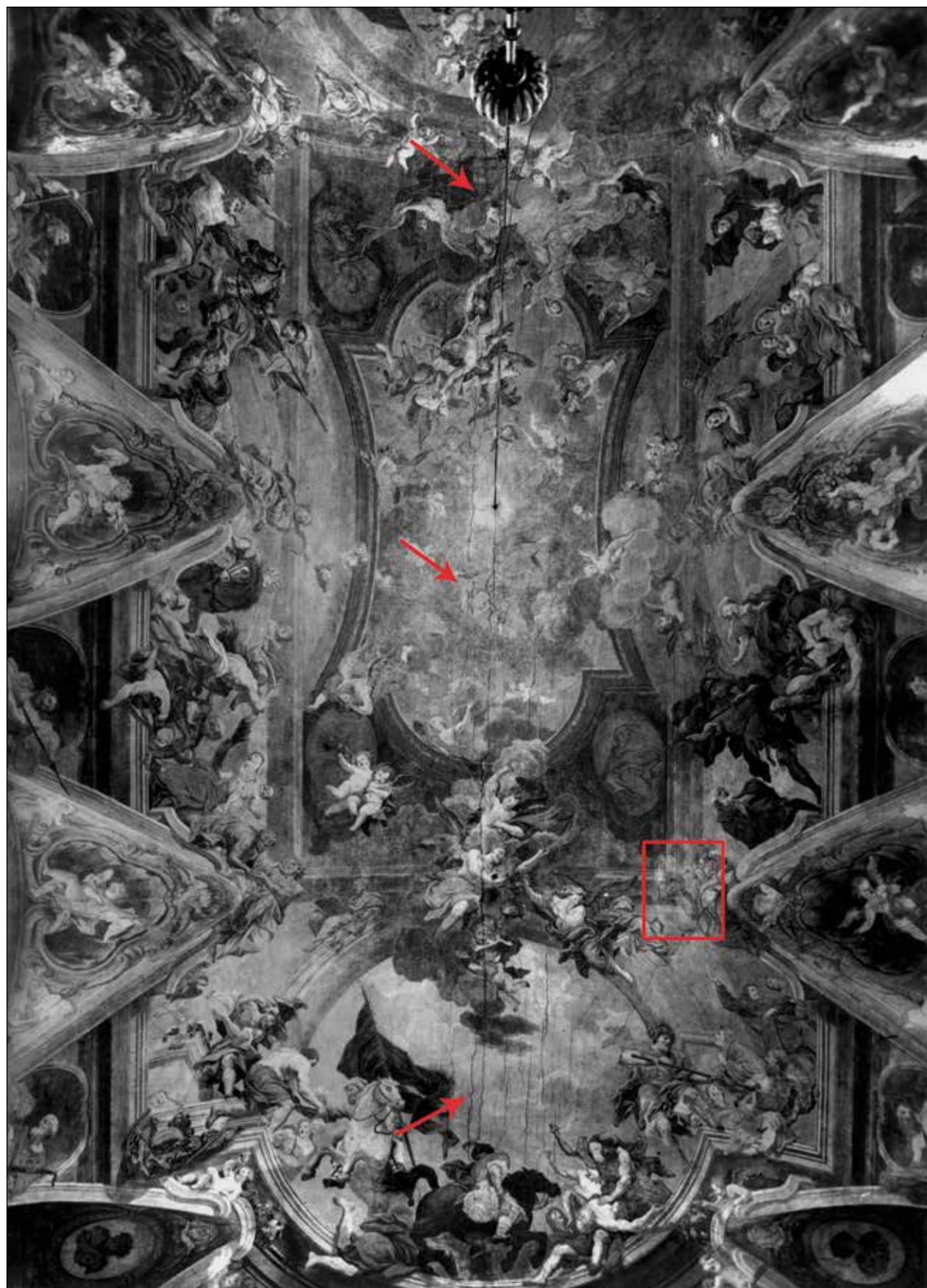
Fig. 18a: Nella fotografia della volta della navata, di autore e data ignoti, l'affresco, sul quale sono ben visibili fessure e sporcizia, sembra non restaurato.
