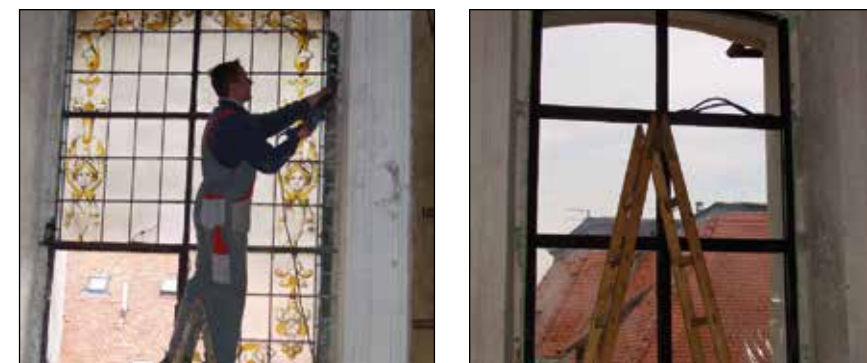
Fig. 11: Sostituzione dei telai lesionati e dei vetri delle finestre (15. 1. 2004).
