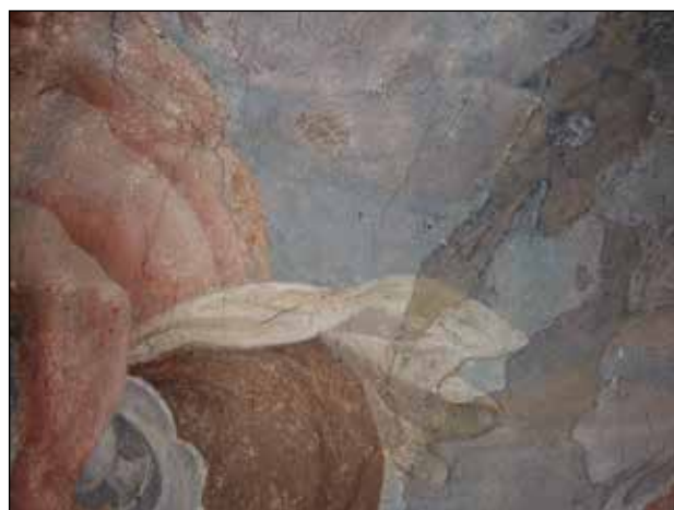
Fig. 2: Tracce delle lesioni più importanti sui dipinti della controfacciata (5. 12. 2002).
