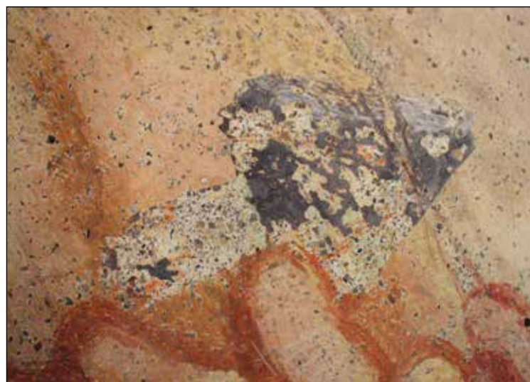
Fig. 145: Dettaglio del chiodo dipinto – il restringimento del legante ha provocato il distacco dello strato inferiore.
