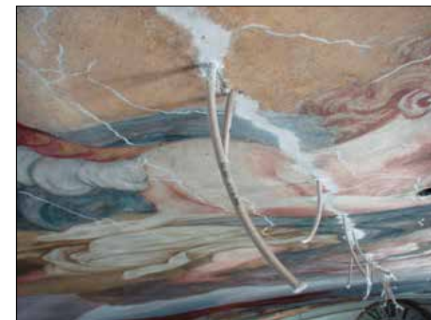
Fig. 20: Le cannule al termine dell'iniezione (25. 5. 2005).
