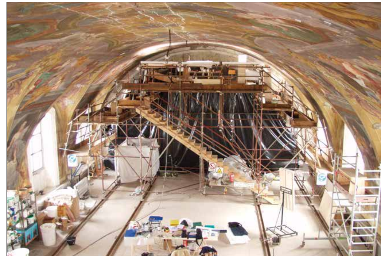
Fig. 52: Vista verso est: il ponteggio mobile sulla piattaforma per il restauro.
