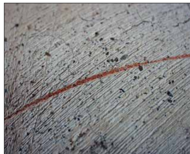
Fig. 154: La tipica superficie di una stesura di base a bianco di calce. Già qui, sulla superficie non ancora dipinta, sono evidenti i frammenti decoesi di scialbo, in particolare sono visibili delle minuscole pietruzze scure, probabilmente parte integrante dello scialbo. È anche possibile che queste parti non ben coese, che avrebbero potuto staccarsi anche da sole e disturbare il lavoro di pittura, siano state volutamente rimosse spazzolando la superficie (HUDOKLIN 1955, p. 39, fig. 37).
