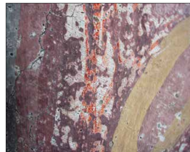
Fig. 158: Gli strati di scialbo, applicati sull'intonaco già essiccato e sull'imbiancatura di base non si sono ben fissati al supporto a causa della superficie carbonatata. La loro adesione era assicurata solo dalla sottile e debole pellicola di carbonato di calcio che si era formata all'interno dei singoli strati di scialbo. Da ciò deriva anche il distacco e la desquamazione delle imbiancature superiori che presentano notevoli difetti di coesione.
