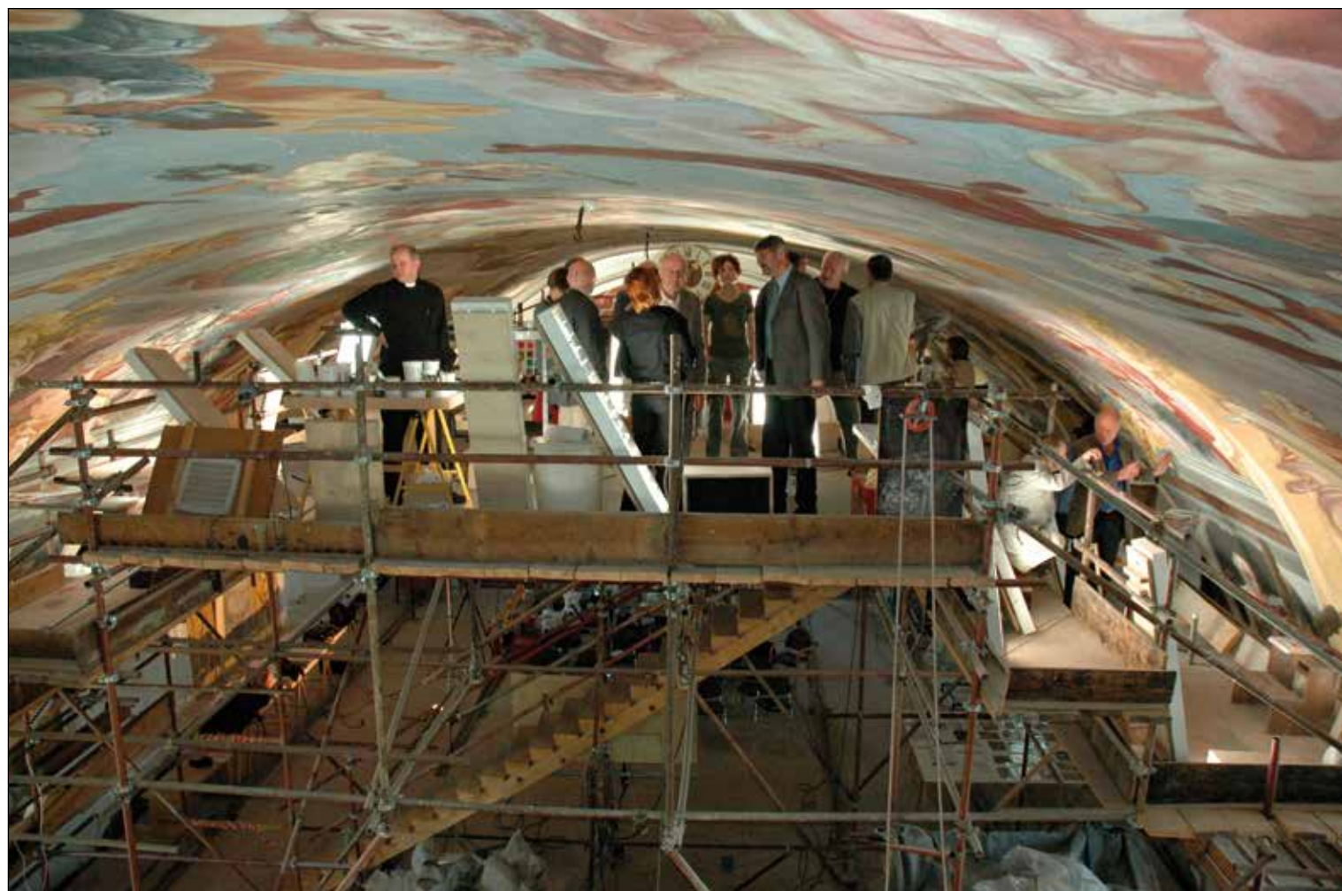
Fig. 24: Le commissioni competenti durante un sopralluogo nelle ultime fasi dei lavori (22. 5. 2006).
