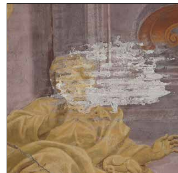
Fig. 18b e 18c: L'ingrandimento di un particolare (18b) della fig. 18a evidenzia intorno alla testa della prima virtù a nord ( Carità ) la traccia di una prolungata infiltrazione d'acqua: 18c – la situazione nel 2004.
