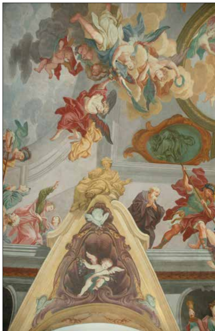
Fig. 221: Parte del dipinto restaurato sulla volta, compresa la ricostruzione.
