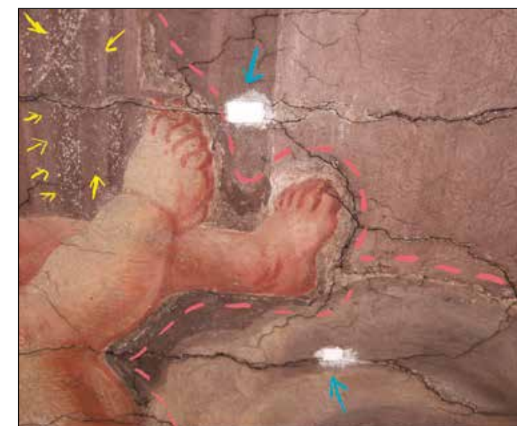
Le biffe in gesso sulle fessure Giornate Microcadute dello strato di colore
