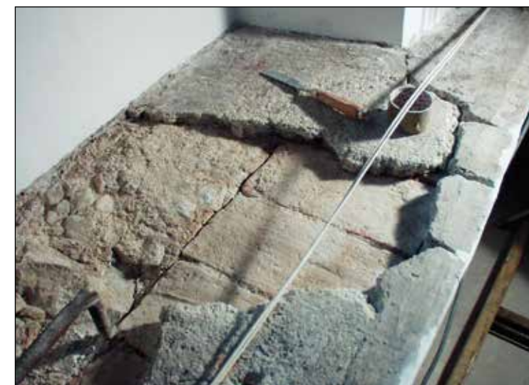
Fig. 27: La mensola sotto la finestra della volta dove è visibile la struttura in mattoni dei profili.
