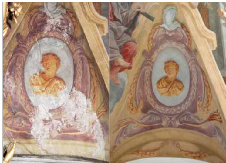
Fig. 95: Punto di contatto delle pareti N e O – prima e dopo il rinnovo.
