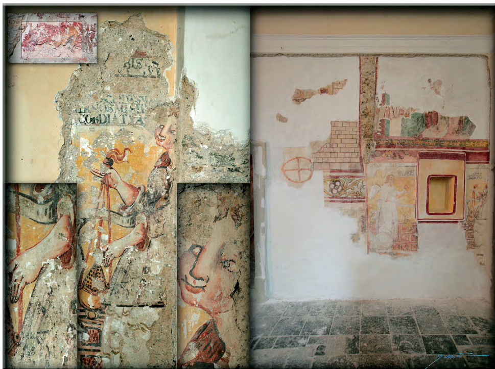
Mozelj, cerkev sv. Lenarta, levo detail pred restavratorskim posegom, desno po restavratorskem posegu (foto: L. Milić)
