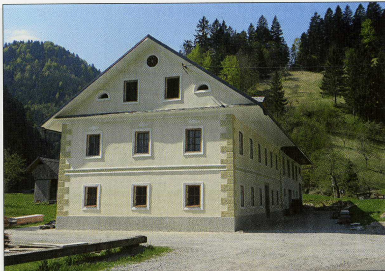
Domačija Jesenovc 5 po obnovi. Foto: Damjana Pediček Terseglav, 2011
