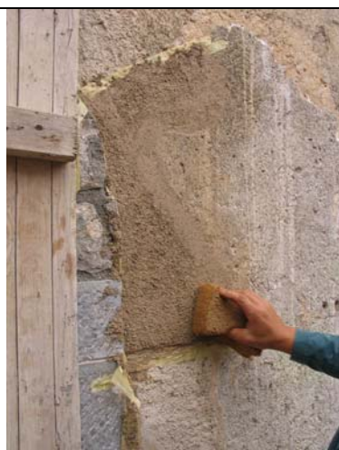
Prilagajanje zaplate novega ometa originalu- očistiti stik, zagladiti površino.
