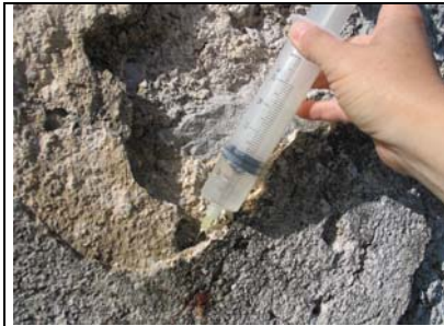
Utrjevanje odtoplih delov, najprej apnena voda.
