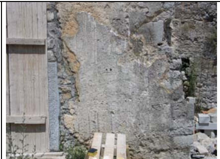
Očiščen in injektiran del originalnega ometa
