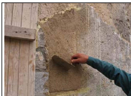
Zapolnjevanje praznin s finalnim ometom
