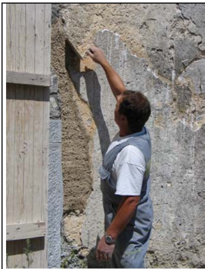
Zapolnjevanje praznin z grobim podložnim ometom
