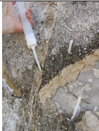
Injektiranje z apneno maso
