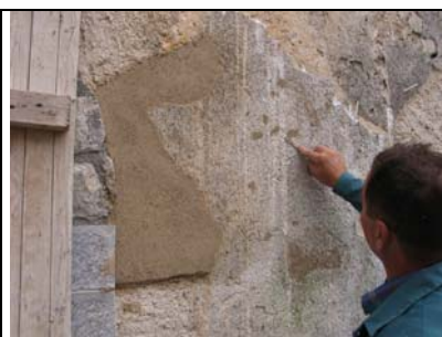
Konservirana zaplata ometa, zapolnjevanje manjših pomankljivosti. Celotno fasado je možno poenotiti z apnenim beležem ali pustiti vidne nove – stare omete, s čimer v večji meri ohranimo patino. Vzorec na hiši Markočič.
