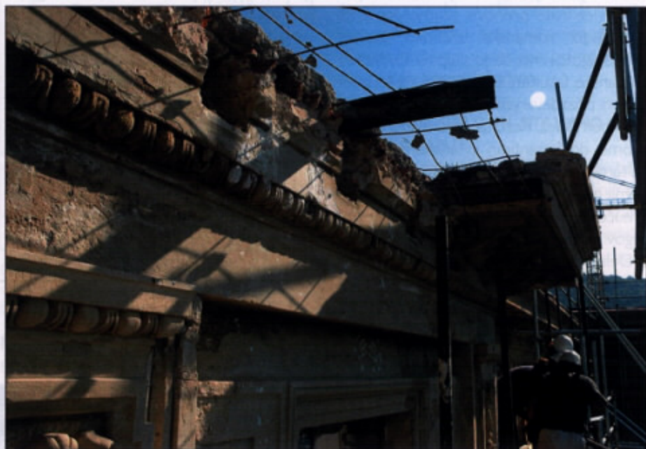
Strešni napušč hotela Palace v Portorožu med rušenjem
