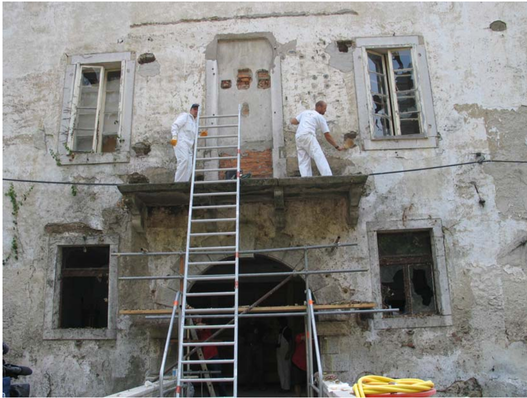
Slika 8: Čiščenje kamnitih členov in ometov na fasadi, fotografija Mateja Kavčič
