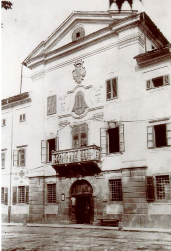
Slika 2: Arhivski posnetek glavne fasade Lanthierjevega dvorca v Vipavi, iz dokumentacije ZVKDS OE Nova Gorica
