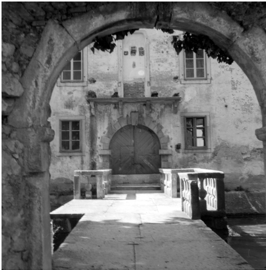
Slika 3: Arhivski posnetek mostička čez Vipavo in portala pred porušenjem, iz dokumentacije ZVKDS OE Nova Gorica
