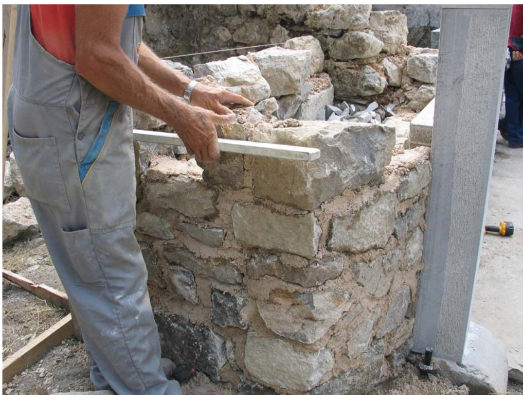
Slika 7: Zidanje dvoslojnega kamnitega zidu za vzidavo portona, fotografija Mateja Kavčič
