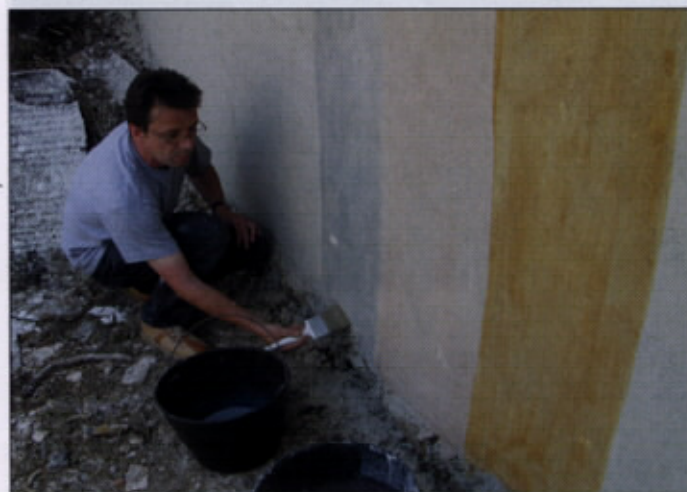
Barvanje fasade z mineralnim pigmentom v moker omet je ena najobstojnejših tehnologij – fresko tehnika.
