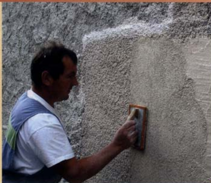
Vzorec narejenega fino zaribanega ometa
