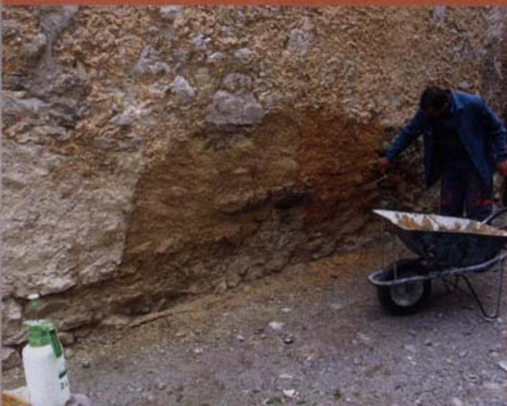
Popravilo grobega fasadnega obrizga, pripravljen v treh različnih odtenkih malt
