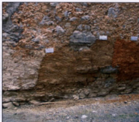
Grobi fasadni obrizg, pripravljen v treh različnih odtenkih malte
