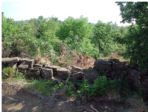
73 Na vrhu 1, ostanke zidu iz večjih kamnitih blokov, ki je ločeval parc. št. 705/1 in 706/2.
