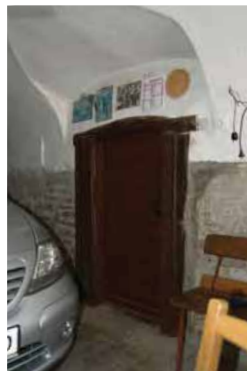
Foto 3, vhod v prostor 19
