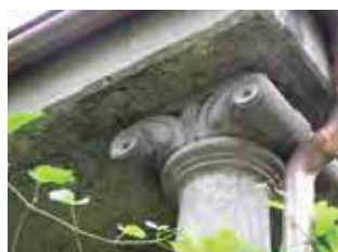
Slabi stiki s kritino in slabi odkapni nosovi
