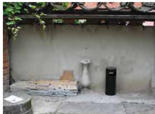
Slabi stiki s kritino in slabi odkapni nosovi
