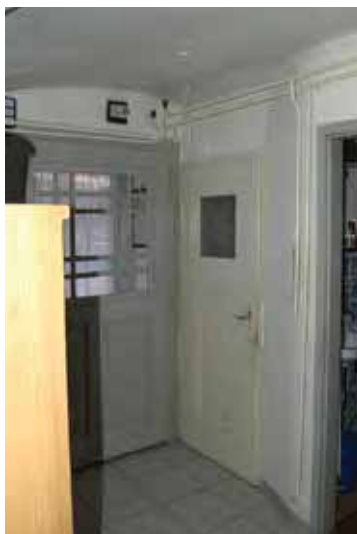
Foto 1, vhod v prostor 13
