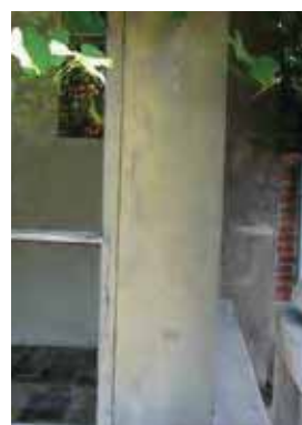
Slabi stiki s kritino in slabi odkapni nosovi
