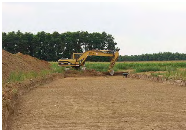
11 Strojni izkop ornice z večjim bagrom.
