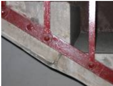
Detajl odstopanja ometa
