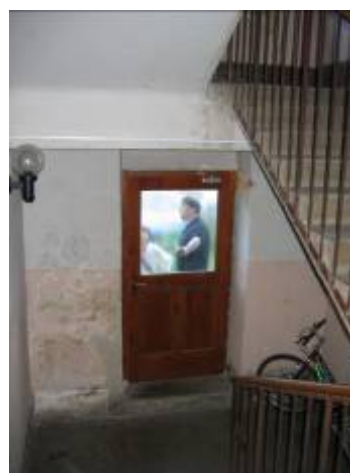
izhod na severni fasadi
