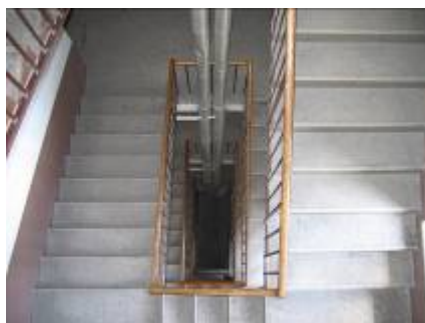
Toplovod, ki poteka med ramami stopnišča
