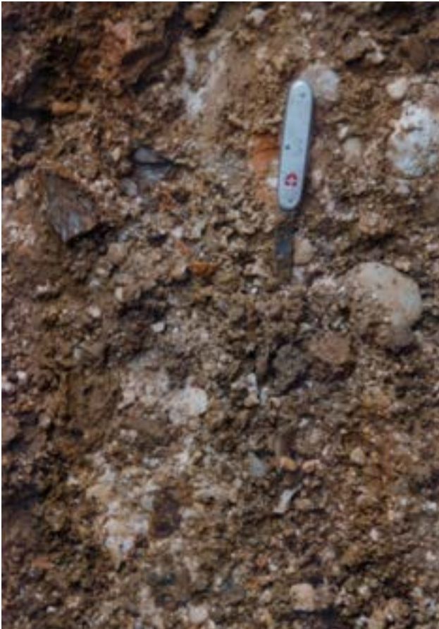
73 Peščen prod, močno zaglinjen in preperel v spodnjem delu izkopa.
