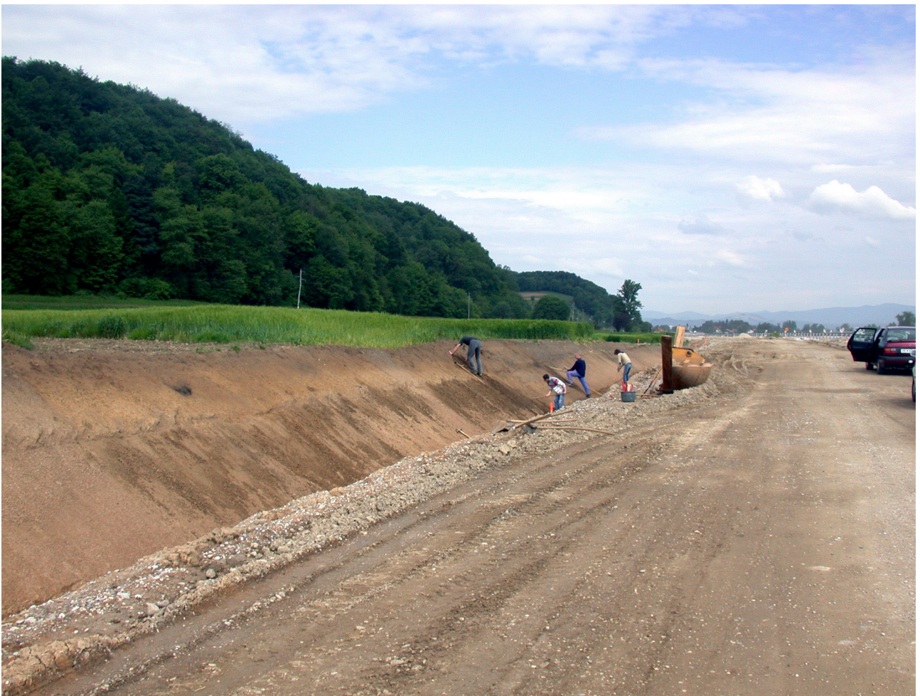
7 Pogled na najdišče pred izkopavanji.
